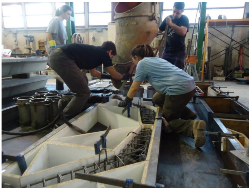
Figura 8.23. Vertido del hormigón en la pieza desde la cuba de hormigonado.
