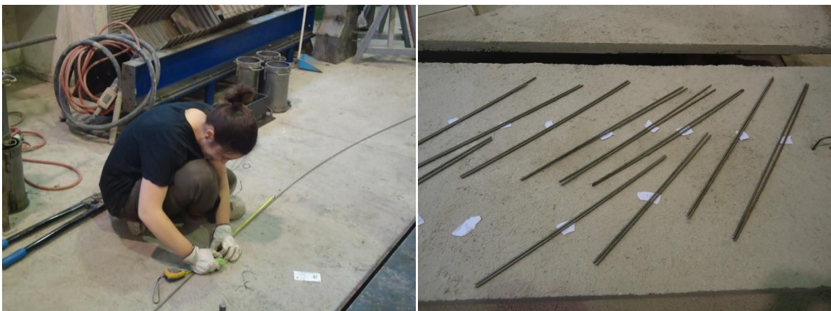
Figura 8.5. a) Corte de las barras para confeccionar los estribos; b) Clasificación de las barras ya cortadas.
