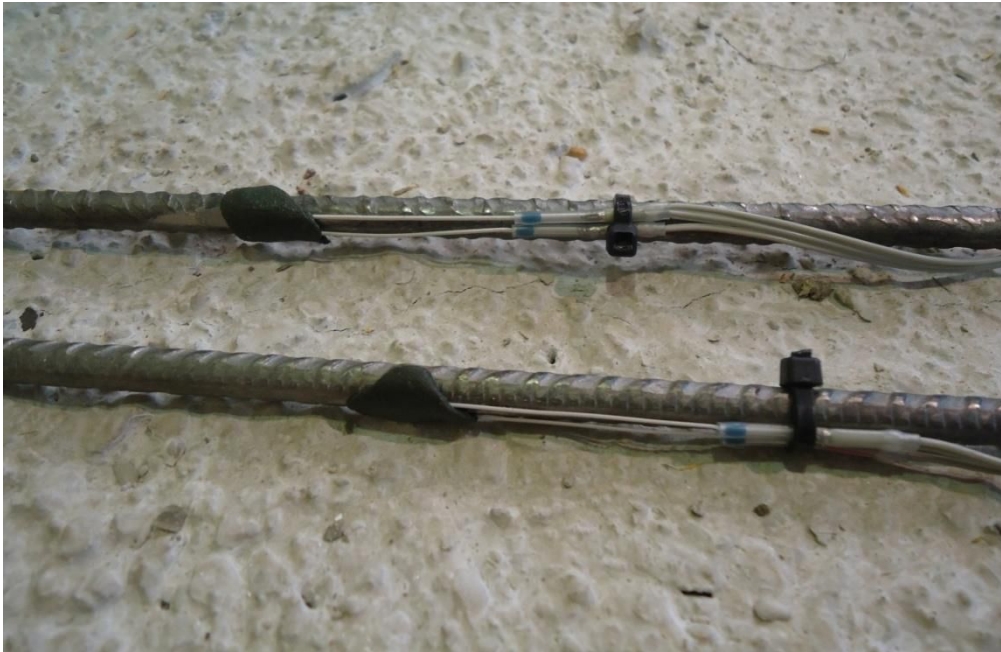
Figura 8.16. Colocación de las galgas extensiométricas de acero en la armadura.
