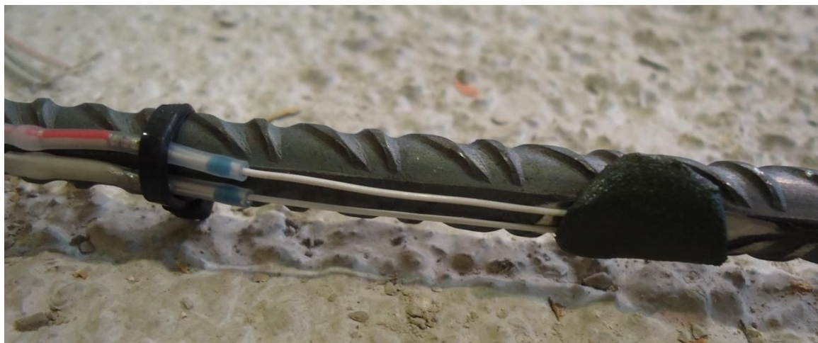
Figura 9.8. Galga de acero colocada sobre una de las armaduras longitudinales.
