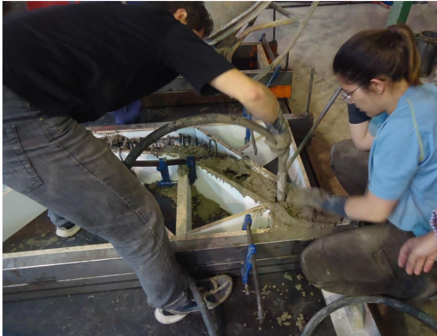
Figura 8.24. Compactación del hormigón mediante vibrador interno y picado con barra.
