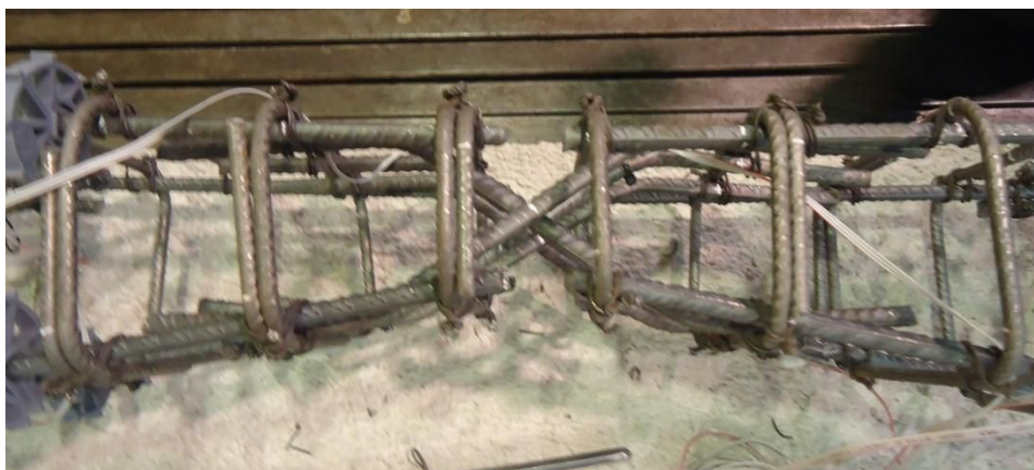
Figura 10.12. Posición de las barras pasantes en el momento de su colocación y atado.
