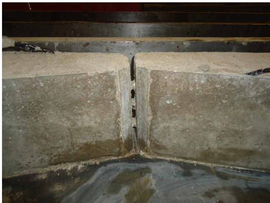
Figura 8.30. Desencofrado de la rótula.
