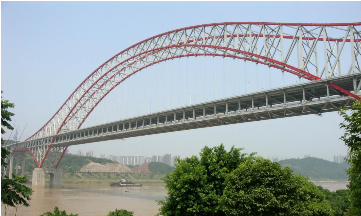
Figura 2.3. Puente Chaotianmen (Chongqing, 2009). Fuente: E. Sakowski.
