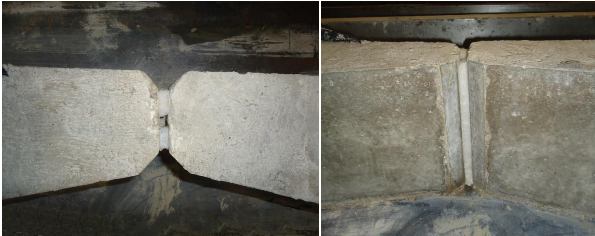
Figura 8.31. Colocación de material fácilmente deformable en la rótula.
