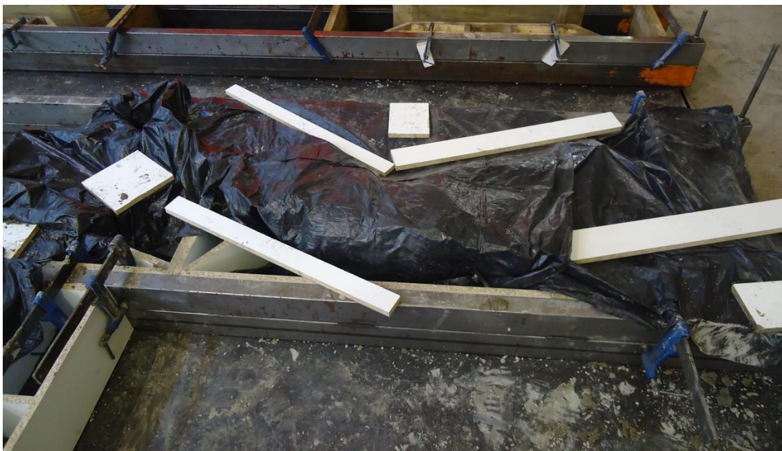
Figura 8.32. Curado de la pieza mediante el cubrimiento con plásticos.
