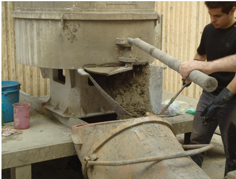
Figura 8.22. Vertido del hormigón en la cuba.
