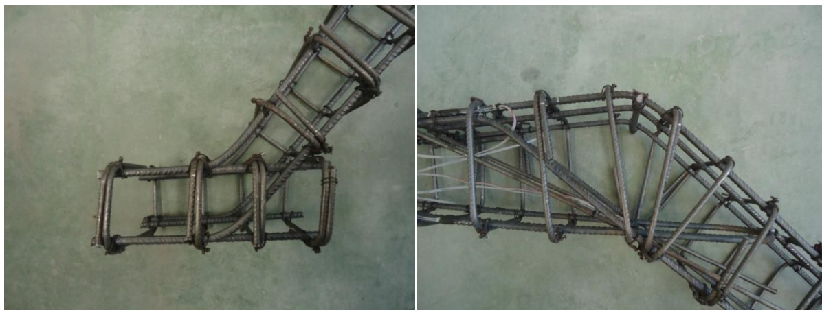
Figura 8.14. a) Detalle de la ferralla armada del apoyo derecho; b) Detalle de la ferralla armada de la región de discontinuidad KL.
