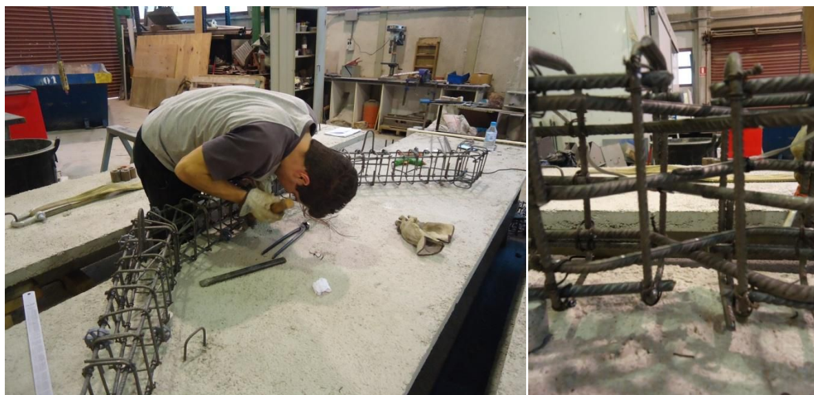
Figura 8.15. a) Atado de las barras pasantes de la rótula; b) Detalle de la ferralla armada de la rótula.
