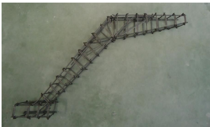
Figura 8.11. Ferralla armada correspondiente a la mitad derecha del arco.
