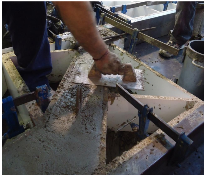
Figura 8.25. Paso de la llana sobre el hormigón de la pieza.
