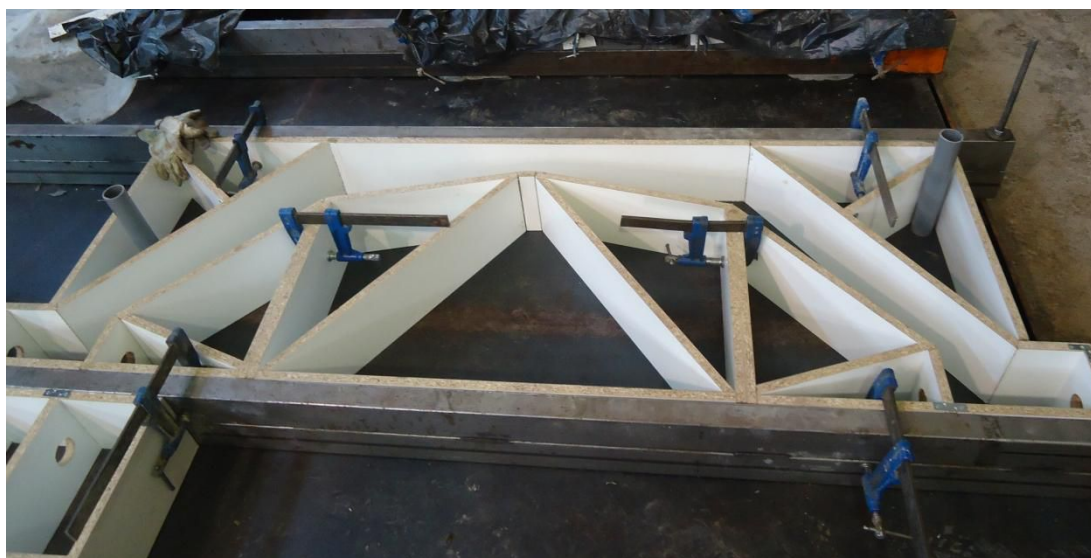
Figura 8.3. Encofrado del elemento.
