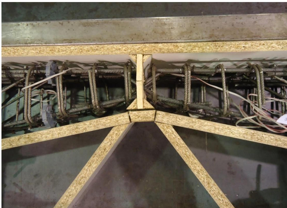
Figura 8.17. Montaje inicial para verificar que el encofrado de la rótula encajaba adecuadamente.
