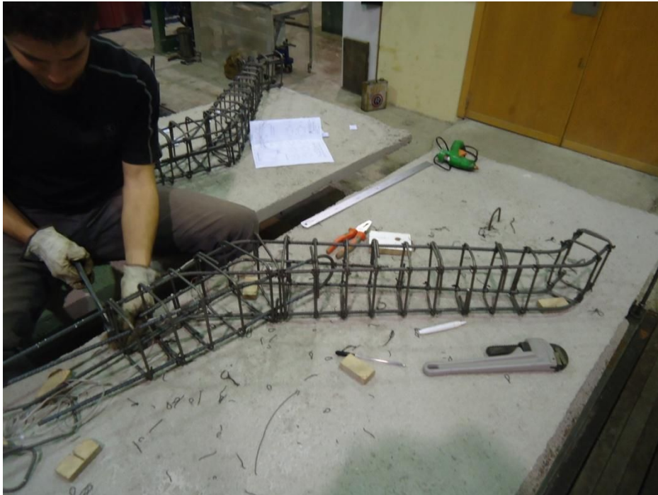
Figura 8.12. Armado de la mitad izquierda del arco.
