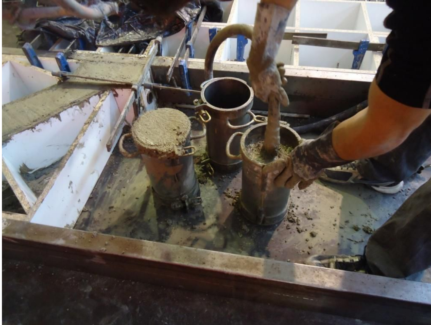
Figura 8.26. Llenado de los moldes para probetas de control del hormigón del elemento.
