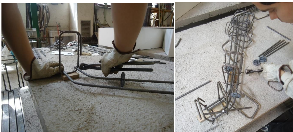
Figura 8.10. Proceso de armado.
