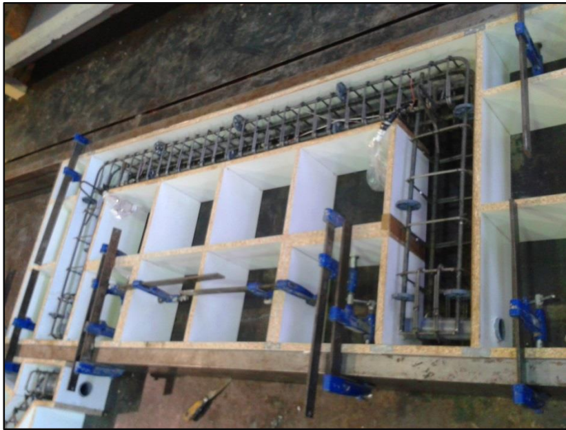
Fig 3.4.1 Montaje del encofrado y armado en la plancha de hormigonado
