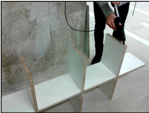
Fig 3.1.1 Montaje de encofrado
