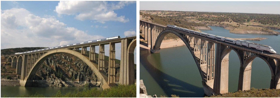
VIADUCTO MARTÍN GIL (ZAMORA)
