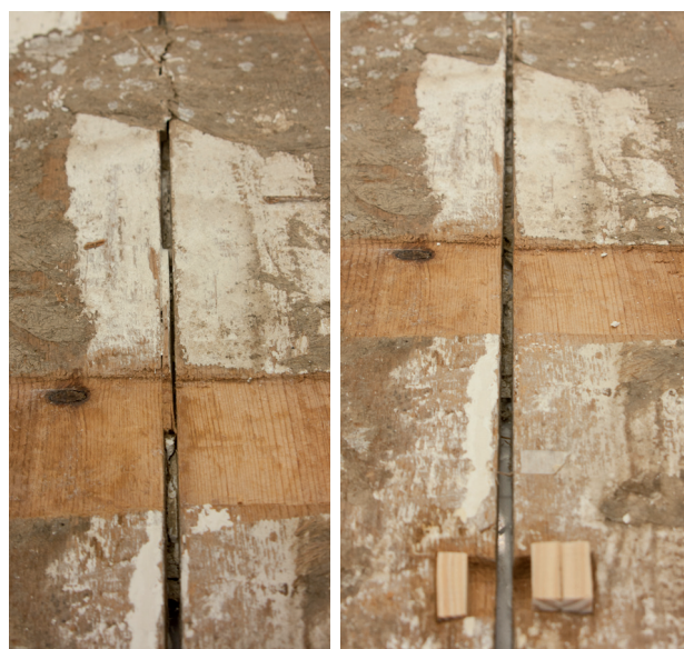
f.56. Limpieza de la unión entre el 2º y el 3º panel.
