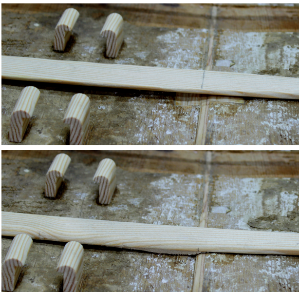
f.85. Adaptación de los travesaños flexibles a las irregularidades del soporte.
