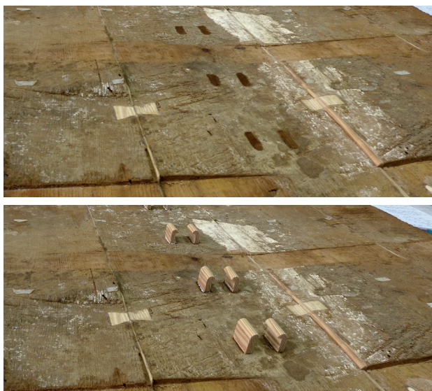
f.88. Impermeabilización puntual del soporte y encolado de las abrazaderas de madera.
