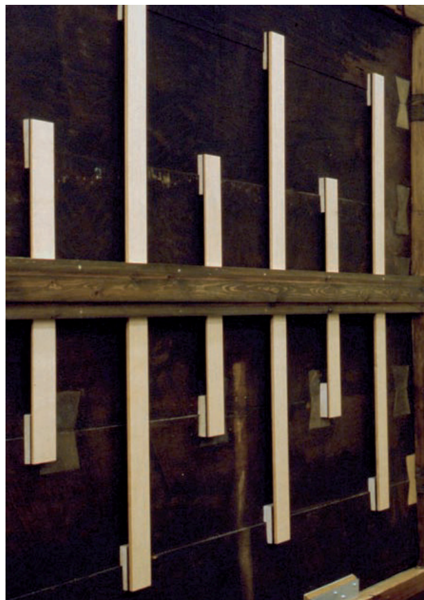
f.67. Enmarcado con puentes flexibles. 115
