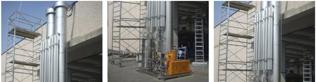
Figura 1.11: Instalación de criogénesis.
