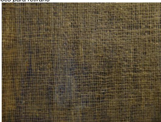
Fotografías detalle del momento de aplicación de la gasa de algodón impregnada en cola sobre el muro
