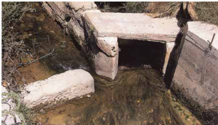
1.2.21. llengües y partidor en funcionamiento de la Acequia de Tormos, pp. 166.
