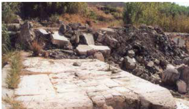
1.2.11. Estado del Assut de la acequia de Rascaña. (GUINOT, SELMA, 2005, pp. 139)
