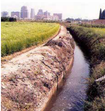
1.2.8. Brazo de Petra, a su paso por detrás del cementerio de Campanar. (GUINOT, SELMA, 2005, pp. 51)
