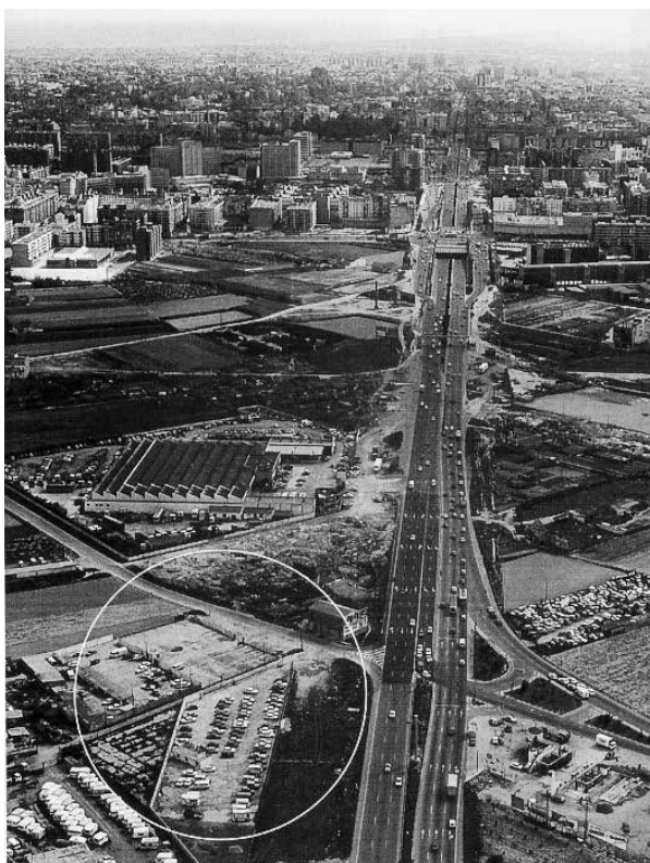
1.2.43. Vista general de la pista de Ademúz, en el lado izquierdo de la imagen se puede apreciar la chimenea del Molino de la Marquesa.
