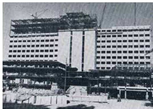
1.1.49. La Fe en construcción. 1968. Fuente: Rafael Solaz .
