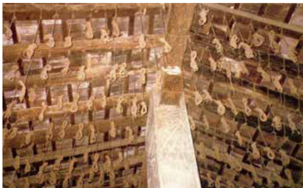
1.2.55. Cubierta de la alquería de Lluna, en el camino Vell de Burjassot con las cuerdas para colgar el tabaco. (DEL REY, 1997, pp. 54)
