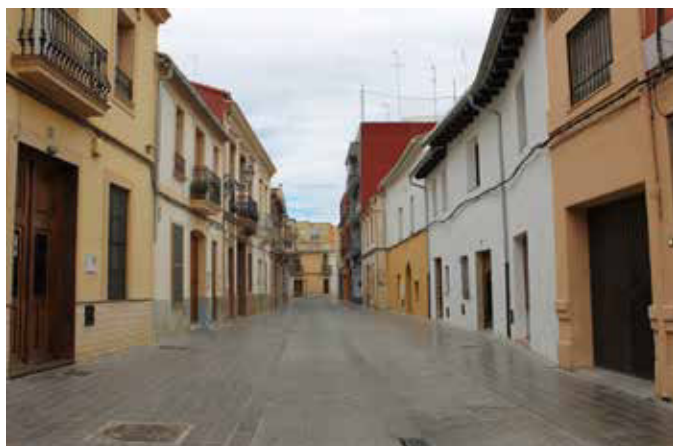
2.62. Foto actual del grupo de casas que fueron parte de la alquería, donde se aprecia el escalón en la alineación de la edificación.
