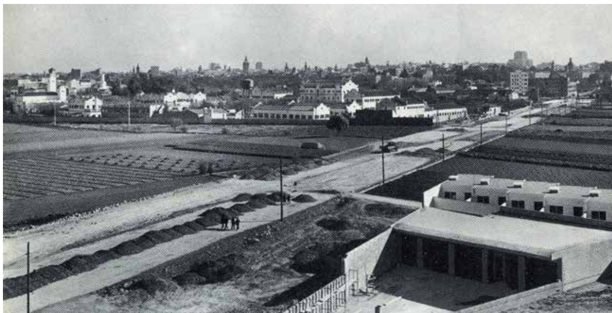
1.1.13. Pista de Ademúz en construcción. Año 1875
