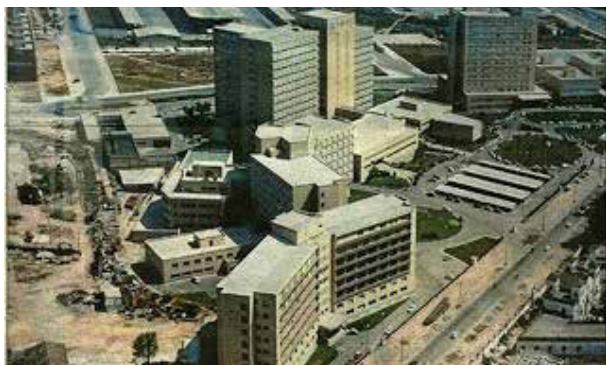
1.1.51. Vista del antiguo hospital la Fe, donde puede apreciarse en la parte posterior algunas casas del barrio del Farol.
