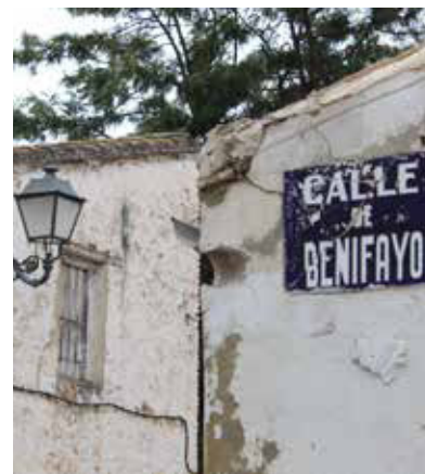
1. 2.96. Estado actual de la calle.
