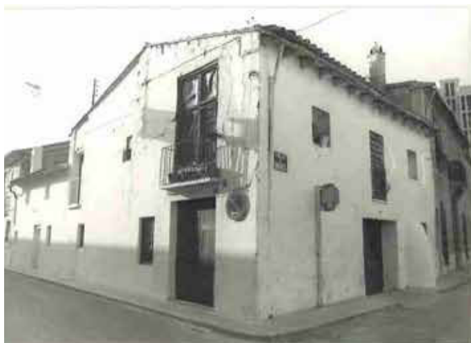
2.65. Foto de la edificación que formaría parte de la antigua alquería. La casa de color es la que se construye en 1898 tras el derribo de la barraca. Podemos apreciar el pozo moruno adosado a la fachada y al fondo el antiguo huerto, hoy solar.
