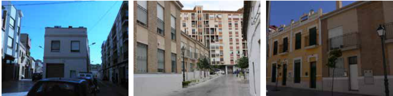
1.2.73. Tres ejemplos de complejos residenciales de viviendas unifamiliares con un lenguaje ecléctico que contrasta claramente con la uniformidad formal del resto de las casas que mantienen, independientemente del estilo utilizado la organización de espacios tradicional.
