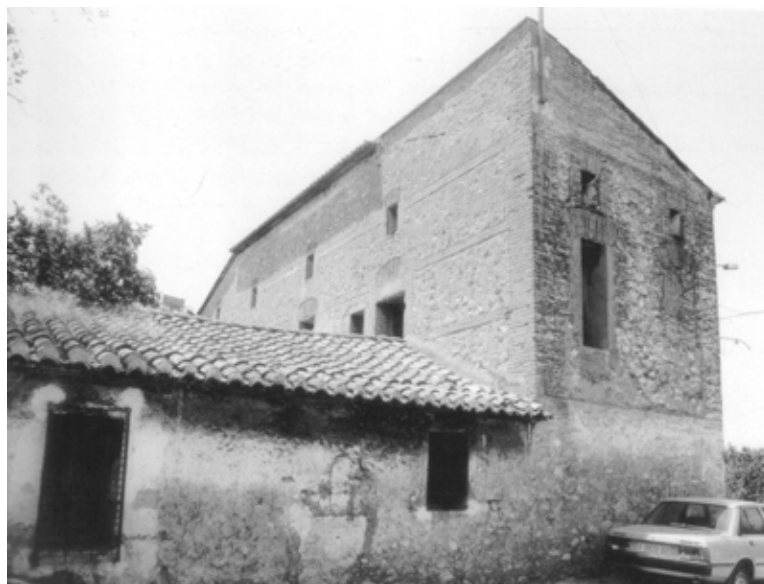
1.2.58. Distintos muros de carga realizados, el primero, con la técnica del tapial valenciano, en vivienda situada en núcleo de Campanar. (Foto propia) y el segundo de mampostería intercalada con ladrillo en Alquería desaparecida en la huerta de Campanar del siglo XVII, (DEL REY, 1987, pp. 44)
