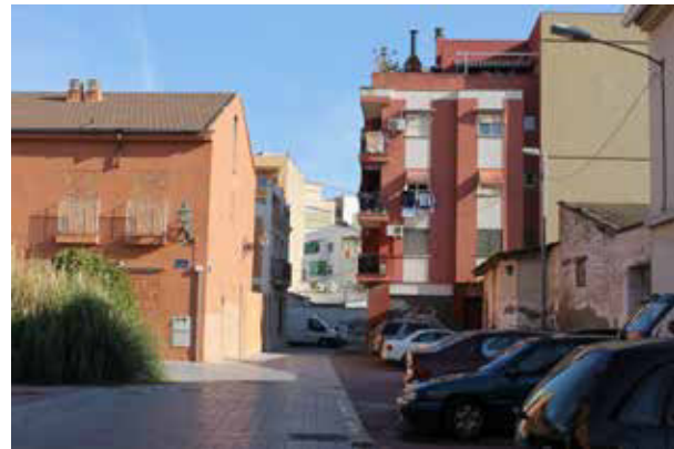
1. 2.100. Diferentes vistas del estado actual de la calle.
