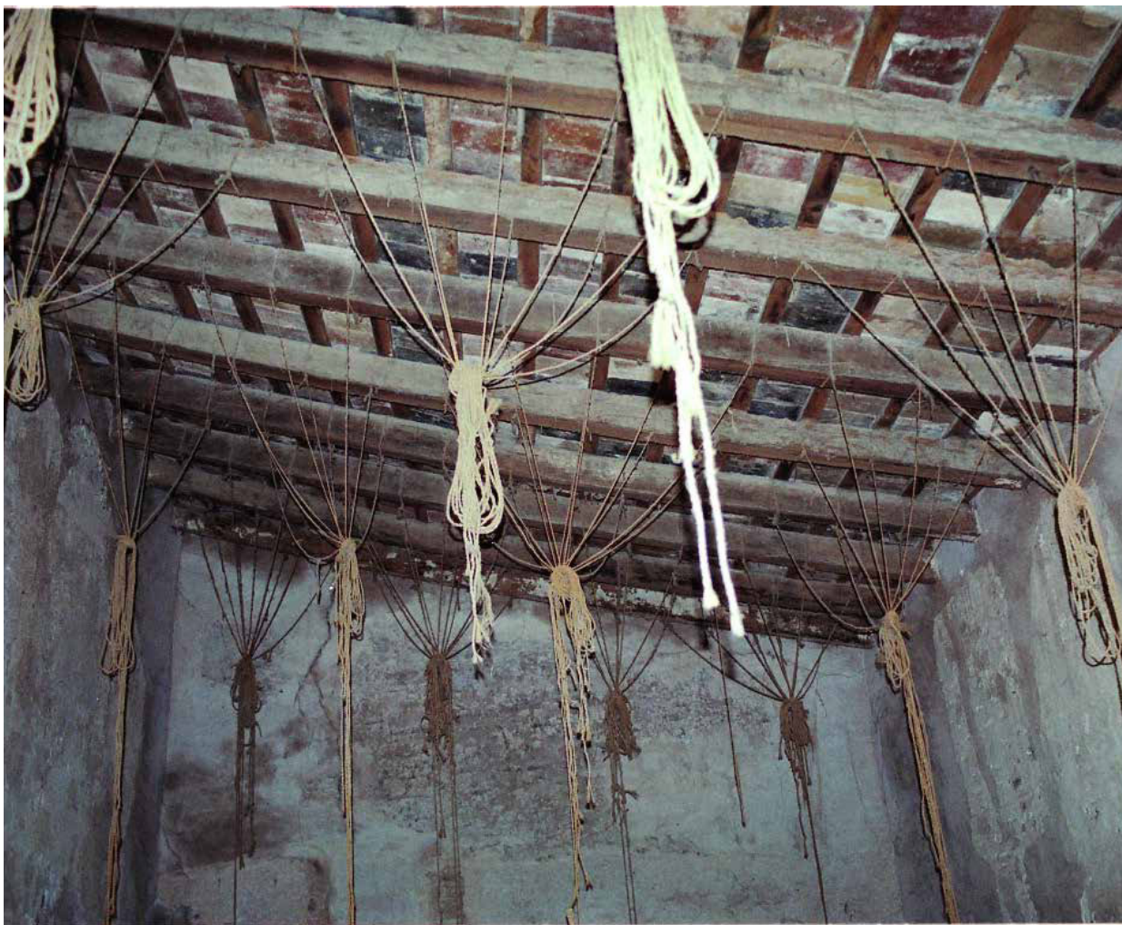
1.2.59. Detalle de la cubierta de la alquería de Barberá, con el entramado de madera y el tablero de rajoles, algunos de ellos con socarrats pintados en mangra. (ALGARRA, RUIZ,1998). Documentación facilitada por D. XXX propietario de la alquería de Barberá.
