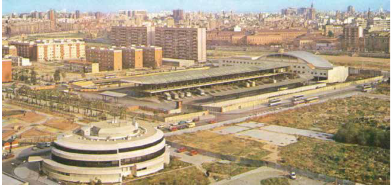
1.1.57. Vista general de Tendetes en los inicios de su urbanización. Aparecen la estación de autobuses, el IVO y al fondo las promociones de viviendas que se levantaron en la década de los setenta.
