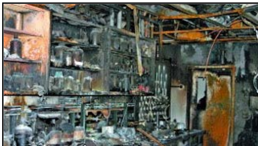
Imagen 1.1. Laboratorio después del accidente (Fuente [5])
