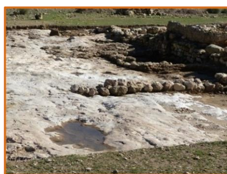
Imágenes 72, 73 y 74. Sales solubles depositadas sobre la base.
