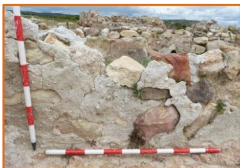
Imágenes 100 y 101. Mal estado de los morteros de época Medieval en el Habitáculo rectangular.
