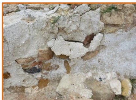
Imágenes 100 y 101. Mal estado de los morteros de época Medieval en el Habitáculo rectangular.
