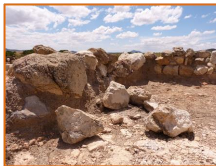
Imagen 8. Desmoronamientos en la estancia Patio.
