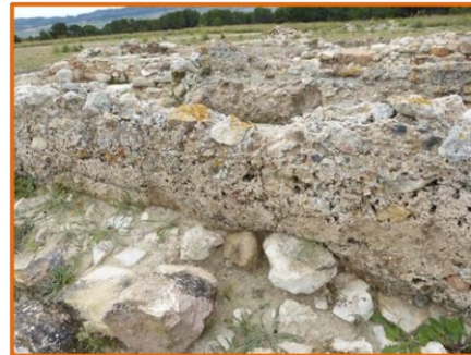
Imagen 2. Estructuras reutilizadas posteriormente. Diferentes técnicas y materiales.
