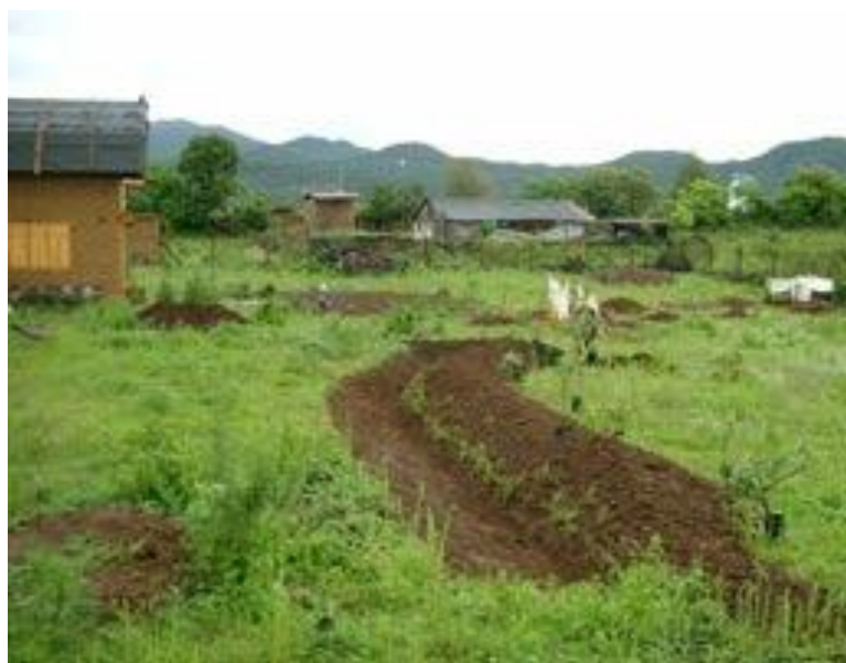
Figura 2.7. Zanja de infiltración. Fuente Dina-mar.
