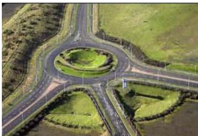
Figura 2.13. Depósito superficial de detención localizado en una “zona muerta”. Fuente: Universidad de Abertay, Dundee, Escocia.
