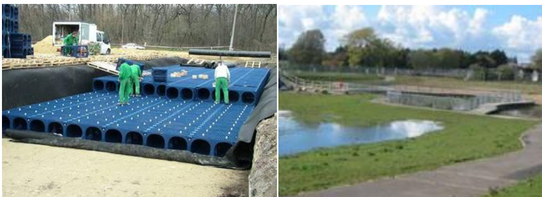
Figura 2.10. A la izquierda montaje de un depósito de infiltración. Fuente: Aquatecnic. A la derecha depósito de infiltración en funcionamiento.
