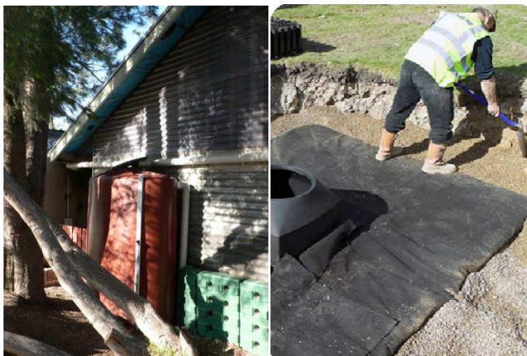
Figura 2.2. A la izquierda, depósito de aguas pluviales sobre el nivel del suelo. Fuente: Wikipedia. A la derecha, Instalación de un depósito bajo tierra. Fuente: Wendy Carradine.
