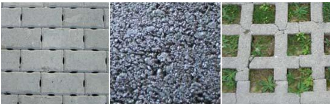
Figura 2.4. Tres tipos de superficies permeables. La primera consiste en adoquines que permiten el paso del agua, la segunda es una mezcla bituminosa permeable y la tercera es de césped y hormigón. Fuente: GITECO (2009).
