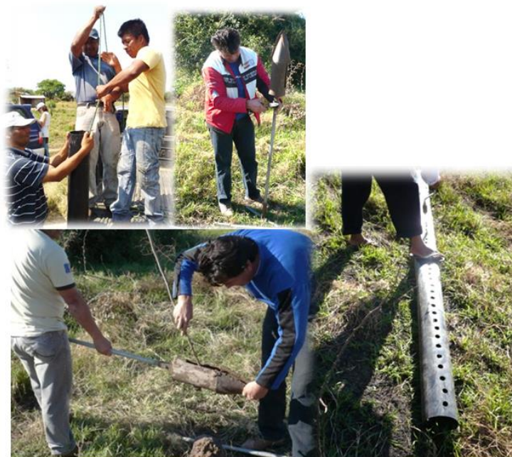
Figura 2: Técnicos de Agua de la ONGD Pro Comunidades Indígenas perforan junto a miembros de la comunidad un nuevo pozo en una comunidad indígena de de etnia Maskoy, Chaco Paraguayo (Barbieri et al. , 2012).
