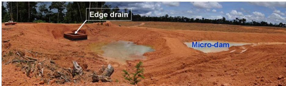
Figura 6. Micro embalse de recarga construido en canal de drenaje.
