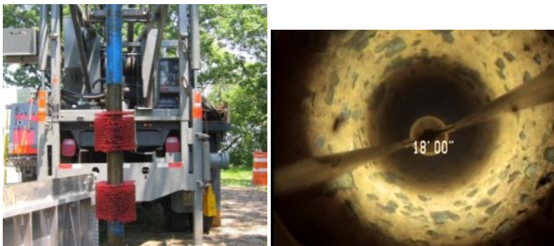
Figura 4. Herramienta y visualización de tubería tras cepillado
