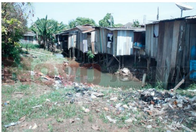
Figura 4. Casas en zona de Mocambo en Porto Velho
