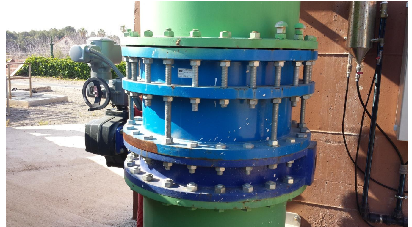
DETALLE CAUDALÍMETRO ELECTROMAGNÉTICO.
