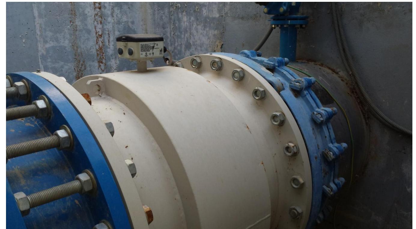
DETALLE CAUDALÍMETRO ELECTROMAGNÉTICO.
