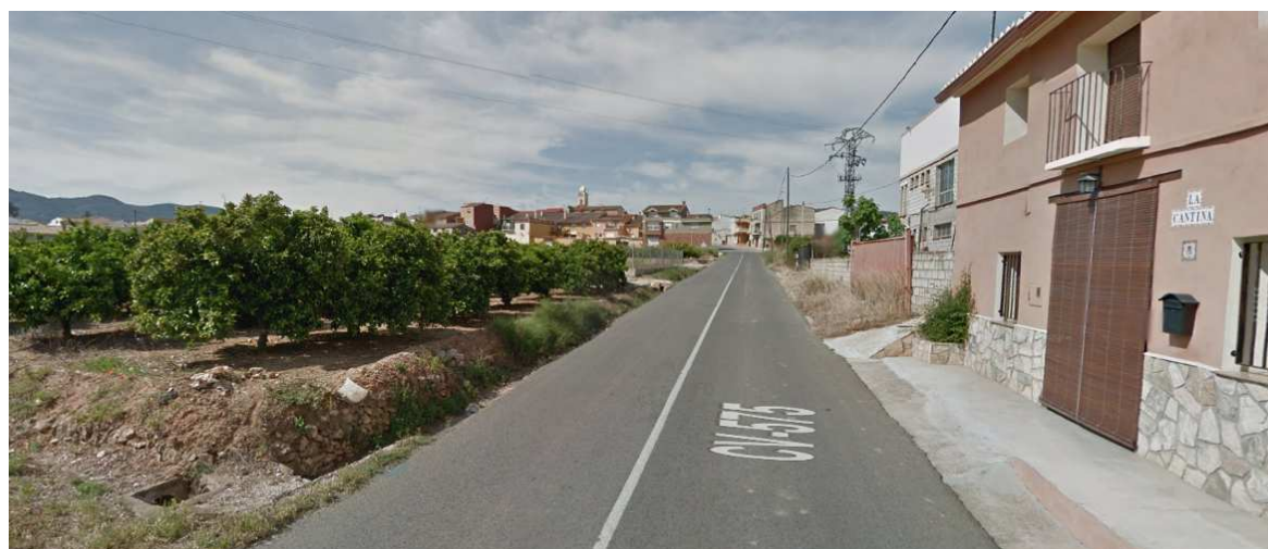
Foto 2 Tramo CV-575. Travesía Lloc Nou D'En Fenollet
