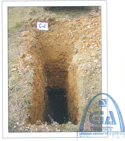
FOTOGRAFIA DE CALICATA
