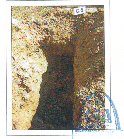
FOTOGRAFIA DE CALICATA
