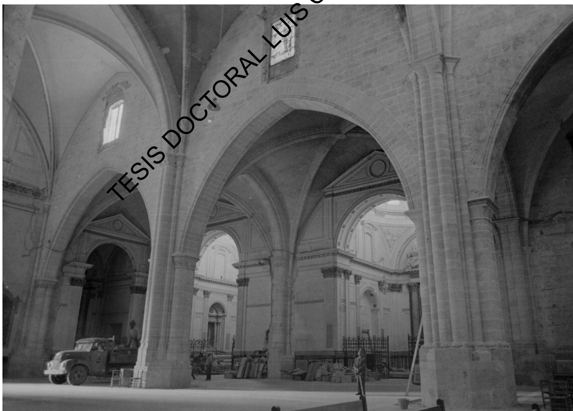
Imagen de la nave central hacia los pies. Archivo COAC Demarcació Lleida 1040-23317
