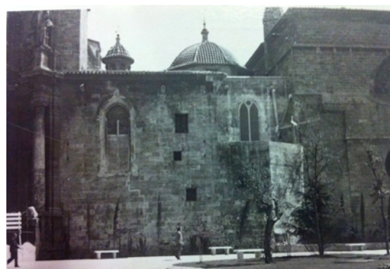
Imagen que presentaba la fachada sur en el tramo final de la restauración de Ferrant. BV AAFV, catedral de Valencia
