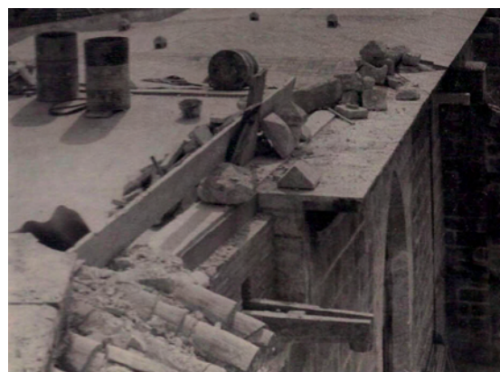
Detalle de las obras de restauración de la cubierta en la década de 1970. Imagen de Vicente Minguet
