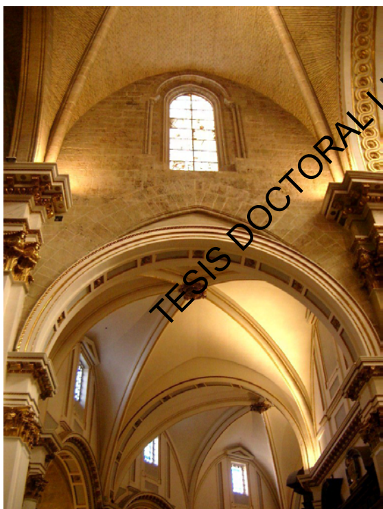
Arranque de nervios de piedra sobre cornisas estucadas y arcos apuntados de piedra sobre arcos de medio punto de albañilería
