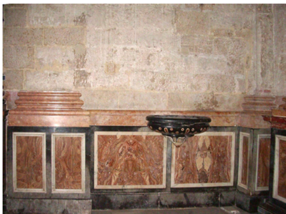
Izquierda: Imagen en la que se visualiza una errónea lectura arquitectónica con el zócalo de mármoles y basas sobre la piedra de cantería
