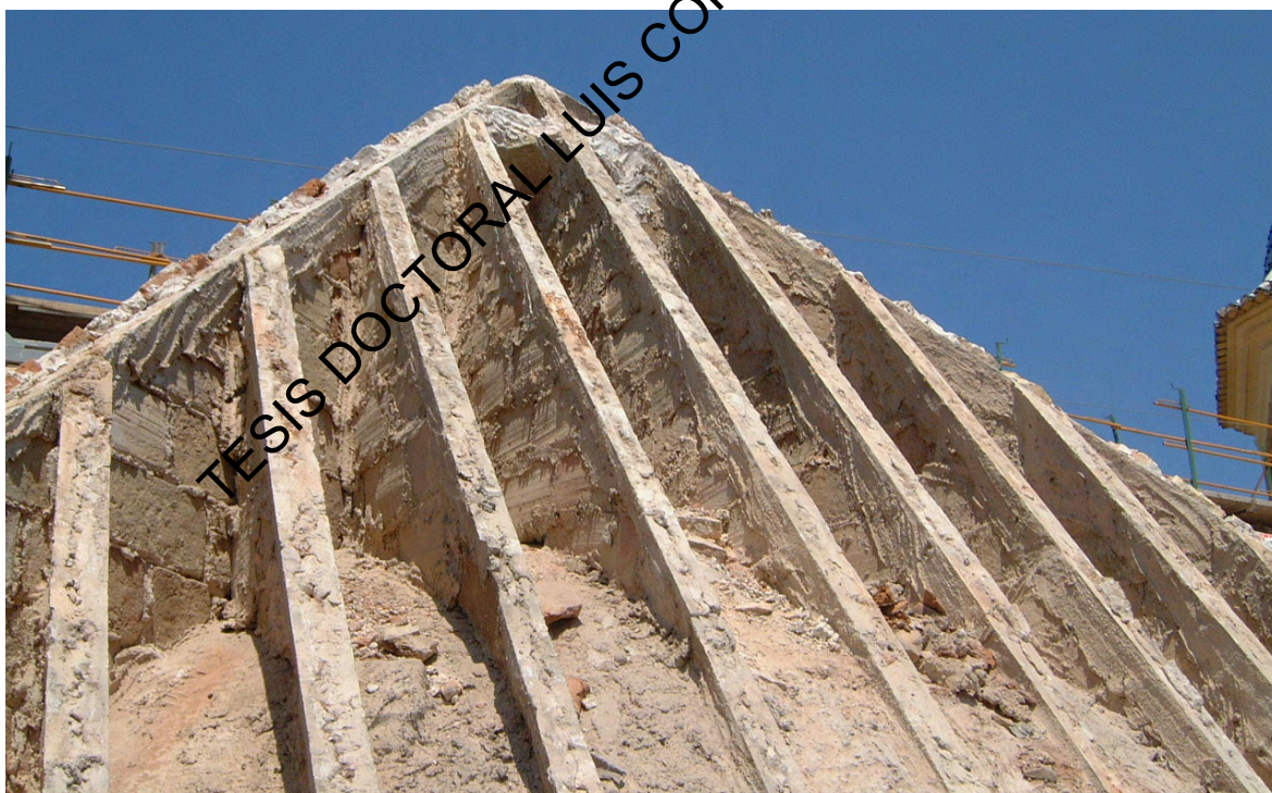
Imagen de la ejecución de una sobrecubierta apoyada sobre bóveda con la técnica de tabiquillos. Foto Rafael Marín
