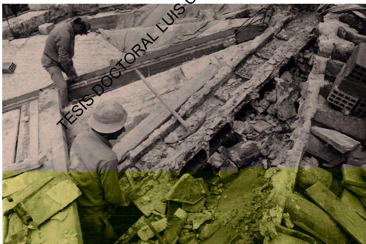
El pico (centro de la imagen) está situado sobre tejas "envernizadas" (tejas planas esmaltadas), la solución utilizada a finales del siglo XVIII para la formación de las canales en cubierta. Archivo personal de Vicente Minguet, década de 1970.
