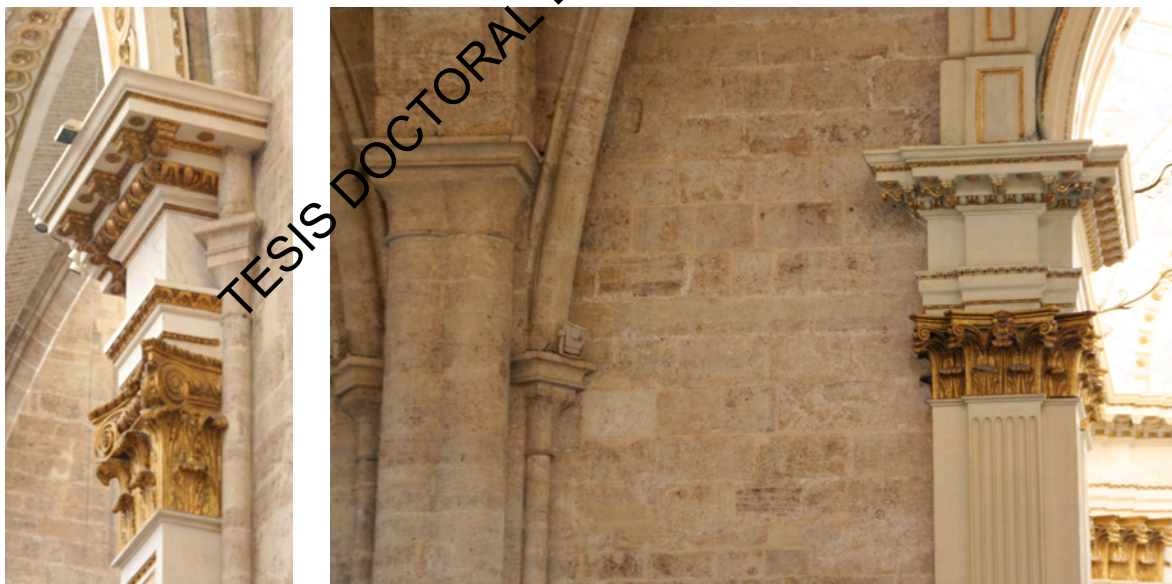
Detalles de las alturas de los capiteles de la fábrica gótica con respecto a la decoración clasicista en los órdenes mayor (izquierda) y menor (derecha), que corresponden a las naves central y laterales
