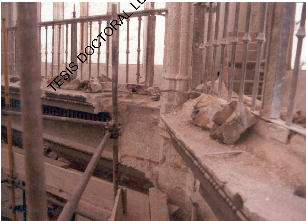
Imagen del archivo de la familia Minguet, de las obras de restauración del cimborio, en la década de 1970. Los elementos de tono rojizo pertenecen a ladrillos encajados en la piedra
