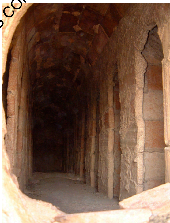
Imagen del pasillo de una sobrecubierta de tabiquillos con ladrillo cerámico en la iglesia del Temple de Valencia. Foto Rafael Marín
