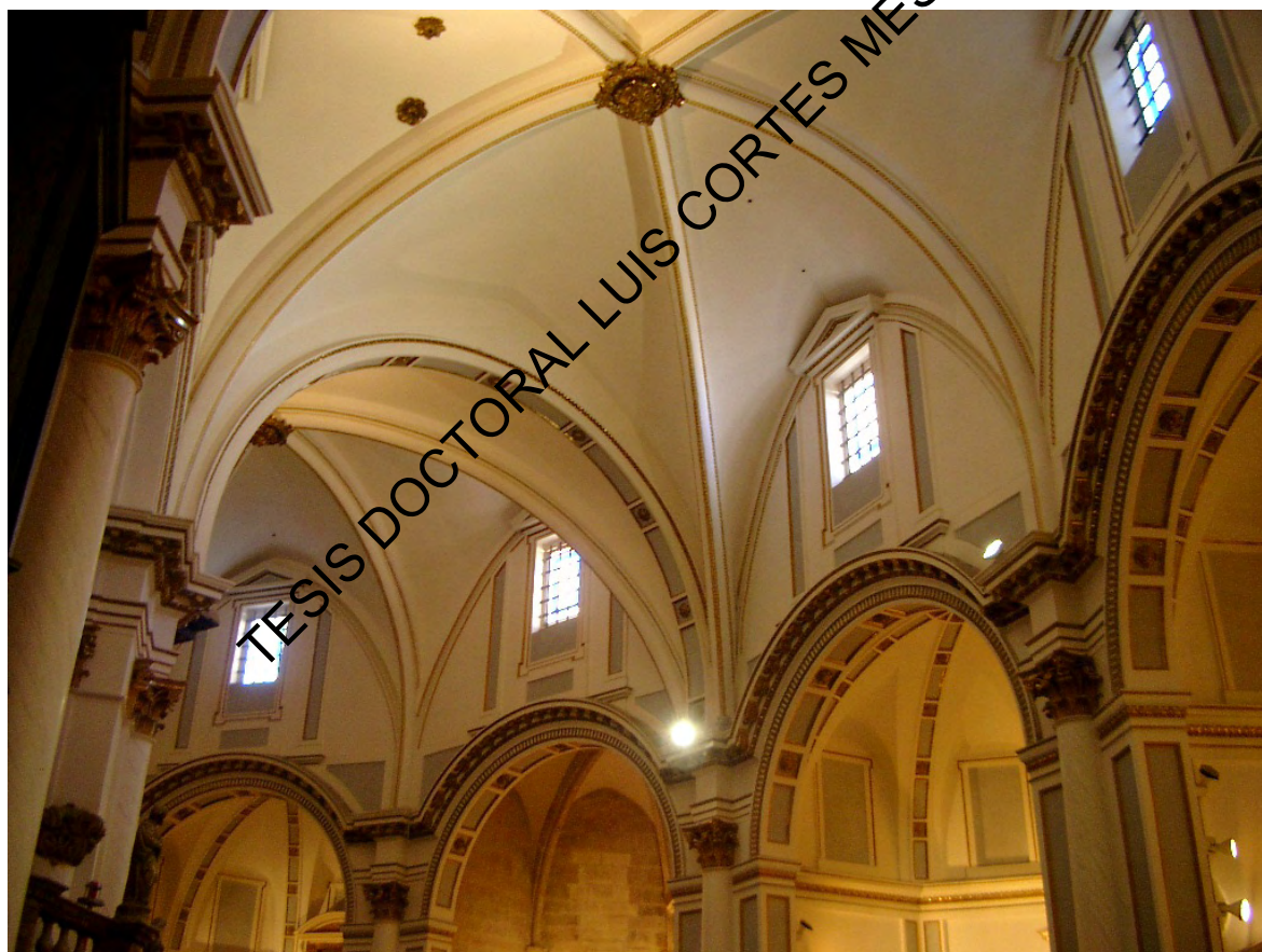
Imagen de las bóvedas del deambulatorio de la Catedral de Valencia
