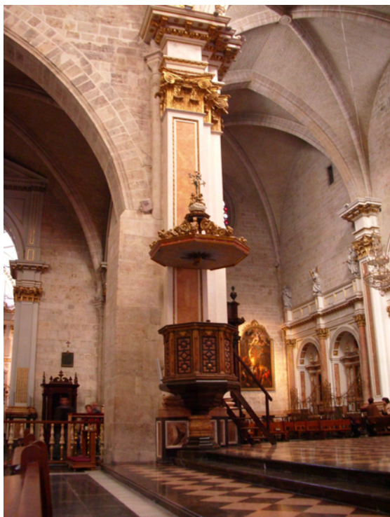
Capitel pétreo gótico junto a entablamento de albañilería clasicista
