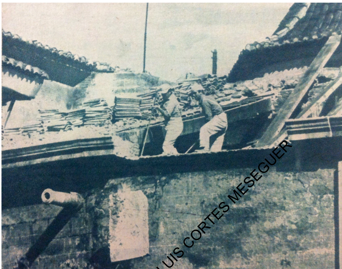
Intervención de Ferrant en la fachada sur. En la imagen se observa la demolición de las vigas de madera que cubrían esta zona. BV AAFV. Imagen del diario Las Provincias, 9 de Noviembre de 1965
