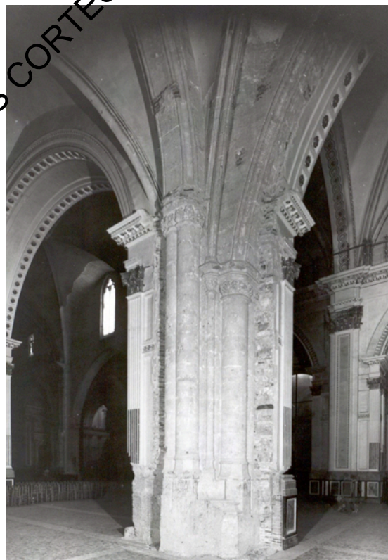
Vista desde la puerta del Micalet hacia el primer pilar que separa la nave principal de la nave del Evangelio, en el que se aprecia se acopló el orden clasicista al ya existente gótico. Archivo de Vicente Minguet.
