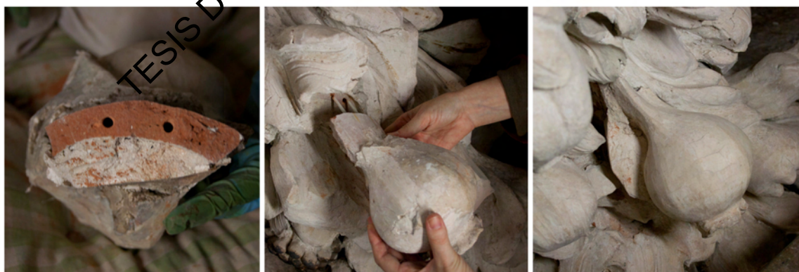
Imagen de Aurora Rubio de la recolocación de piezas esculturales con tejas cerámicas en la restauración de la Capilla de San Pedro de la Catedral de Valencia, 2012
