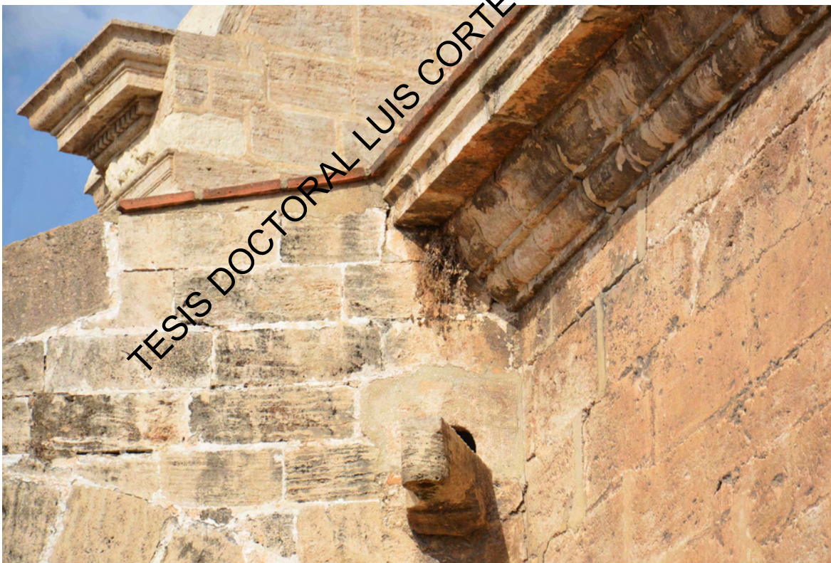
Detalle de la cornisa en cubierta de la nave de la Epístola. Año 2014
