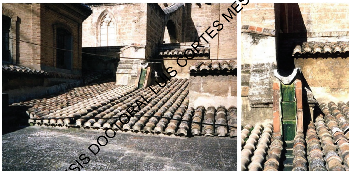
Imágenes cedidas por D. Rafael Soler, en el que se aprecia la utilización de las tejas planas como solución de canal
