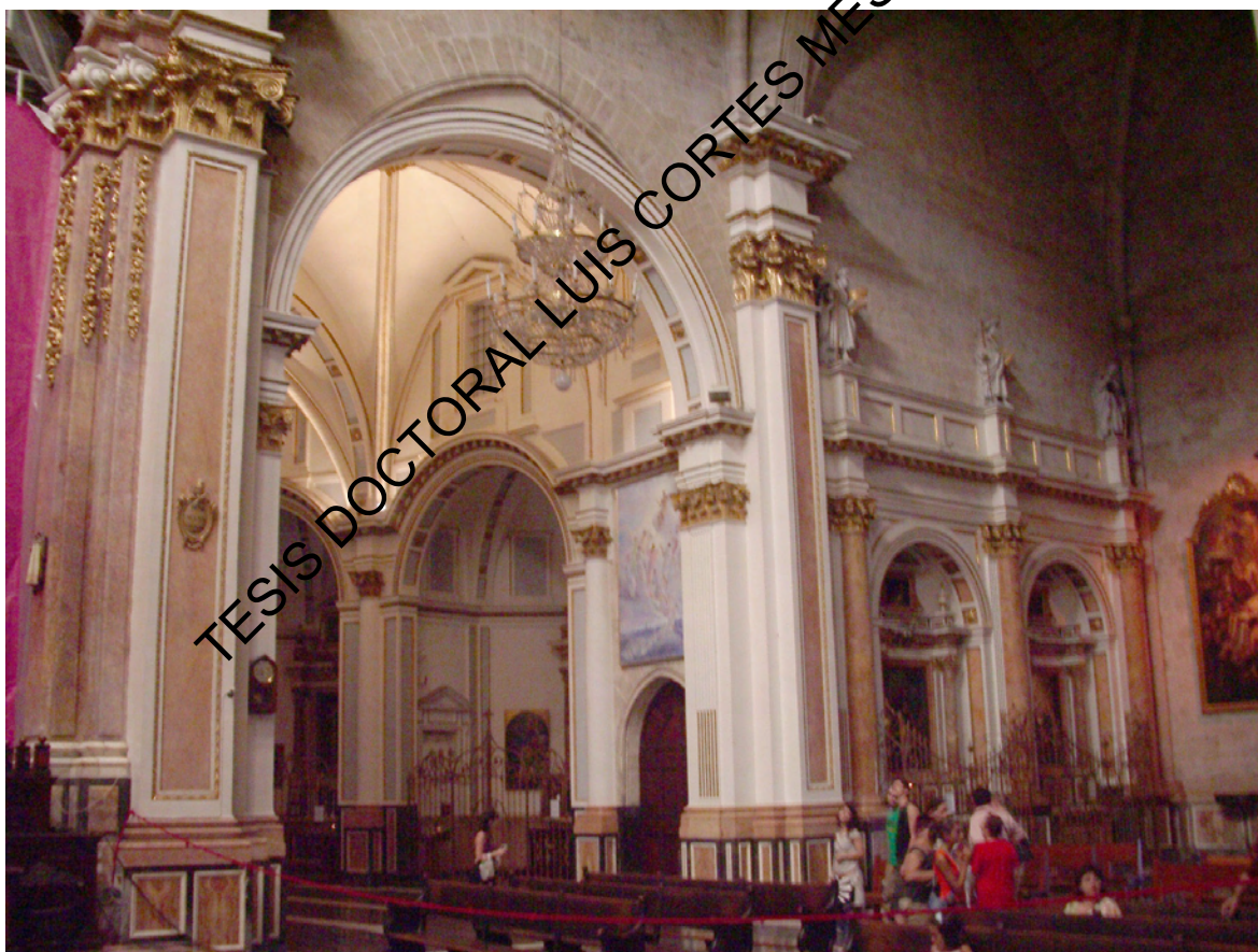
Vista desde la nave principal hacia la nave del transepto recayente a la puerta del Palau (2005)
