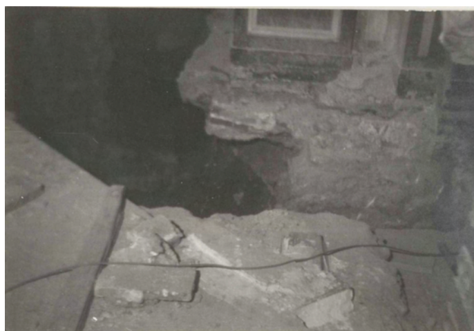
Imágenes de Tirso Avila, del pilar del cimborio del lado del evangelio. En la parte central de la imagen inferior derecha se aprecian las aristas del octógono que forma la cimentación del citado pilar y que el revestimiento neoclásico sobresale de dicha cimentación
