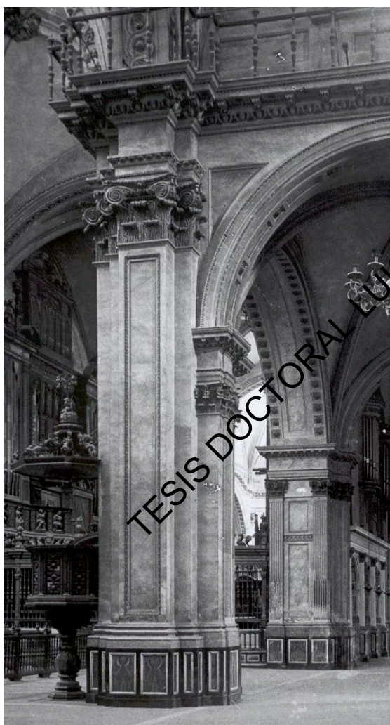
Fotografía del pilar del cimborio recayente a la puerta de los Apóstoles, donde se aprecia la modulación de los dos órdenes. Archivo Mas, signatura E1157, 1917
