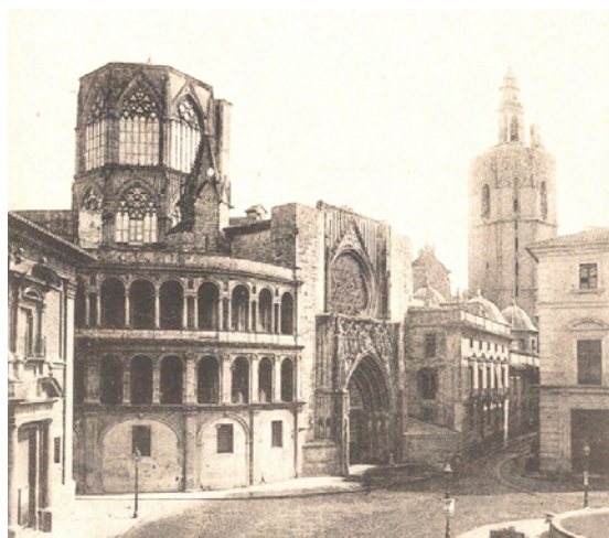
Vista de la logia de los Canónigos junto a la portada gótica de la Catedral. BV AAFV
