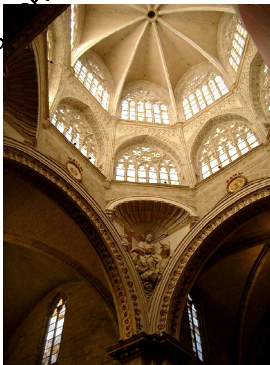
Un cimborio gótico sobre arcos y trompas neoclásicas
