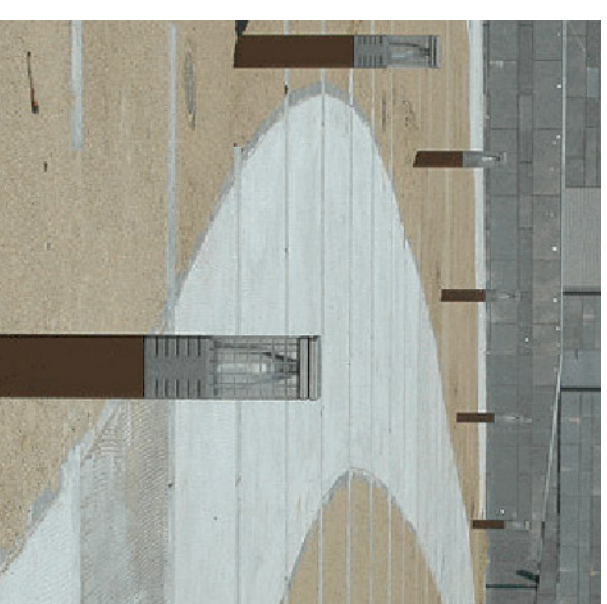
Luminarias de acero corten
