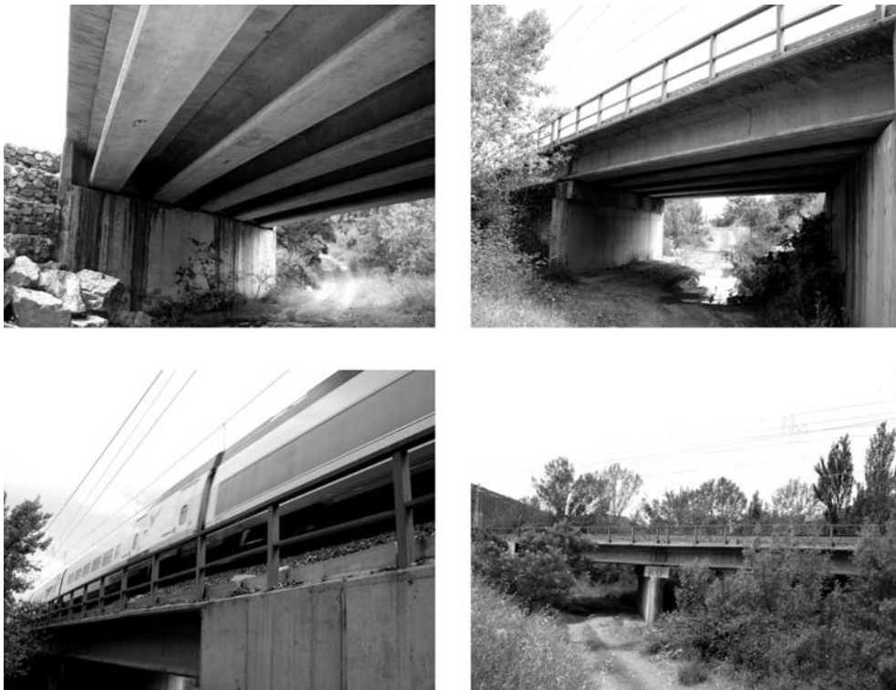
Figura 7.6 Imágenes del puente Arroyo Bracea II
