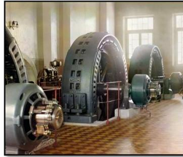
**Figura 38.** Alternadores de principios del siglo XX en una central hidroeléctrica.
