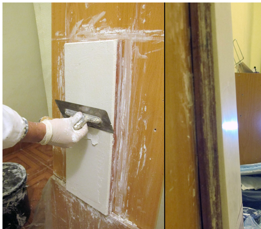
Imagen 42. A la izquierda vemos la aplicación de la tercera capa con la llana metálica y a la derecha un detalle del proceso de pulimentado en fresco del mortero.
