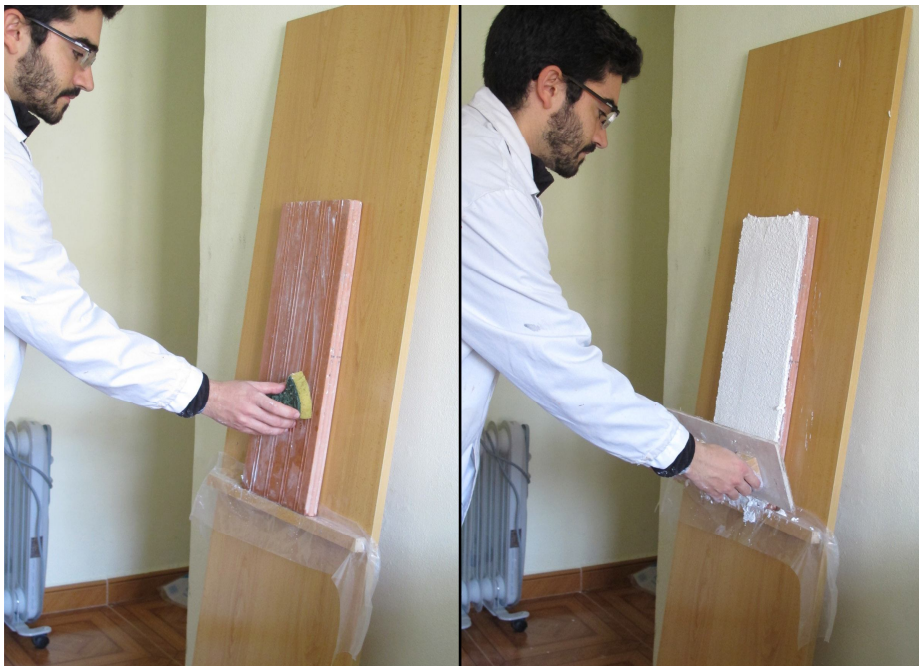
Imagen 40. A la izquierda vemos como se está humectando el soporte con esponja y a la derecha durante la aplicación de la primera capa de estuco con la talocha de madera.
