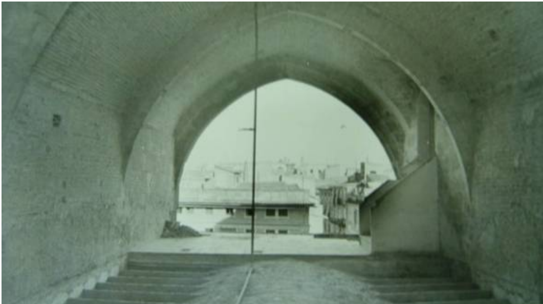
Bóveda interior arriba y en el suelo el esqueleto de la falsa bóveda superior de la planta inferior.
