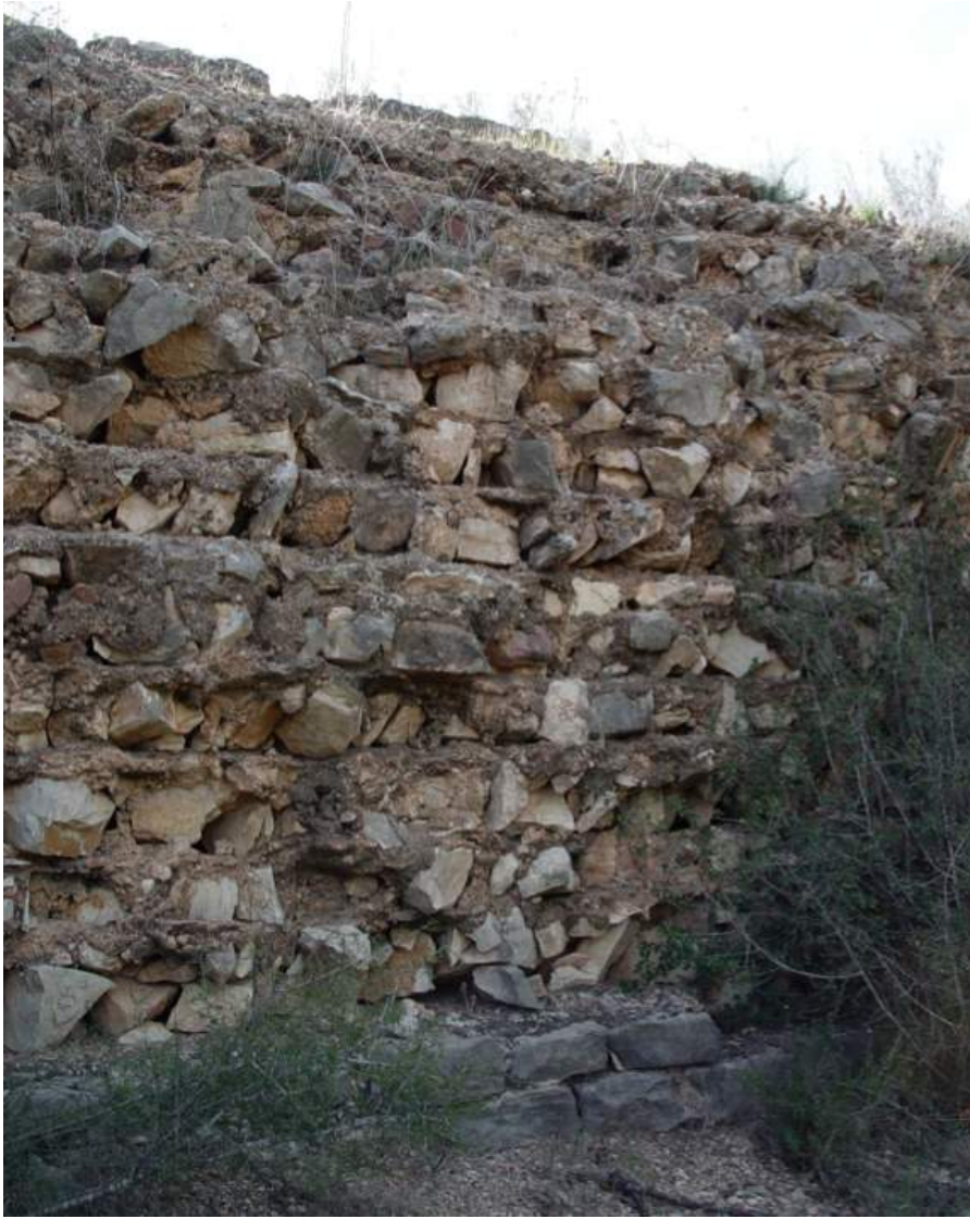
Interior de la estructura del acueducto
