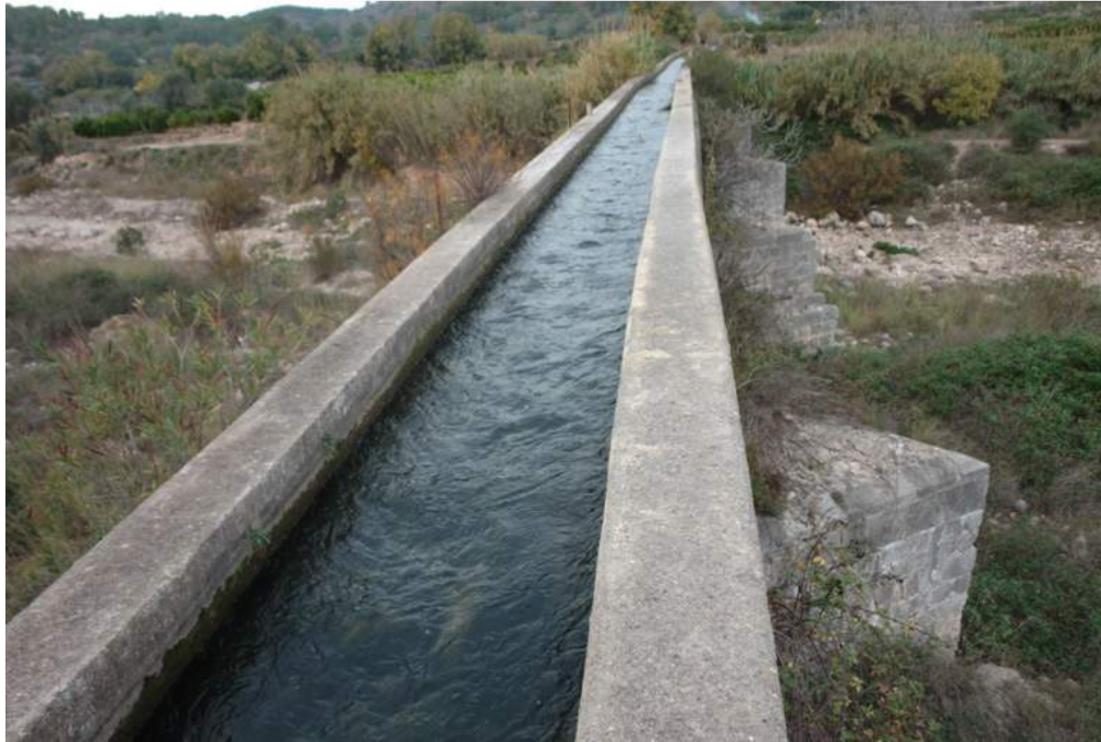
Imagen de este acueducto medieval-moderno en uso sobre tajamares apuntados de diferente cronología cruzando sobre el Palancia.
