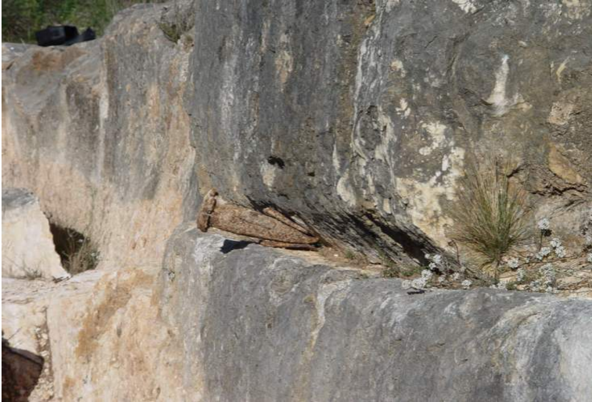
Reconstrucción de la posición de la cuña y sus sobrecuñas para romper la unión del bloque con la roca madre.
