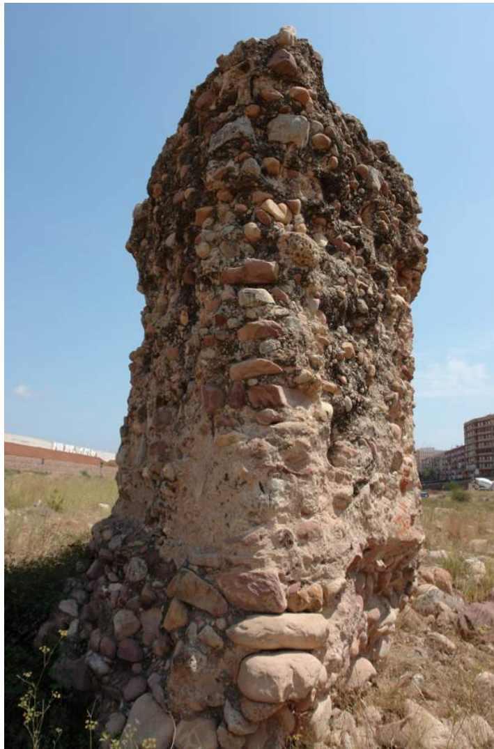
Uno de los tajamares del puente- acueducto en el cauce del río Palancia en la ciudad de Sagunt.
