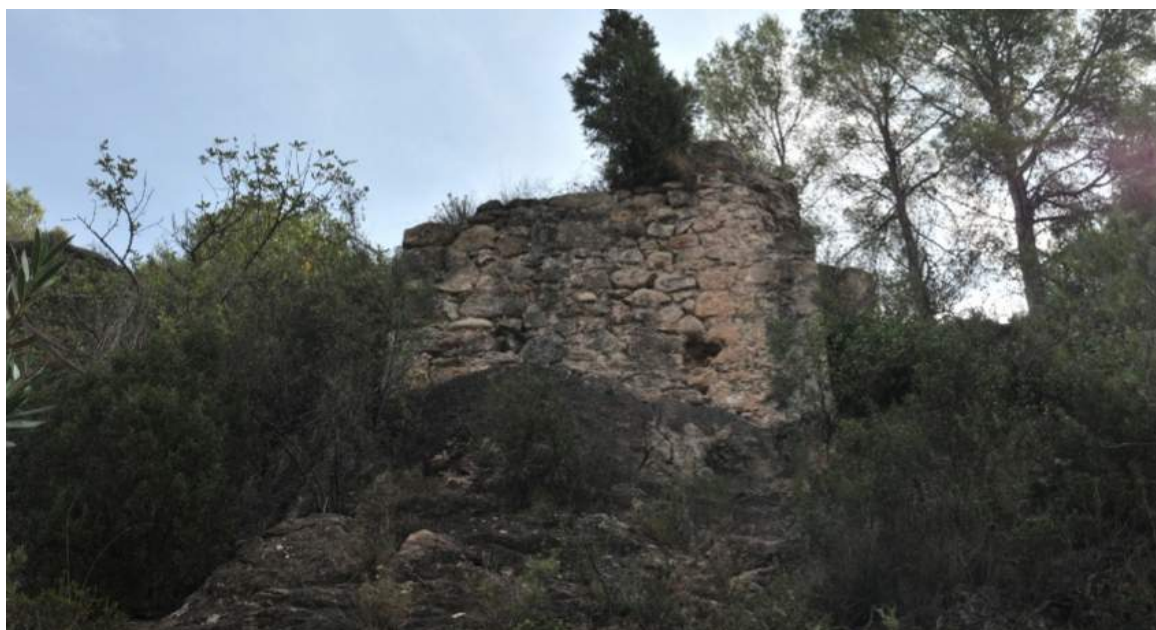
Detalle de la base en la orilla norte del barranco.
