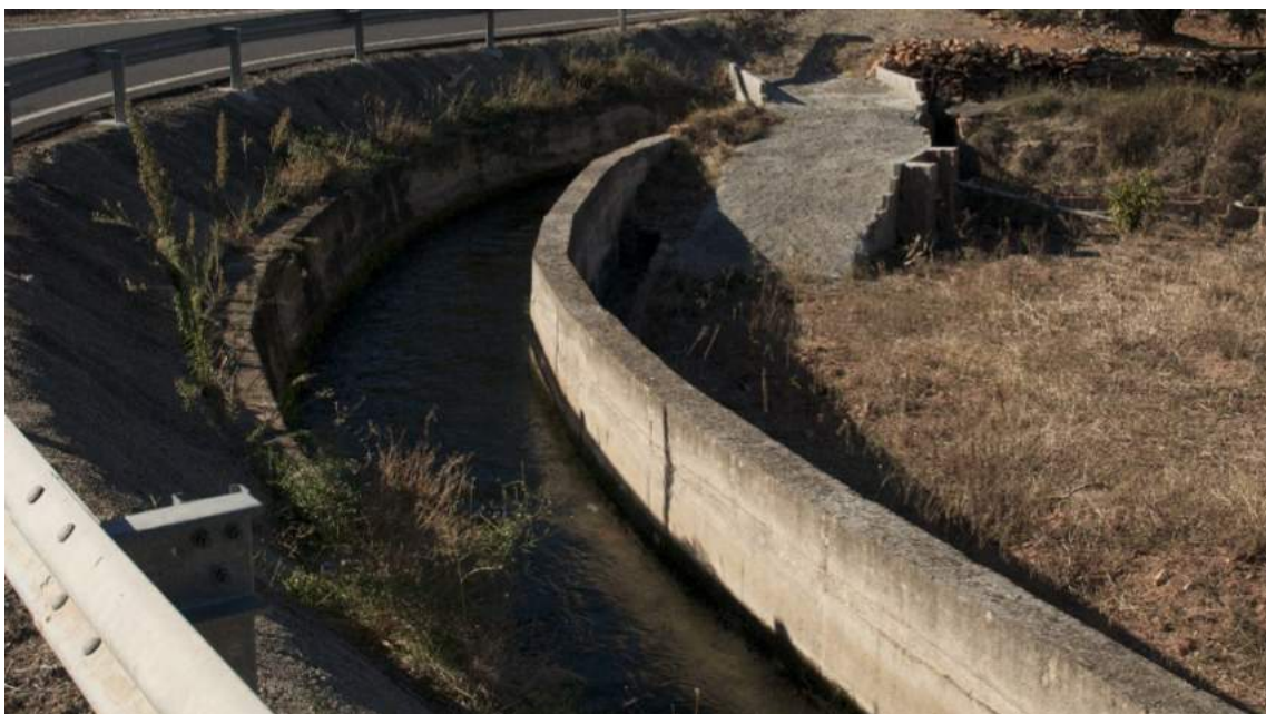
Salida del acueducto de Torres Torres.
