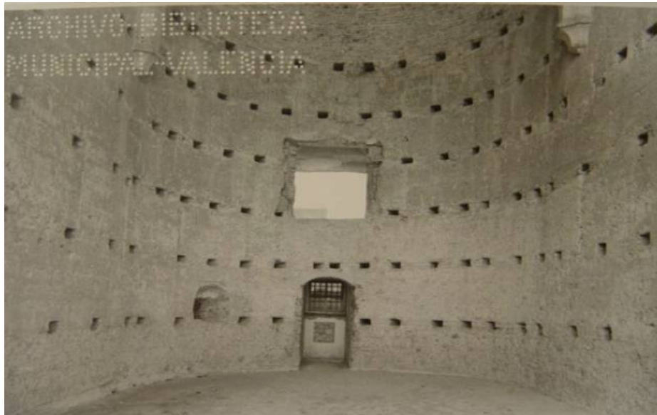
Interior de una torre de Quart (vista de frente, la derecha) en el momento de la restauración a cargo del arquitecto Carlos Soler, mediados siglo XX, donde se observan los mechinales para la entrega de las vigas de madera para el andamiaje trepante.
