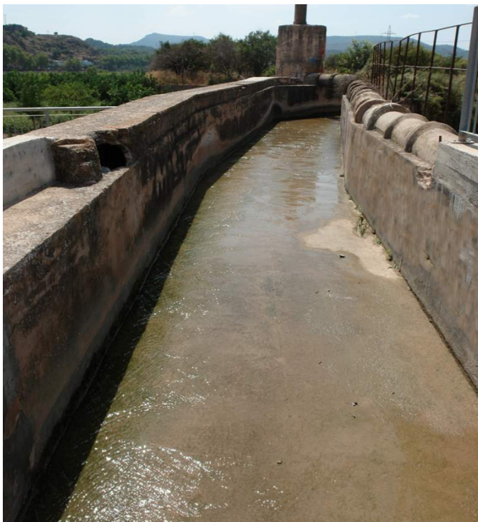
Continuación del acueducto romano recubierto por cemento actual y que hoy es llamado Acequia Mayor de Sagunt.
