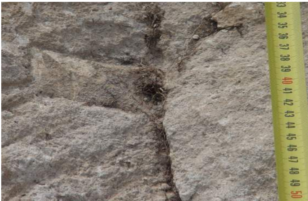
Detalle de una marca de cuña y sobrecuña al sacarlas.
