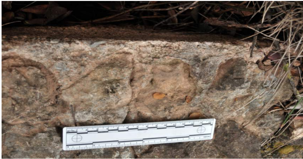
Detalle de la sección del muro de la bóveda y de su superficie superior.
