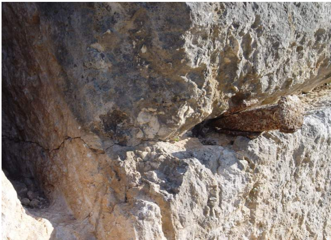
Este gran bloque romano se partió en dos, y aún se conserva una gran parte, que aún ofrece la posibilidad de ver la fractura (parte izquierda imagen) que separó el bloque, de la roca madre, debido a la presión de las cuñas.
