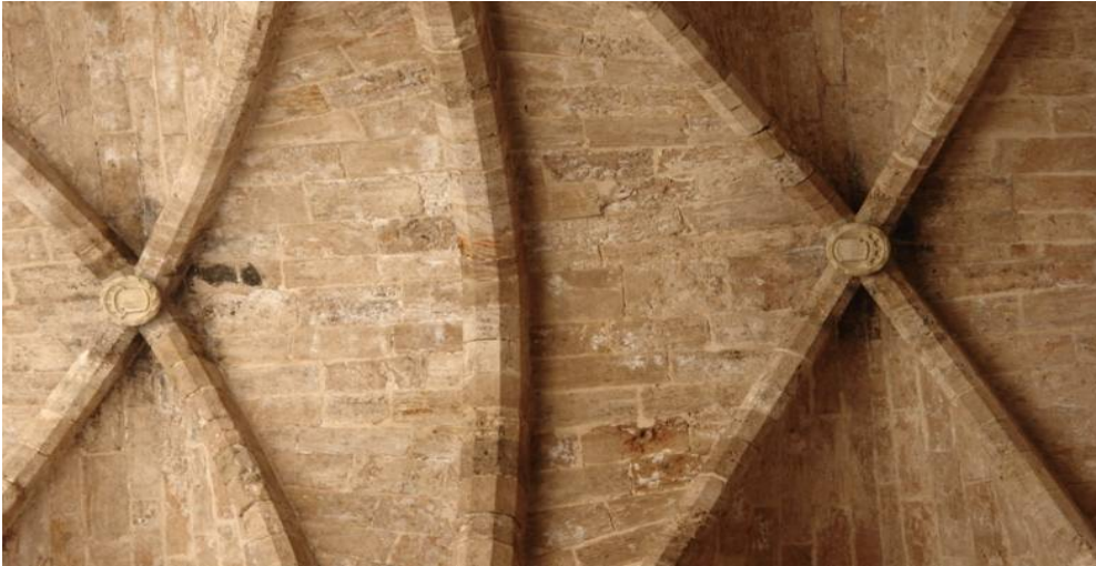
Restos de pintura sobre las dos claves sobre el portal (no en las torres)
