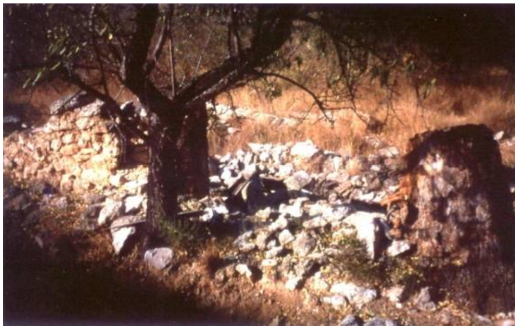
Entrada derruida del taller, aún se observa un tronco de palmera que funcionó como jamba de entrada.
