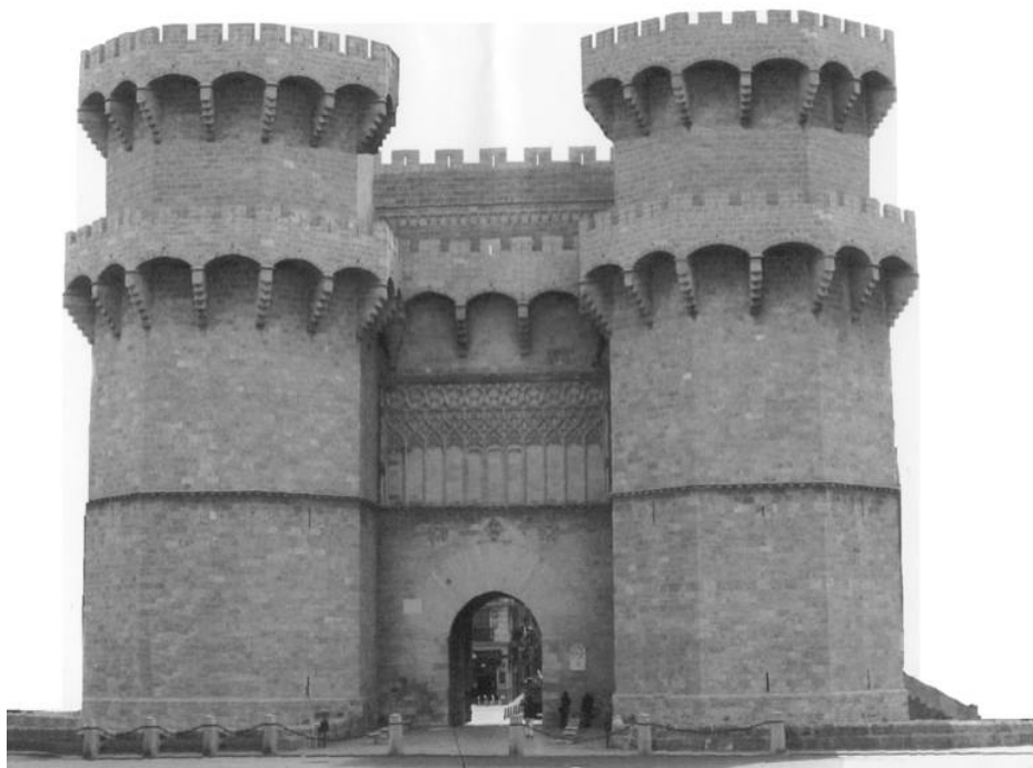
Reconstrucción de las Torres antes de la pérdida de su matacán superior.
