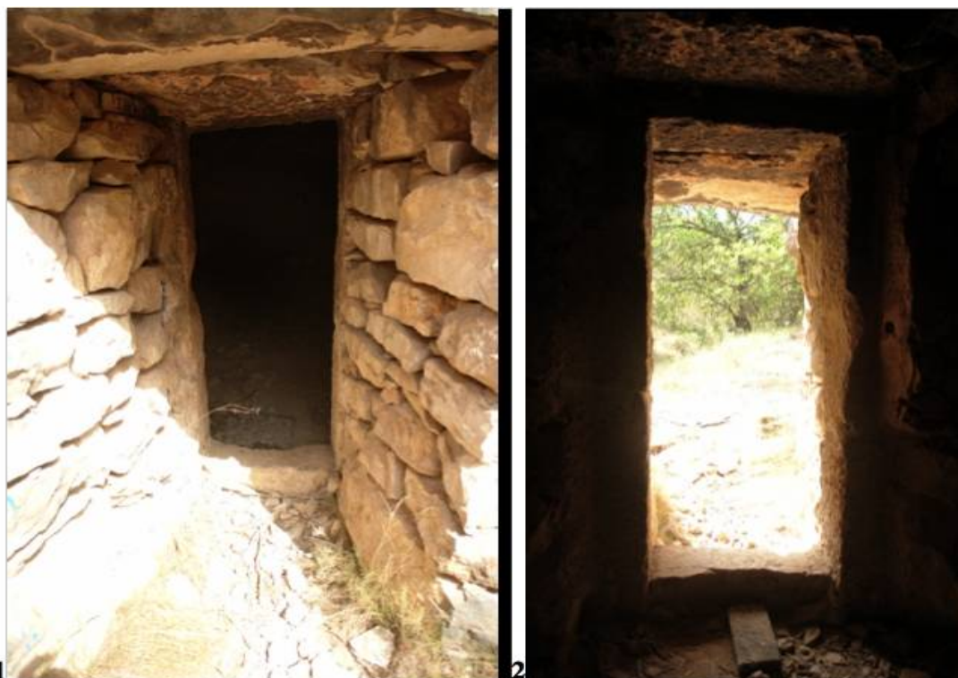
1) Entrada derecha al catxerulo // 2) Entrada vista desde el interior
