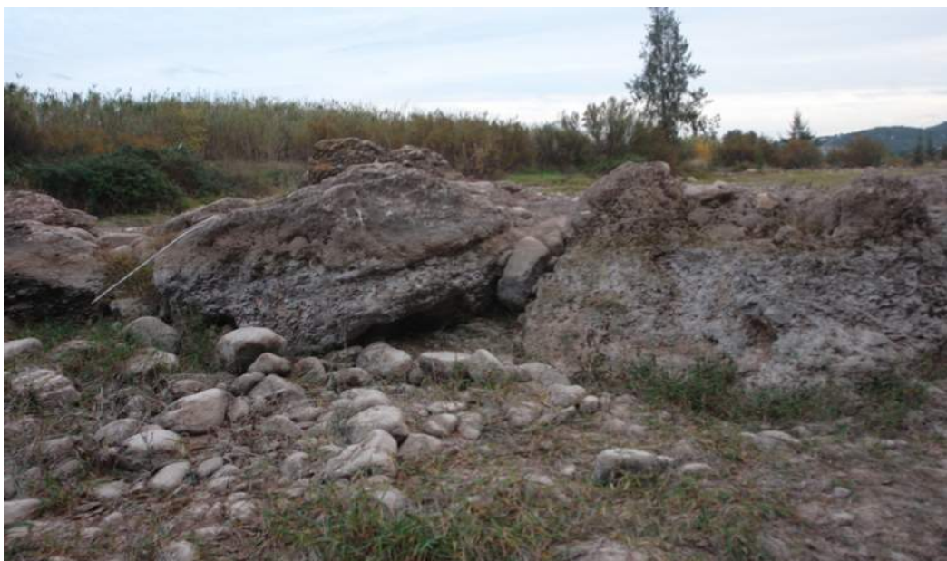
Restos inéditos de los pilares (tajamares) del acueducto romano de Estivella.
