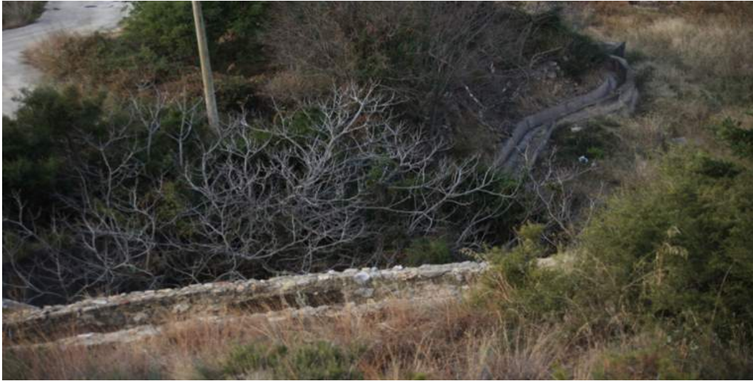
Acueducto que estamos analizando (Parte inferior imagen). Fondo de la imagen acueducto del Túria a nivel 5 metros por debajo del anterior.
