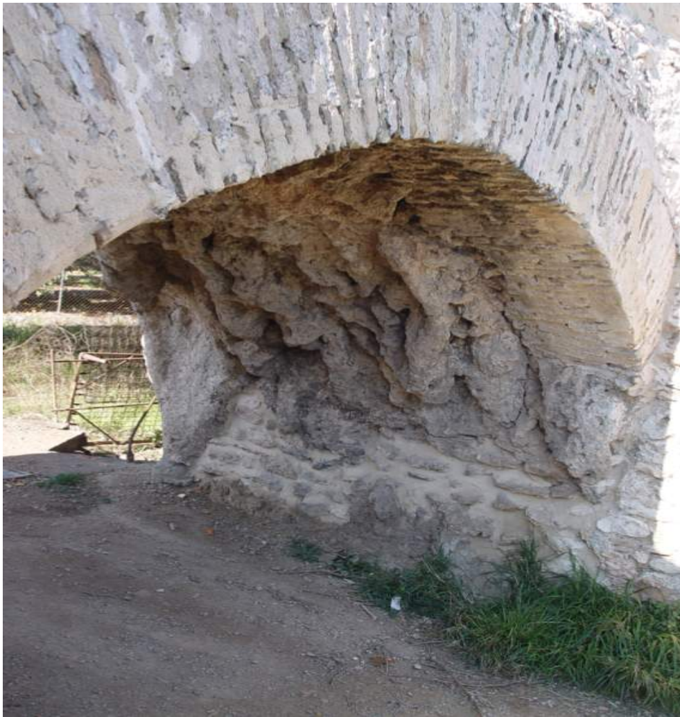
Grosor de un pilar del acueducto con engrosamientos posteriores a los lados.
