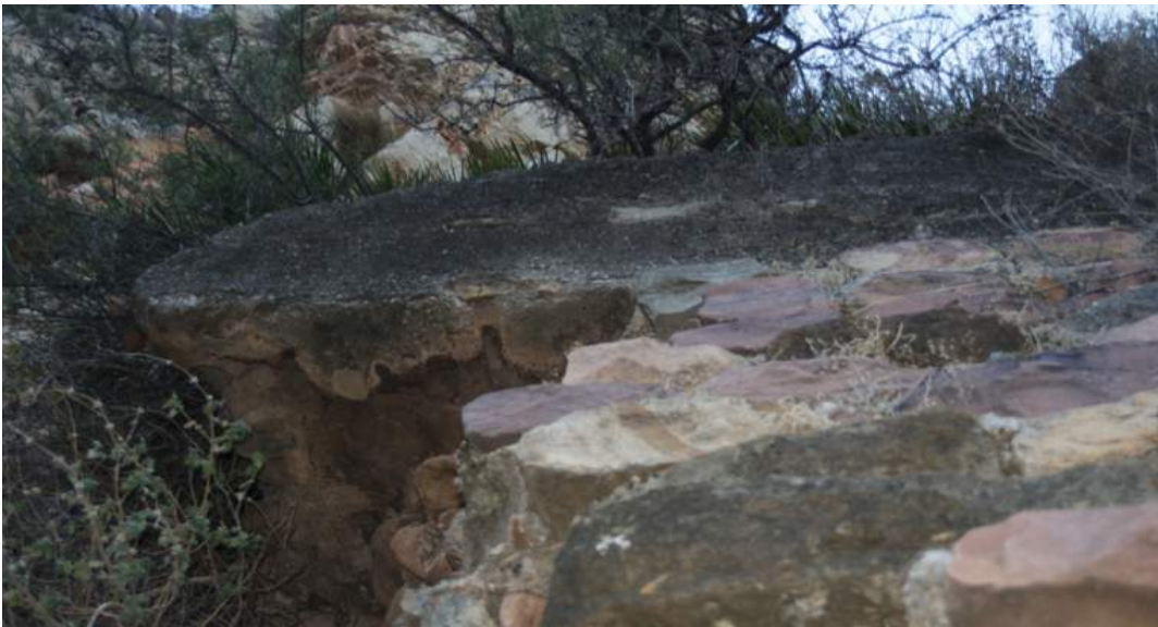
Base del canal al descubierto en su forma de construcción, descansando sobre el muro.
