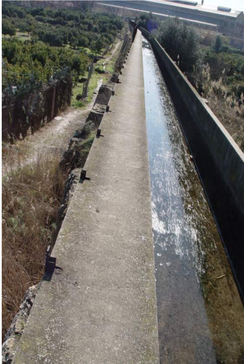
Canal del Acueducto de Manises, que adaptado según los siglos, aún esta en uso, dos milenios después.
