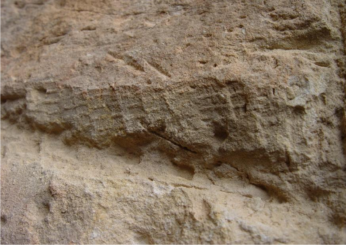
Marcas del filo dentado de un martillo trinchante medieval. Pedrera de Barxeta.
