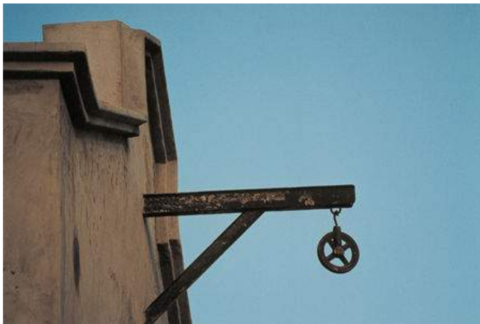
FIG-484. Corriola en un edificio del siglo XIX
