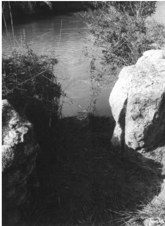
ACUEDUCTO 2. La Pea (Vilamarxant) , por donde entraba el agua del río, con restos de piedra tallada donde se ponían las compuertas para entrada del agua . Foto E.Jarabú.
