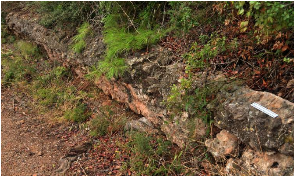
Muro lateral del nacimiento de la bóveda. Montaña de Pesta (Sagunt)
