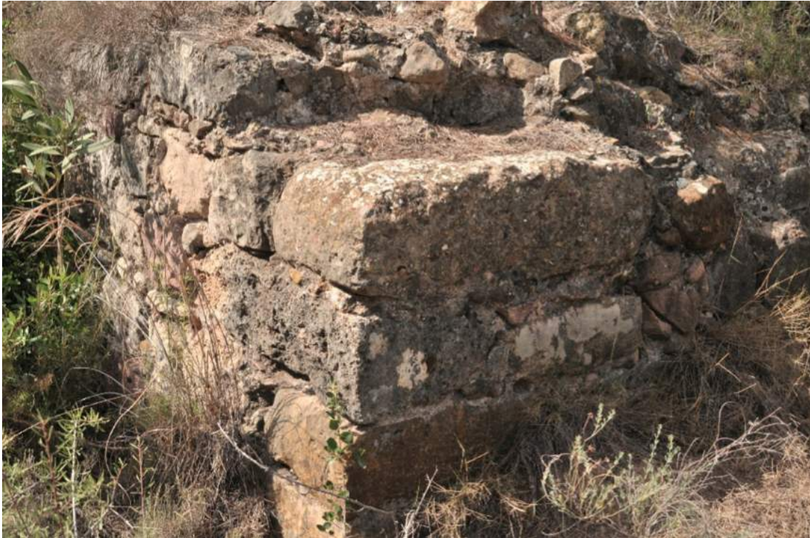
Tercer pilar en forma de tajamar.
