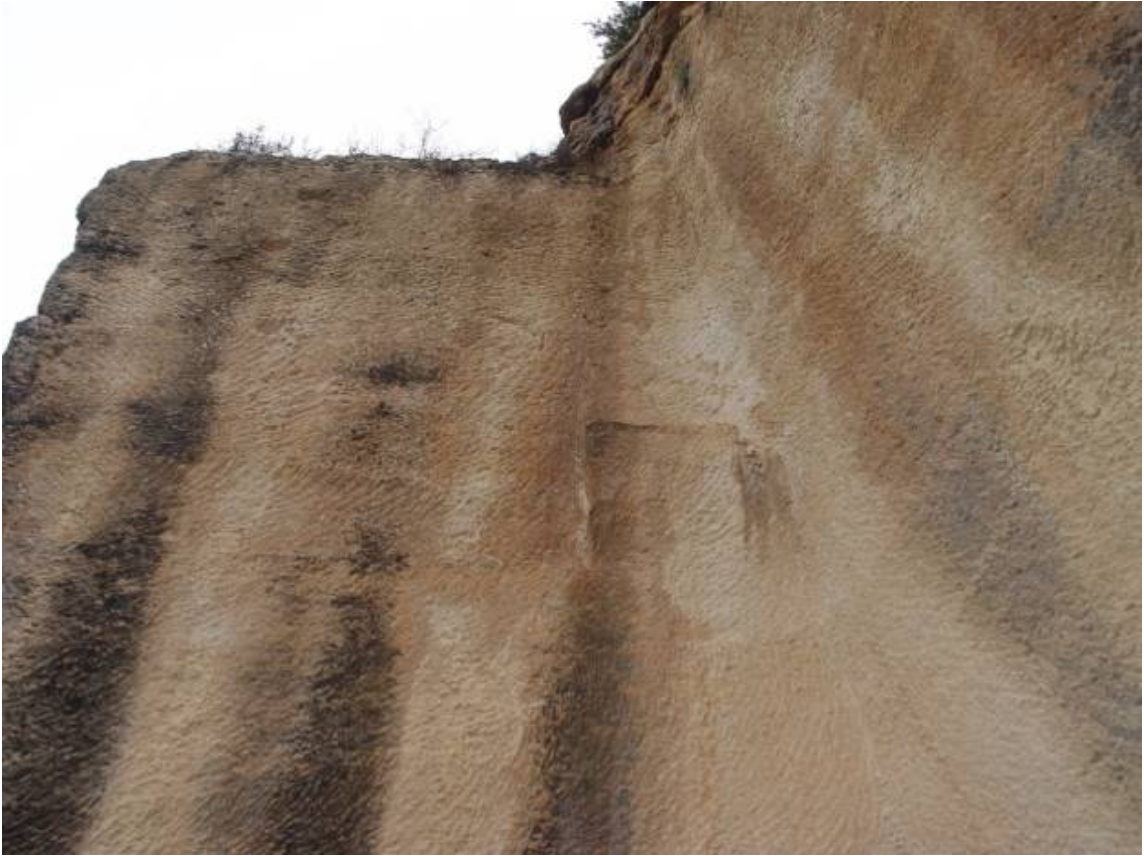
Detalle con un saliente de piedra para sostener andamios. Pedrera de arenisca de Barxeta.
