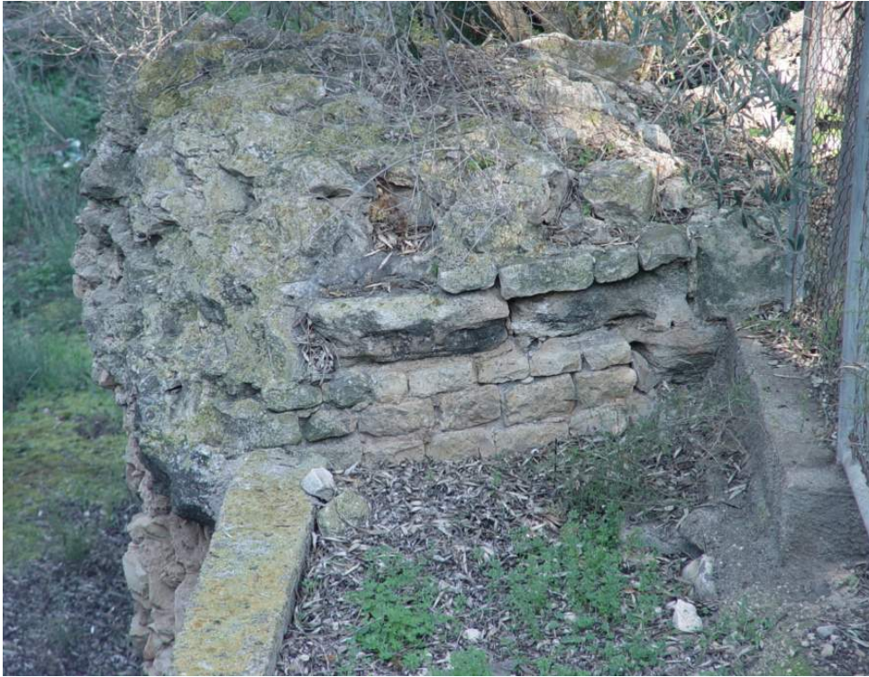
Restos del acueducto romano de Altea (Alicant), en un barranco.
