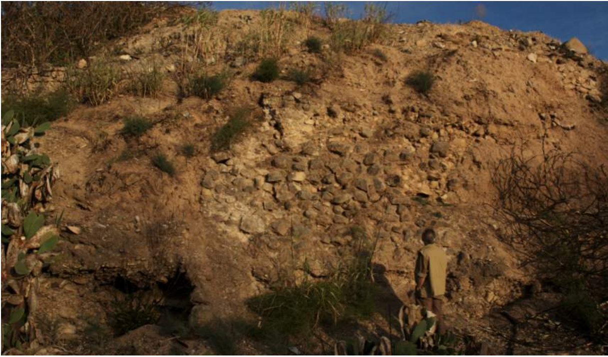
Izquierda de la imagen, cajón del canal del acueducto relleno de tierra. Derecha restos del muro romano en el lateral norte del río Túria.
