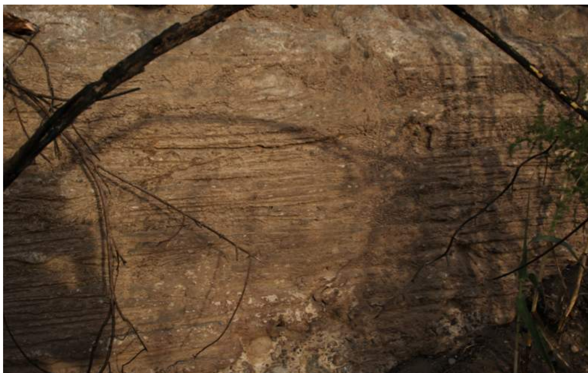
Reparación medieval del hueco que había bajo el muro romano por erosión
