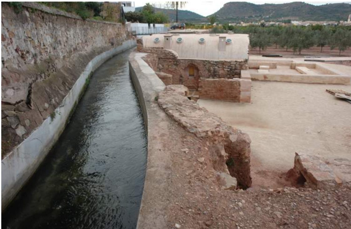
Baños y estructuras anexas vistas desde el acueducto
