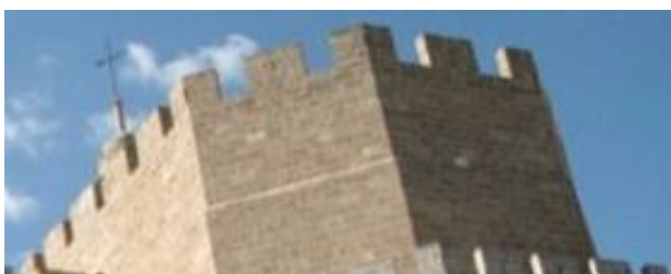
Detalle con el escalón en la pared donde estuvo la otra corona d almenas
