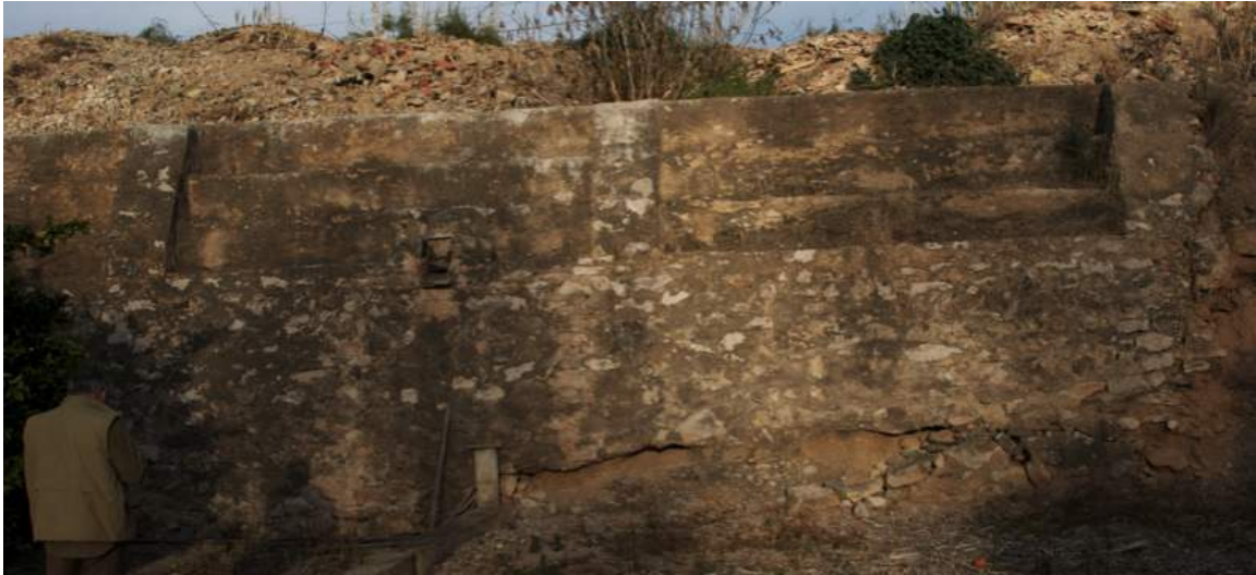
Muro escalonado con contrafuertes con agujero con compuerta pequeña desagüe, reparación muro de la época de la República española.
