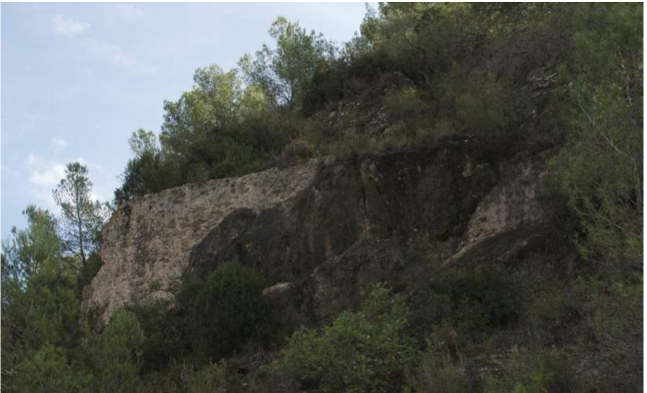
Paredes del acueducto romano de Alfara de la Baronía.
