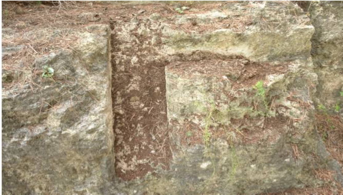
Enclava lateral para extracción de bloque
