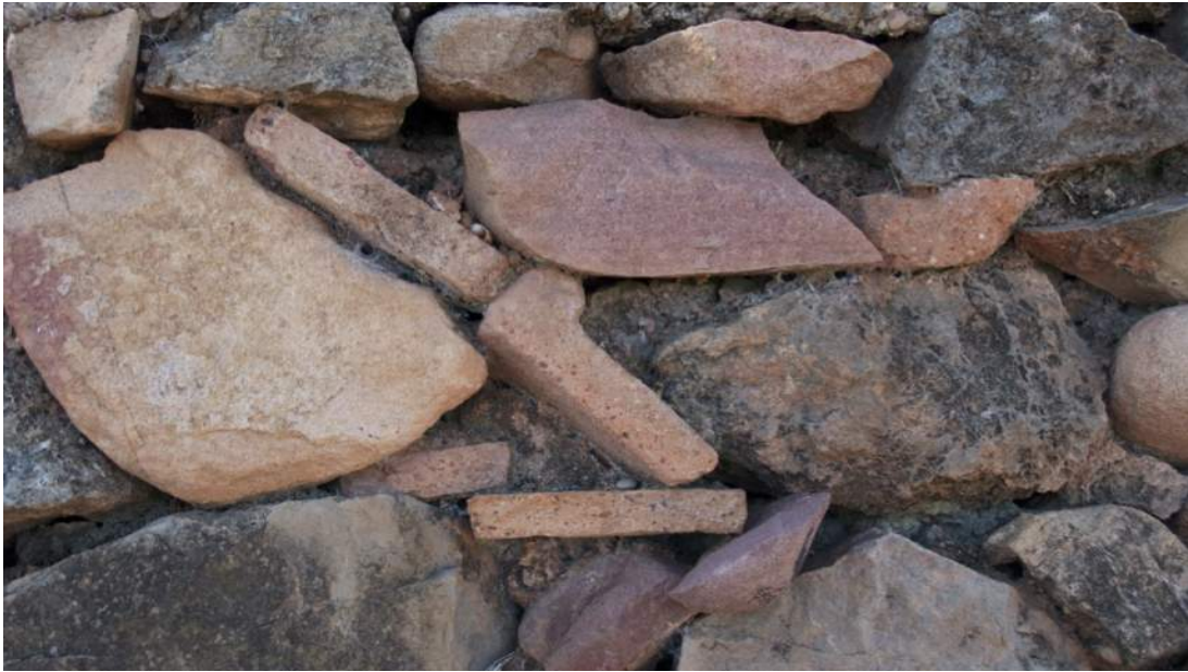
Tegulas romanas fragmentadas en un muro de una vila junto al Barranc de les Foies o “el barranquet”.
