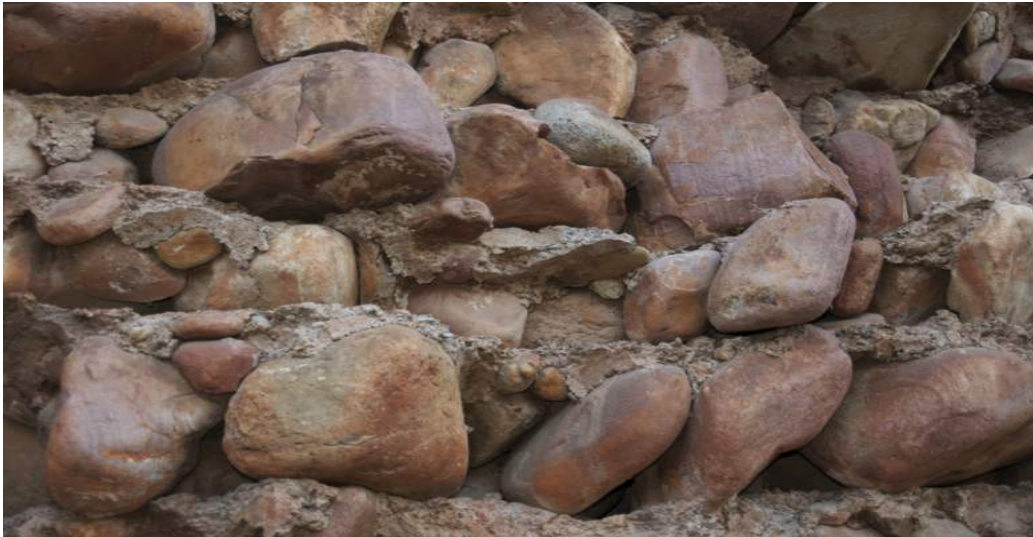
Relleno de la parte superior del acueducto.
