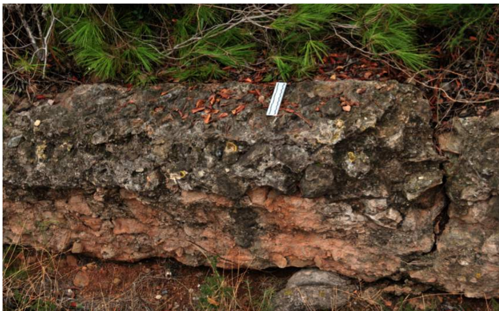
Detalle frontal con el opus incertum de cuerpo del muro.
