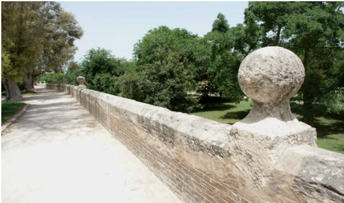
Imagen de bolas de piedra y su barandilla de piedra junto al río.
