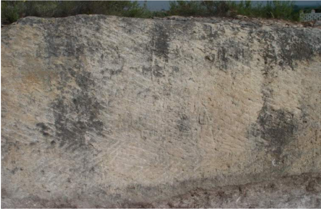
Detalle de frente de cantera con marcas de herramienta en forma de “comillas”, también llamada en francés “ chevrons ”.
