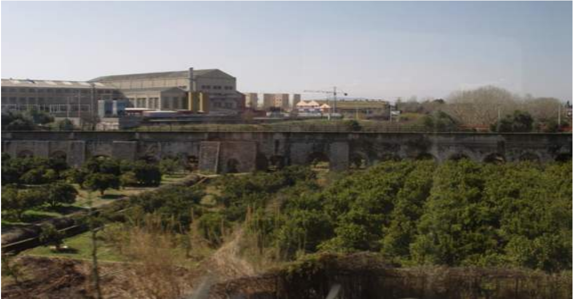
Acueducto en Manises salvando un barranco.
