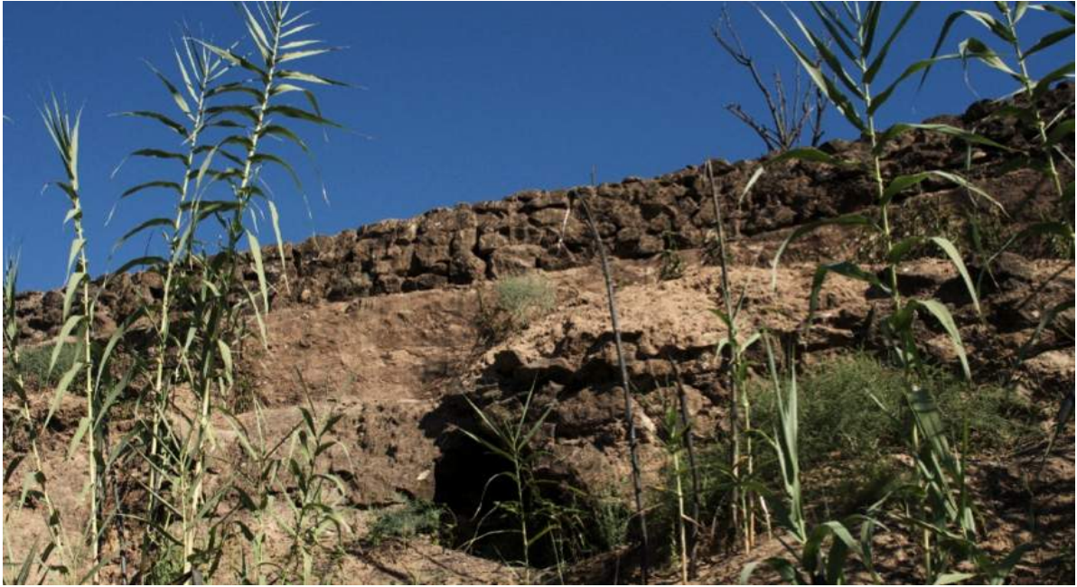
Muros y contrafuerte de cronología adscribibles al siglo XVIII, parte superior s.XX.
