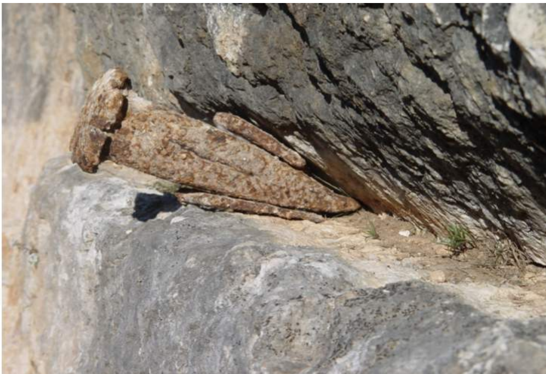
Imagen de la cuña romana de l'Enova en el entrante lateral del bloque.
