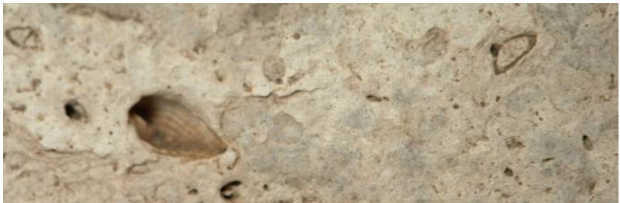
Detalle lateral de un bloque y su fósil erosionado de la pared de la Llotja en su parte trasera
