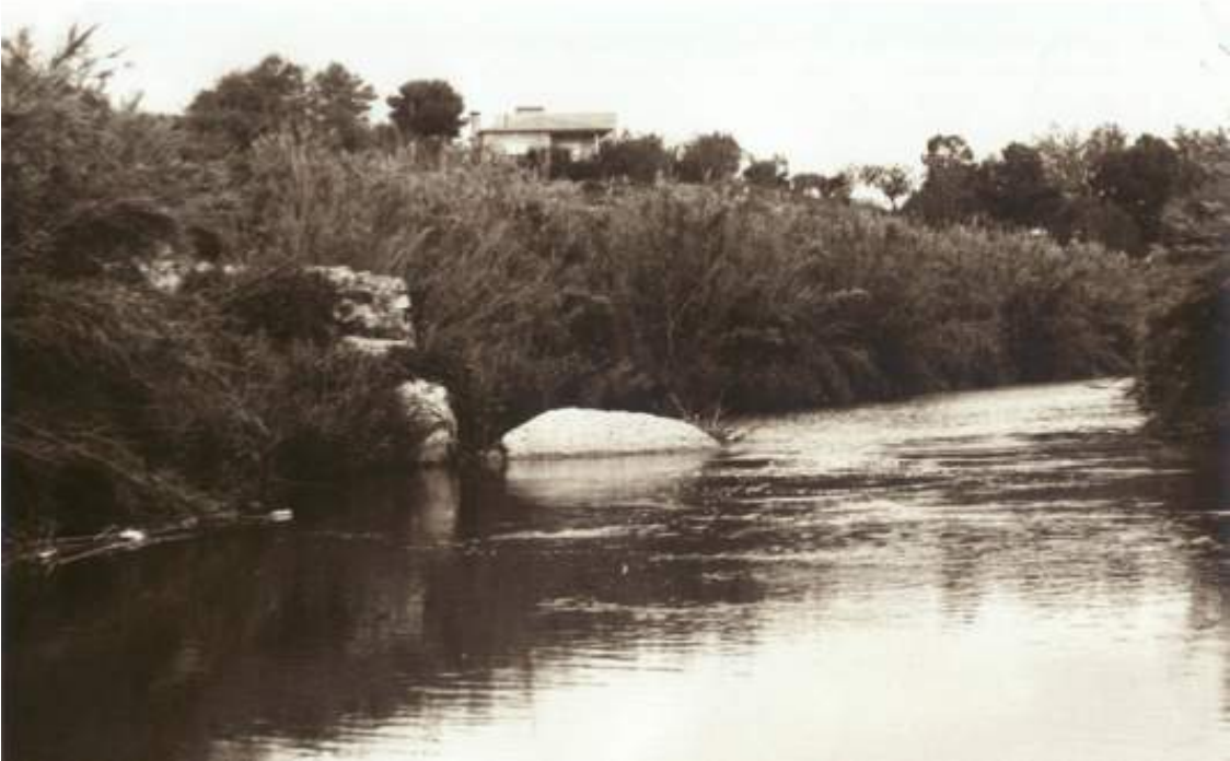
ACUEDUCTO 3. Nacimiento en Riba-roja, junto Valencia la Vella. Parte desplomado. Foto E.Jarabú.
