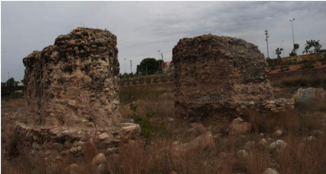
Dos tajamares del puente-acueducto de Sagunt
