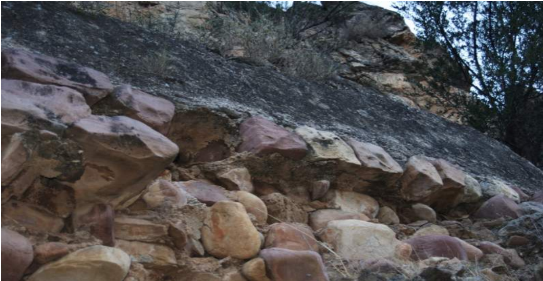
Zona de contacto entre el canal, la parte conservada del frente del muro con bloques tallados y el relleno irregular interior.
