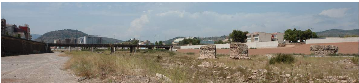
Tajamares del puente-acueducto de Sagunt en el lecho del río Palancia
