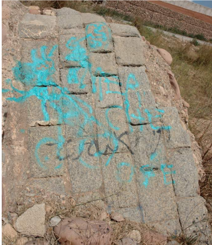
Tajamar caído del puente-acueducto romano de Sagunt con los sillares de pieza azulada aún en su lugar original forrando el núcleo.
