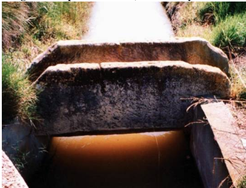
Sarcófago tardo-romano, junto a la Muntanyeta dels Sants para servir como puente. Eliminados los extremos para poder pasar por él.
