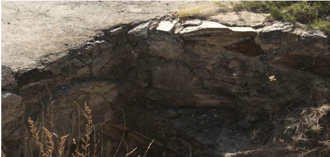
Construcción del 1987 para tuberías, cubriendo canal acueducto romano
