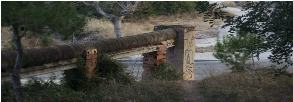
Tubería de los años 50 que atraviesa el barranco de la Travessa (al fondo).
