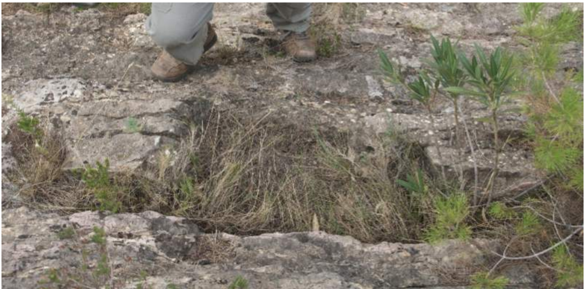
Hueco para colocar el entramado de madera para poder construir el acueducto.
