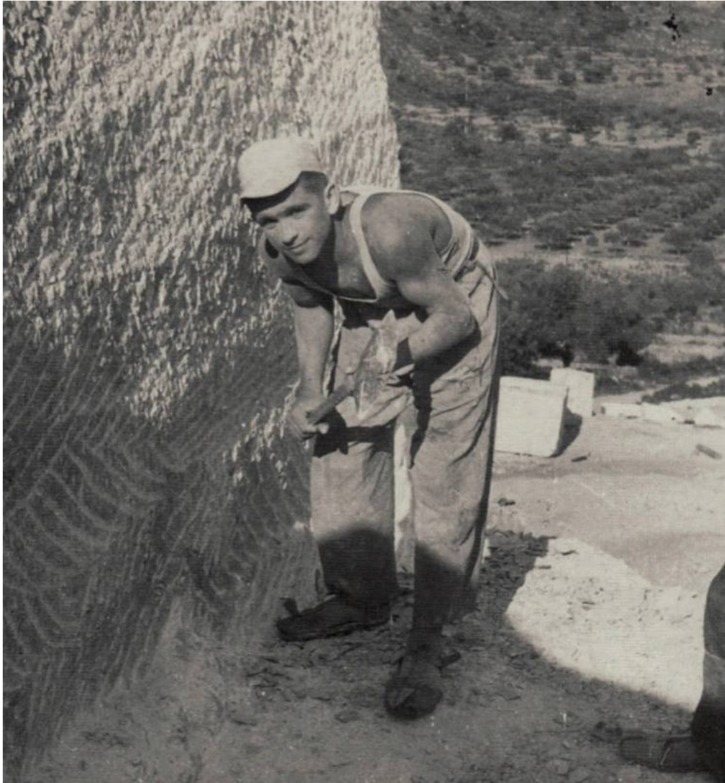
Pedrapiquer trabajando al tajo con la escoda (Barxeta) . Foto Abel Soler
