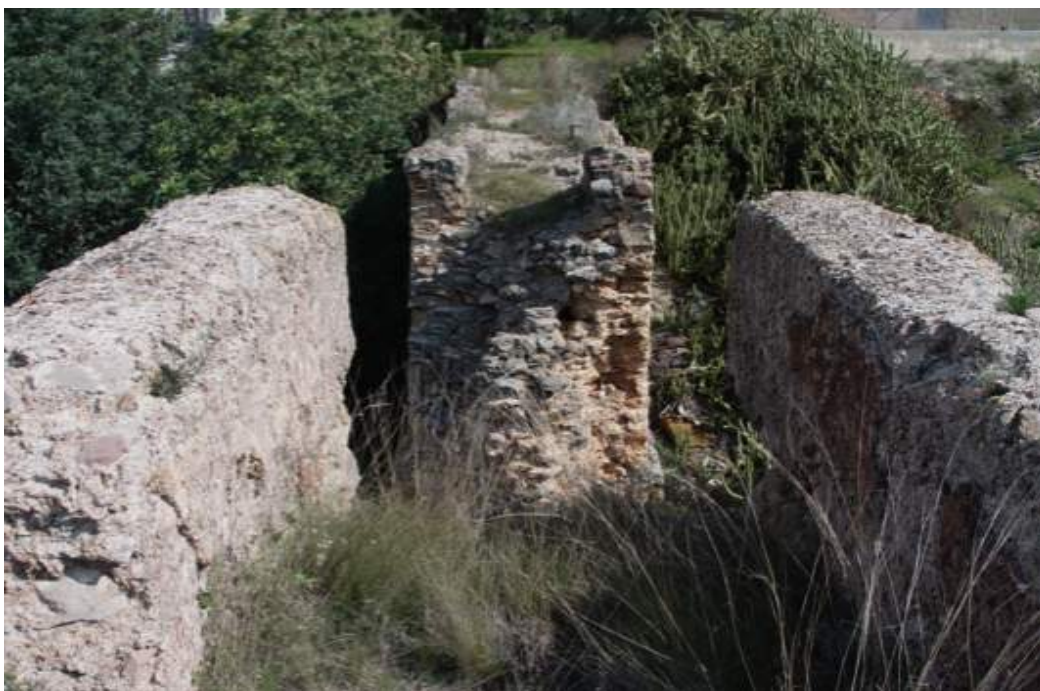
Canal Interior del Acueducto. Riba-rojo del Turia (Valencia)
