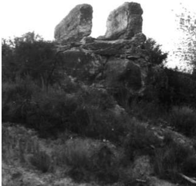
ACUEDUCTO 2. Entre Manises y Riba-roja. Foto E.Jarabú.
