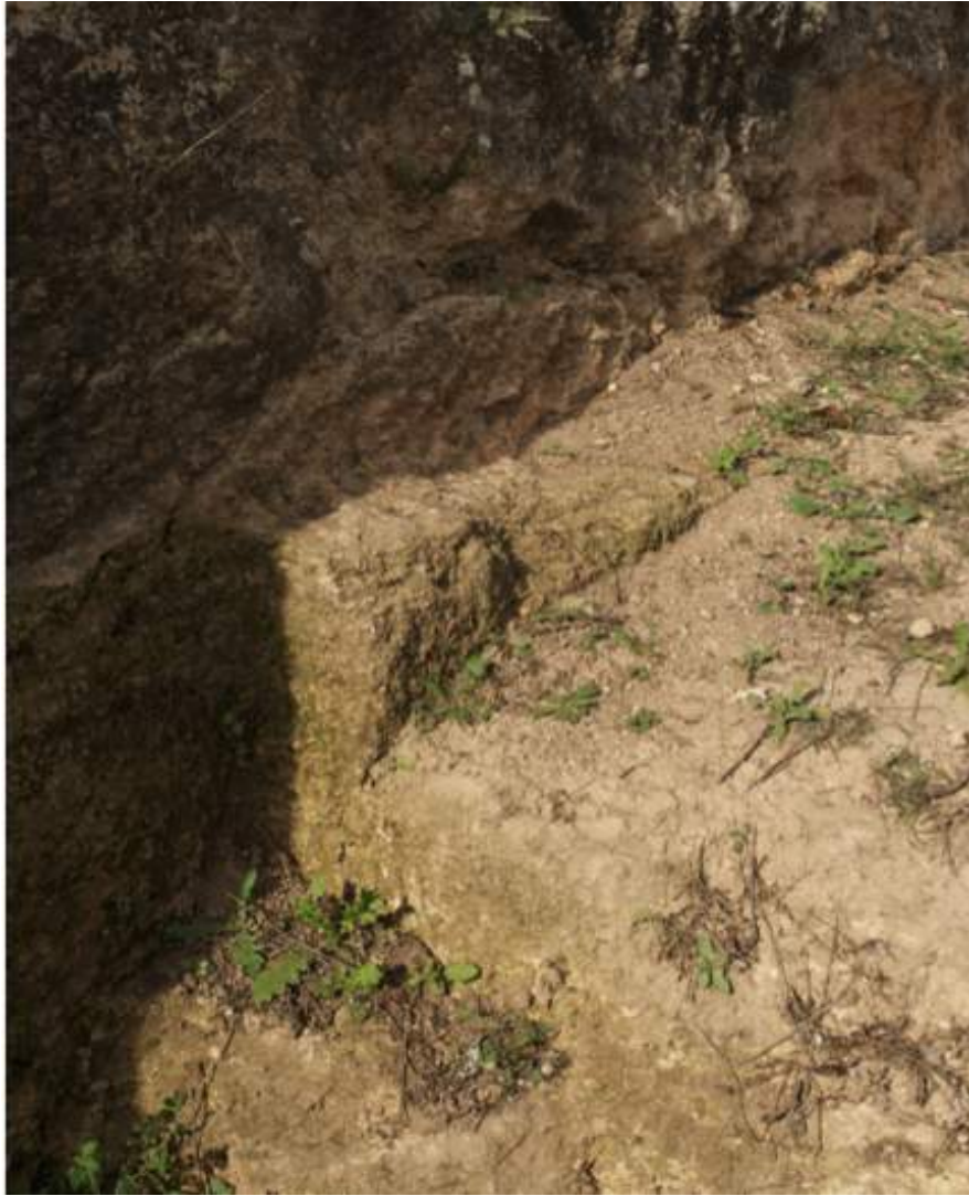
Detalle del pilar en el hueco del canal.
