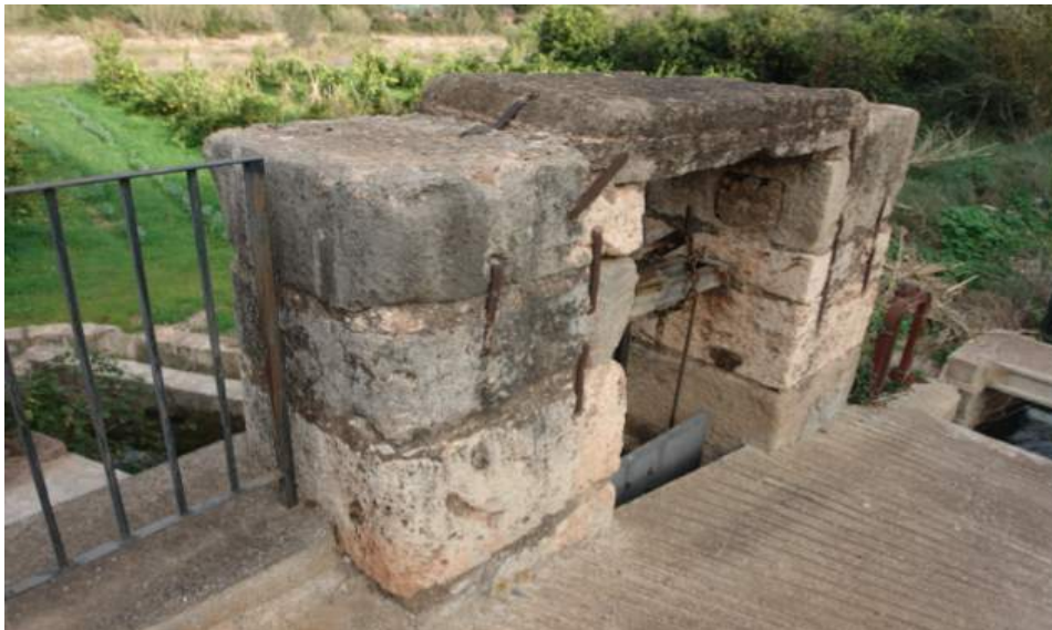
Compuerta con bloques reutilizados en el siglo XIX en la acequia- acueducto. Algar del Palancia.
