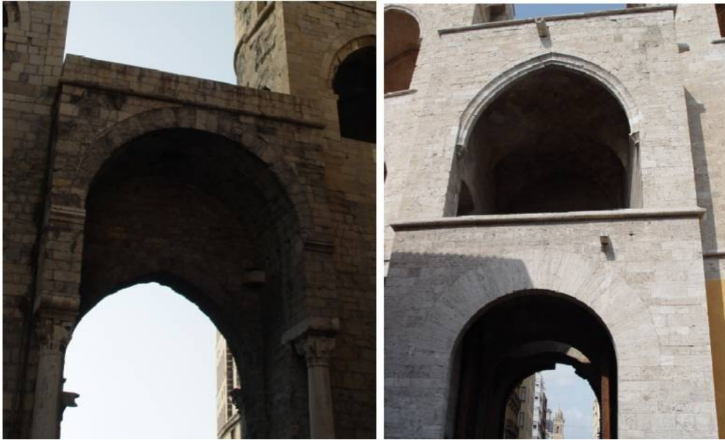
1. Cuerpo saliente en la entrada de la Porta Soprana. 2. Cuerpo saliente Portal de Quart
