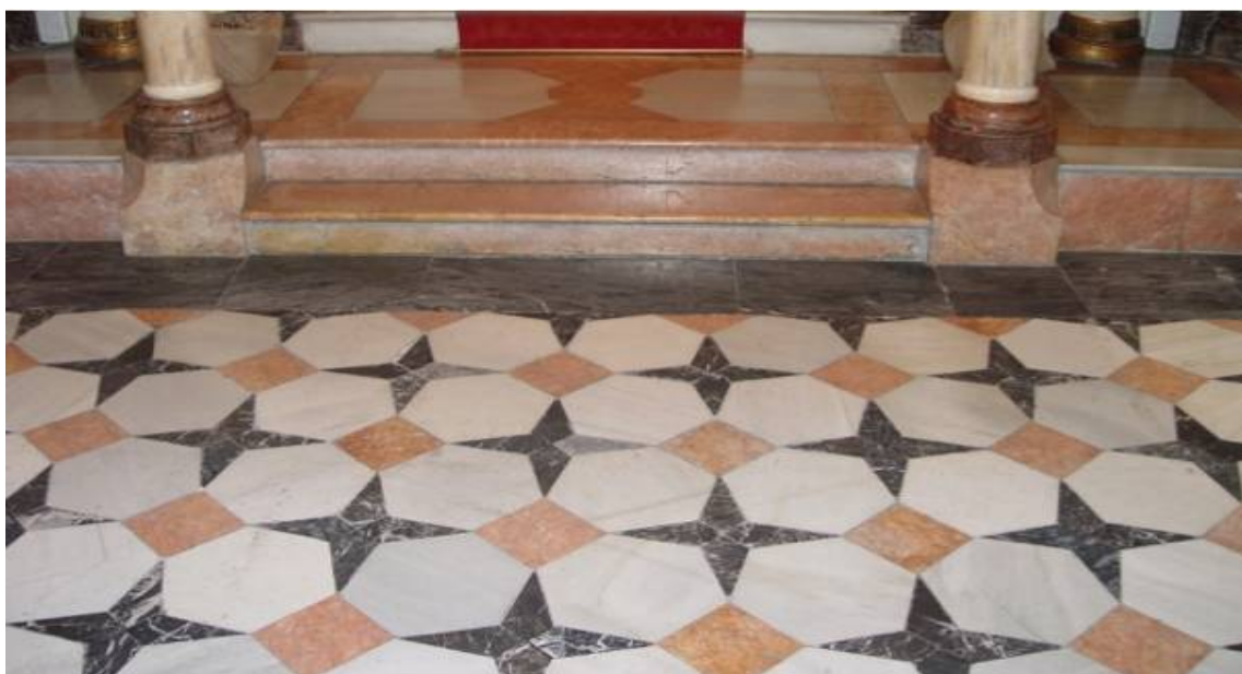
Detalle de algunos de los suelos con placas de mármol de Barxeta, en el palacio.
