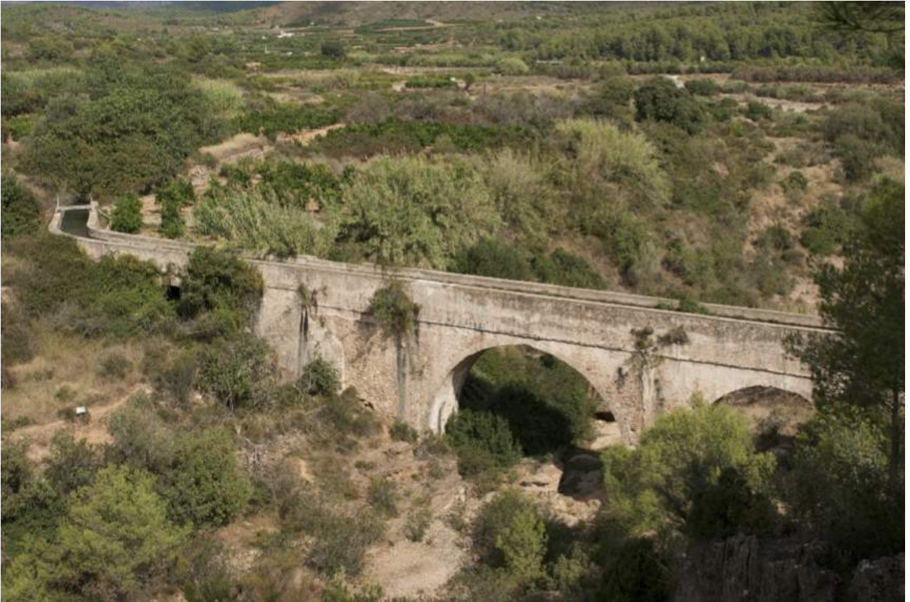
Acueducto medieval utilizado hasta la actualidad, sustituyendo al romano en el barranco de Alfara de la Baronía.
