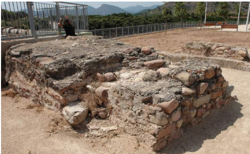
Estructura unida al Acueducto Norte de Sagunt, al margen Norte del río Palancia. Posible Torre de agua.
