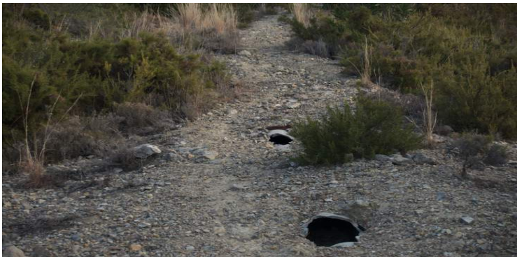
Tuberías en la parte superior de la colina bajando hacia Sagunt sobre acueducto romano.
