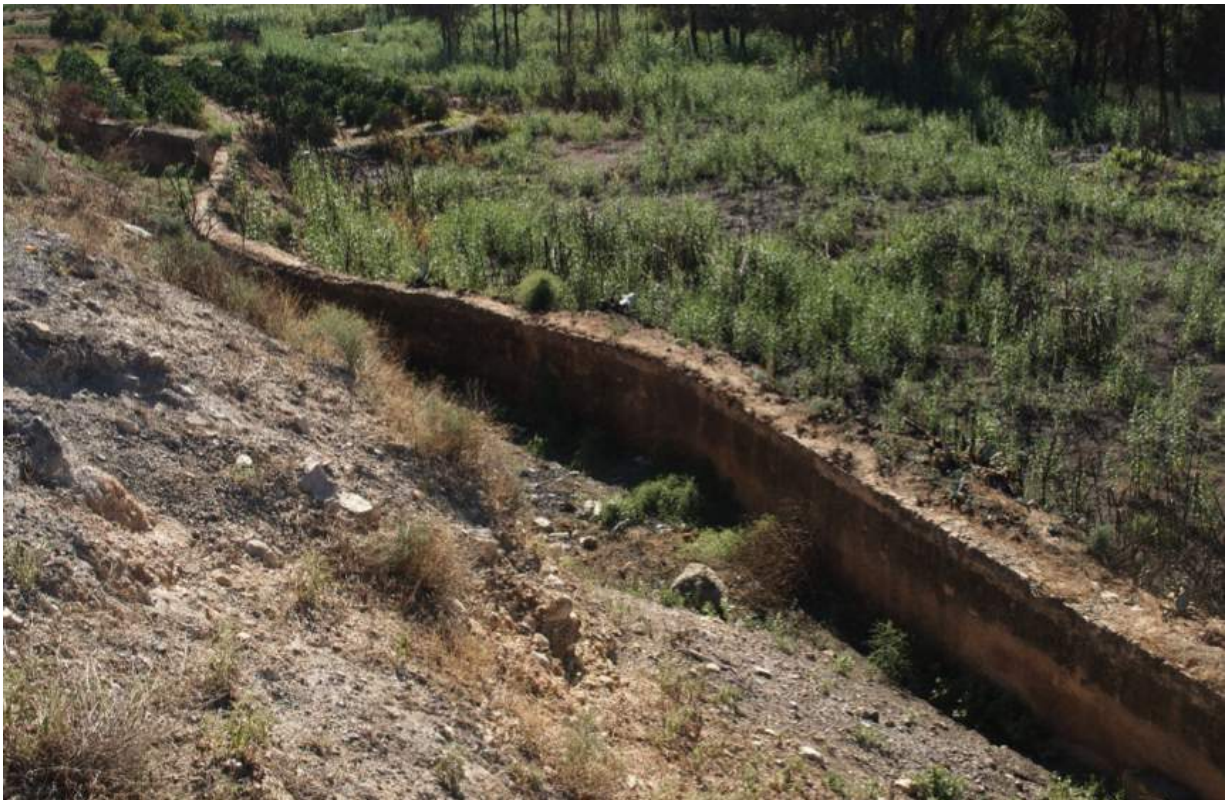
Muro en el cauce del río, continuación de los anteriores, siglo XVIII-XIX.
