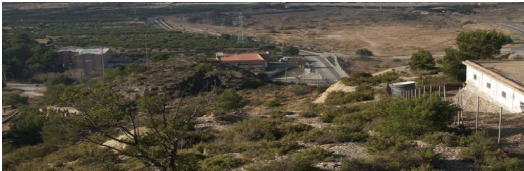
Colina con depósito moderno (derecha). Parte del descenso del acueducto (izquierda)
