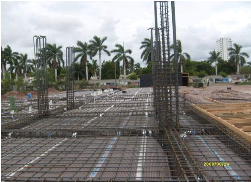
Forjado y arranque de pilares de un edificio en Miami 2003-
