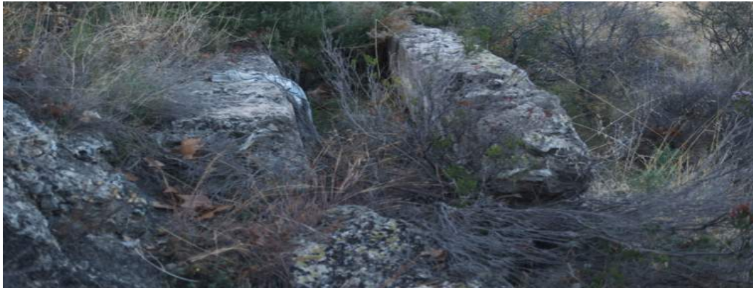
Continuación del acueducto en la ladera del Barranc de Cuiro.
