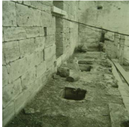
1. Matacán central de las Torres. Año 2005 // 2. Matacán central, en fase de restauración, con los botafuegos a la vista.
