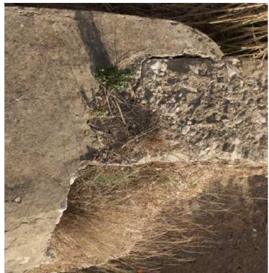
Foto1) Unión de la reparación de la República Española (al fondo), con el muro del XIX en primer plano. Foto 2)Detalle de la unión, muro siglo XIX, a derecha.
