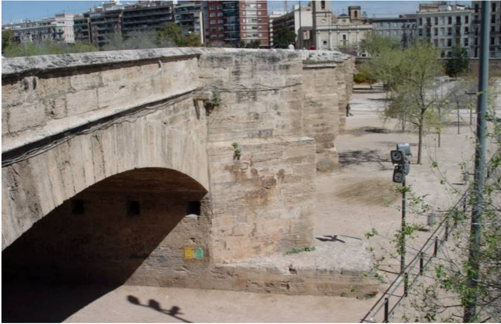
Tajamar de sección triangular sobre extraña base rectangular, único caso.
