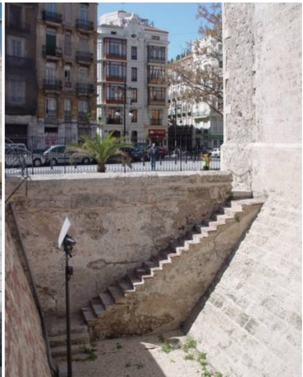
Detalle de la muralla original de las Torres de Quart con su corazón de tapiadas de cal, arena, reble y tierra. B) Restos muralla en las Torres dels Serrans, junto escalera y verticalmente su señal en el muro (parte inferior frontal de la foto).
