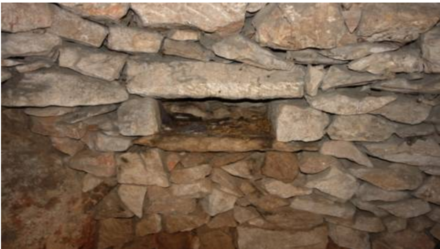
Hueco interior lateral
