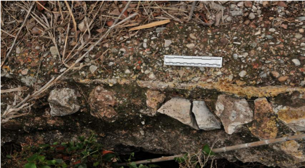
Interior del canal (mitad superior de la imagen) y base de un lateral del muro del canal (mitad inferior)
