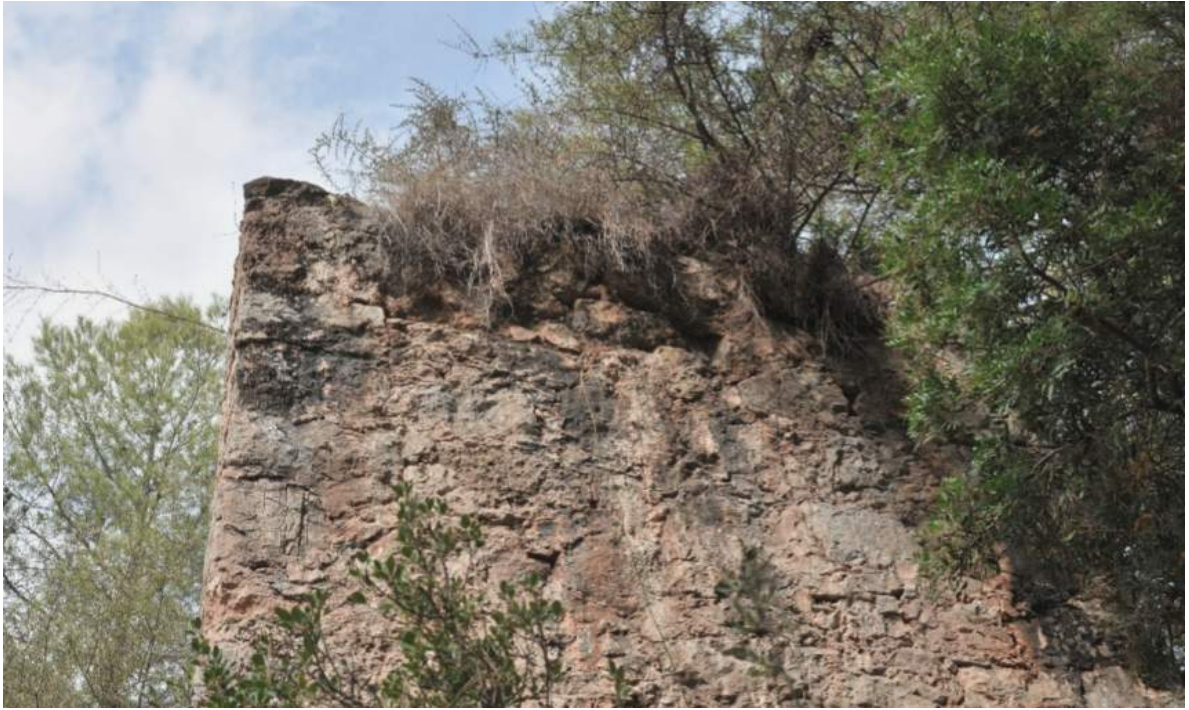
Detalle con el canal del acueducto.
