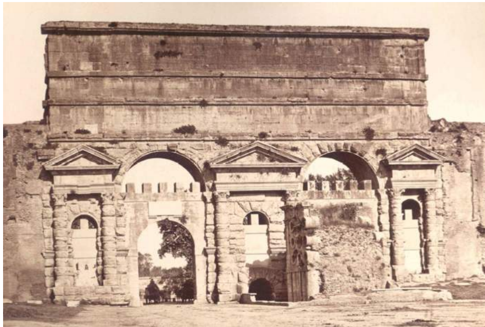
Acueducto con tres canales superpuestos en Roma. Col. Sulema.
