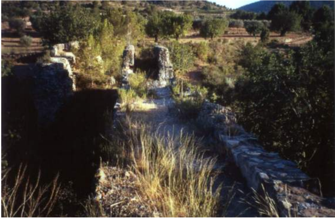
ACUEDUCTO 1. Barranc de la Pedrera, partida “dels Arquets”. Riba-roja del Túria (Valencia)
