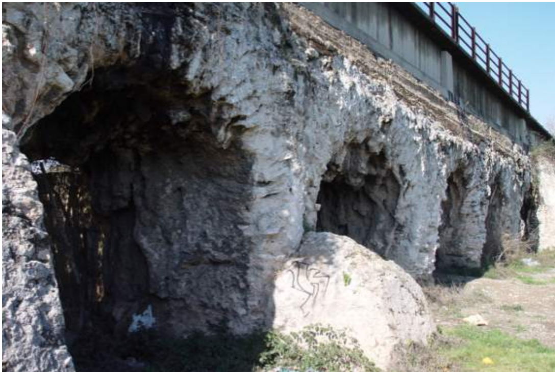
Perspectiva de algunos de sus arcos, con contrafuerte añadido en un pilar.
