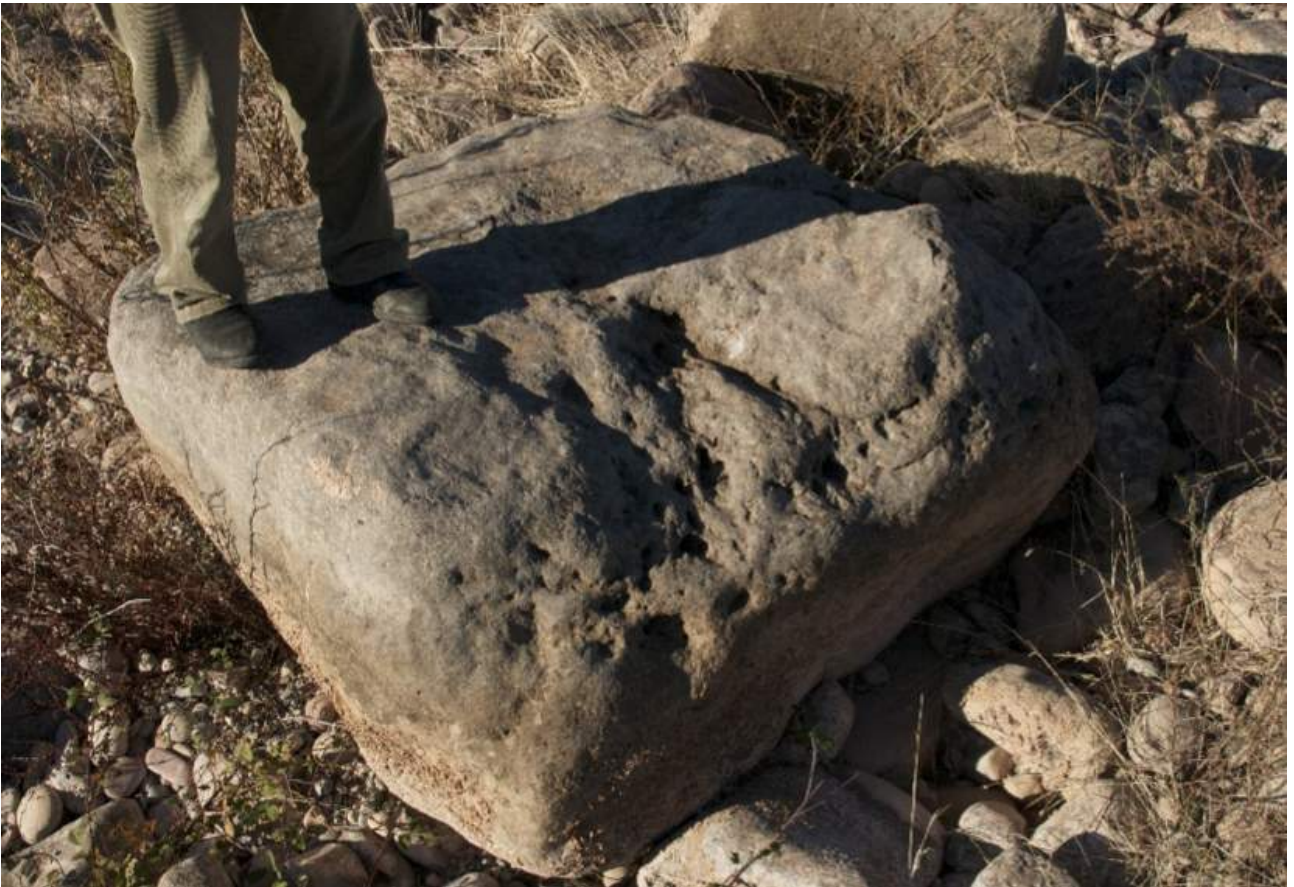
Bloque de piedra maciza, parte de la cimentación de otra base desaparecida del viaducto (no catalogada hasta hoy).
