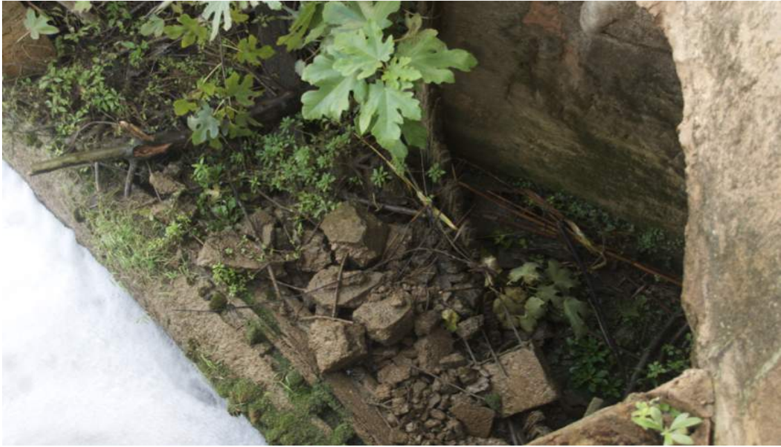
Detalle del antiguo cárcavo y restos de las puertas de madera descompuestas, del molino anterior al actual (abandonado).
