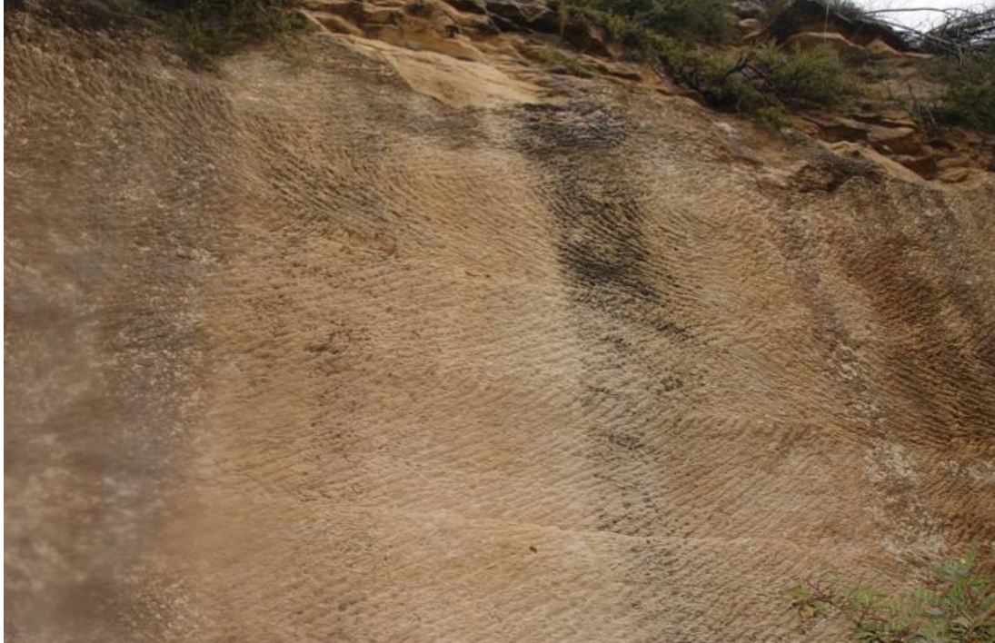
Marcas de talla en las altas paredes de arenisca de las canteras de Barxeta.
