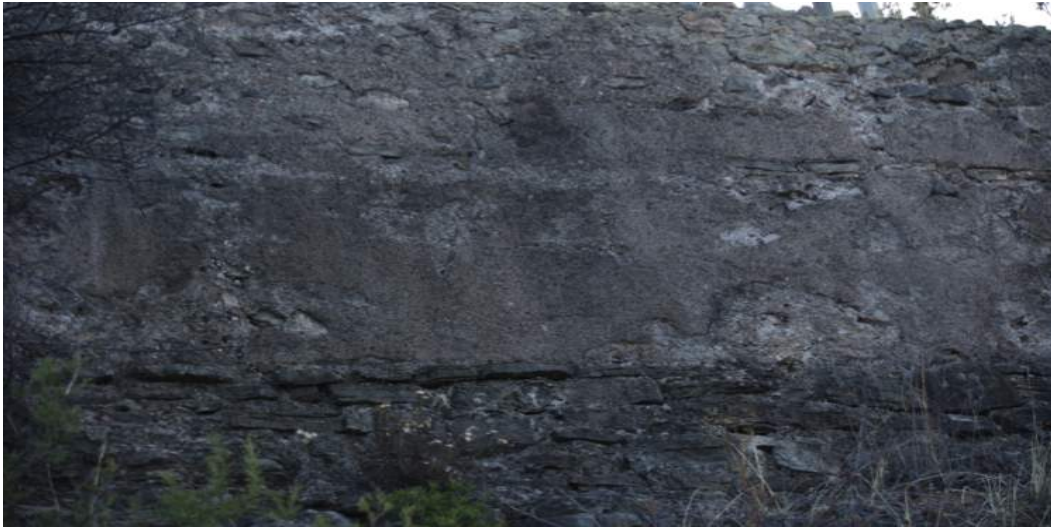
Otro detalle de las tres tongadas, con los agujeros del andamiaje, tapados.
