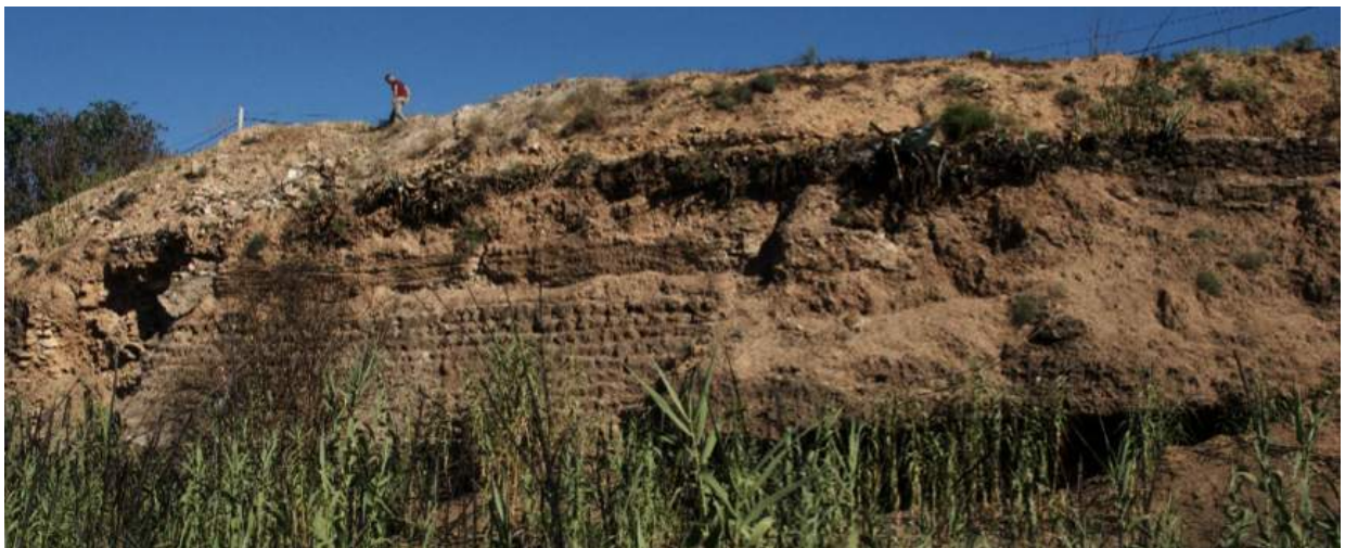
Izquierda:hueco del canal; derecha: muro. Base de ambos grava natural compacta.
