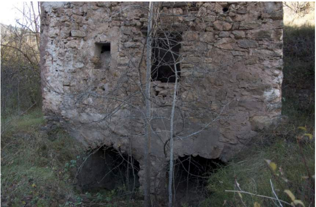
Detalle de la parte inferior del molino.
