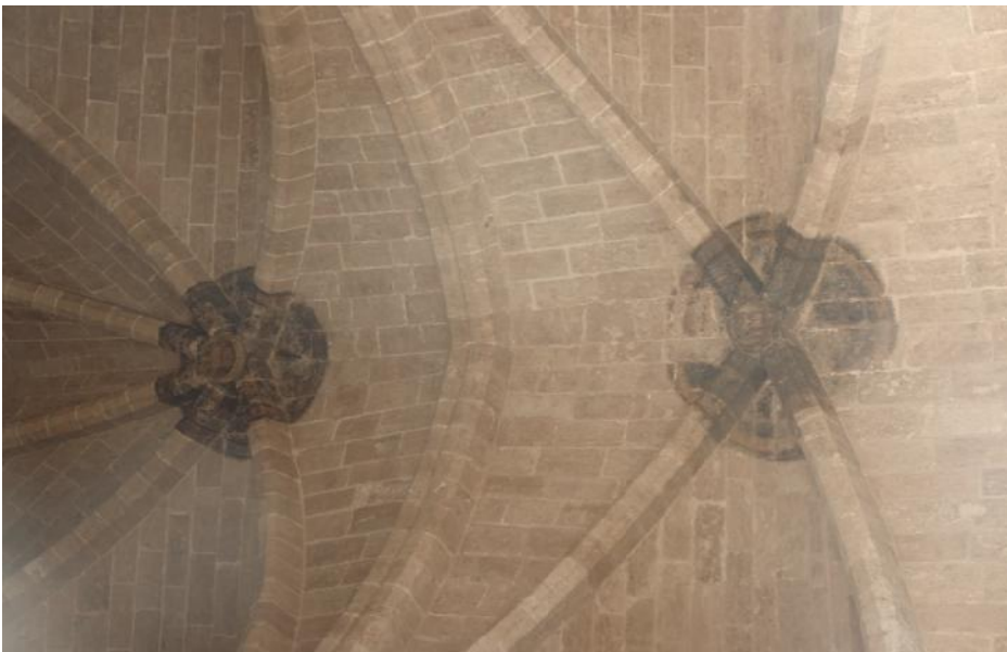
Claves pintadas (vista la torre derecha). Parte cerrada al pñ blico.
