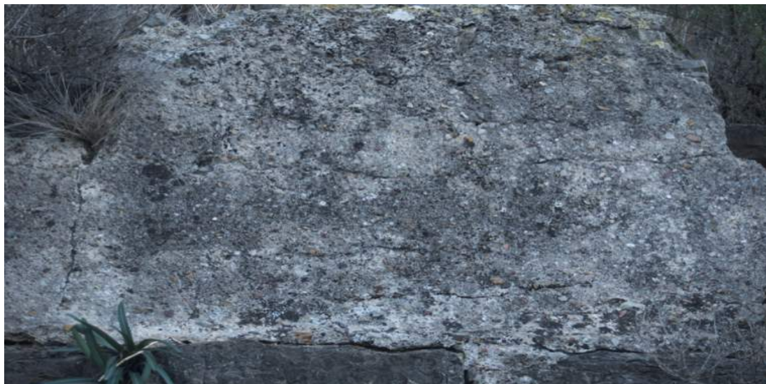
Detalle de la pared exterior del canal ( specus ) del acueducto
