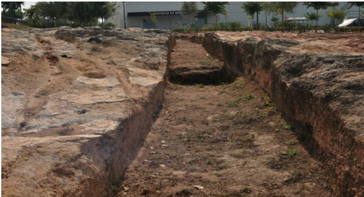
Detalle del canal del polígono de la pobla de Vallbona con su hueco en el trayecto
