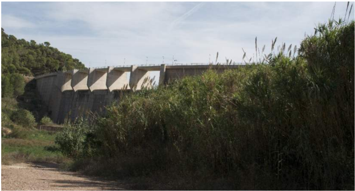
Presa de Algar. A la derecha, cañar por donde discurre el canal romano/Acequia mayor de Sagunt.
