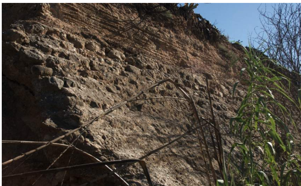
Parte inferior y superior, mortero huecos de cañas, reparación S.XIII-XIV d.C.
