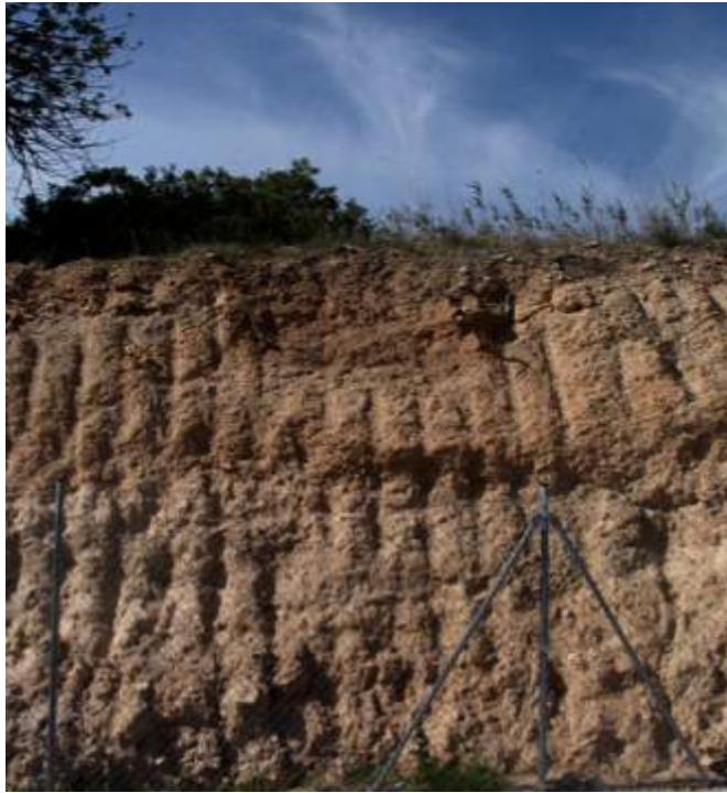
ACUEDUCTO 2. Excavado en tierra arcillosa compacta. Riba-roja del Túria (parte superior de la imagen)
