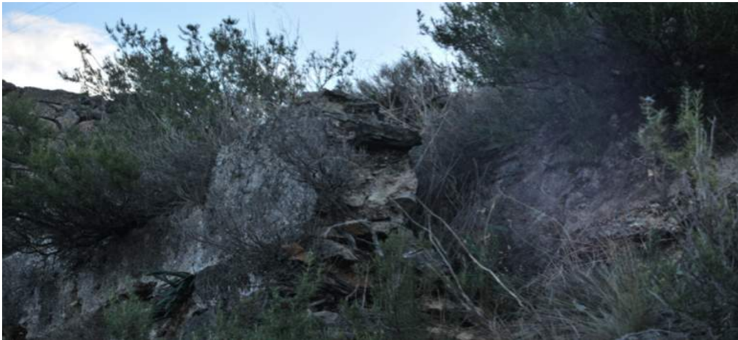
Acueducto antes de girar la ladera y meterse en el llamado barranco de Cuero.
