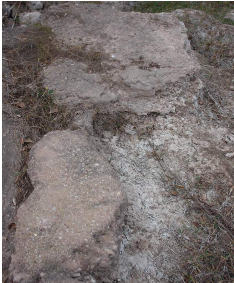
Imagen del canal con el lecho de opus signinum fino.
