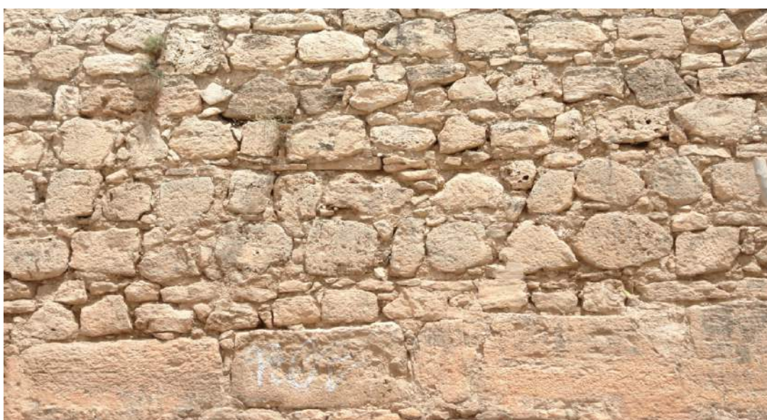
Detalle del pretil con su disposición de piedras. Piezas reaprovechados de los que encontraron en los cimientos.
