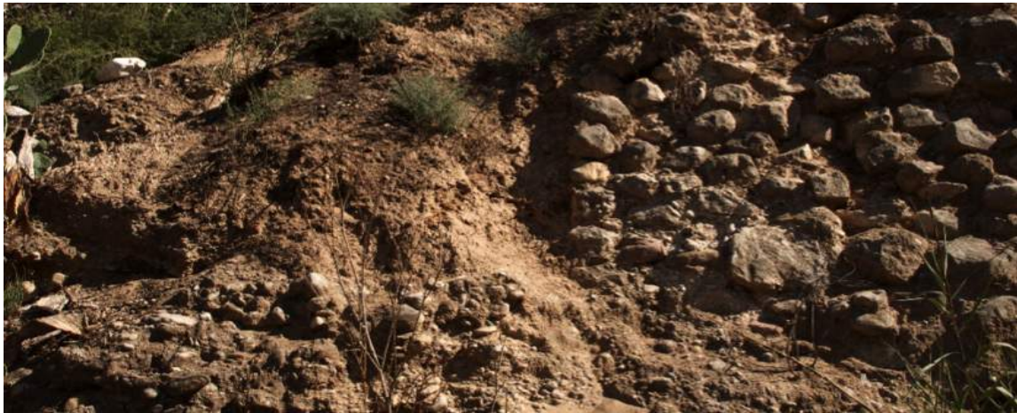
Detalle del hueco del canal.
