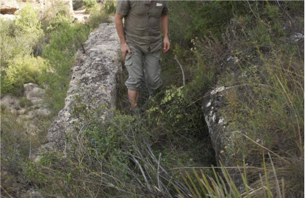
Continuación del canal interior del acueducto romano de Alfara de la Baranía.
