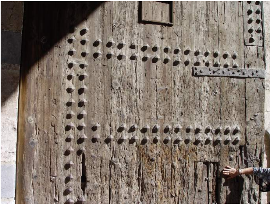
Clavos grandes con cabeza piramidal en la purta de les Torres dels Serrans.
