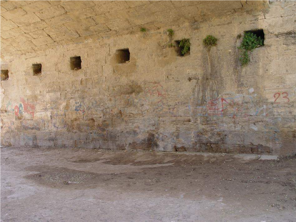
Huecos donde se colocaron los anclajes de madera de la cimbra de uno de los arcos del puente.
