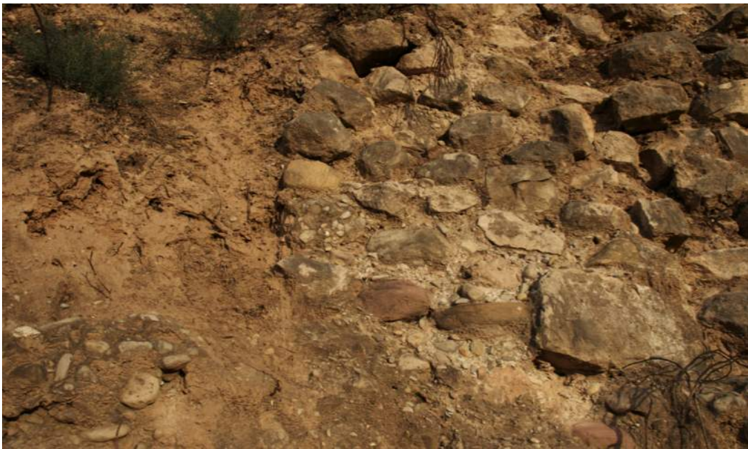
Izquierda:hueco del canal; derecha: muro. Base de ambos grava natural compacta.
