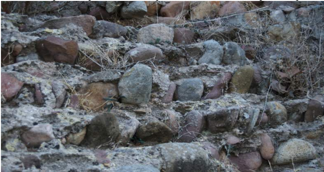
Relleno de la parte inferior del muro
