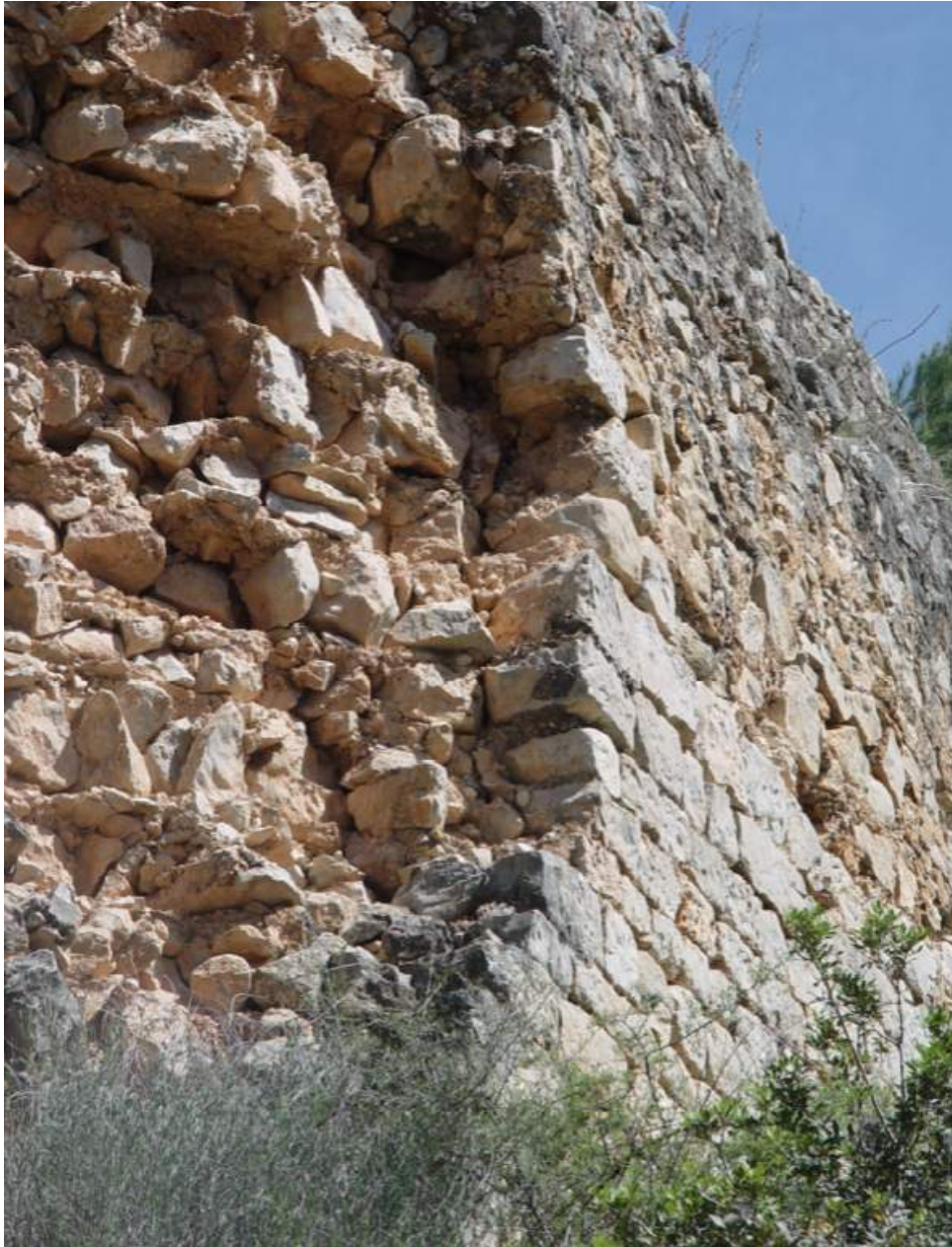
Pared exterior con opus quadratum en parte inferior del muro, piedra irregular en parte superior y relleno de mortero de cal y con piedras irregulares de relleno. Riba-roja (Valencia).
