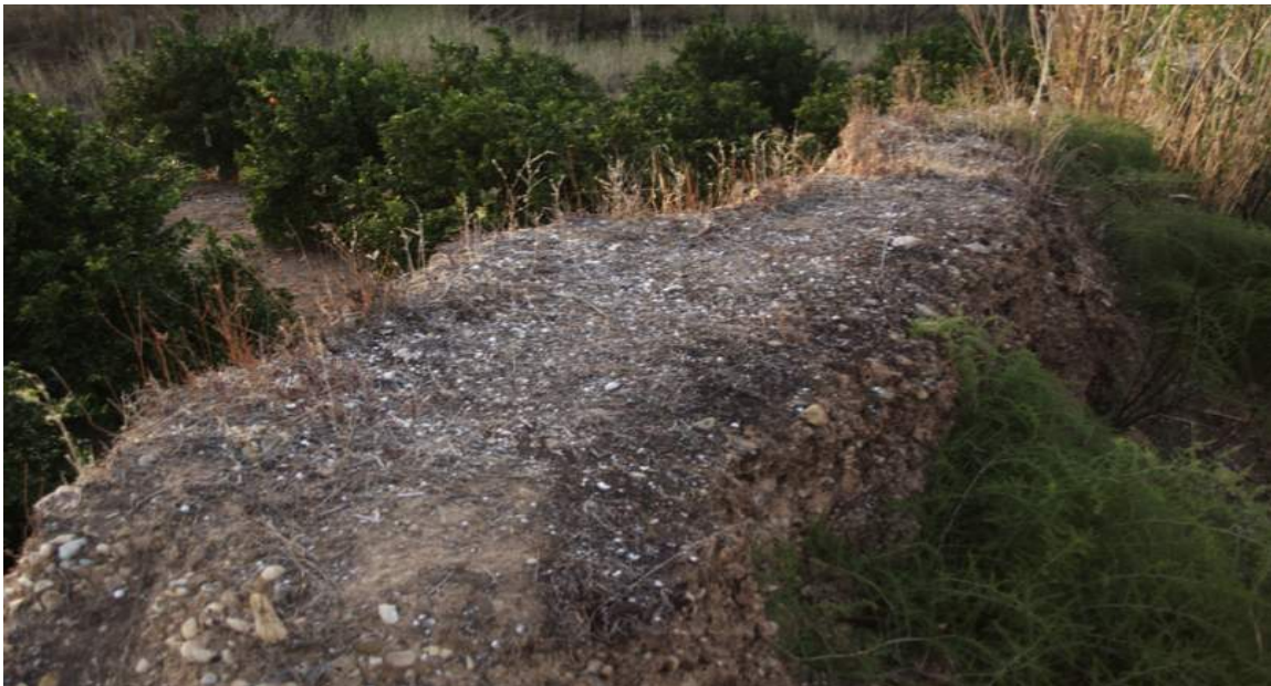
Lateral del muro de tierra excavado para realizar la cequia, anterior a los dos muros del siglo XIX y XX.
