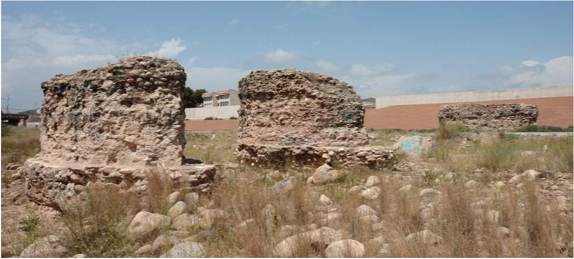
Cuatro de los tajamares que quedan con el tercero caído
