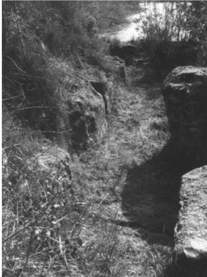
ACUEDUCTO 2.La Pea (Vilamarxant). En el centro se puede observar donde se ponía la compuerta para regular el agua. Foto E.Jarabú.
