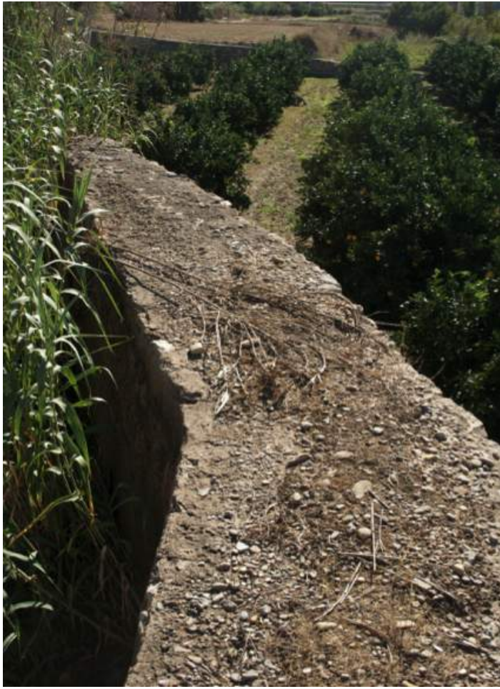
Muro del siglo XIX para la cequia de Benaguacil .
