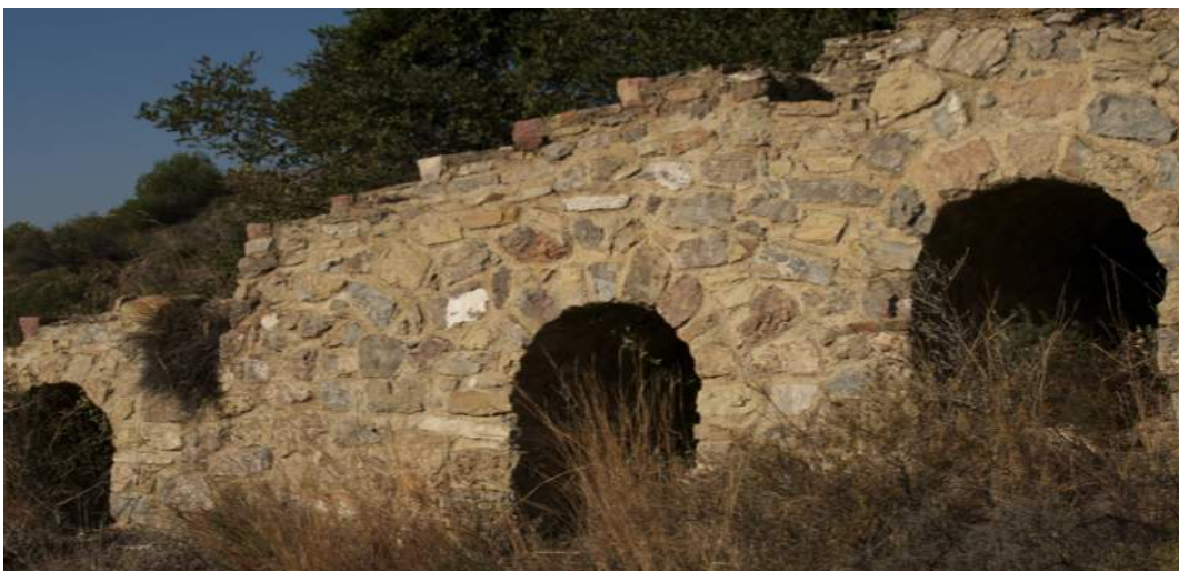
Lateral de la construcción de 1987 dentro de la cual se conserva el acueducto, arcos parte inferior, escaleras en parte superior.
