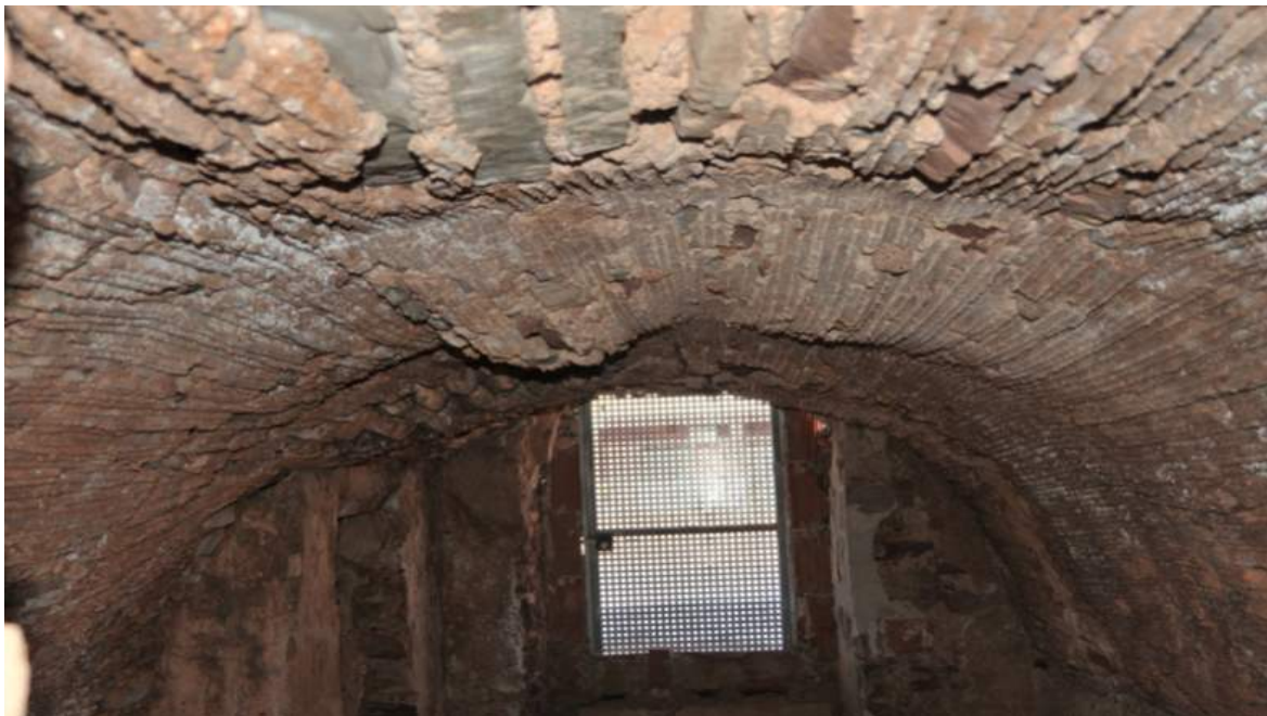
Bóveda con mortero con el encofrado de cañas del río.
