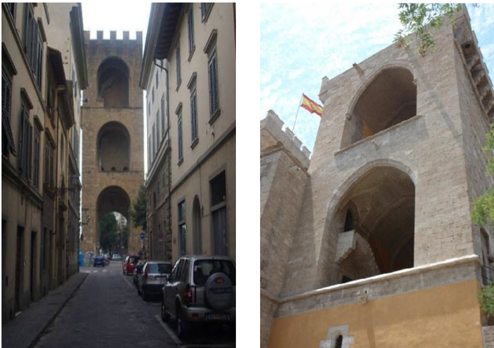
1. Porta San Niccolò (Florenca) desde el interior de la ciudad. 2. Una de las Torres de Quart
