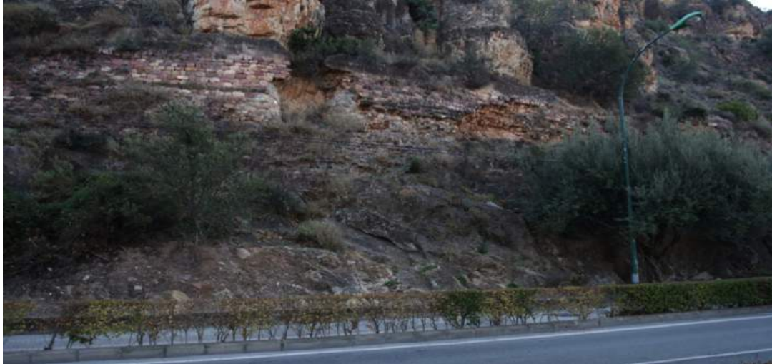
Acueducto 3 en la ladera de la Montaña de Sagunt. Parte mejor conservada.
