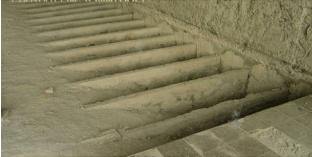
Falsa bóveda de costillas de fábrica de ladrillo para la división de plantas para presos, vista por su parte superior, al quitar en suelo en su restauración mediados siglo XX
