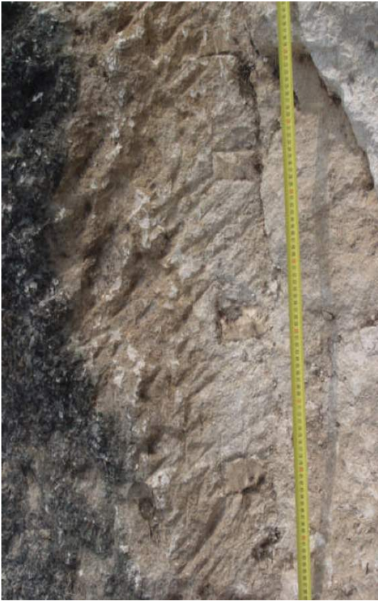
1. Detalle de las marcas de las cuñas.
