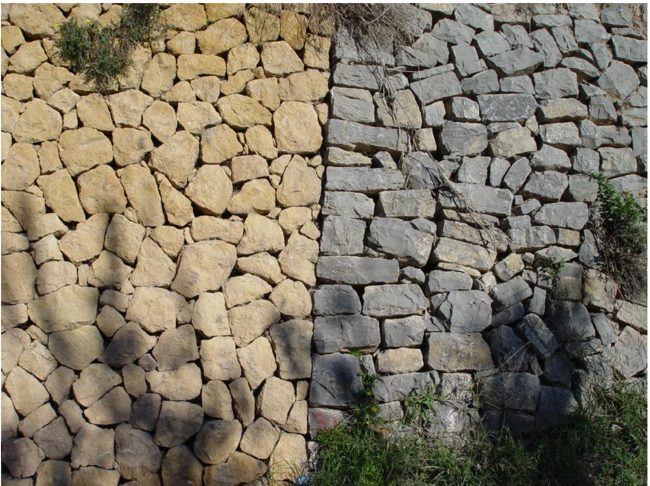
B) Las dos variedades de piedra de Altea: Izquierda roca amarilla del Terciario //Derecha, roca gris del Jurásico, en un bancal de la localidad, mamposterías muy bien concertadas.
