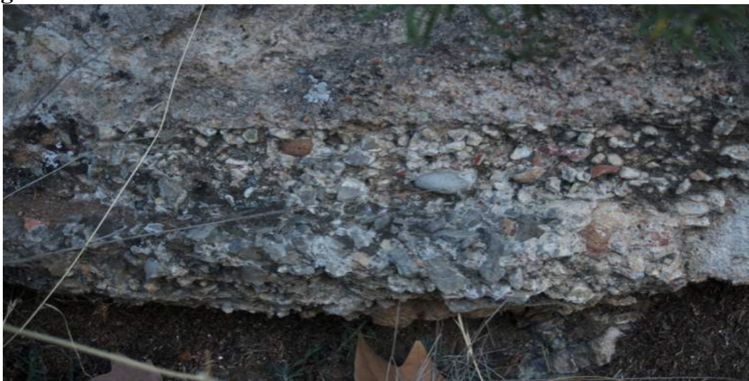
Sección lateral del canal: Parte superior lisa, canal. Parte media, media caña del canal. Parte inferior base del canal cortada. Base (hueco donde unía con muro)
