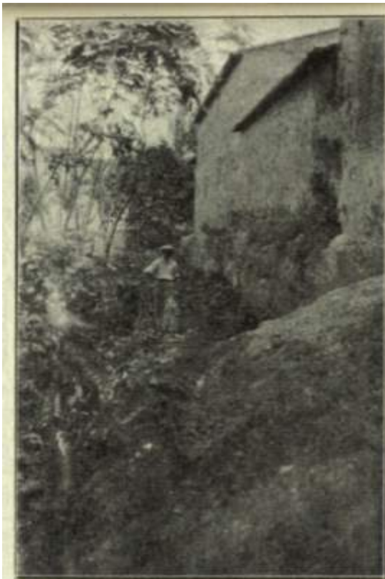
Fig. 2.—Rest de l' aqüeducte que forma els fonaments de la casa numero 29 del carrer de Quart, extramurs; junt a la cequia de Favara. Continuació de l' anterior
