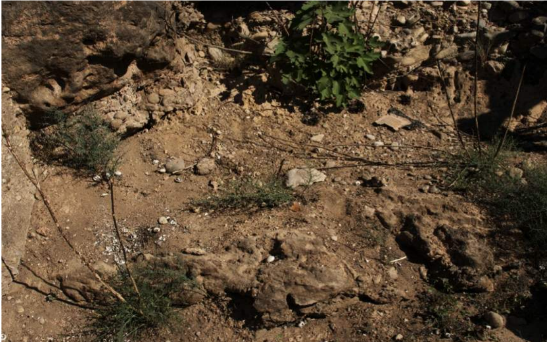
Estrato natural de arenisca fósil, base de las estructuras para la entrada de aguas del acueducto romano
