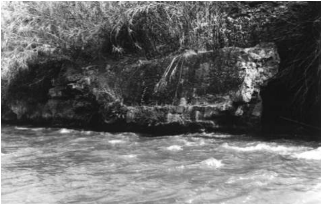
ACUEDUCTO 1. La Pea (Vilamarxant). Nacimiento acueducto donde se capta el agua a favor de la corriente del río. Foto E.Jarabú.
