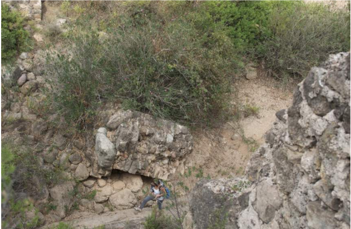
Base de tres de los cuatro pilares del acueducto. Alfara de la Baronía.
