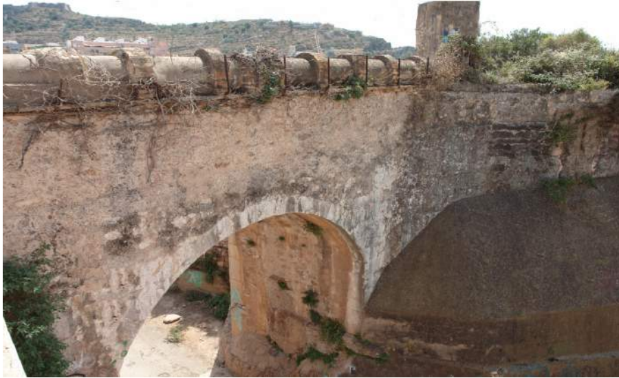
Arco con acueducto y encima tubería moderna. En la parte derecha de la imagen se conserva el acueducto romano, el arco debe ser medieval.
