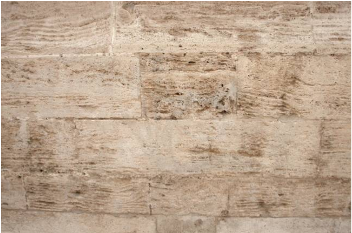
Pared exterior de la Llotja realizada con “pedra de fil”
