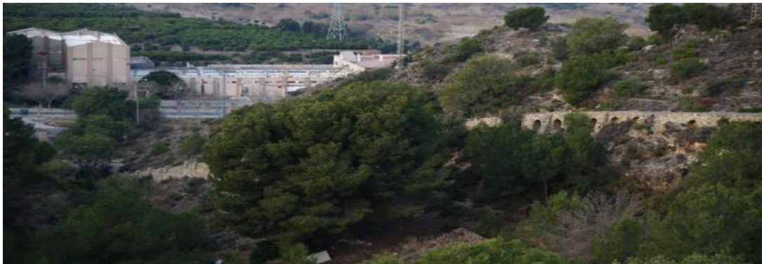
Parte del trayecto del acueducto de la colina, sobre arcos, restauración de 1987.
