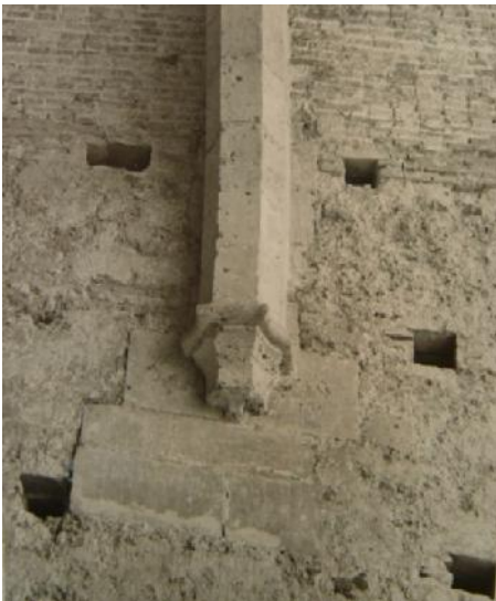
Falsa bóveda de costillas de fábrica de ladrillo para la división de plantas para presos, vista por su parte superior, al quitar en suelo en su restauración mediados siglo XX
