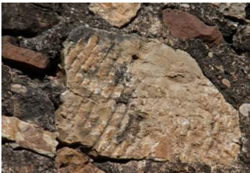
ACUEDUCTO 1. Piedra con marcas de herramienta en el paramento exterior del acueducto
