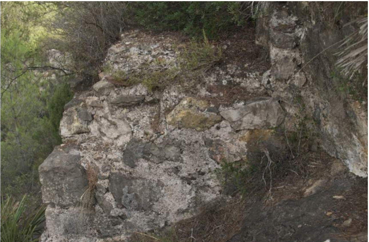
Detalle del interior acueducto
