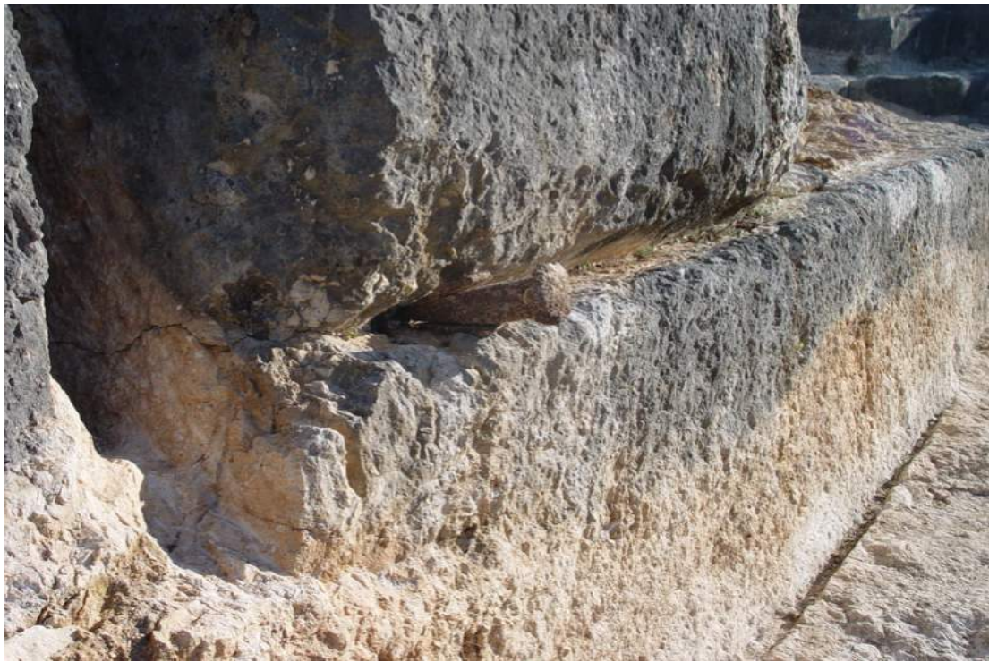
Perspectiva de la cuña, la fractura y el bloque partido in situ .
