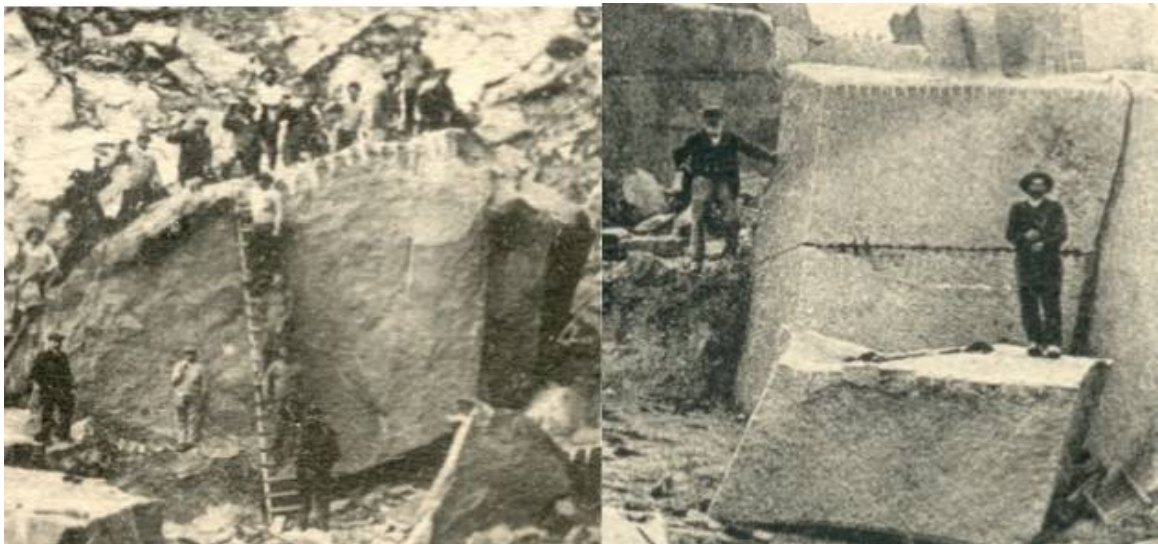
Canteras francesas en las que se observan marcas de cuña y bloques partidos.
