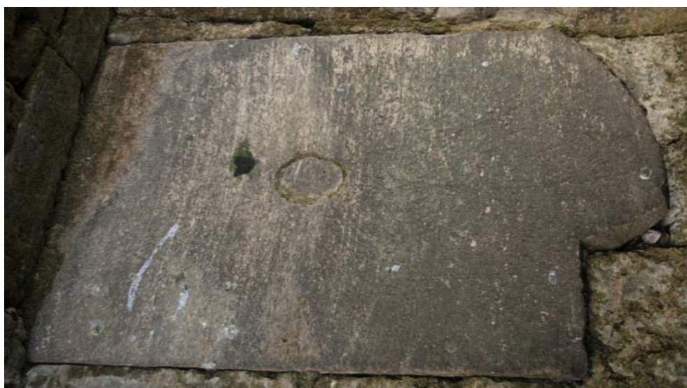
Rueda de molino reutilizada, cortada en ángulos restos para reaprovecharla como sillar, reparando los bloques medievales desgastados que le precedían.
