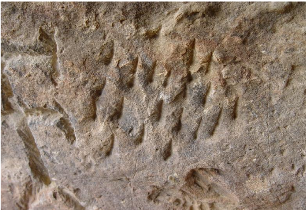
Marcas del pico de la escoda en la pedrera de arenisca de Barxeta.
