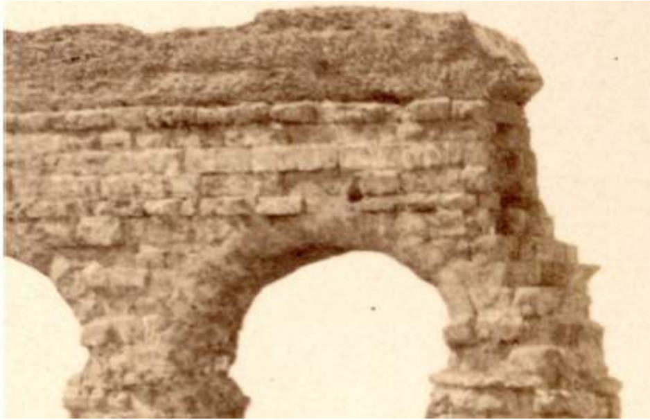
Detalle del acueducto anterior. Roma. Se observa el opus quadratum y el mortero.
