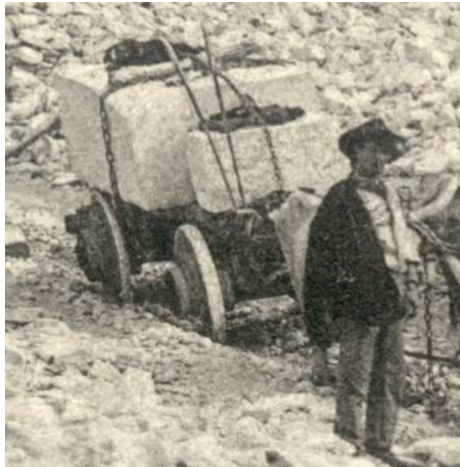
Detalle de carro con ruedas forradas de Hierro en Carrara. Siglo XIX. Colección Sulema.
