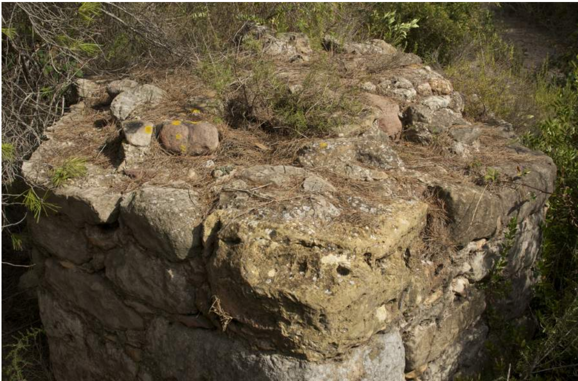
Base tercer pilar-tajamar.
