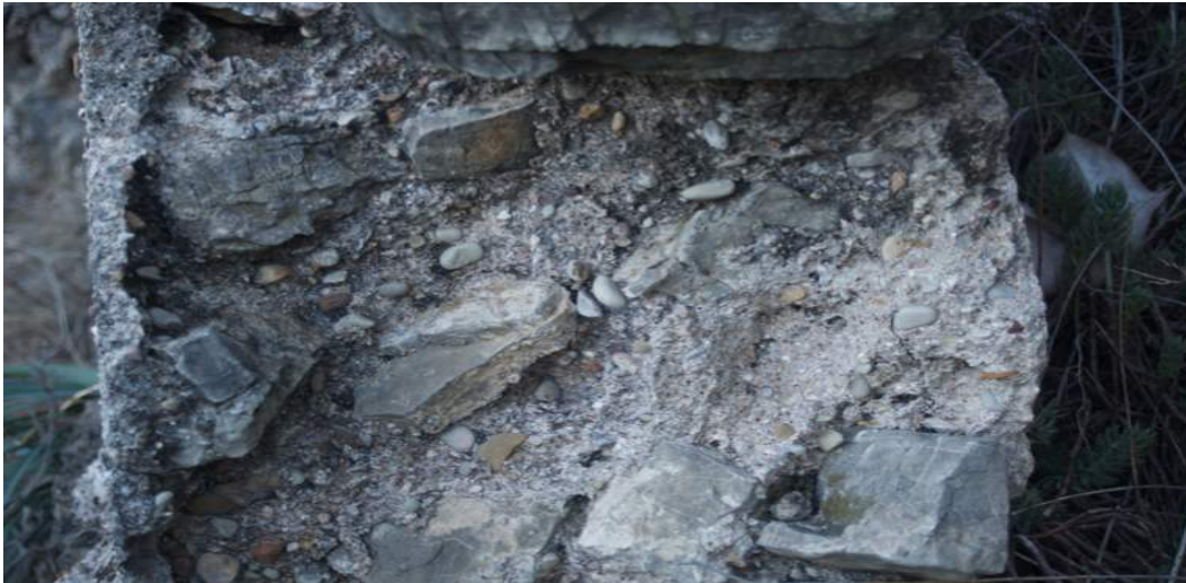
Sección del muro del canal ( specus ) con relleno de pequeñas piedras irregulares, cal y grava
