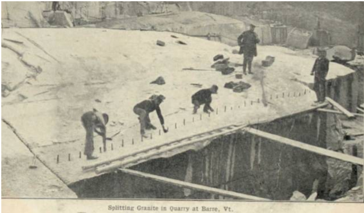
Cantera de granito en Splitting, Vermont, Estados Unidos, colocando cuñas. Principios años XX. Colección Sulema.
