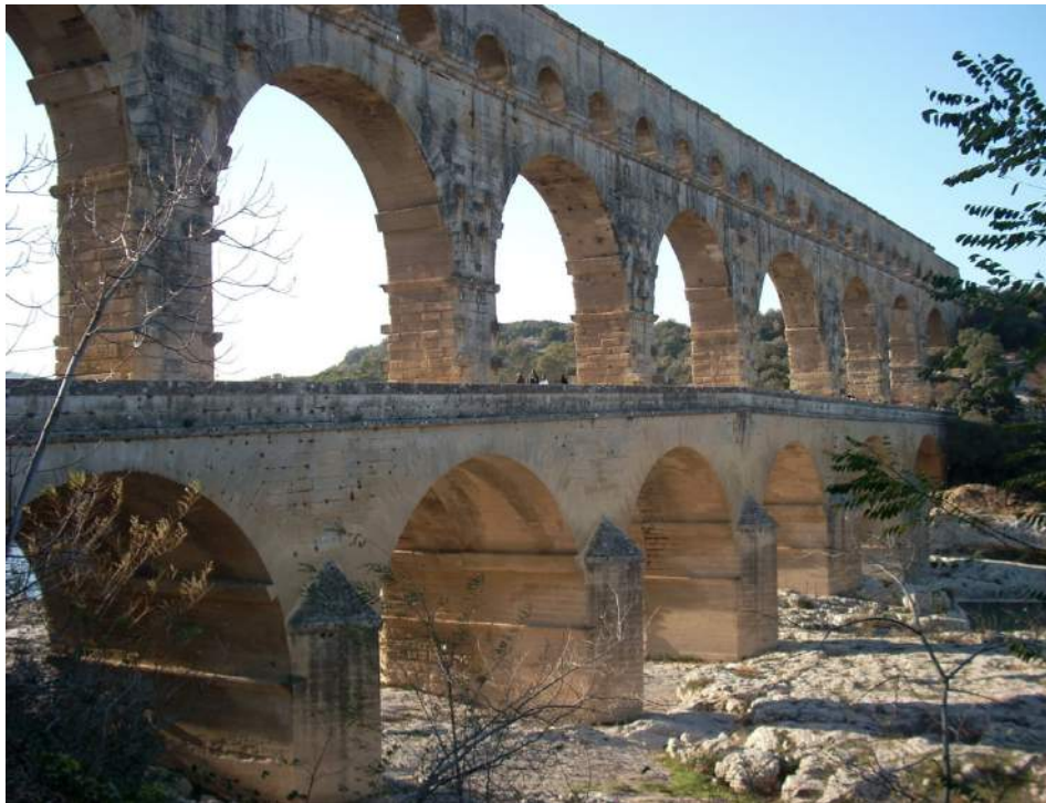
Puente-acueducto romano sobre el río Gard (Nîmes, Francia)
