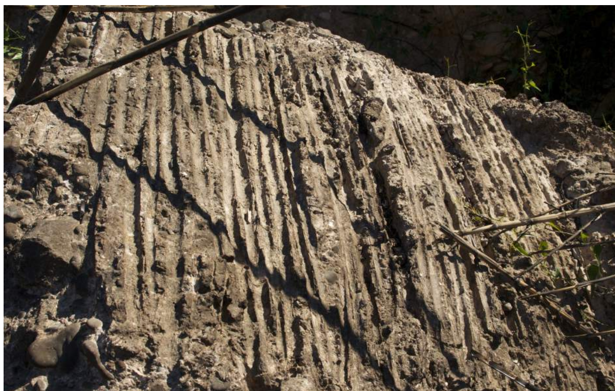
Mortero con negativos de cañas de época medieval cristiana, caído al cauce.
