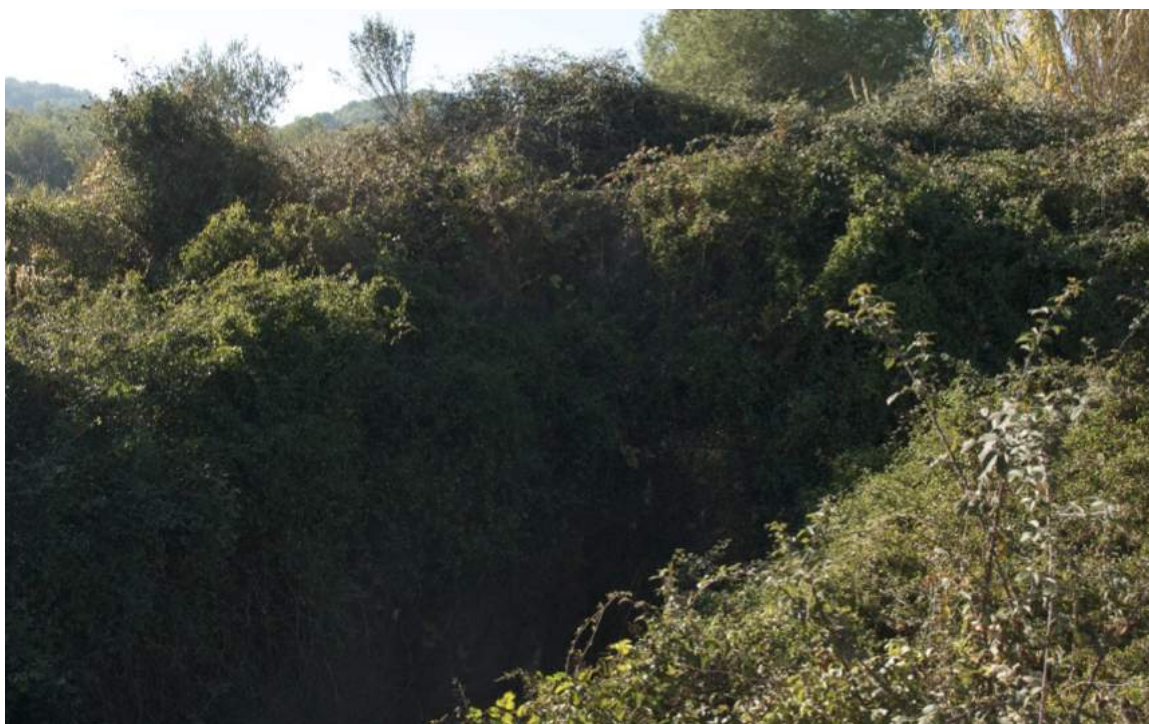
Barranc de les Foies o “ el barranquet ”, donde el acueducto salva el hueco (Estivella) con un arco de medio punto cubierto por maleza.
