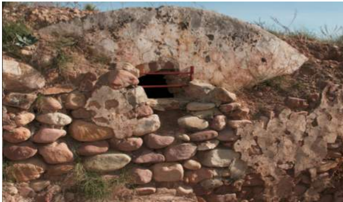
Parte trasera de la otra estructura con forma de aljibe, observable superposición de capas distintas sobre la estructura original.
