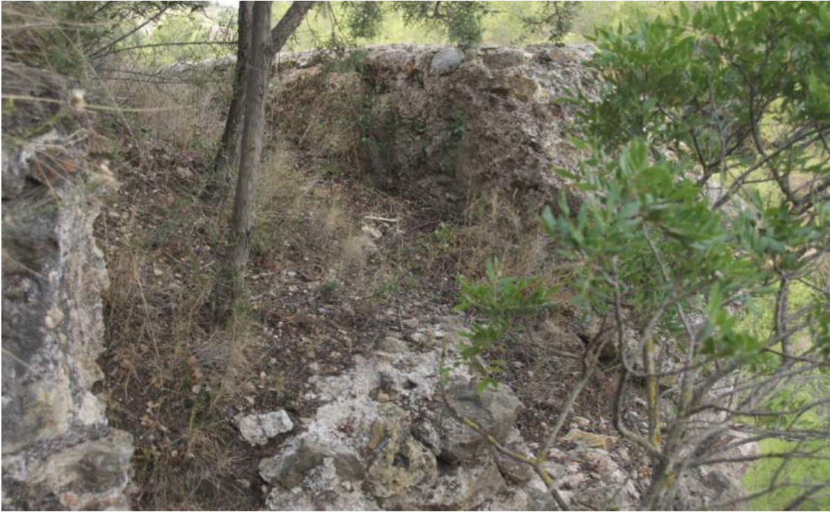
Interior del canal del acueducto romano en Alfara de la Baronía.
