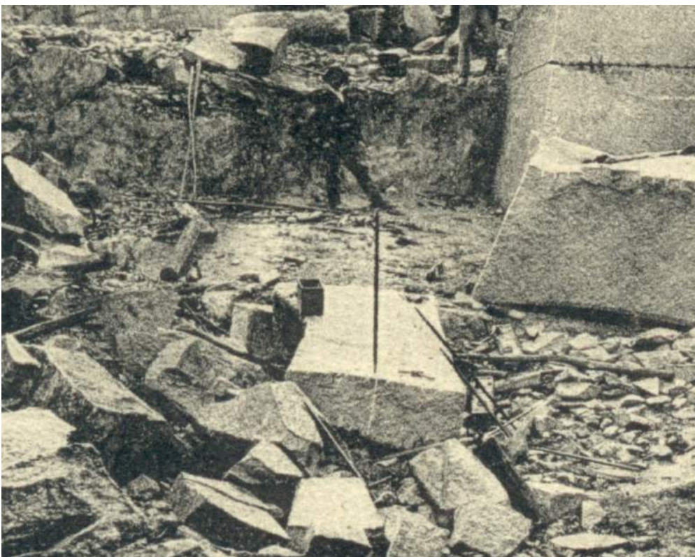
Fotografía cantera francesa, con palancas apoyadas en un bloque
