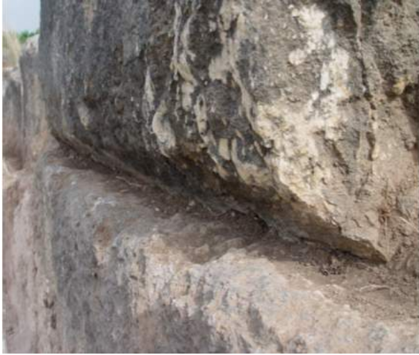
Dos imágenes del entrante lateral anterior para recibir las cuñas de hierro.
