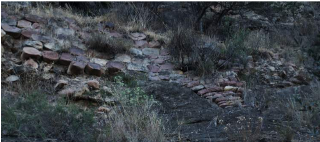
Derecha de la imagen, relleno artificial de hueco natural para la base del muro.
