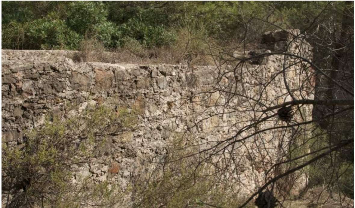
Pared del acueducto, continuación.
