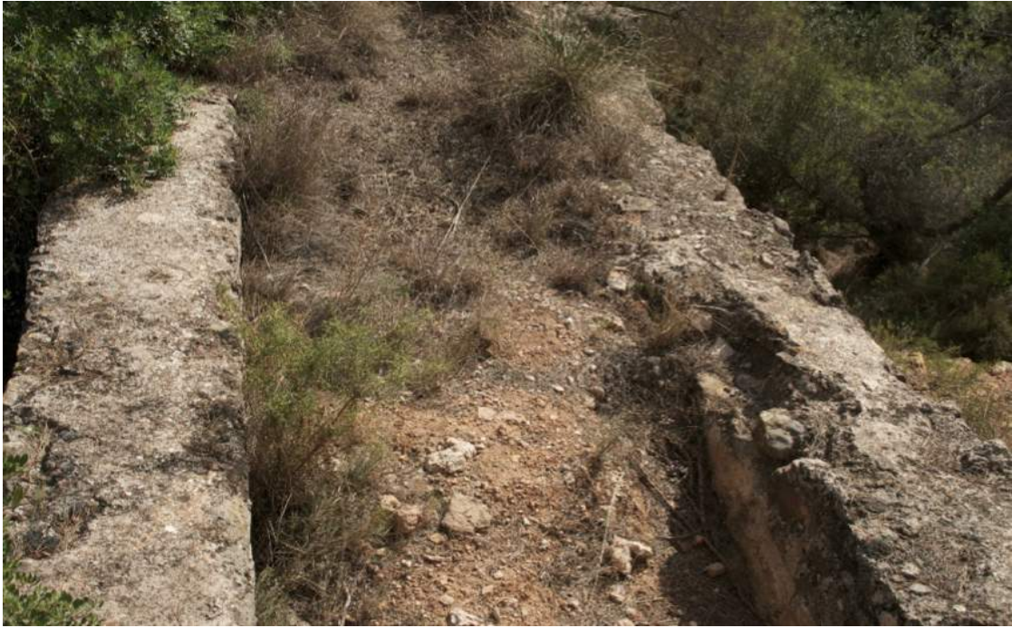
Interior del canal del acueducto.
