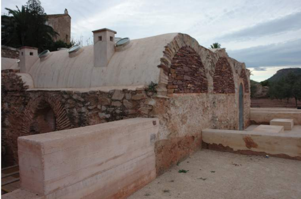
Detalle de los Baños de tipología árabe, del siglo XIV
