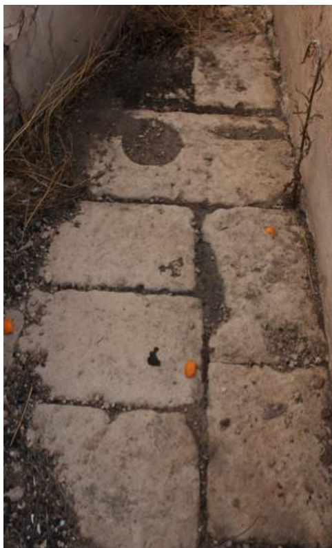
Bloques reaprovechados en el canal del aliviadero, siglo XIII como mínimo.
