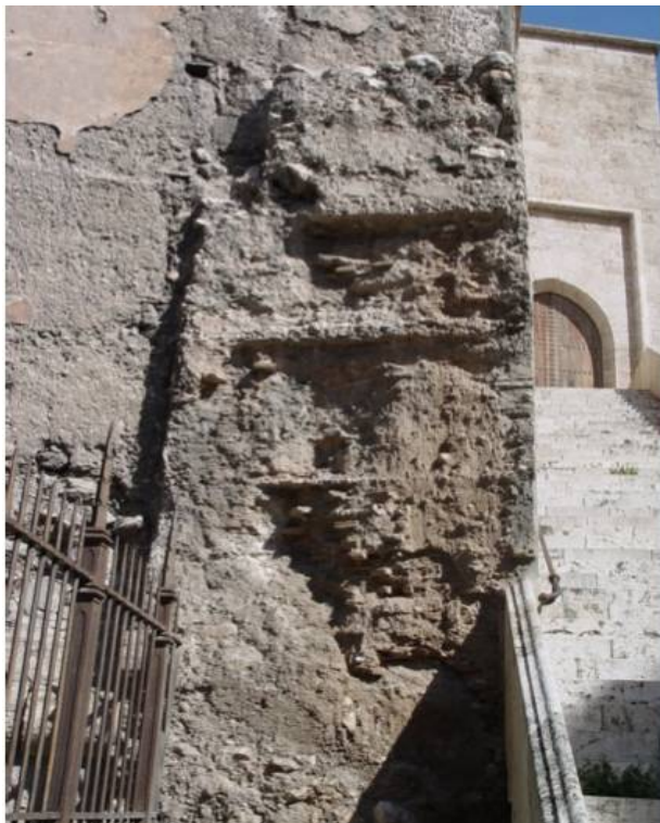
Detalle de la muralla original de las Torres de Quart con su corazón de tapiadas de cal, arena, reble y tierra. B) Restos muralla en las Torres dels Serrans, junto escalera y verticalmente su señal en el muro (parte inferior frontal de la foto).
