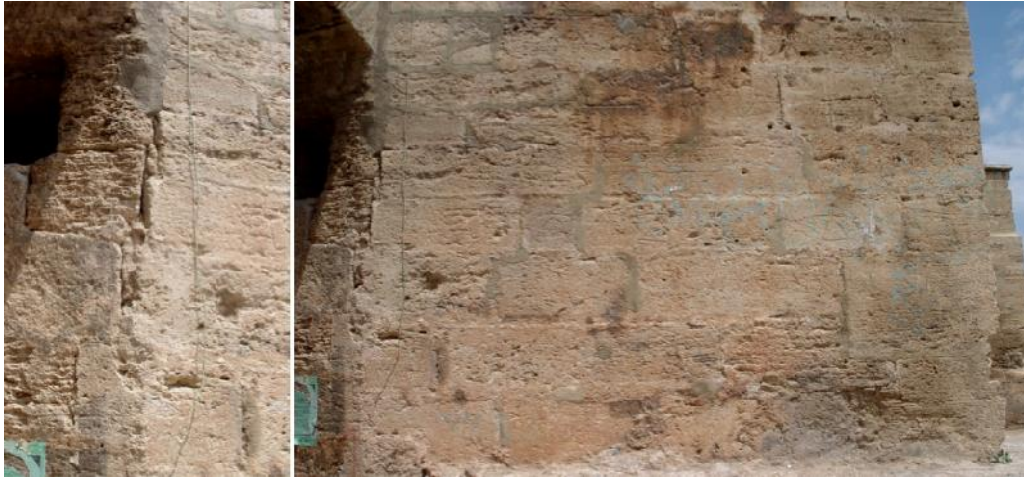
1. Detalle de la brecha que muestra que no hay continuidad de trabado
