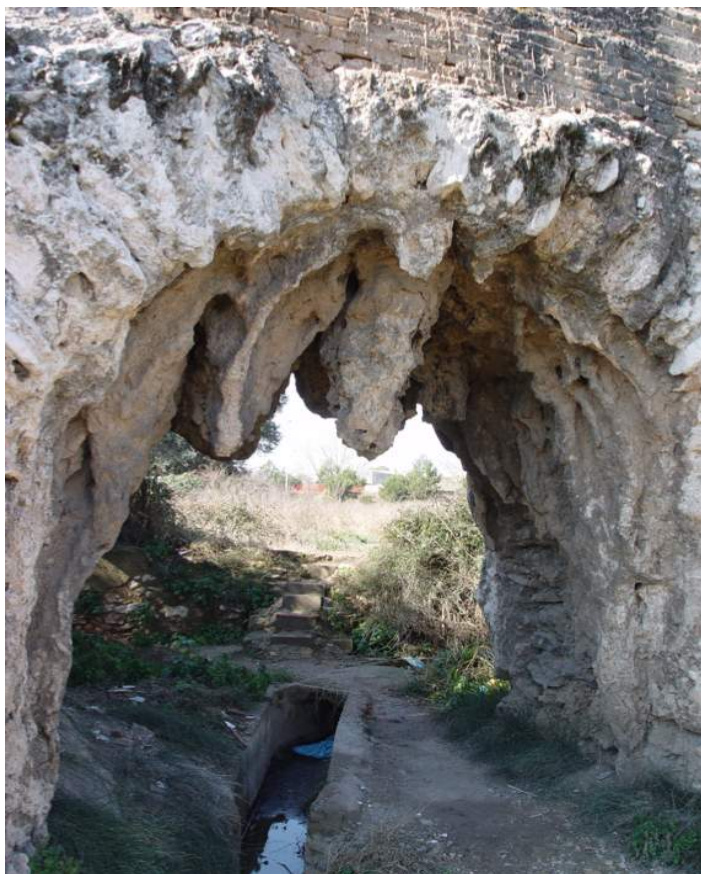
Arco del que cuelgan estalactitas de cal por fa filtración durante siglos.
