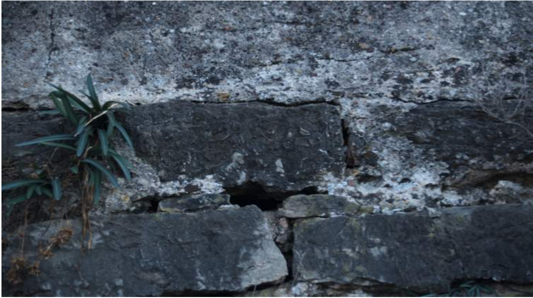
Unión del canal con su base de caliza trabajada, sacada del mismo lugar.
