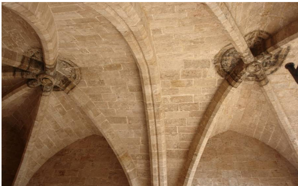
Claves pintadas (cuya pintura se extiende también por parte de la bóveda) del primer piso de la torre izquierda (vista las torres desde fuera de la ciudad)
