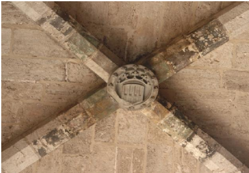
Clave (actual) y dovelas pintadas. Bb veda inferior, en la entrada en el portal.
