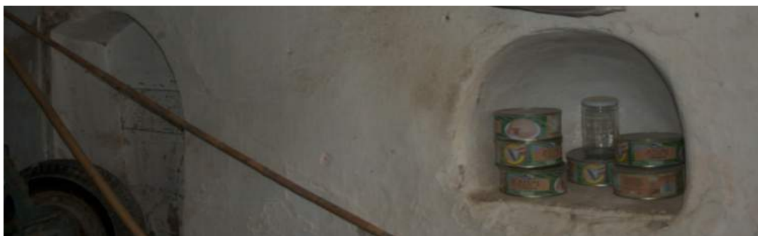
Armarios realizados excavando en el muro de la pared.
