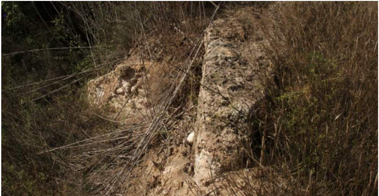
Detalle de muro partidor del canal del molino anterior al actual de salida de agua.
