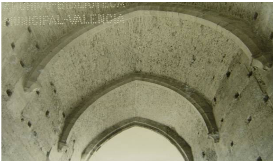
Parte bóveda interior de las torres de Quart con arcos ojivales, en esviaje, y bóveda de fábrica de ladrillo unidos con mortero de cal.
