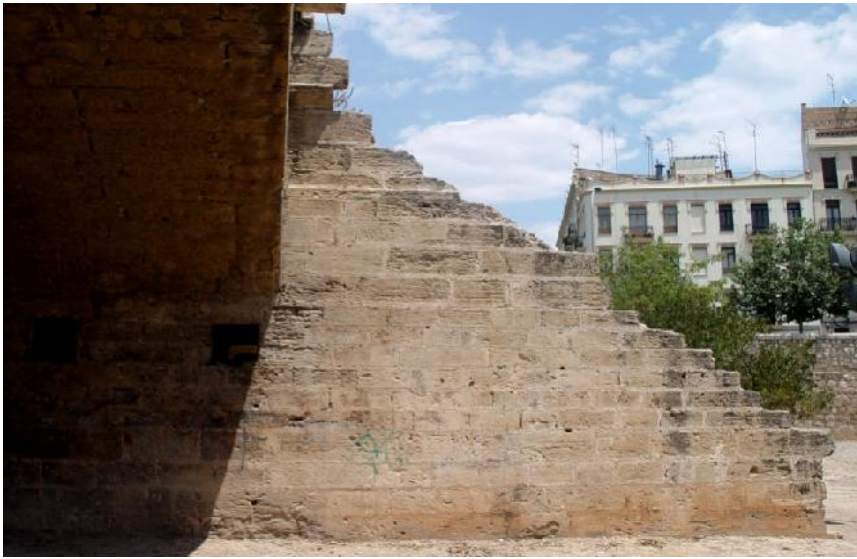
1. Detalle de la brecha que muestra que no hay continuidad de trabado
