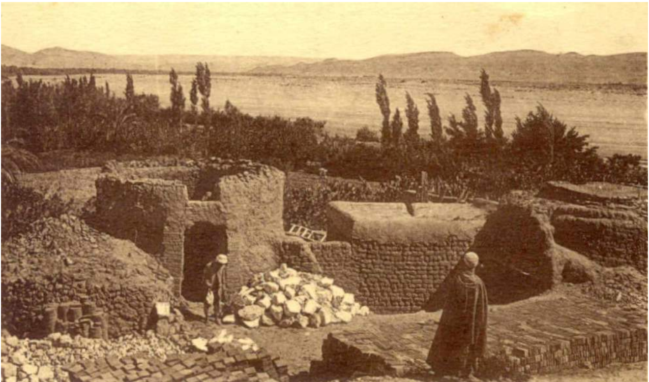
Horno de cal norte-africano. Sacando los bloques de piedra caliza convertidos en cal.
