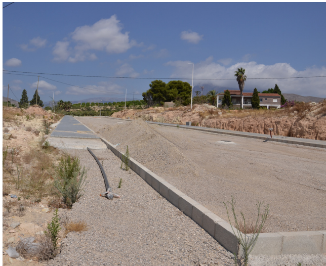
Fig. 8.38. Obras de urbanización del Sector PP-33 del PGOU de la Vila Joiosa, 24 agosto de 2013.
