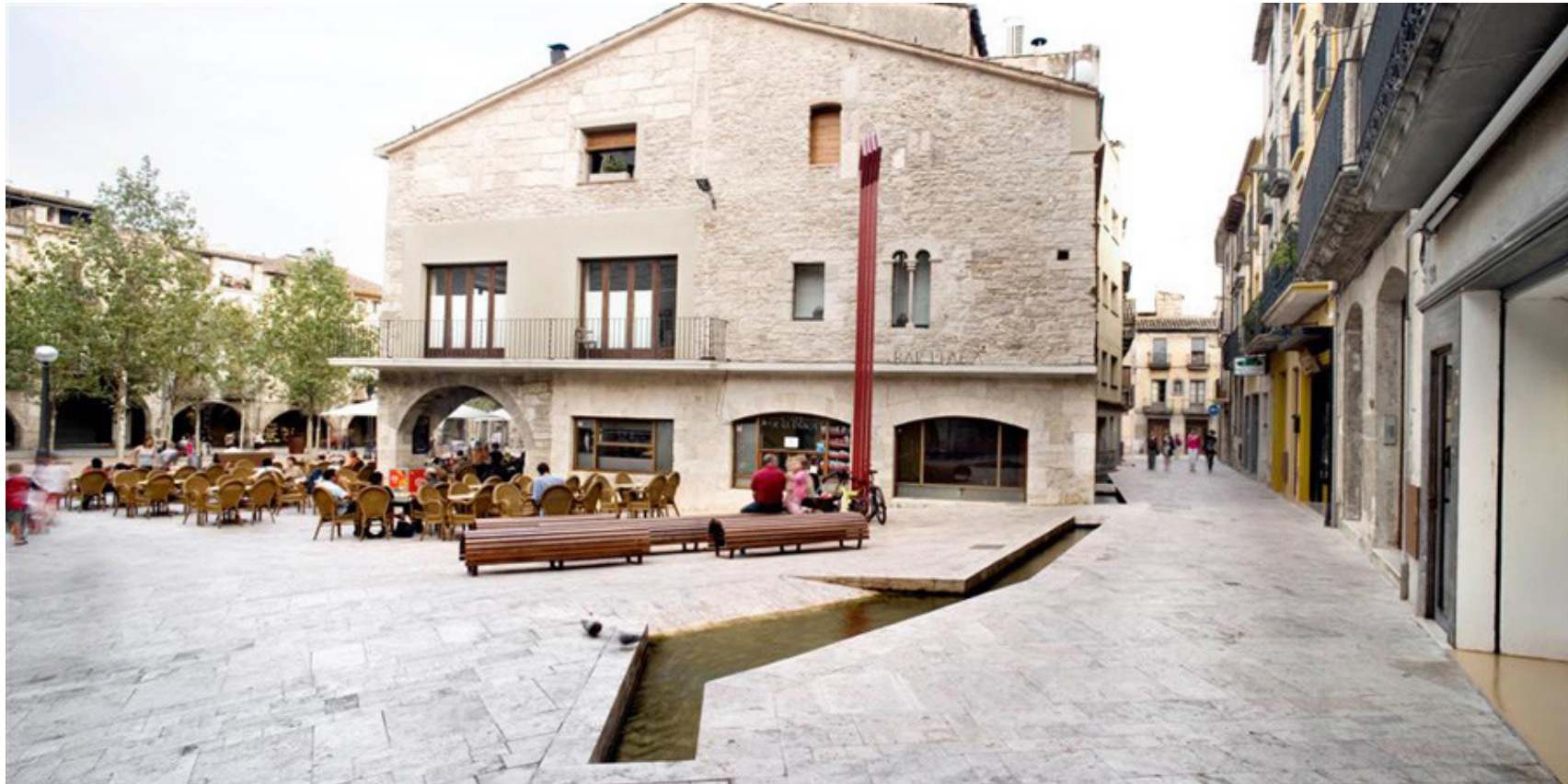
Fig. 4.16. Casco Antiguo de Banyoles (2008) Autores proyecto: Josep Miàs. Miàs Arquitectes Promotor: Ajuntament Banyoles Fuente: www.miasarquitectes.com
