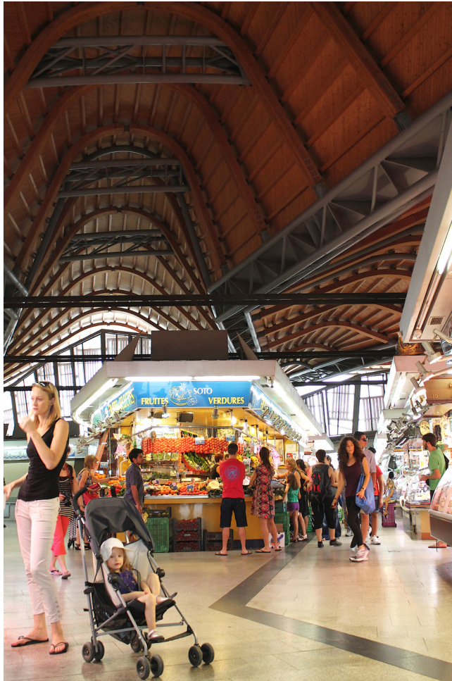
Fig. 2.23. Interior del Mercado de Santa Caterina. Barcelona, agosto 2013. Una de las referencias contemporáneas más importante de proyectos de rehabilitación de mercados, obra de EMBT.
