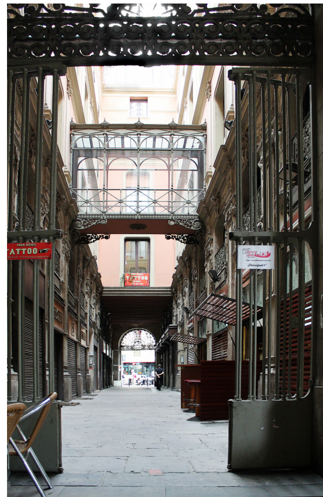
Fig. 2.14. Pasaje Bacardí, entre la Rambla y la Plaça Reial, actualmente solo alberga una cafetería con terraza en la Plaça Reial. Barcelona, agosto 2013.
