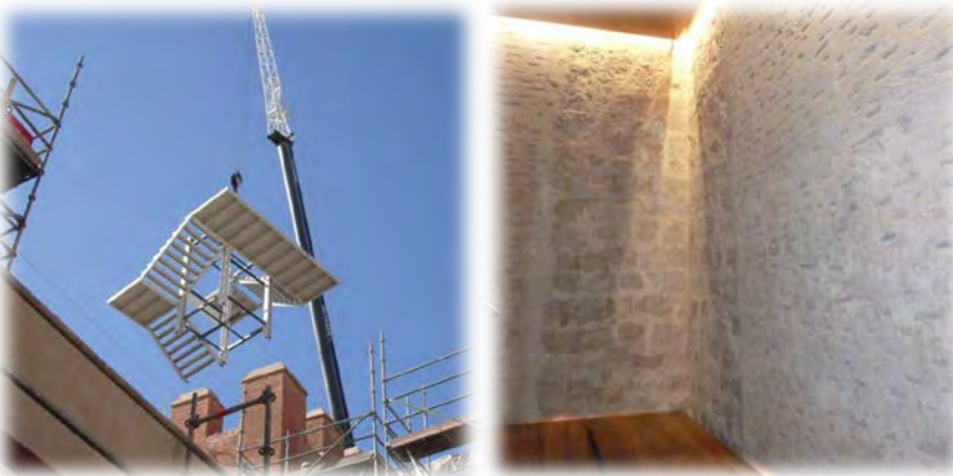
Foto arriba izq. Introducción de un tramo de escalera al interior de una torre. (Proyecto rehabilitación)
