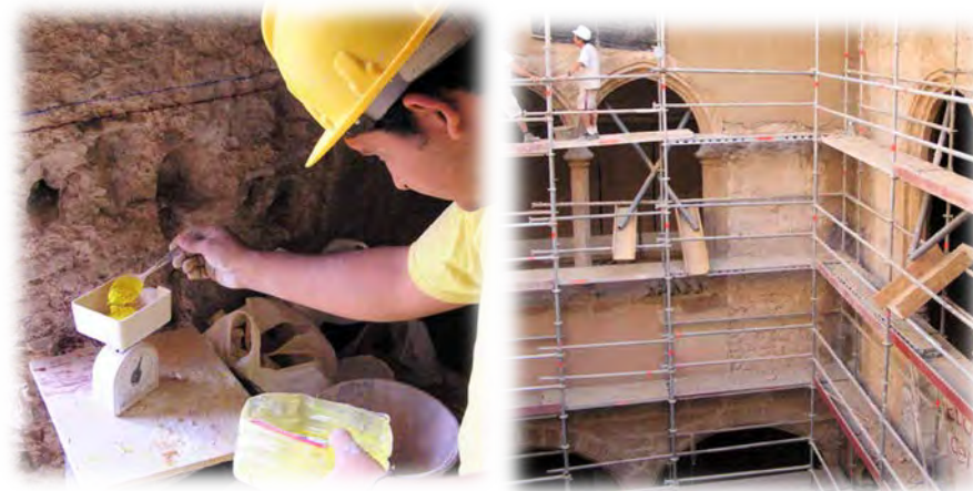
Foto izquierda: Dosificación de los pigmentos minerales Foto derecha: Ejecución del estuco del patio (Proyecto rehabilitación)
