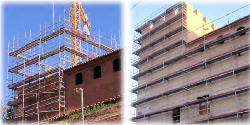
Foto izquierda: Estado con tres Torres Foto derecha: Cuarta Torre finalizada
