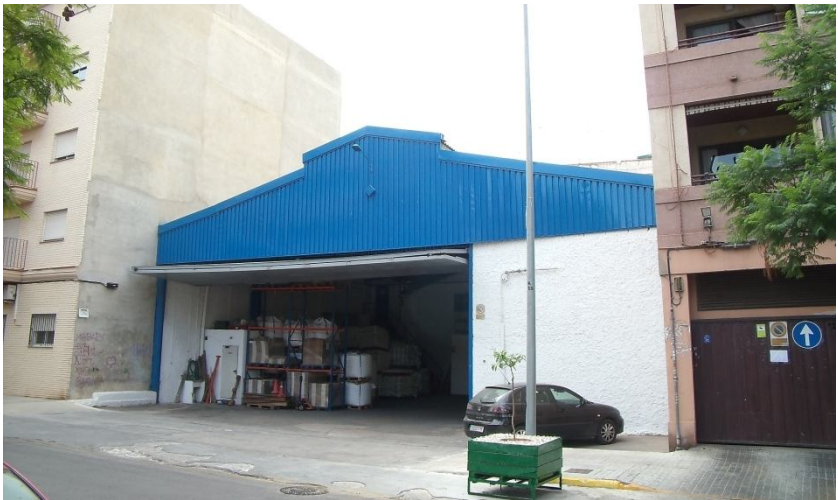
Figura 42. Nave industrial dentro del casco urbano de Torrente. Foto propia.
