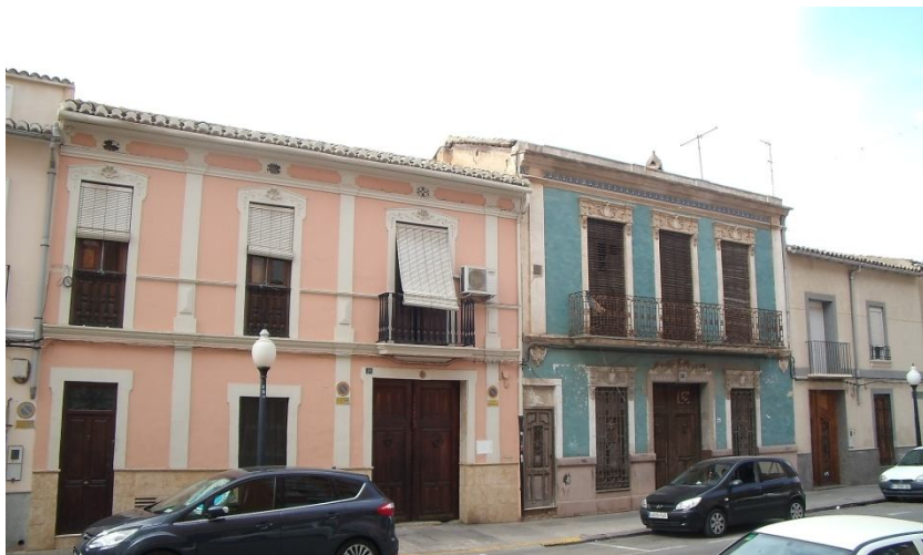
Figura 40. Viviendas unifamiliares adosadas en casco antiguo en Torrente. Foto propia.
