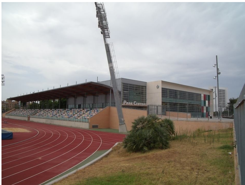
Figura 47. Polideportivo Parc Central de Torrente. Foto propia.
