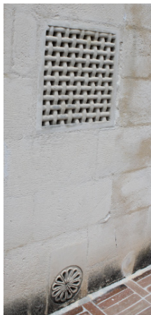
Fig. 15 Ejemplo de aberturas de ventilación
