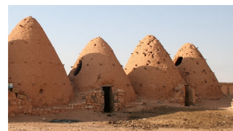
Fig. 4 Arranque de mampostería
