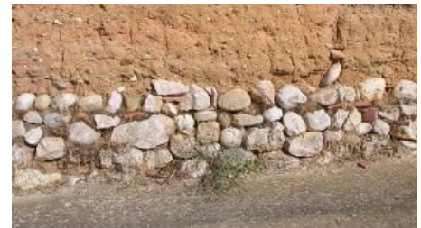
Fig. 11 Arranque del muro de tapial
