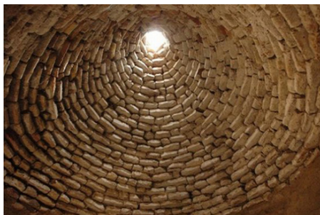
Fig. 9 Interior cubierta colmena
