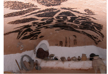
Fig. 9 Revestimiento interior y techo con forma de bóveda
