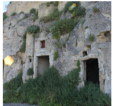
Fig. 17 Puerta y ventana superior en sasso caveoso
