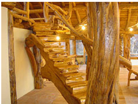
Fig 8. Estructura de madera empleando materiales de la zona
