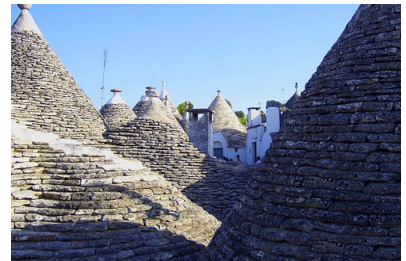
Fig. 6 Vista de cubiertas
