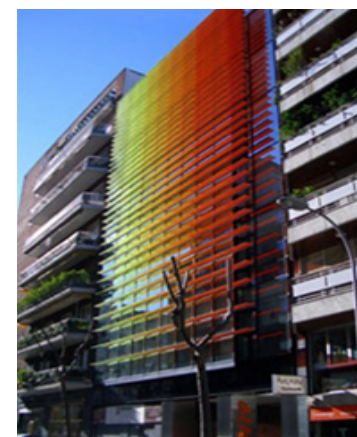
Fig 21 Elementos protección solar móviles.
