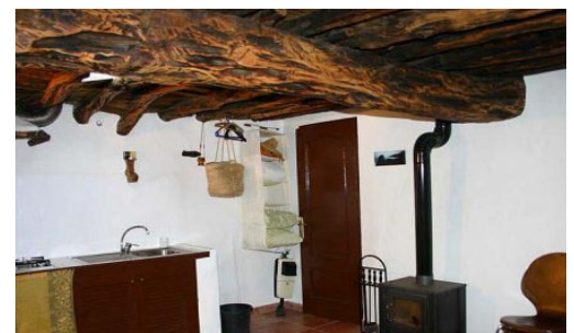
Fig. 9 Vista interior estructura cubierta
