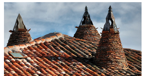
Fig. 14 Chimeneas en la cubierta
