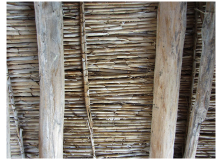
Fig. 9 Estructura de la cubierta
