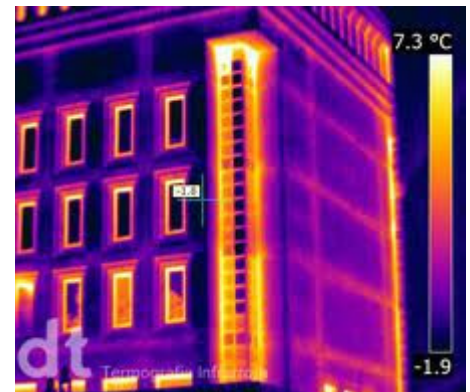
Fig 6. Foto termográfica a una fachada de vivienda.
