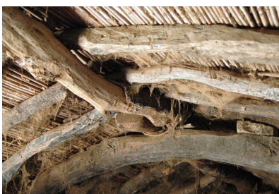
Fig. 7 Estructura de la cubierta
