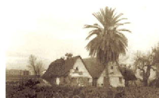
Barracas situadas en el entorno del actual barrio de San Marcelino
