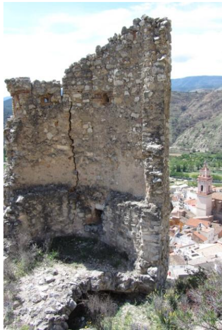
Imagen 4.28 y 4.29. Vista interior y exterior de la torre este.
