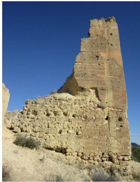
Paso 5.- Fotografía con dianas y toma coordenadas.
