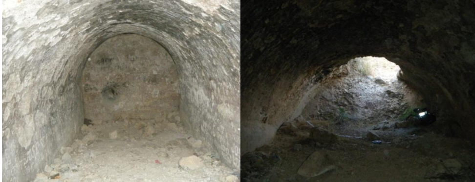
Imágenes 4.52 y 4.53 .- Interior del aljibe.
