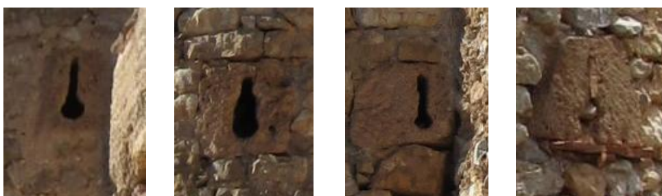
Imágenes 4.39, 4.40, 4.41 y 4.42 Algunas aspilleras/ troneras vistas desde el exterior
