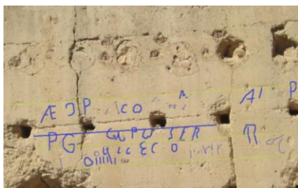
Imagen 2.33.- Detalle muro anexo
