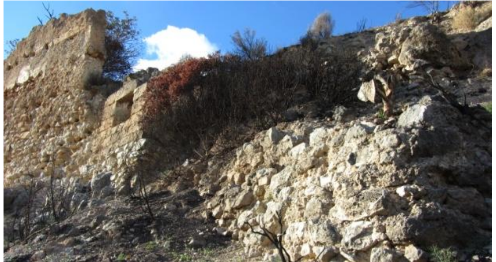
Imagen 4.50.- Muralla de tapia, cañonera y cimentación.
