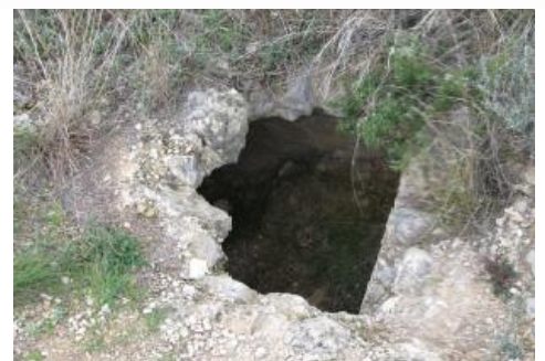
Imagen 4.51.- Acceso al aljibe
