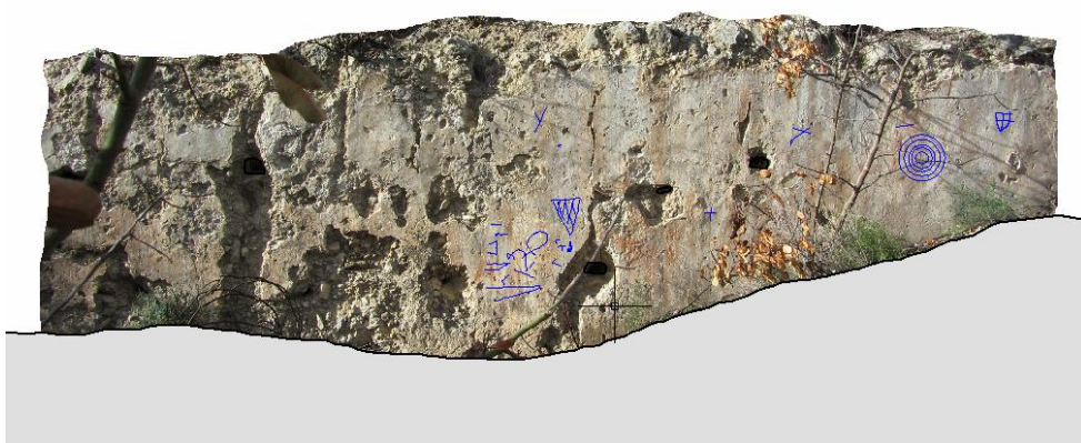
Imagen 5.26.- Foto rectificada del muro del aljibe.
