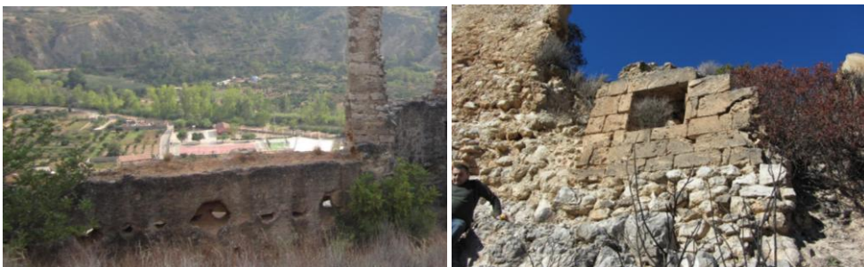
Imágenes 2.41, 2.42 y 2.43.- Muralla: intradós trasdós y detalle.
