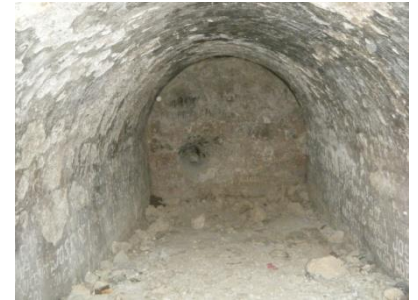
Imagen 5.8.- Interior del aljibe
