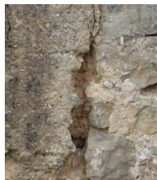
Imágenes 4.45 y 4.46.- Traba con la torre oeste.
