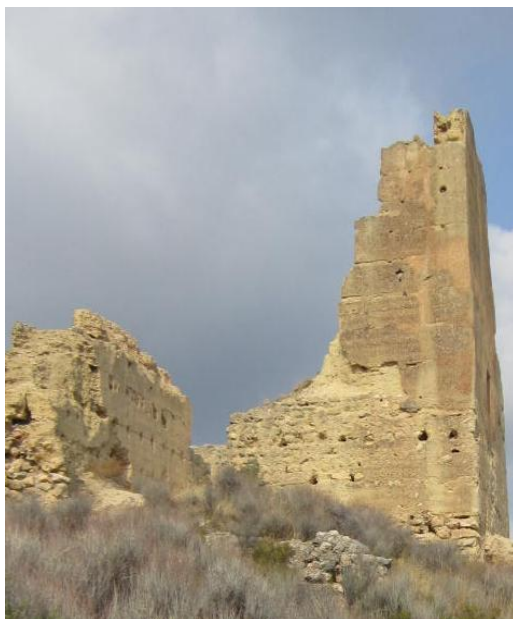
Imagen 2.34.- Cara oeste de la torre
