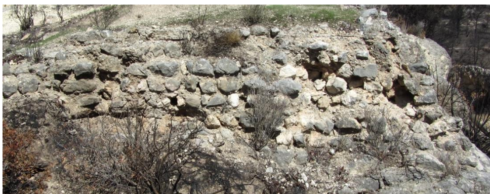
Imágenes 4.6. , 4.7.y 4.8.- Muros de tipo de tapia 3.
