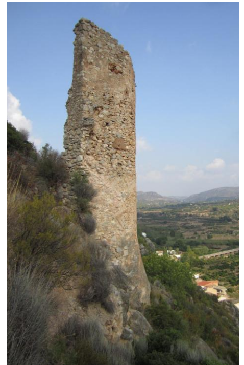
Imágenes 2.38, 2.39 y 2.40.- Torre semicircular 2.
