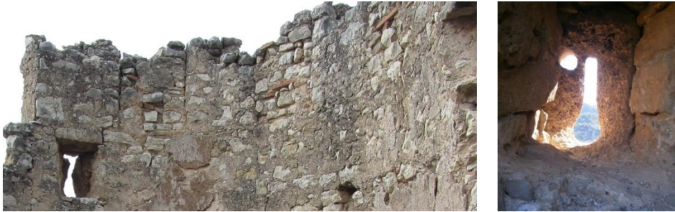
Imágenes 5.11 y 5.12.- Cegado de almenas y adaptación aspillera
