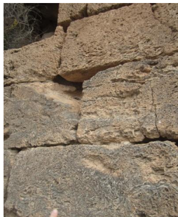
Imágenes 4.11 y 4.12.-General y detalle del elemento de sillería.
