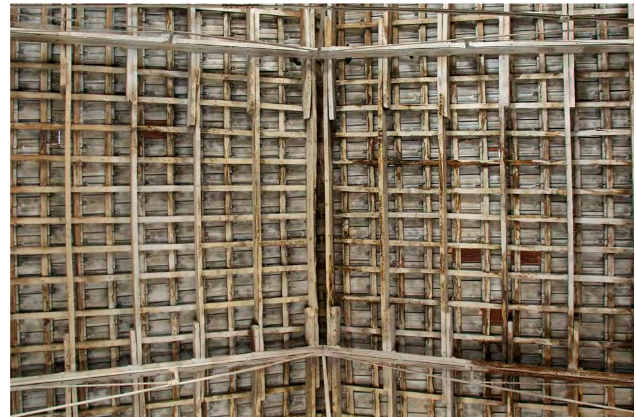
Cubierta nave norte
