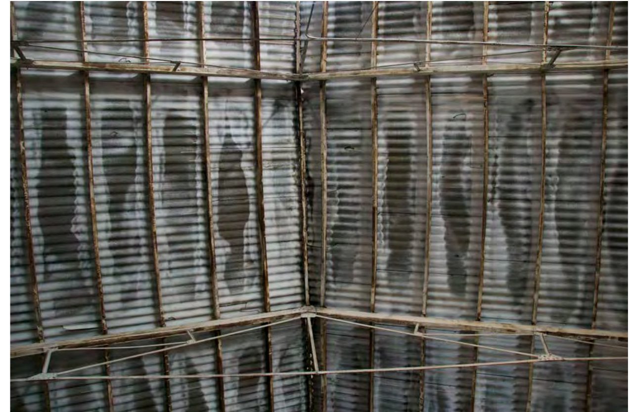
Cubierta nave sur
