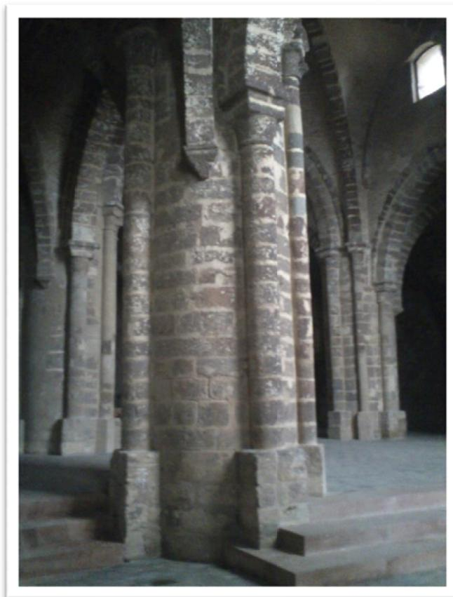
Fig. 14. Conforme lo descrito en los protocolos notariales de la reforma barroca, los pilares de la iglesia gótica eran de piedra redondos. Similares a los existentes en el Castillo de Calatrava la Nueva (Ciudad Real)
