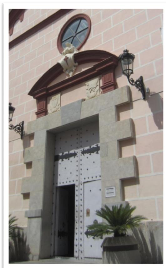
Fig. 21. Entrada actual que se abrió en la reforma barroca en el paramento vertical del altar gótico
