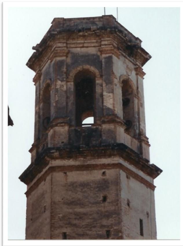
Fig.46. Detalle mechinales de la torre barroca
