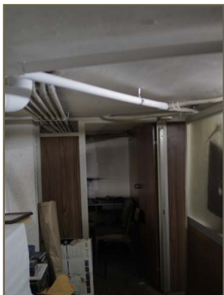
Figura 75. Imagen in-situ instalaciones
