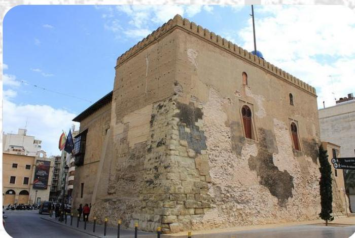
maciza utilizando sillares rectangulares dispuestos en la hilera inferior del muro y en las esquinas. El resto del muro se compondría de mampostería (con cal), y a partir de cierta altura se completaría con tapial.
