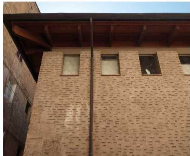
Fig. 14. Vista del voladizo de cubierta de la nave lateral
