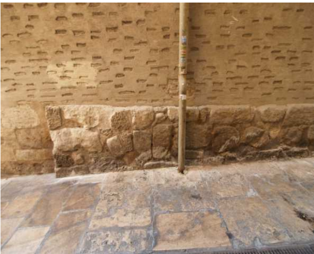
Fig. 9. Detalle arranque muro de mampostería
