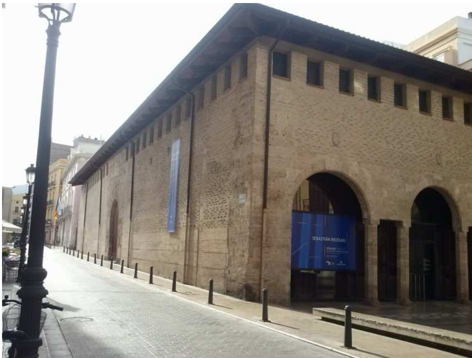
Fig. 3. Fachada Sur. Calle del Almudín
