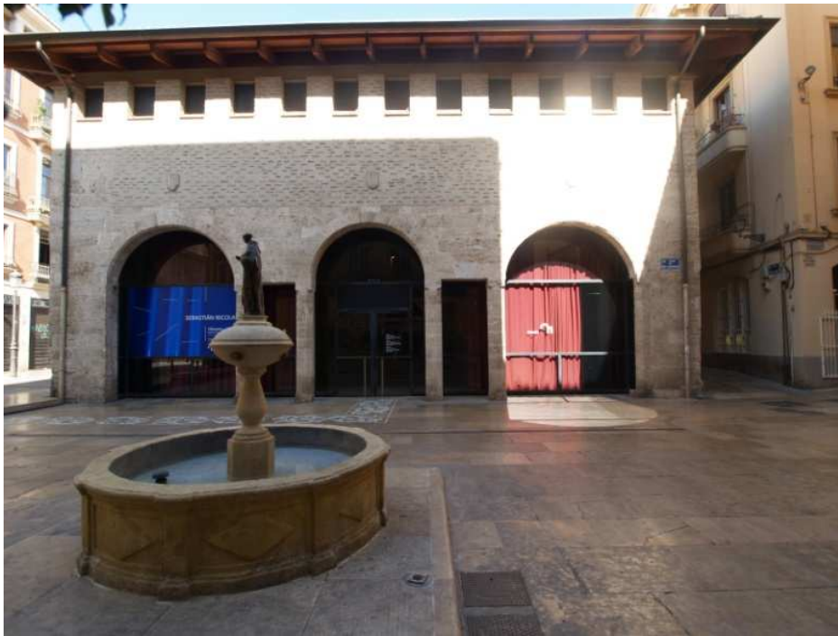
Fig. 4. Fachada Este. Plaza de San Luis Beltrán
