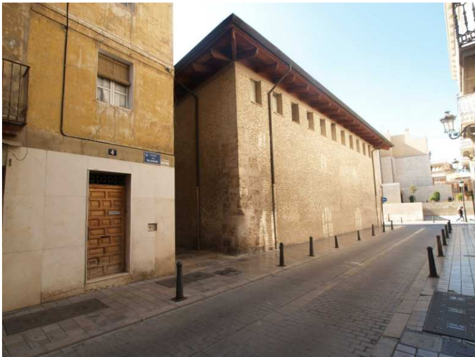
Fig. 5. Fachada Oeste. Calle del Salvador
