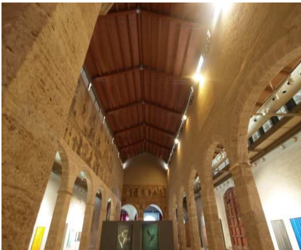
Fig. 13. Vista cenital de la cubierta de la nave central
