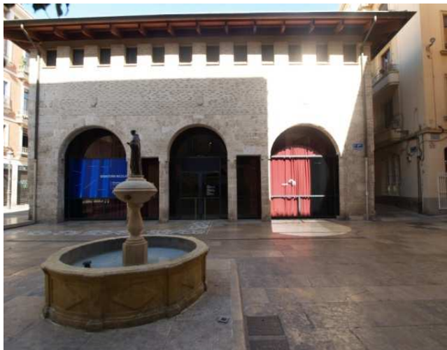
Fig. 7. Fachada Este. Plaza San Luis Beltrán
