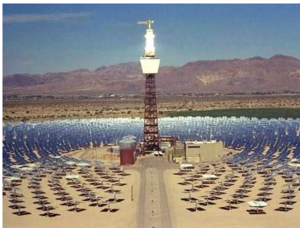
Fig. 12. Sistema de receptor central. Fuente. Web: Themorningstarg2
