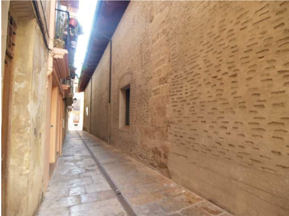
Fig. 2. Fachada Norte. Calle Estrecho del Almudín
