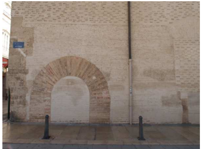
Fig. 10. Detalle zona de Ladrillo macizo
