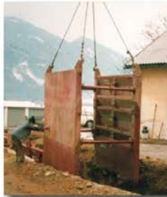
Los paneles cortantes sirven de encofrado para el recubrimiento de hormigón.
