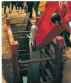
Trabajo de la excavadora entre los codales.
