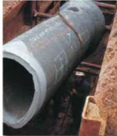
Los tubos de 2,5 m. ó de 3,5 m. de longitud se colocan sin necesidad de mover los codales.
