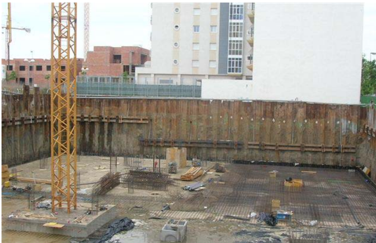
Imagen de excavación paralela a edificio de varias alturas
