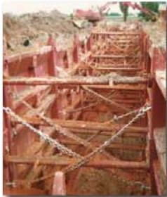
Zanjas anchas en terreno de relleno. El empleo de cadenas cruzadas en diagonal, en planos verticales aumenta la estabilidad del blindaje y limita el desplazamiento relativo de los paneles al \pm 5^\circ . Las cadenas no suponen un estorbo para los trabajos.
