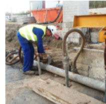
CONEXIÓN A COLECTOR
