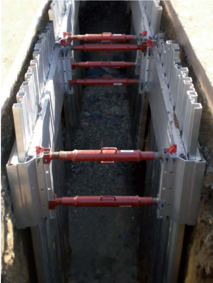
Imagen de panel de aluminio con cámara + tablestacas
