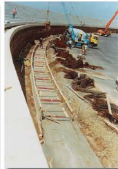
Paneles Alu utilizados como encofrados para fundaciones
