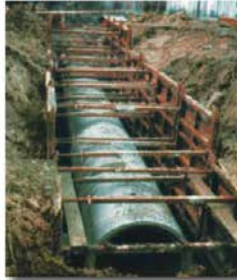
Grandes tuberías. Sobre una solera de hormigón que contribuye a sustentar la entibación. Es necesario reforzar a sustentar las uniones entre paneles, con tornillos de gancho que sustituyan a los codales inferiores.
