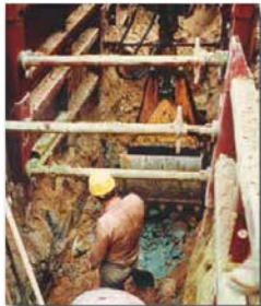
Protección total mientras se instala la tubería en el fondo de la zanja.
