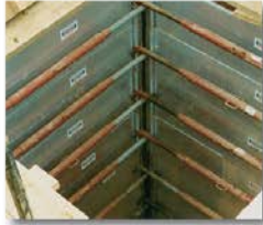
Solución especial: Entibación de pzo con codales adicionales
