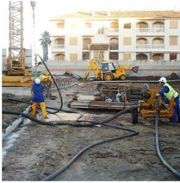
ELEVACIÓN Y POSICIONADO
