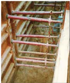
Zanjas anchas en terreno de relleno. El empleo de cadenas cruzadas en diagonal, en planos verticales aumenta la estabilidad del blindaje y limita el desplazamiento relativo de los paneles al \pm 5^\circ . Las cadenas no suponen un estorbo para los trabajos.
