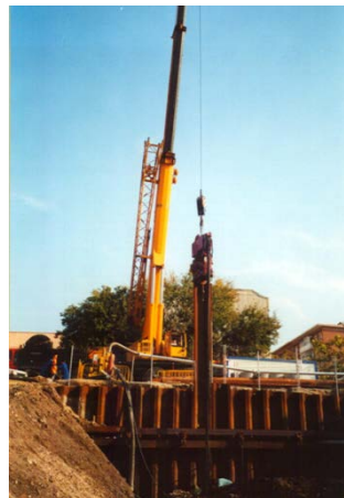
Imágenes de vibrador colgado de grúa hincando tablestacas
