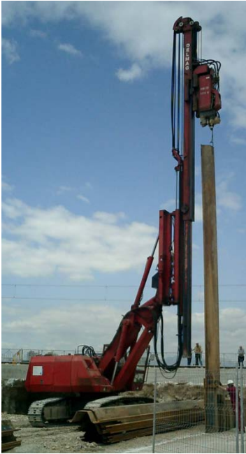
Imágenes de equipo auto transportable hincando tablestacas
