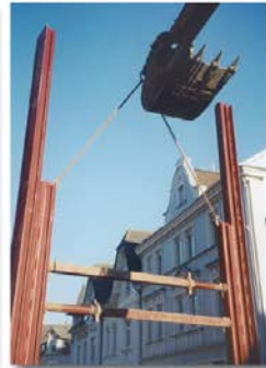
El ojal para transporte con cuña situado en la guía interior más corta, permite un punto de izado con menor altura
