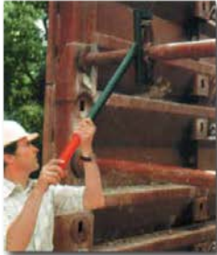
Apretar y aflojar los codales, con una llave de palanca.
