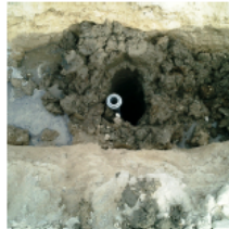
LANZA COLOCADA EN EL POZO
