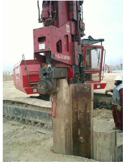
Imágenes de equipo auto transportable hincando tablestacas
