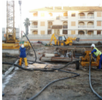
ELEVACIÓN Y POSICIONADO
