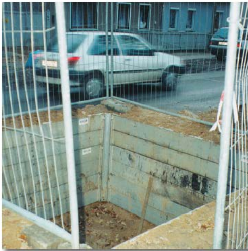
Renovación de acometidas
