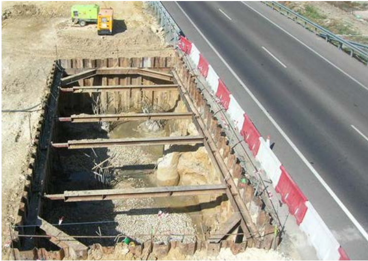
Imagen de excavación paralela a vía de circulación
