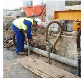
CONEXIÓN A COLECTOR
