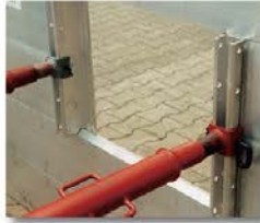
Solución especial: Blindaje de aluminio con 'ventana' 0,54 x 0,5 m 2
