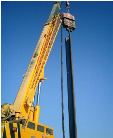
Imágenes de vibrador colgado de grúa hincando tablestacas
