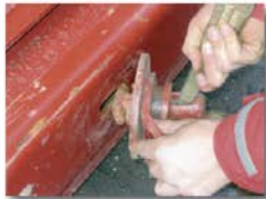
Montaje del ojal para transporte
