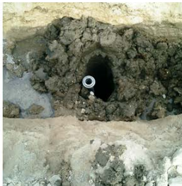
LANZA COLOCADA EN EL POZO
