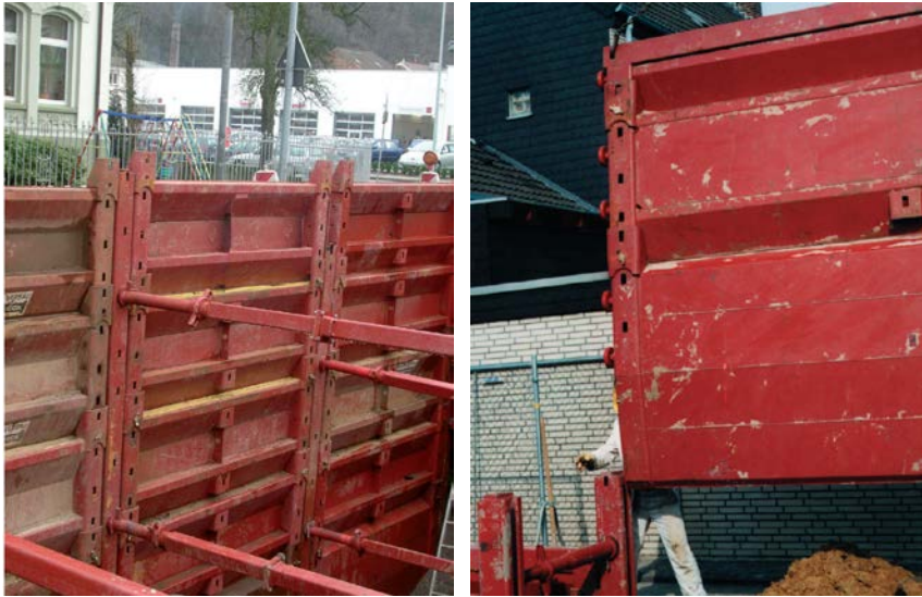
Imágenes del sistema de guía simple en obra
