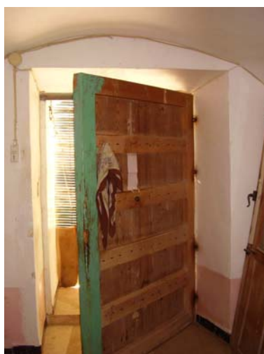
Foto 39: Puerta de acceso.
