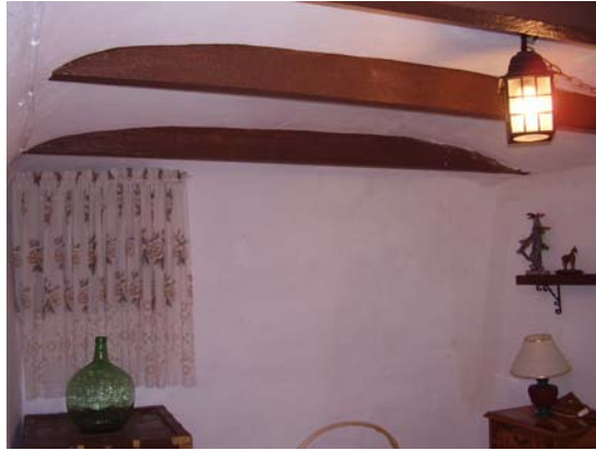
Foto 10: Viguetas de refuerzo.
