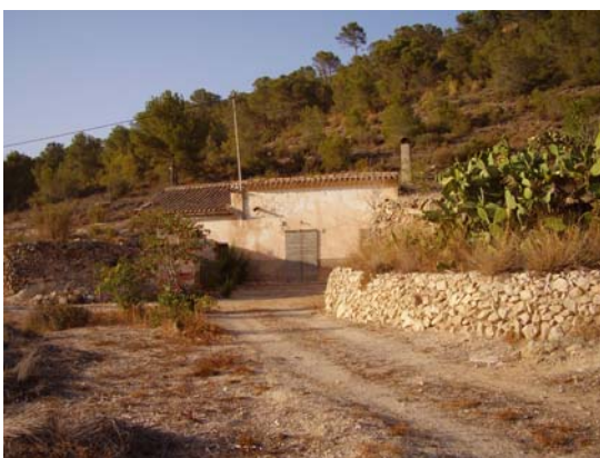
Foto 6: Acceso por camino excavado.
