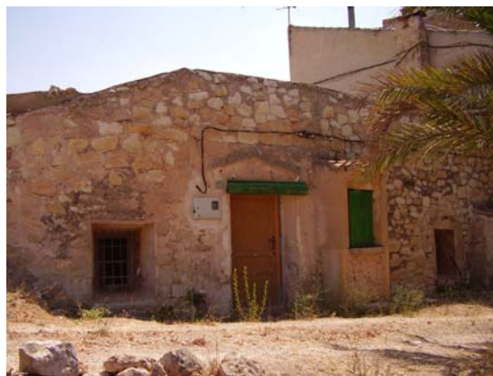
Foto 4: Acceso por frente de bancal.
