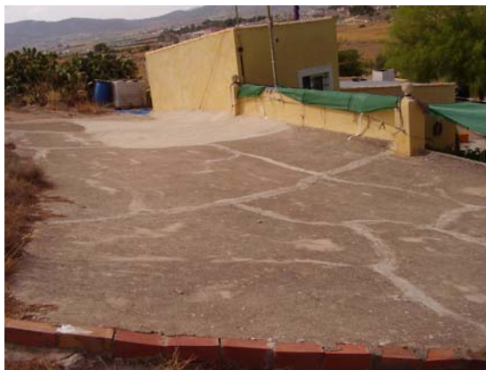
Foto 23: Cubierta revestida con mortero de cemento.
