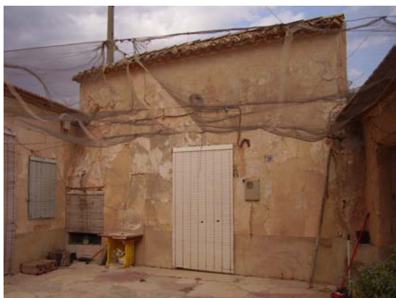
Foto 48: Cuarteado y desprendimiento de revestimientos exteriores.
