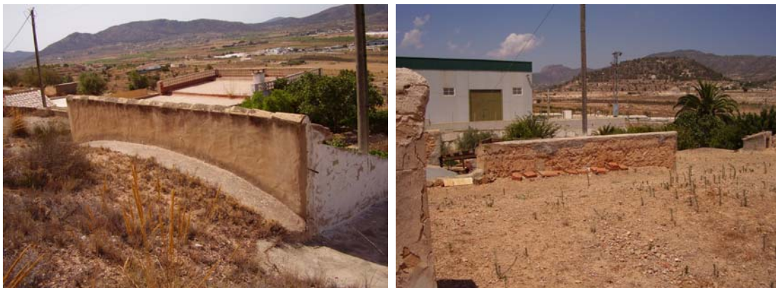
Foto 24: Cubiertas con terreno natural.
