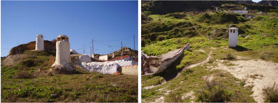
Foto 35: Acabado exterior de cubiertas en Guadix.
