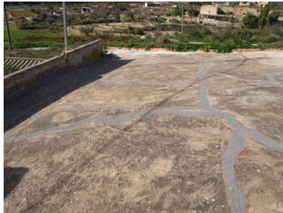
Foto 45: Cubierta terminada con mortero de cemento con grietas impermeabilizadas.
