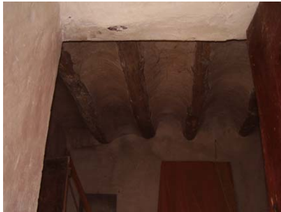
Foto 9: Viguetas de refuerzo.
