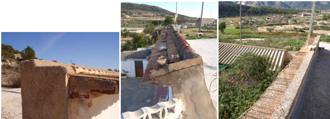
Foto 17: Detalles protección de fachada con teja plana.
