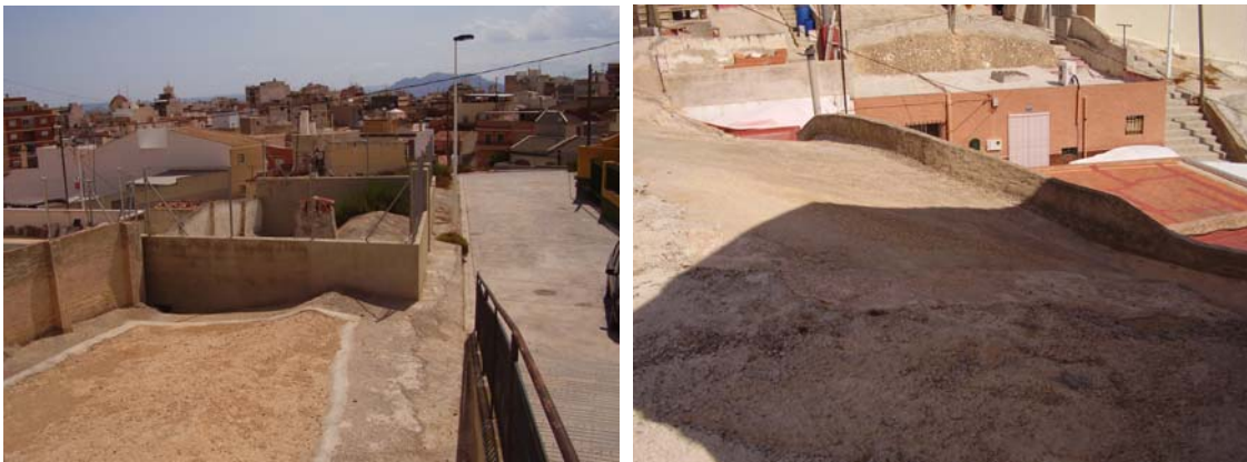
Foto 37: Acabado exterior de cubiertas en Crevillente.
