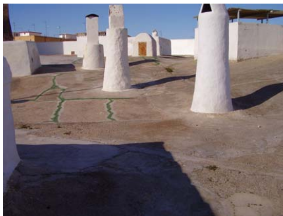
Foto 36: Acabado exterior de cubierta en Paterna.
