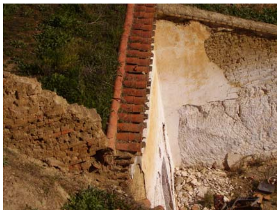
Foto 28: Protección de fachada en Guadix.
