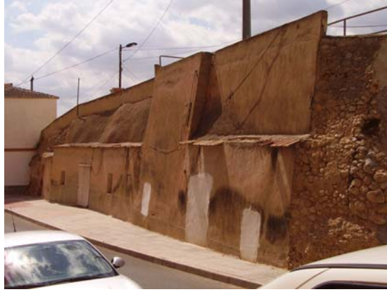
Foto 30: Antepecho en Crevillente.
