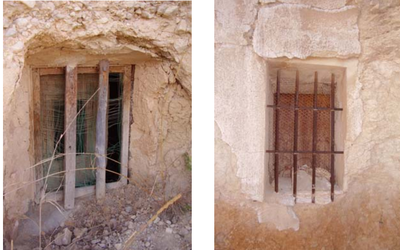
Foto 41: Rejas metálicas y de madera.
