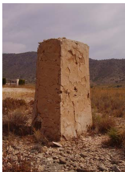
Foto 48: Cuarteado y desprendimiento de revestimientos exteriores.
