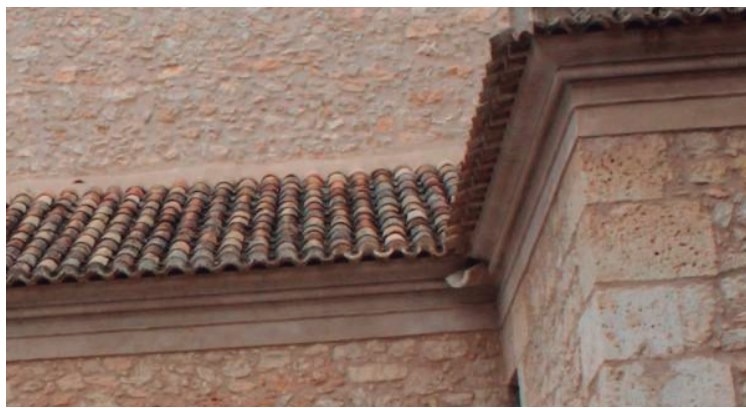
Figura 60. Imagen de la Canaleta de cantería. 2014. M a Nieves Pujol.
