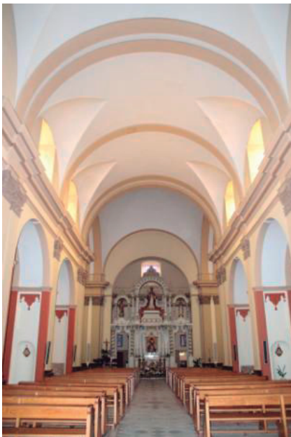
(Izq.)Figura 47. Vista desde la entrada principal en la que se observan los arcos fajones sustentando la nave principal. 2014. M a Nieves Pujol.
