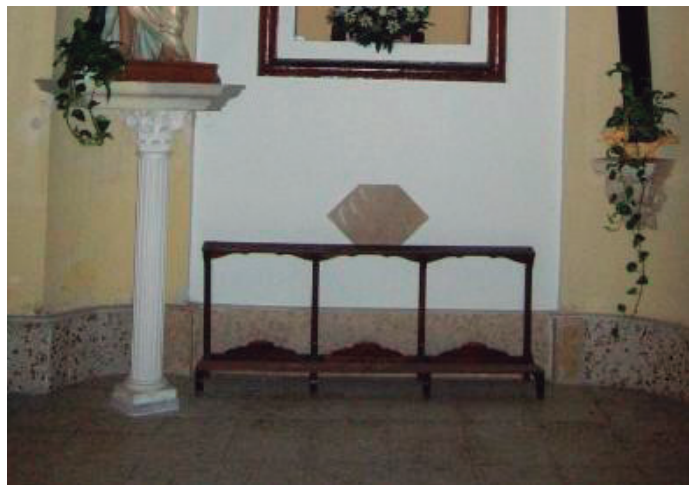
Figura 46. Zócalo de mármol en las naves laterales antiguamente. 2001. Alfredo Alcahut Utiel.
