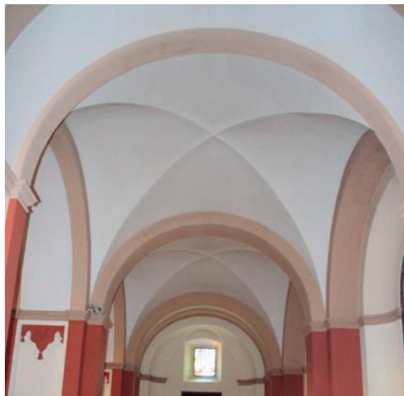
Figura 51. Bóveda de aristas en la nave lateral. 2014. M a Nieves Pujol.
