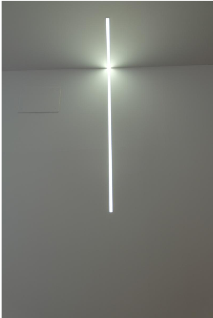
Il·lustració 40. Foto Detall Il·luminària corredor. Encastrades en parets i sostres. 2014. Documentació pròpia.
