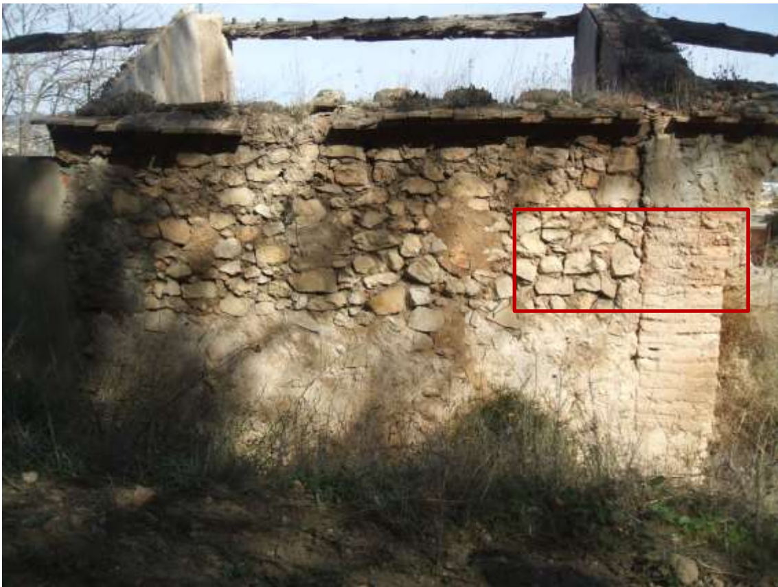
Figura 15: Diferencia de materiales utilizados entre muro y pilares.
