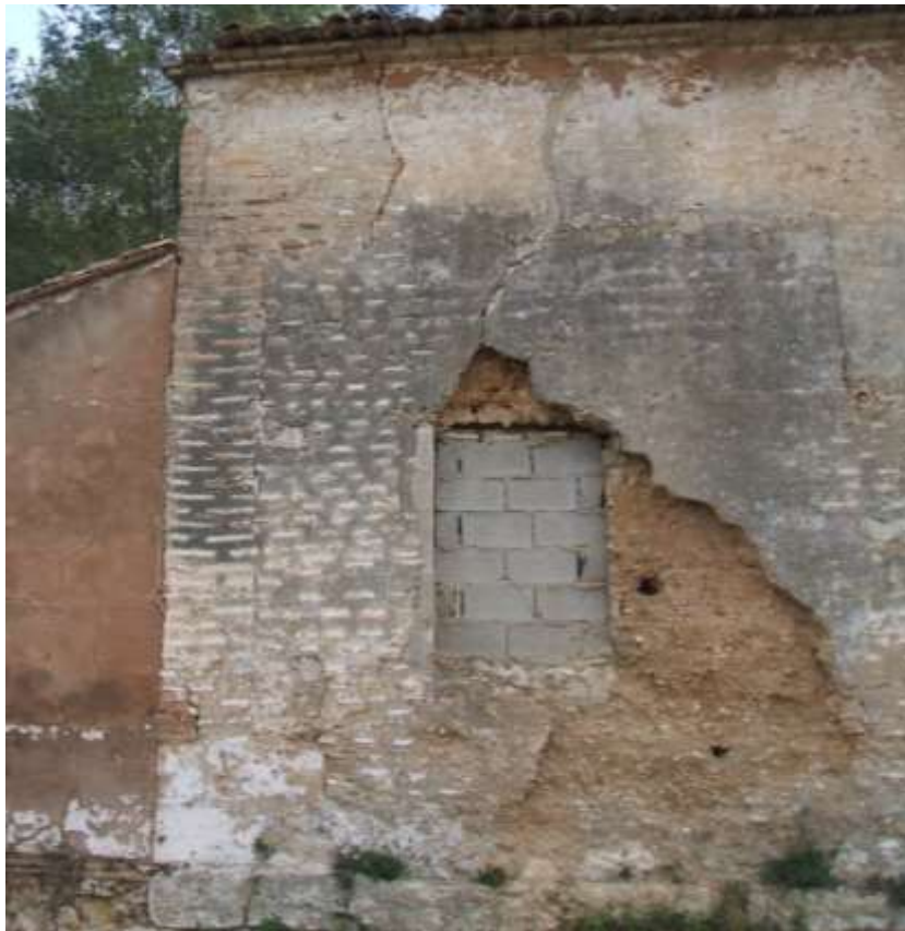
Figura 7: Lavado del núcleo de tierras de la tapia
