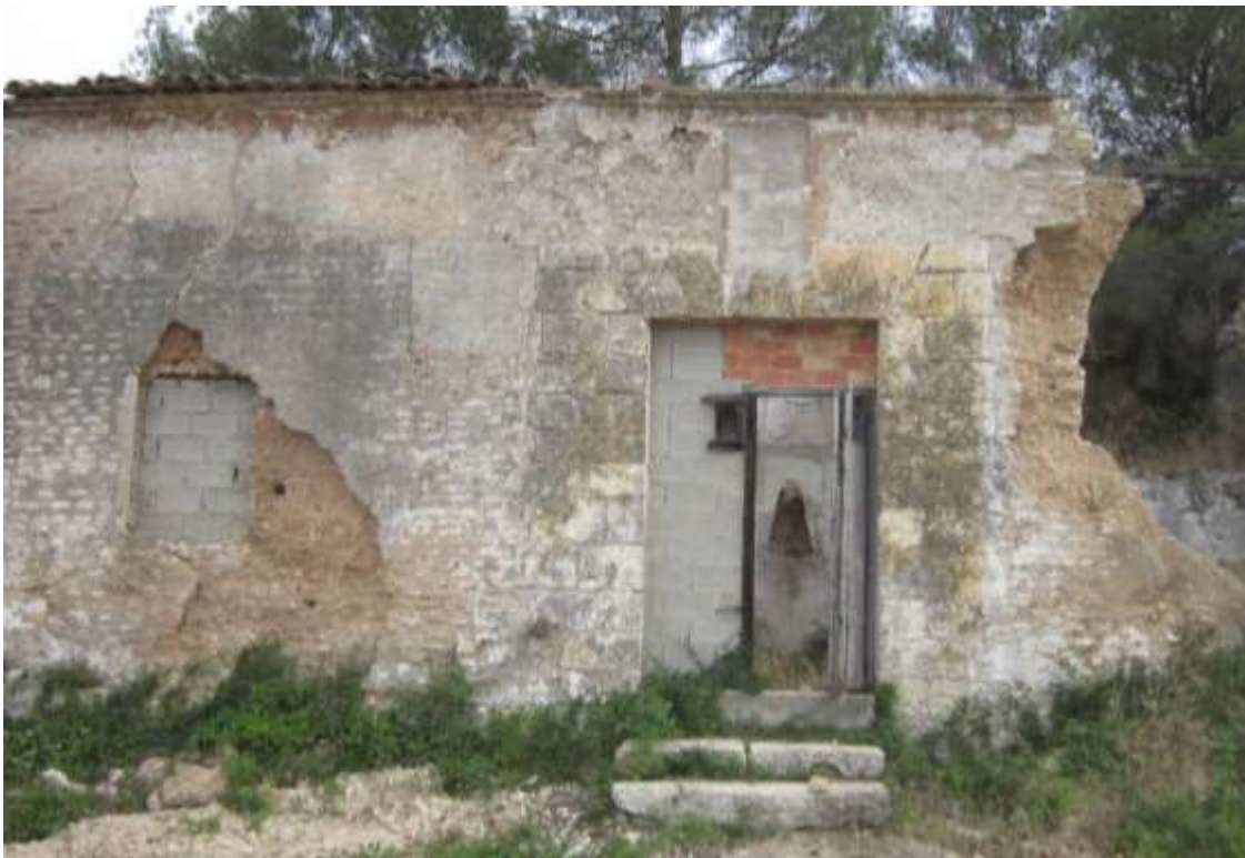
Figura 14: Tapiado de huecos en fachada principal.
