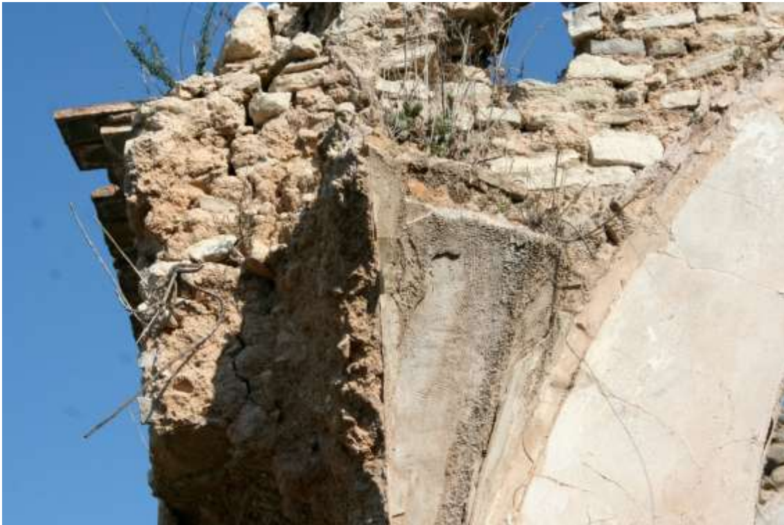
Figura 17: Detalle del arranque de la bóveda. Fotografía de S. Tormo Esteve
