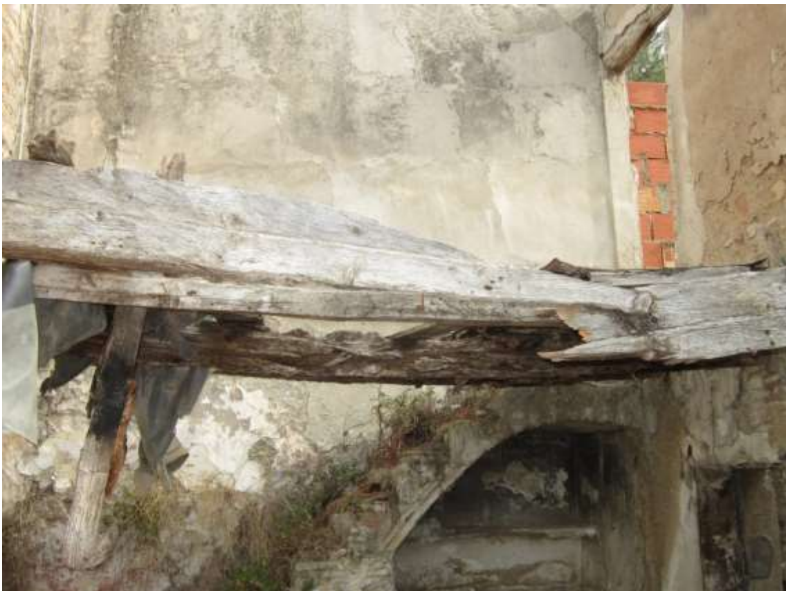
Figura 13: Ataque biológico en los elementos de madera
