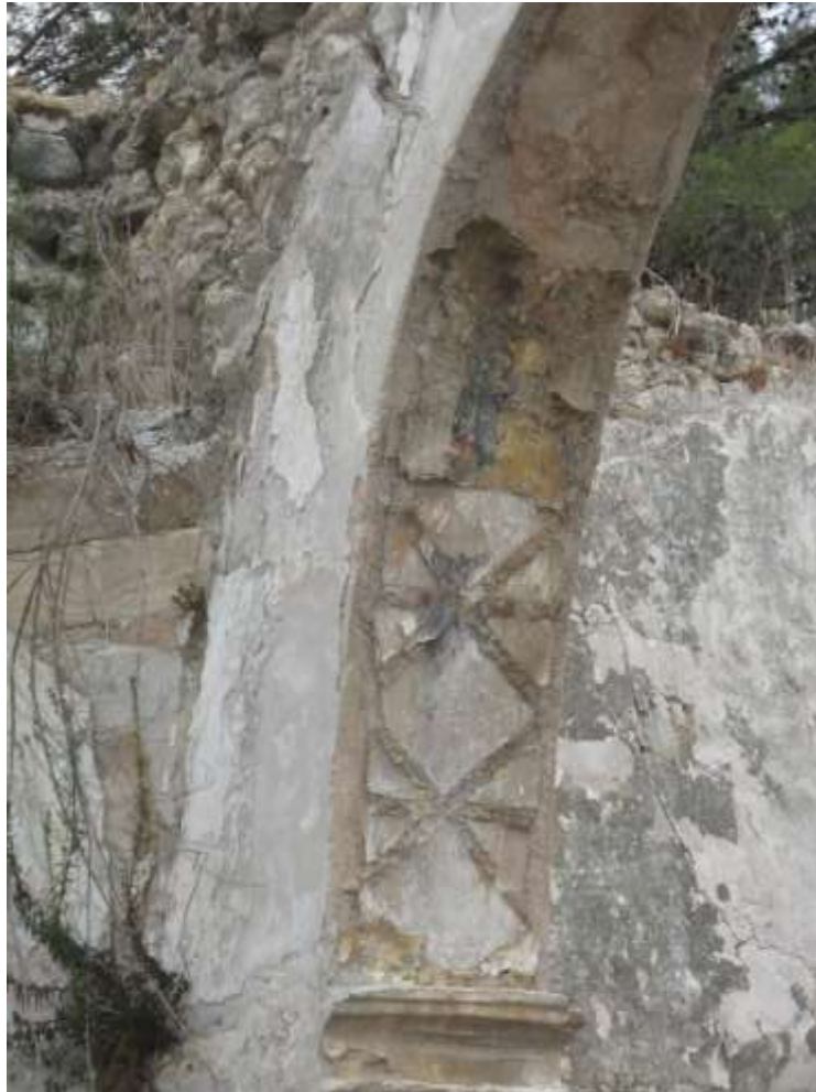
Figura 49: Técnica del esgrafiado en los arcos de medio punto de la ermita
