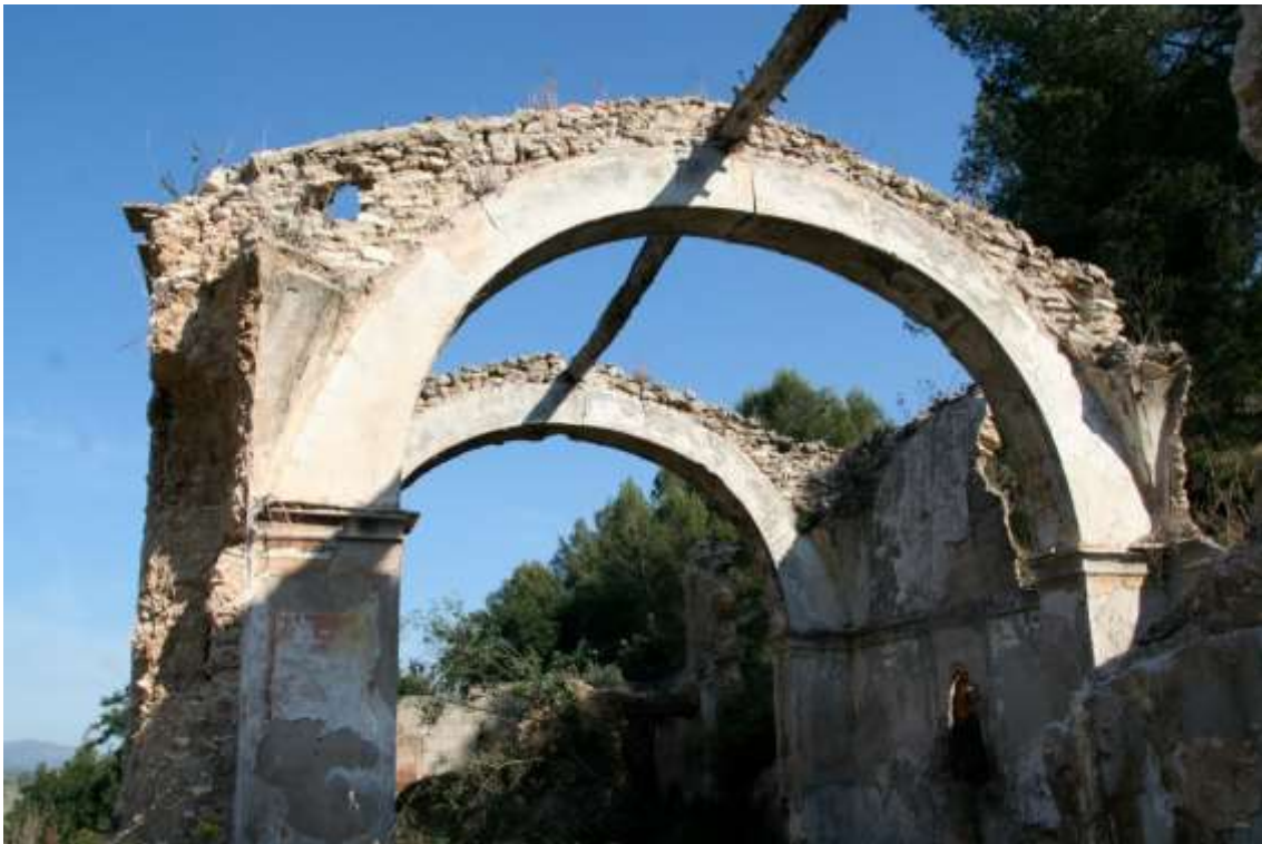
Figura 14: Arcos de medio punto. Fotografía de L. Cortés Meseguer.
