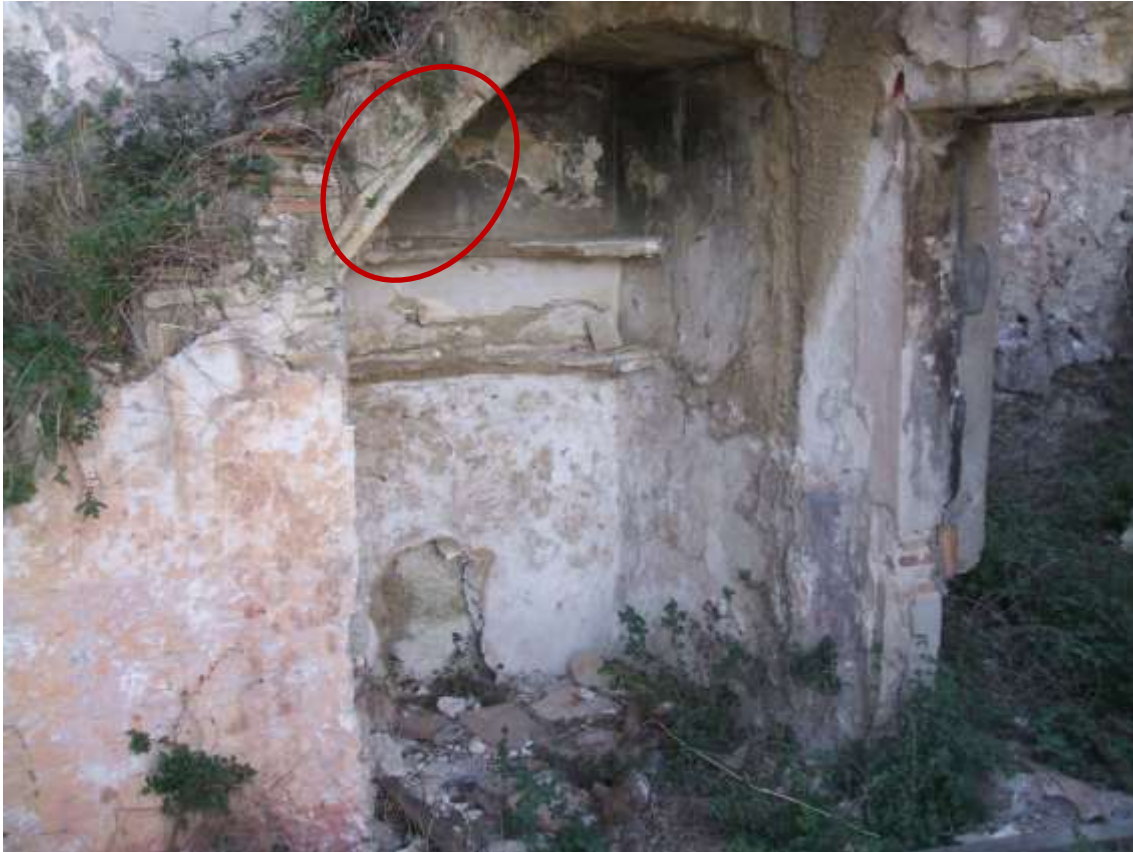
Figura 18: Bóveda tabicada en la escalera de la casa del ermitaño.
