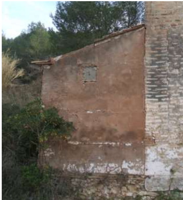
Figura 12: Aspecto que presenta la sacristía de la ermita actualmente
