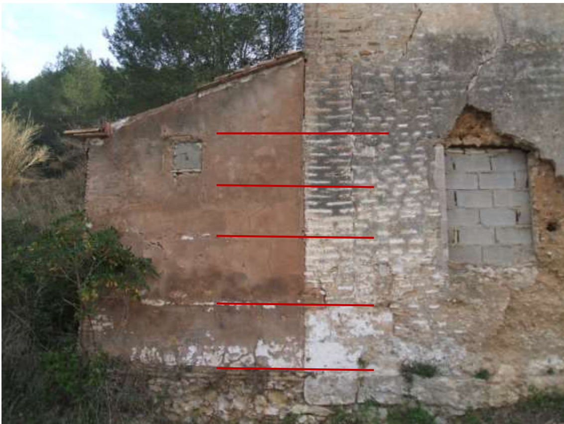
Figura 8: delimitación de tongadas de muro de tapia
