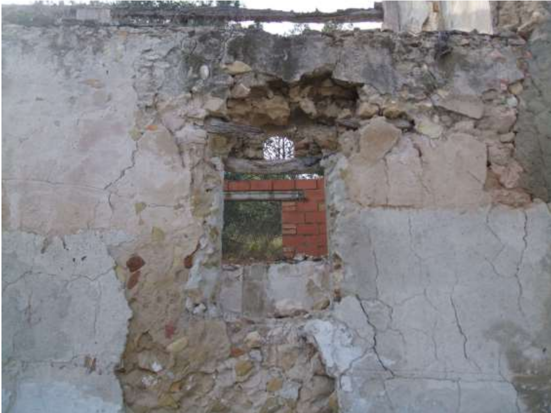
Figura 25: Detalle de dintel en el hueco de la ventana.
