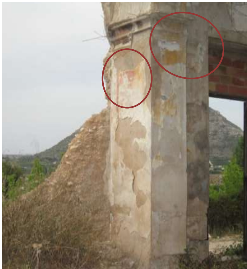
Figura 1: Diferentes capas de pintura en el interior de la ermita
