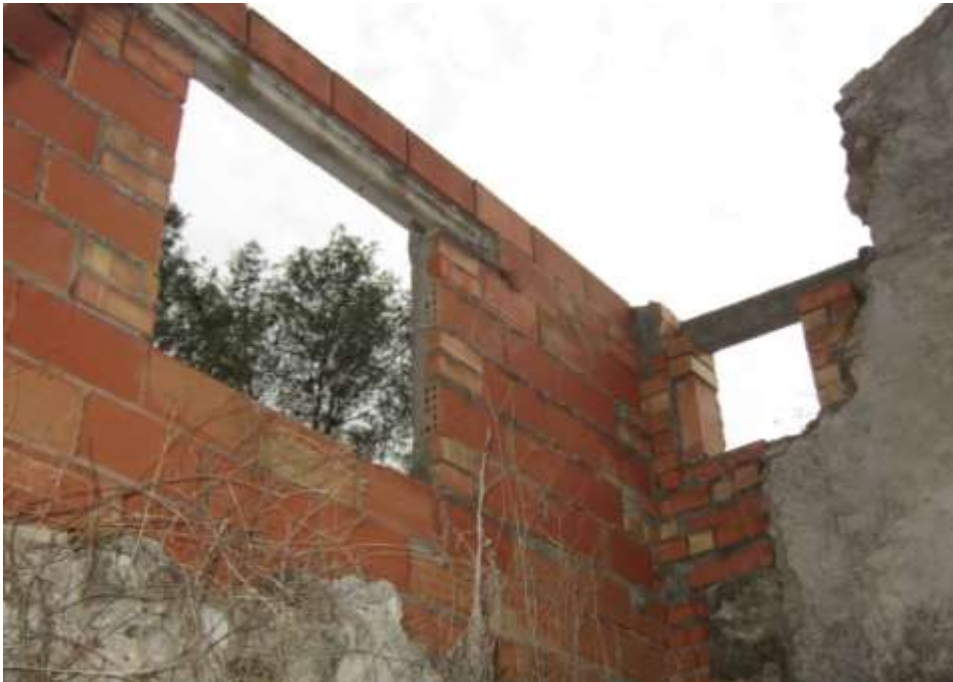
Figura 15: Elemento impropio en fachada posterior
