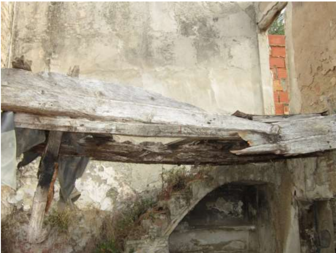
Figura 19: Forjado horizontal en planta primera
