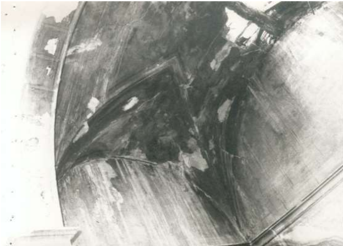
Figura 16: Bóveda tabicada de ladrillo cerámico. Imagen cedida por el Archivo municipal de Xàtiva (AMX Rg: 1491/3)
