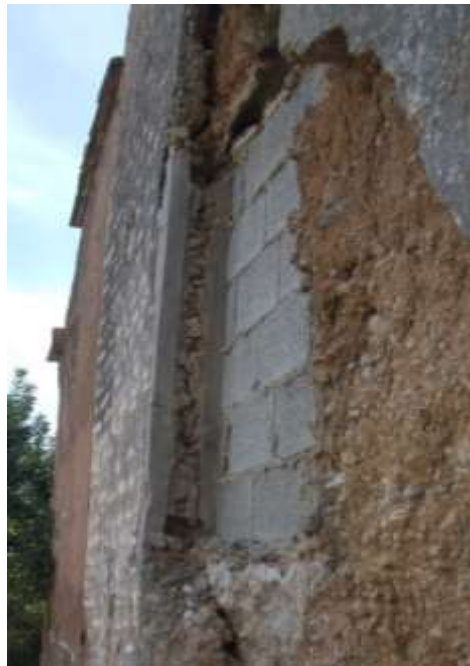
Figura 7: Sección transversal del muro.
