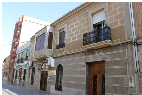
Figura 2. Fachada del edificio objeto a estudio
