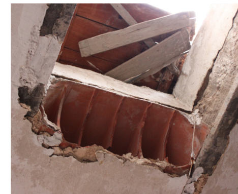
Figura 6. Apertura hueco palomar. Bovedilla cerámica
