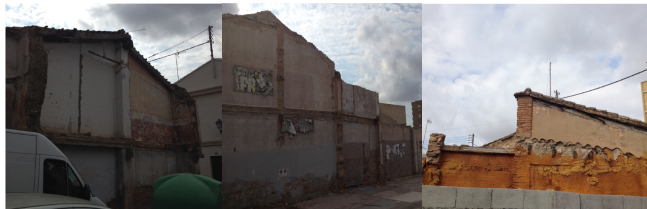
Figuras 1, 2 y 3. Vistas de varios edificios de la zona, en los que se les ve parte de la estructura
