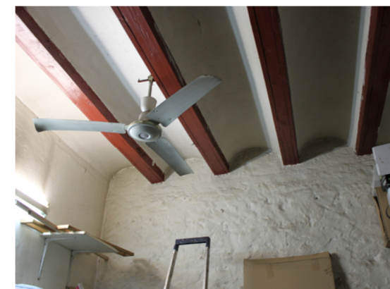
Figura 5. Vista del forjado de planta baja. Detalle del revoltón
