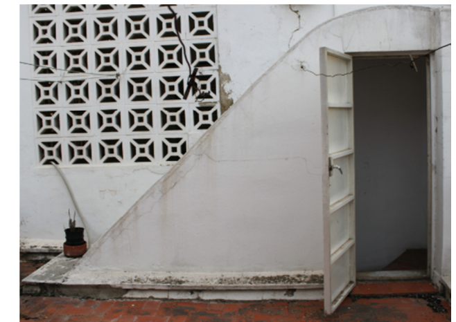
Figura 9. Vista de la azotea del edificio
