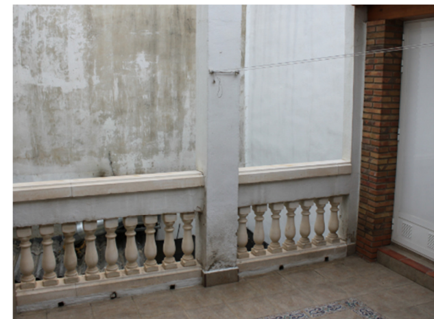
Figura 8. Vista de la terraza descubierta
