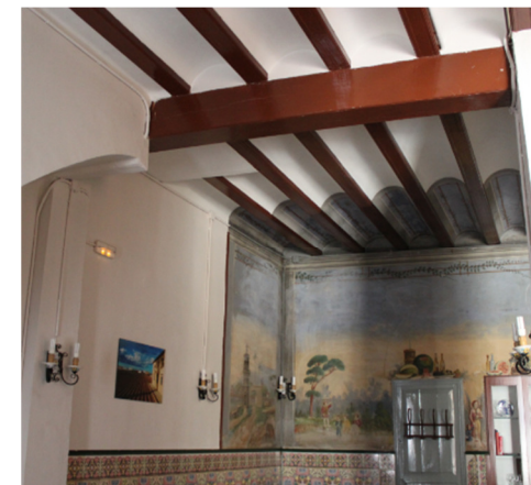
Figura 4. Vista del forjado de planta baja
