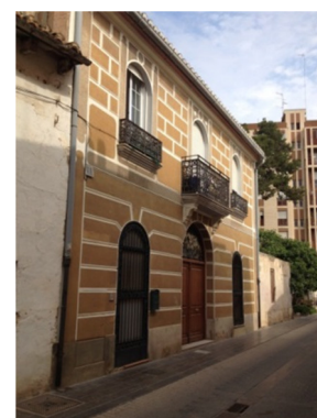
Figura 3. Fachada del edificio ubicado en la calle Marines nº13
