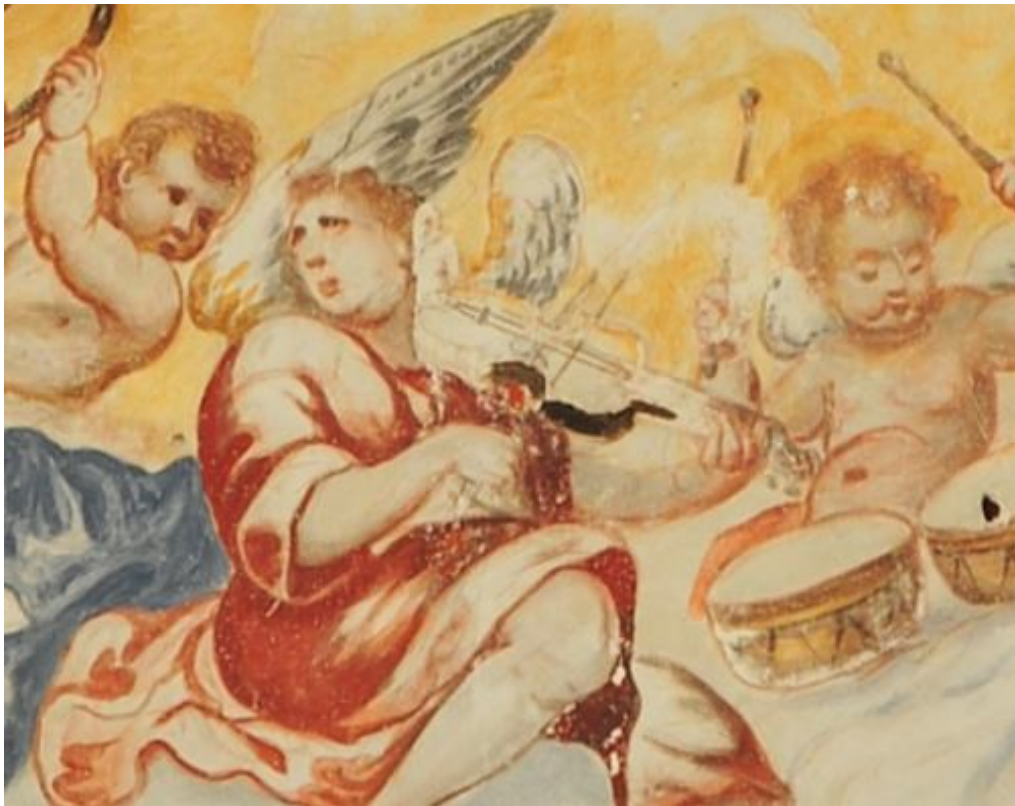
Imagen 52. Daños provocados por defectos en la técnica
