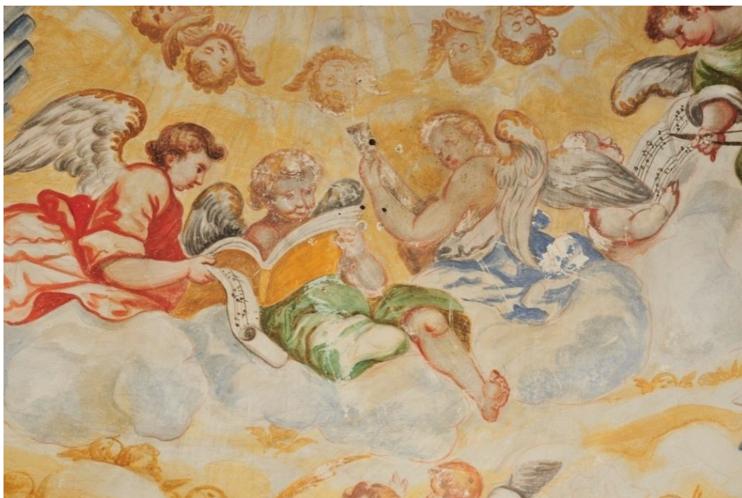
Imagen 51. Pintura pulverulenta a causa de la humedad
