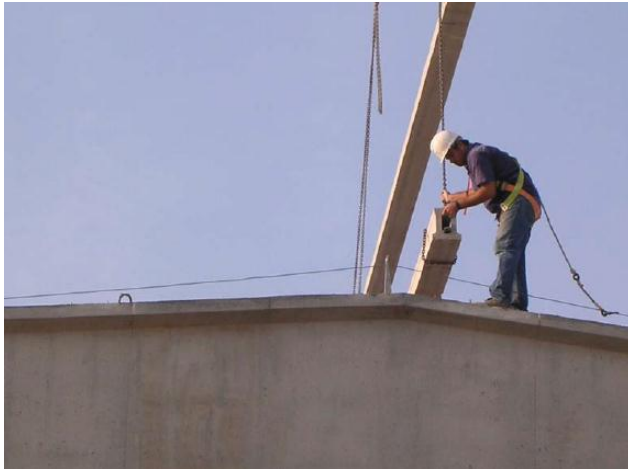
Ilustración 56. Colocación de correas. Fuente: Bibliografía 1.
