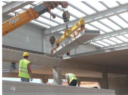
Ilustración 53. Izado viga e izado losa. Fuente: Bibl. 1 y lineaprevención.com
