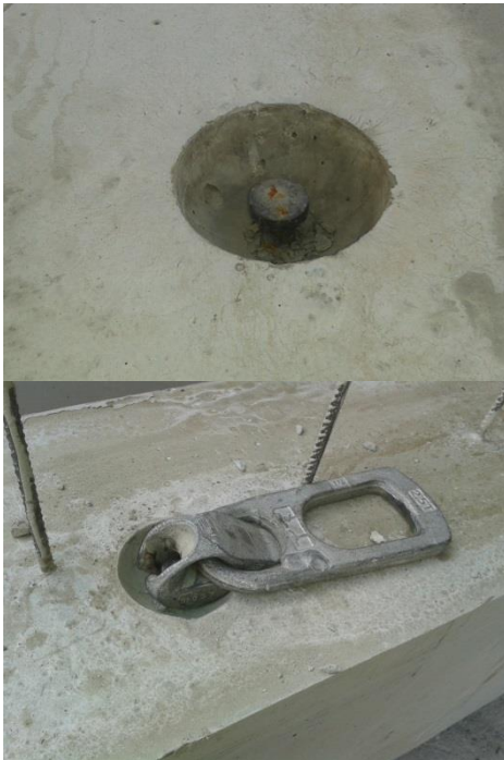
Ilustración 39. Rosca y garra de elevación. Fuente: Propia.
