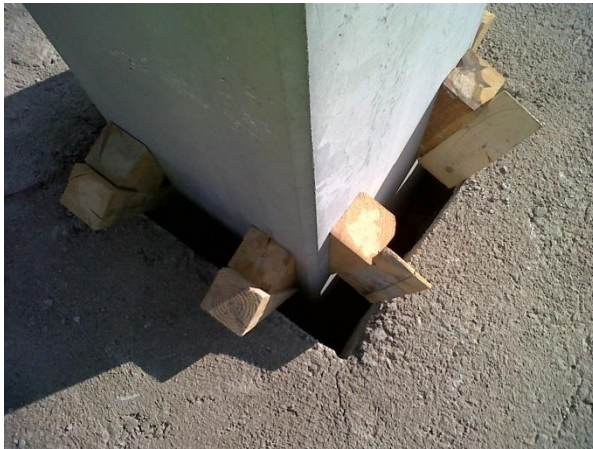
Ilustración 52. Cuñas para la verticalidad del soporte.
