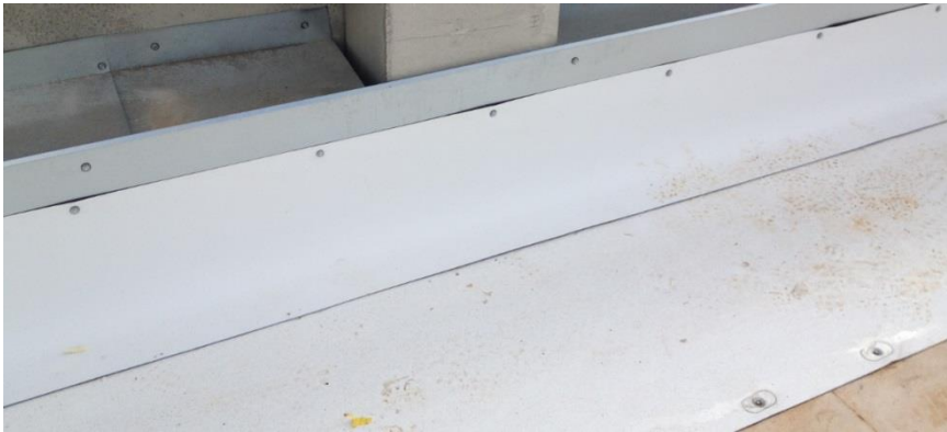
Ilustración 66. Peto de cubierta. Fuente: Propia.
