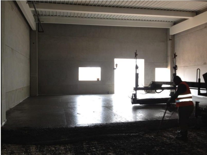
Ilustración 70. Regleado del hormigón. Fuente: Propia.
