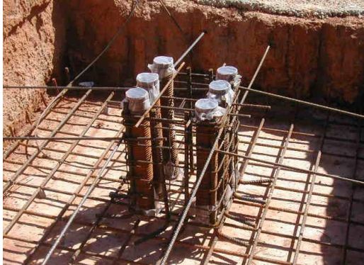
Ilustración 3. Cimentación por vainas. Fuente: Propia.
