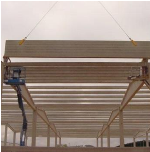
Ilustración 57. Colocación de paneles horizontales. Fuente: Bibliografía 2.
