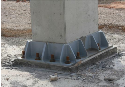
Ilustración 5. Cimentación con chapa base. Fuente: Bibliografía 1
