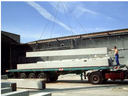
Ilustración 53. Izado viga e izado losa. Fuente: Bibl. 1 y lineaprevención.com
