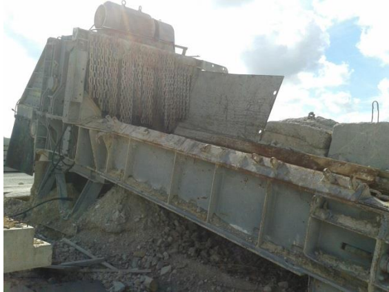
Ilustración 36. Demoladora. Fuente: Propia.
