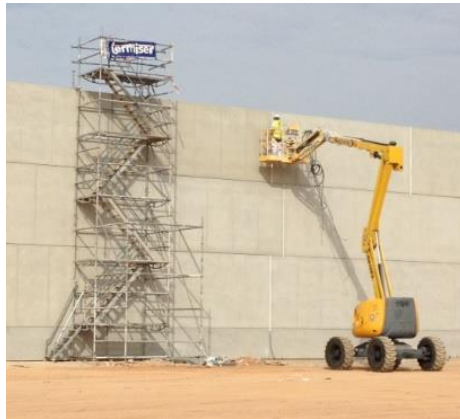
Ilustración 58. Izado de operarios. Fuente: Propia.
