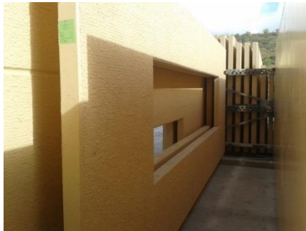
Ilustración 35. Acopios de paneles. Fuente: Propia.
