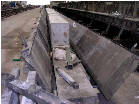
Ilustración 30. Desmoldeo soporte/viga. Fuente: Bibliografía 1.
