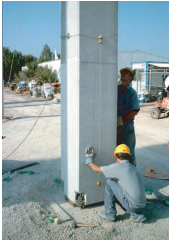
Ilustración 4. Cimentación atornillada. Fuente: Prevalesa.
