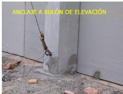
Ilustración 55. Anclaje a soporte. Fuente: Bibliografía 1.
