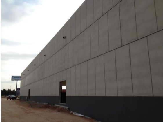
Ilustración 10. Paneles horizontales. Fuente: Propia.
