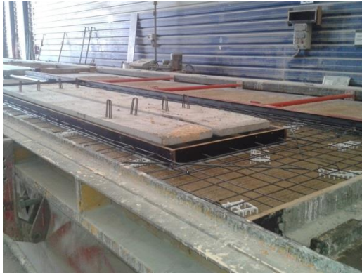
Ilustración 32. Armado de paneles. Fuente: Propia.
