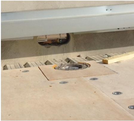
Ilustración 67. Sumidero y orificio de evacuación de agua. Fuente: Propia.
