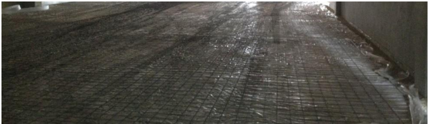
Ilustración 69. Armadura de la solera. Fuente: Propia.
