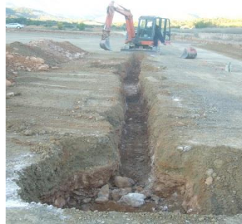
Ilustración 46. Excavación de zapatas y vigas riostra. Fuente: Propia.
