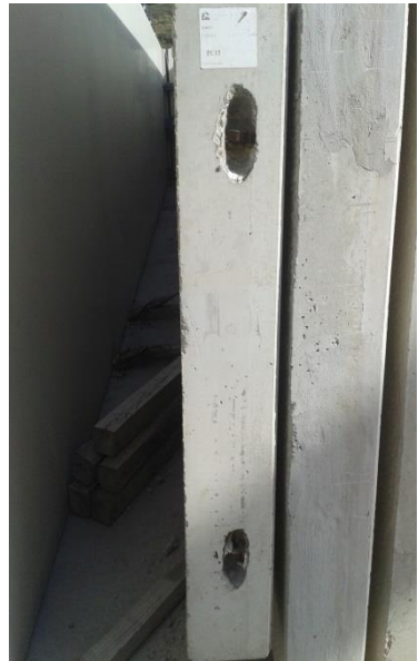
Ilustración 38. Elementos de elevación en paneles. Fuente: Propia.
