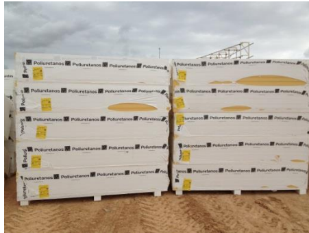
Ilustración 59. Acopios de materiales de cubierta. Fuente: Propia.
