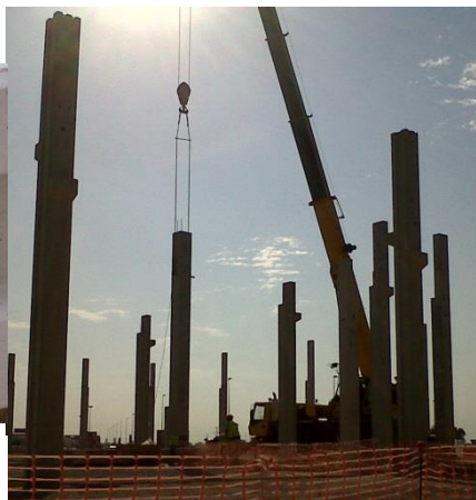
Ilustración 51. Izado de soporte. Fuente: Propia.
