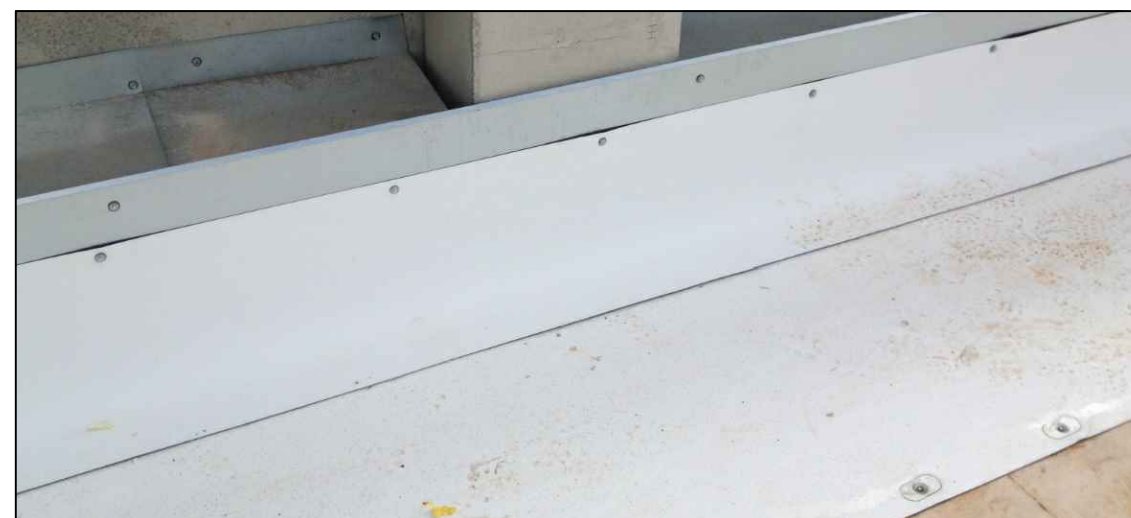
FOTO PETO CUBIERTA
