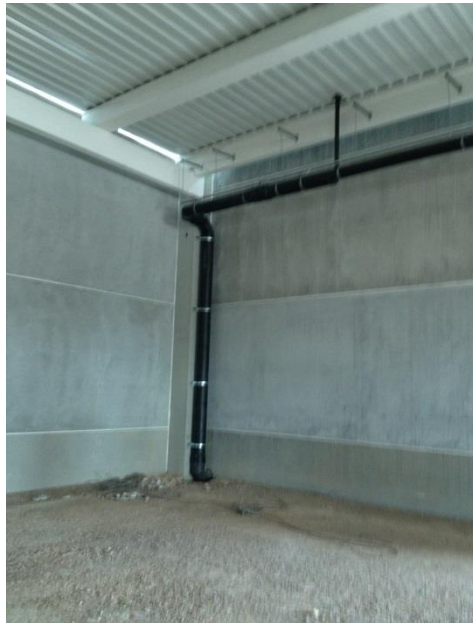
Ilustración 68. Evacuación interior del agua. Fuente: Propia.
