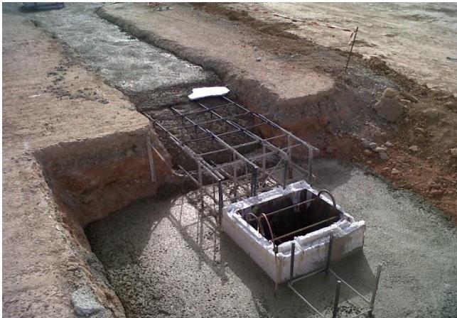
Ilustración 6. Viga riostra. Fuente: Propia.
