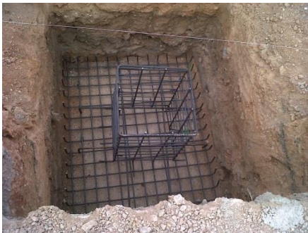
Ilustración 48. Armado y hormigonado de cimentación. Fuente: Propia.
