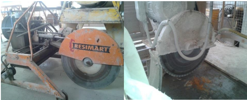
Ilustración 24. Cortadora manual y eléctrica de losas alveolares. Fuente: Propia.
