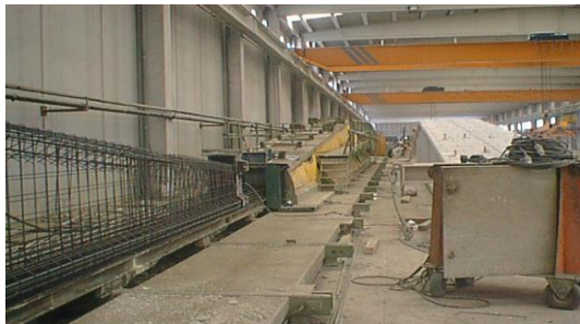
Ilustración 26. Armado y encofrado de viga de sección variable. Fuente: Biblio 2.
