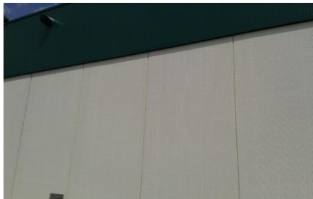
Ilustración 9. Paneles verticales. Fuente: Propia.
