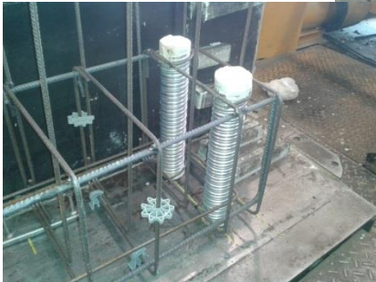
Ilustración 29. Armadura de viga. Fuente: Propia.
