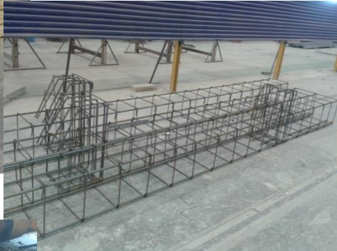
Ilustración 28. Armadura de pilar con ménsula. Fuente: Propia.
