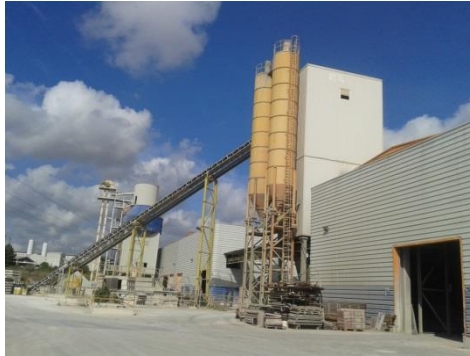
Ilustración 14. Instalación de hormigonado. Fuente: Propia.
