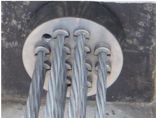
Ilustración 1. Cuña de anclaje. Fuente: iatsa
