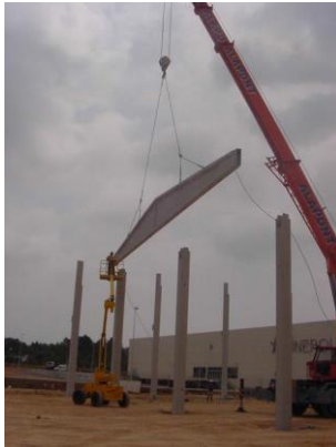
Ilustración 54. Izado de vigas de cubierta. Fuente: Bibliografía 2.
