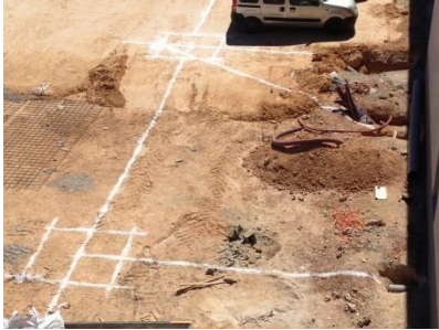
Ilustración 47. Replanteo cimentación. Fuente: Propia.
