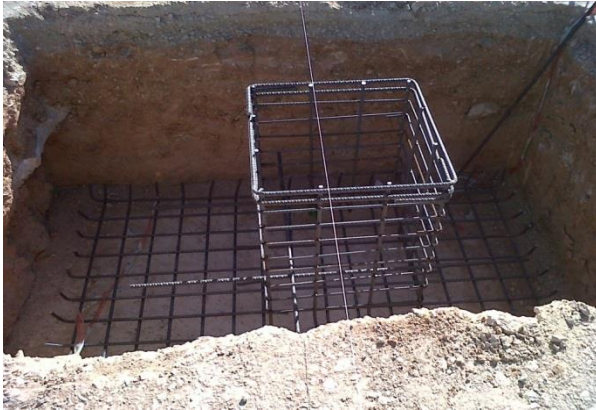
Ilustración 2. Cimentación por cáliz. Fuente: Propia.
