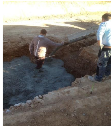
Ilustración 48. Armado y hormigonado de cimentación. Fuente: Propia.
