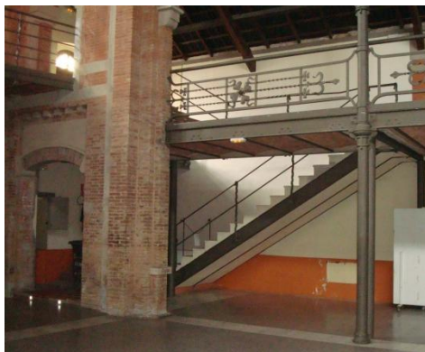
Imagen 3.27: Nueva escalera para acceso a la planta de altillos, en nave principal.
