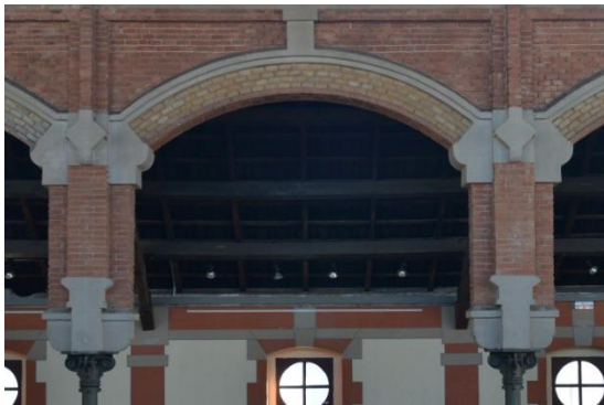
Imagen 3.17:Vista del conjunto formado por las columnas de fundición, sobre las que descansan los pilares que reciben los arcos escarzanos y que a su vez soportan la estructura de la cubierta.
