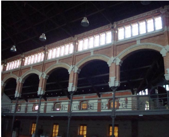
Imagen 3.6: Vista del muro de separación entre la nave principal, de mayor altura, y las naves laterales adosadas a la misma. Esta composición permite una buena iluminación del interior del edificio gracias a los lucernarios situados en la parte
