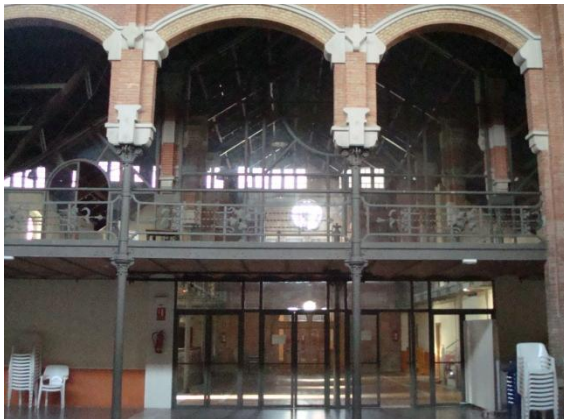
Imagen 3.36: Mampara de vidrio y perfiles de acero laminado, vista desde la nave principal.
