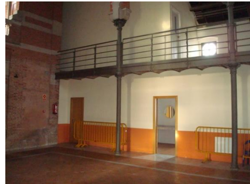
Imagen 3.33: Locales destinados a almacén y a aseos, en planta baja.
