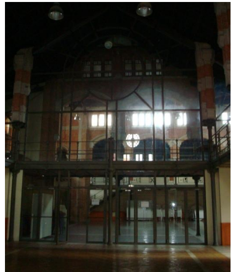
Imagen 3.37: Mampara de vidrio y perfiles de acero laminado, vista desde la zona de bar-cafetería.
