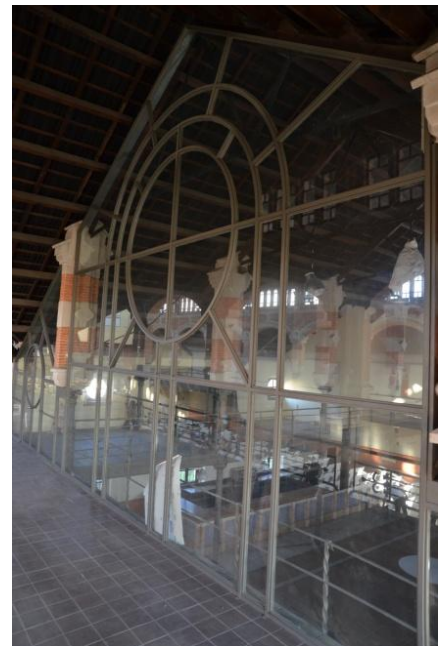
Foto 4: Elemento separador visto desde la planta de altillo.
