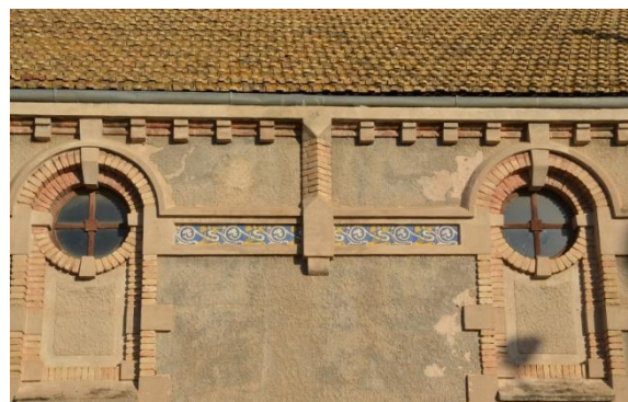
Imagen 3.20:Detalle del remate decorativo perimetral formado mediante azulejos de estilo modernista.
