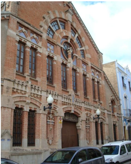
Imagen 3.8: Fachada de la nave principal en la calle "La missa".
