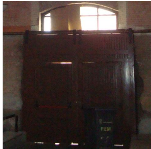
Foto 2: Vista interior de la puerta de acceso, incluida en la fachada ensayada.
