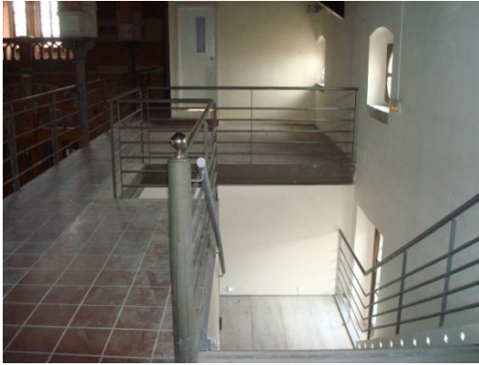
Imagen 3.34: Escalera acceso altillo en zona bar-cafetería. Al fondo aparece un local destinado a aseos.
