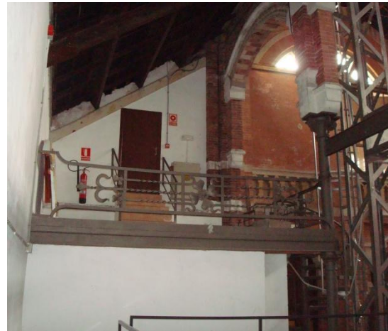
Imagen 3.24: Cuartos de instalaciones en la cabecera de la nave ppal. recayente a la calle "La missa".
