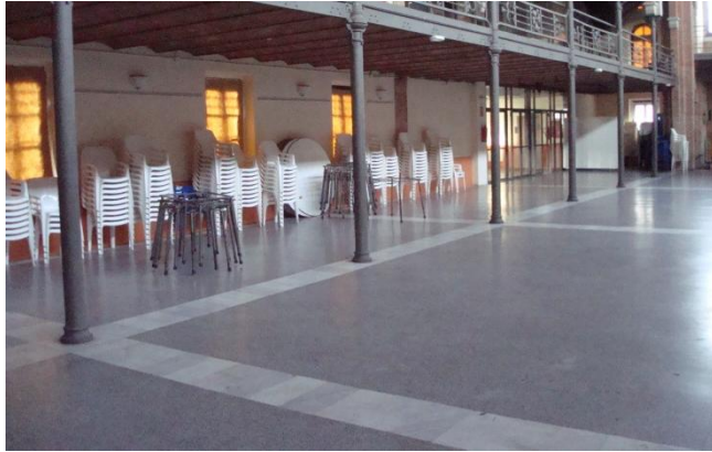
Imagen 3.29: Pavimento mediante baldosas de terrazo grisáceo delimitado en zonas por baldosas de mármol blanco, en nave ppal.
