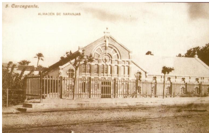
Imagen 3.40: Vista de la fachada de la calle Joanot Martorell, desde el andén de la estación de ferrocarril.
