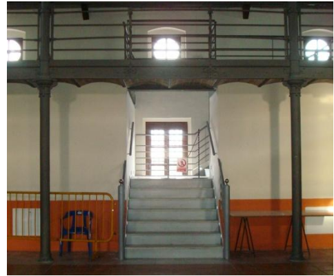
Imagen 3.35: Escalera acceso altillo en zona bar-cafetería.
