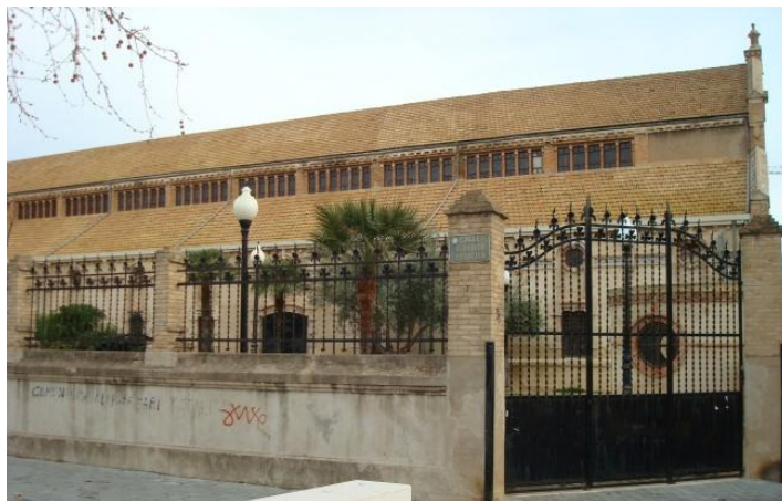
Imagen 3.13: Puerta de acceso al patio lateral.
