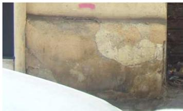
Ilustración 34. Desprendimiento revestimiento. Fuente edición propia.
