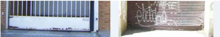
Ilustración 37. Corrosión por aireación diferencial. Fuente: edición propia.
