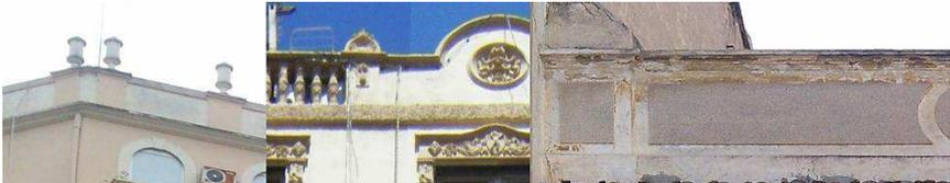
Ilustración 26. Antepechos y remates. De izq a dcha. Erosión, suciedad, erosión, suciedad y fisuras. Fuente: edición propia.
