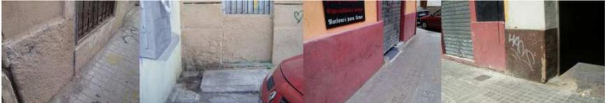
Ilustración 25. Ejemplo lesiones en zócalos. De izq. A dcha. Erosión física, humedad capilar, suciedad, erosión física. Fuente: edición propia.
