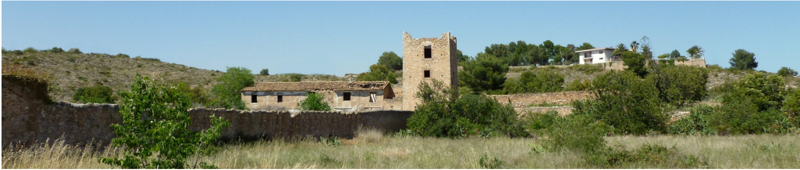
Fig. 30. Vista panorámica de la alquería del Agua Fresca.
