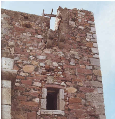
Fig. 77, 78 y 79. Detalle del matacán de otras construcciones en el municipio de Sagunto, la torre de la Casa-palacio Duque de Gaeta (s. XV), la torre de la alquerieta de Roc (s. XVI) y la torre del Grau Vell (s. XVI). Fuente: Lluesma Espanya, 2009.
