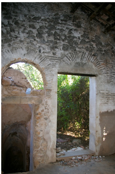
Fig. 121 y 122. Muro de mampostería combinado con ladrillo en el edificio del aljibe de la alquería del Agua Fresca. Imagen propia. Comparativa con el muro de mampostería listada con hiladas de ladrillo de la alquería de Albors (finales del s. XVIII y principio XIX). Fuente: Del Rey et al., 2002.
