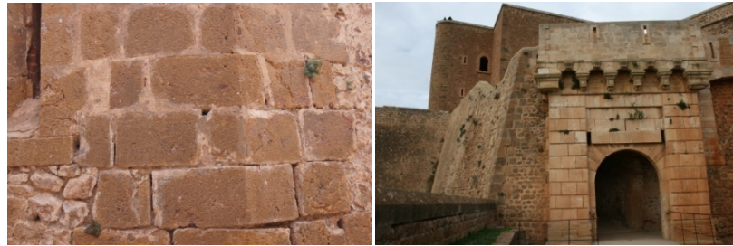
Fig. 2 y 3: Sillería en las esquinas de los paramentos y en la puerta principal (S.M).
