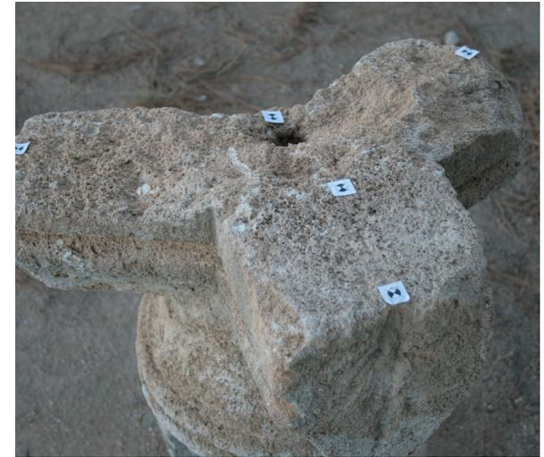
Fig. 5.11. Trasdós de la clave secundaria, en donde se aprecia la marca del cantero del eje de la ligadura.
