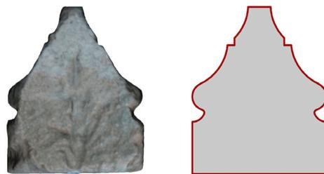
Fig. 5.13. Plantillas de los nervios de la clave secundaria. (B2A.1).
