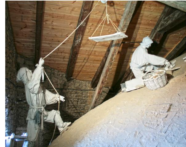
Fig. 8.35. Recreación del proceso constructivo de una bóveda, sobre el trasdós de la cabecera de la iglesia de Santa María Magdalena de Vilafranca del Cid. En donde la plementería forma un casquete que envuelve a los nervios, quedando estos ocultos en su trasdós, asomándose únicamente las claves.
