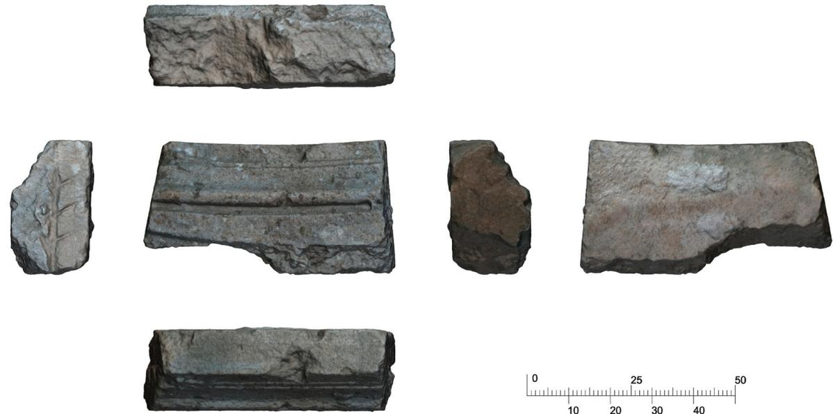
Fig. 5.33. Vistas de la dovela de arco de cabeza B1B.2.
