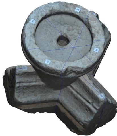
Fig. 6.10. Trazado de los ejes de los planos medios de los nervios de la clave secundaria.
