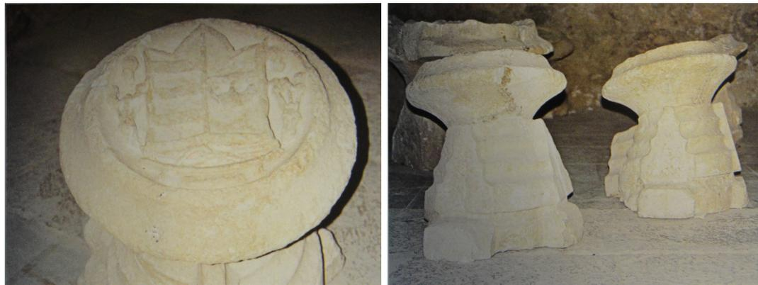
Fig. 6.12. Clave secundaria de la sacristía del monasterio de Simat de la Valldigna. Trasdós de la clave horizontal a la pieza colcada.
