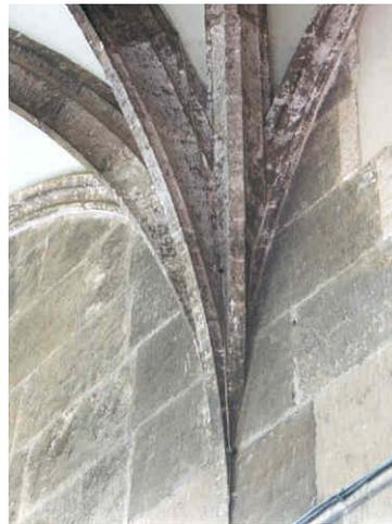
Fig. 7.17. Arranque del claustro del convento de la Trinidad en Valencia.
