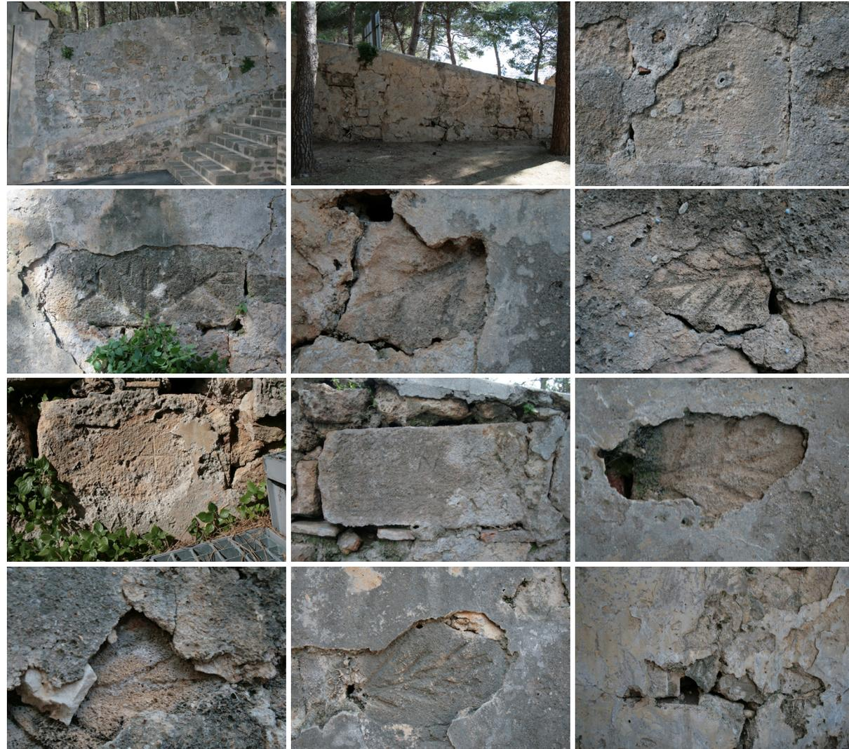
Fig. 3.31. Restos de dovelas y sillares de la iglesia de la Vila Vella, encontrados a lo largo del muro de defensa creado entre los años 1700-1800. Dichas piezas son fácilmente identificables por la presencia de espigas para el mejor agarre del mortero, formas aplantilladas o por la presencia de marcas de cantería.
