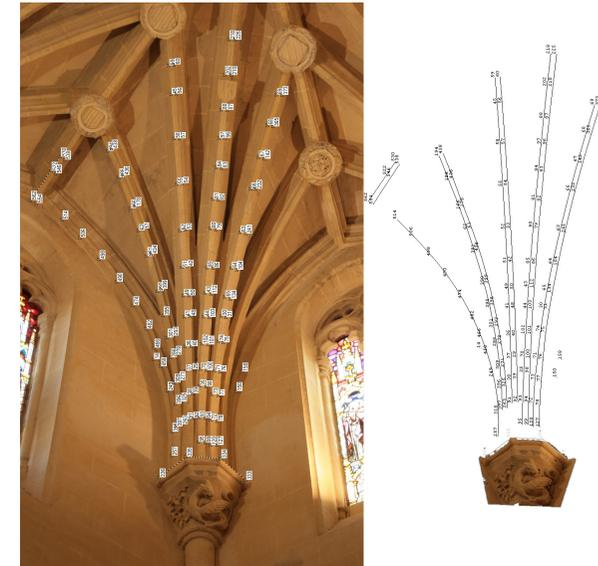
Fig. 2.01. Referenciado de puntos homólogos en Photomodeler Scanner. Resultado de referenciar 13 imágenes, usando como dianas naturales, las juntas de las dovelas y la extracción de la nube de puntos del capitel. Jraje del ábside de la catedral de Orihuela.
