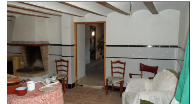
Forjado de revoltón cocina
