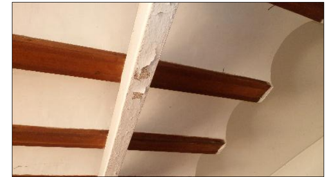
Apoyo forjado de revoltón sobre perfil IPE 200
