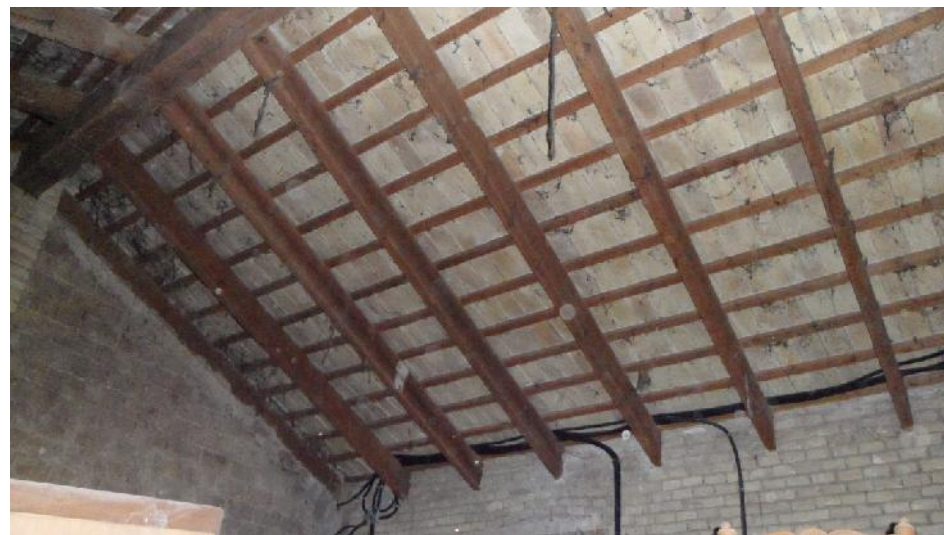
Ilustración 32. Vista cenital de la cubierta a dos aguas
