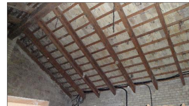
Cubierta a dos aguas Planta Primera.
