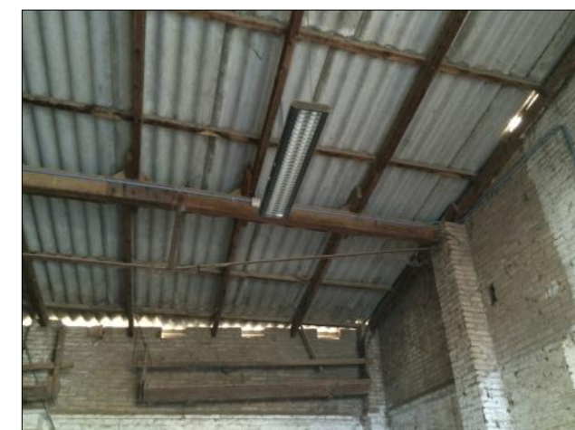
Cubierta de almacén de placas de fibrocemento
