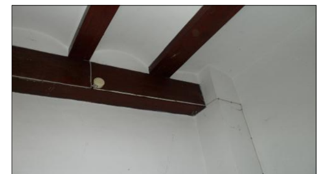
Apoyo forjado de revoltón sobre viga de madera
