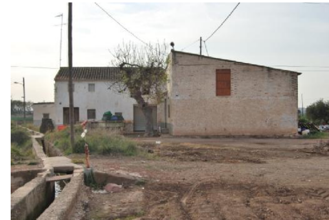
Ilustración 22. Vista fachada principal
