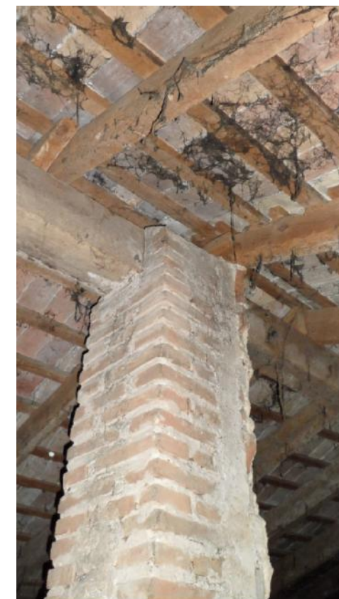
Ilustración 38. Pilar central. Fuente: propia autora
