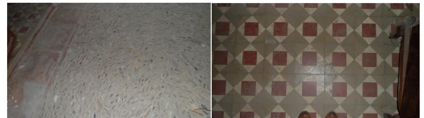
Ilustración 48. Pavimento de guijarros o "paso de caballos" y pavimento hidráulico de dormitorios 1 y 2. Fuente: propia autora
