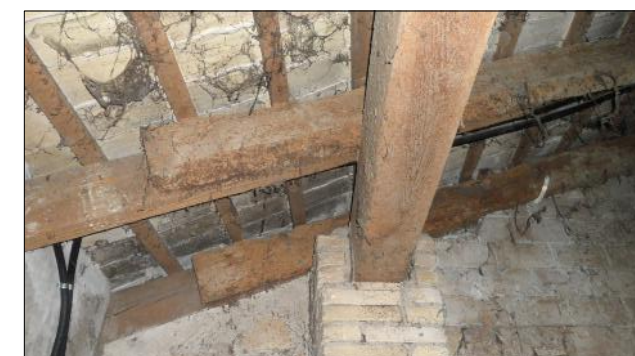
Detalle encuentro viga-pilar Planta Primera
