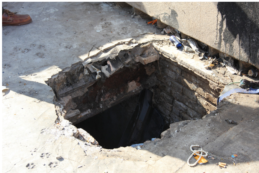
Imagen IX-126. Perforación en la terraza de la estación de Nazaret. Fuente: Singularg
