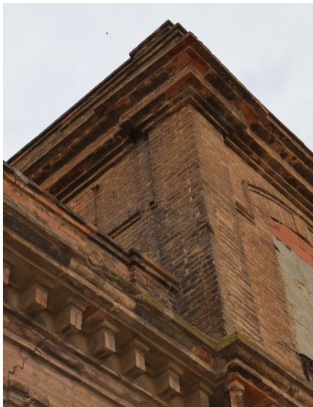
Imagen XI-10 y II. Desaparición de las bajantes de recogida del agua de lluvia, tanto de cubierta como de la terraza plana del piso superior. Testeros Norte y Sur. Fuente: Propia
