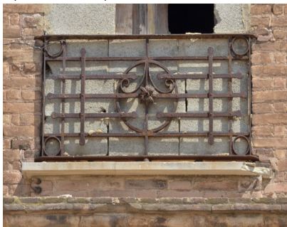
Imagen IX-89. Estación de Nazaret . Cerrajería de la planta superior. Fuente: Propia.
