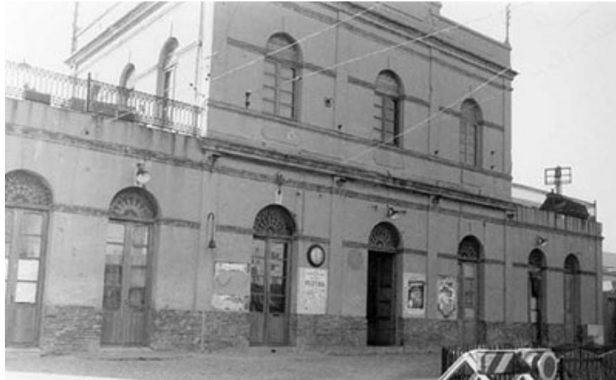
Imagen IX-60. Estación de Grao . Imagen superior: Vista desde el andén. Fuente: AHFGV. Imagen inferior: Vista desde la vía. Fuente: Aguilar Civera I. Historia de las estaciones ferroviarias valencianas. DPV. Valencia. Pág. 80. 1984.
