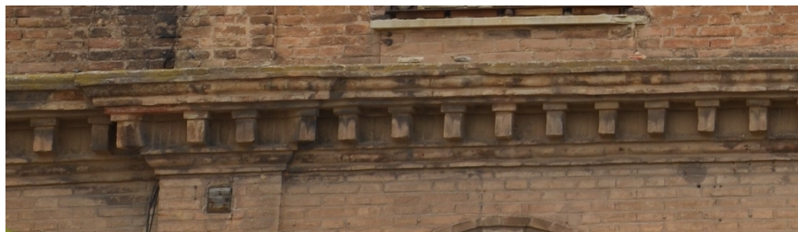
Imagen XI-1. Musgo y algas en frente de alero de cornisa. Fachada Oeste (andén, c/ Cuatretoda). Fuente: Propia
