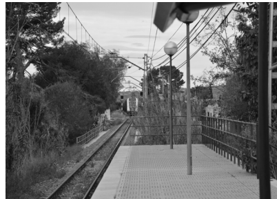
Compañía: S.C.M.D.A.Y.F.G.T. Año: 1895. Fot. Actual Ingeniero: Juan Pérez SanMillán Categoría: Apeadero. Posición: Paralelo a vía
