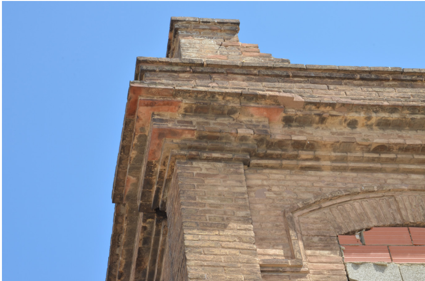
Imagen IX-72 y 73. Estación de Nazaret . Fragmento del cuerpo superior donde se aprecia el entablamento de remate. En la imagen inferior se observa con detalle la pilastra central. Fuente: Propia.
