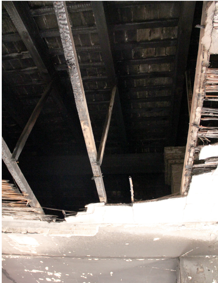
Imagen IX-130. Cubierta inclinada de la estación de Nazaret. Fuente: Singularq
