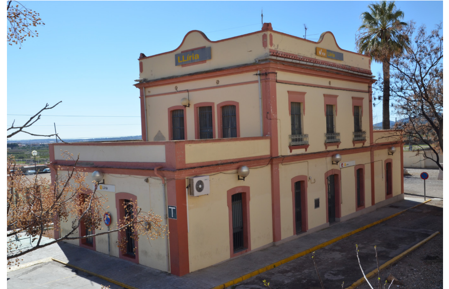
Imágenes IX-77, 78. Estación de Llíria . Fachada a calle. Fragmento del frontón con detalle de entablamento y pilastras. Fuente: Propia.
