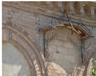
Imagen IX-90. Estación de Nazaret . Cerrajería de protección del reloj. Fuente: Propia.
