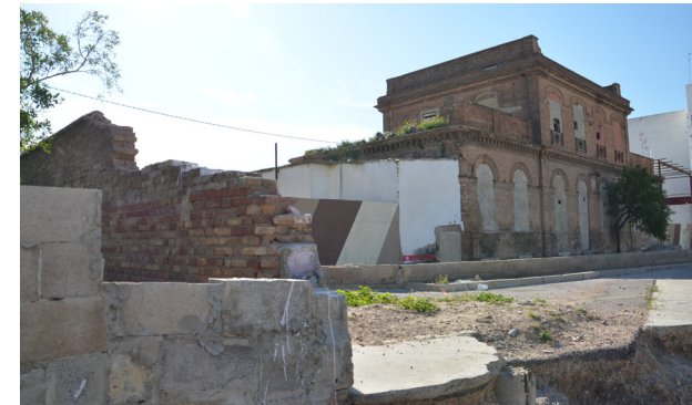
Imágenes IX-117 y 118. Muro de vallado, vista desde la calle Quatretonda y una visión más ampliada del muro. Fuente: Propia.
