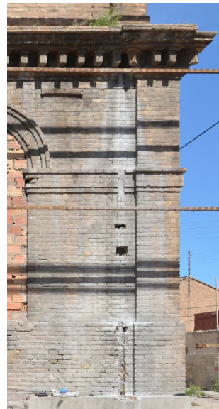
Imagen XI-10 y II. Desaparición de las bajantes de recogida del agua de lluvia, tanto de cubierta como de la terraza plana del piso superior. Testeros Norte y Sur. Fuente: Propia
