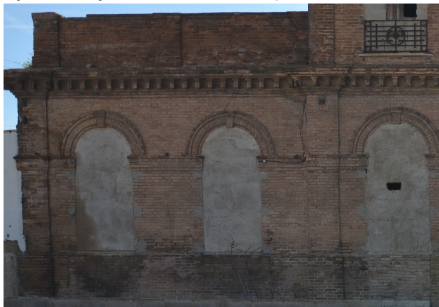
Imagen XI-II. Filtración del agua de lluvia. Fachada calle Cuatretonda. Fuente: Propia.
