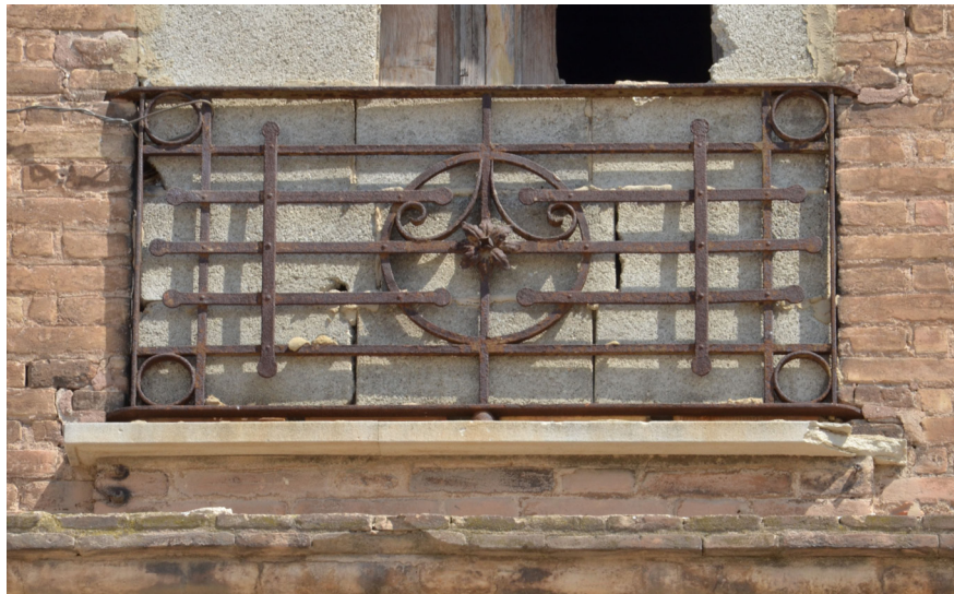
Imágenes XI-18. Baranda de la planta superior en la Fachada calle Cuatretonda, en la que se observa la oxidación y la rotura de la fábrica de ladrillo en su unión. Fuente: Propia
