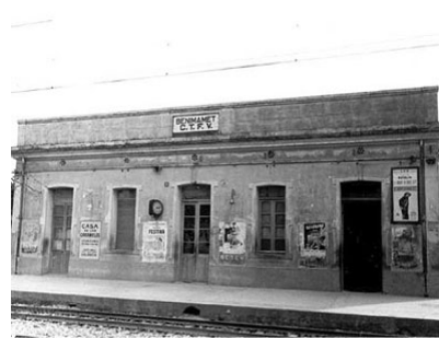
Compañía: S.V.T. Año. 1888-1890 Ingeniero: Alejandro Barber Categoría: Apeadero-3ª. Posición: Paralelo a vía
