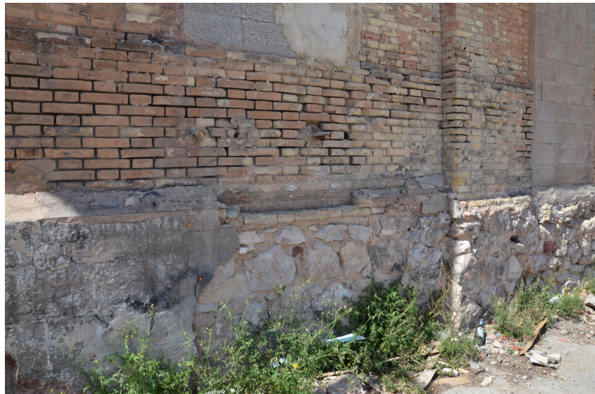
Imagen XI-9. Desprendimiento mortero de recubrimiento y de las juntas en la fábrica de mampostería ordinaria de cimentación en la Fachada Este (principal, c/ Mayor de Nazaret). Fuente: Propia
