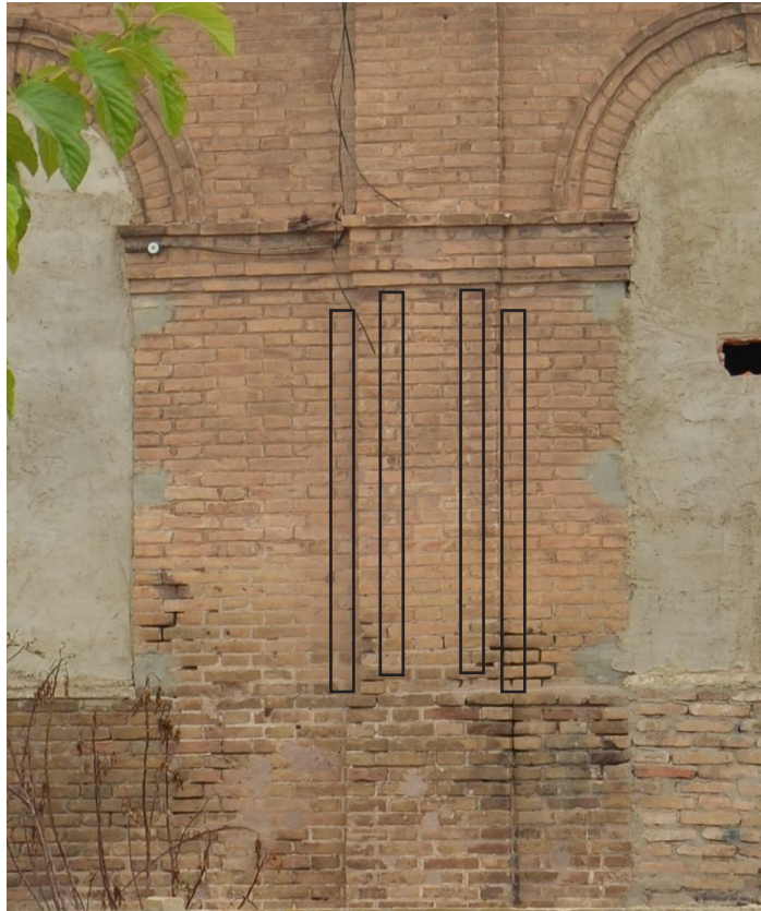
Imagen IX-52. De izquierda a derecha (estación de Nazaret): -Tramo de fachada de unión entre el cuerpo central y el lateral -Fragmento de fachada entre huecos -Zona de terminación de la estación (esquina). Se ha marcado en un rectángulo el ajuste que se ejecutó en la fábrica de ladrillo con el aparejo para ajustarse a la medida del paño.
