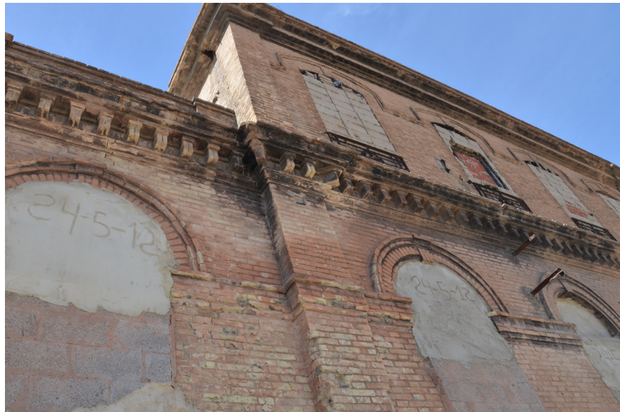
Imagen XI-6. Suciedad por contaminantes. Fachada Este (C/ Mayor de Nazaret). Fuente: Propia
