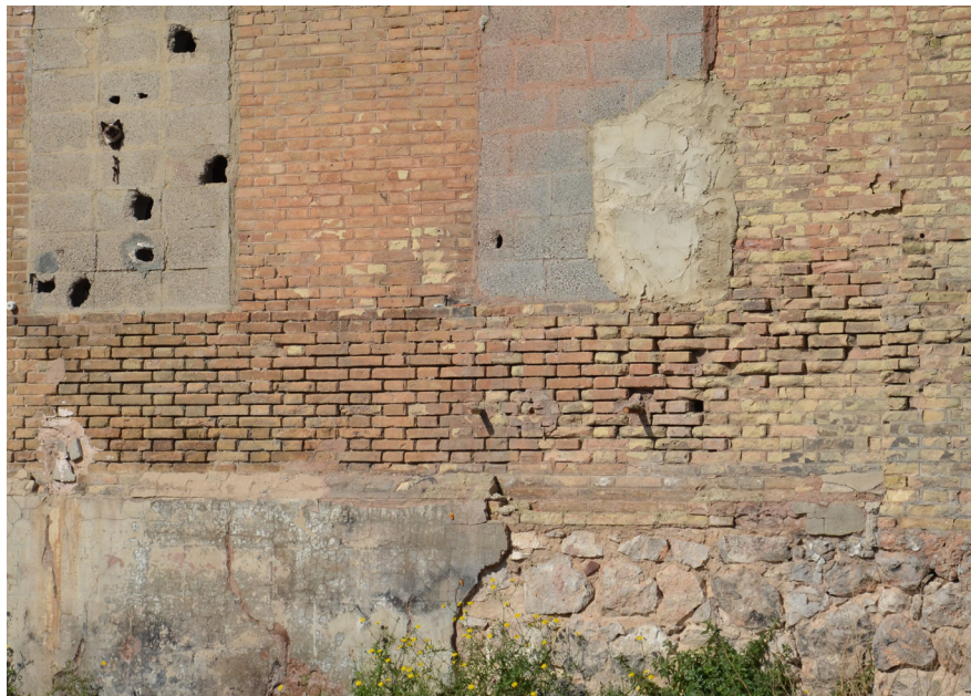
Imagen XI-12. Desperfectos en el ladrillo cerámico de la fábrica de las fachadas. Fachada Oeste (calle Mayor de Nazaret). Fuente: Propia
