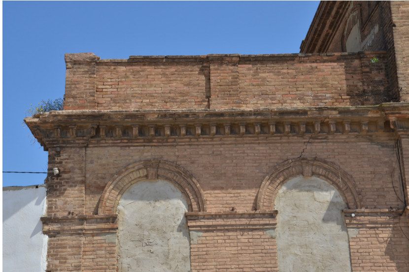
Imágenes XI-36 y XI-38. Fragmento de la fachada de la calle Cuatretonda. Fuente: Propia.
