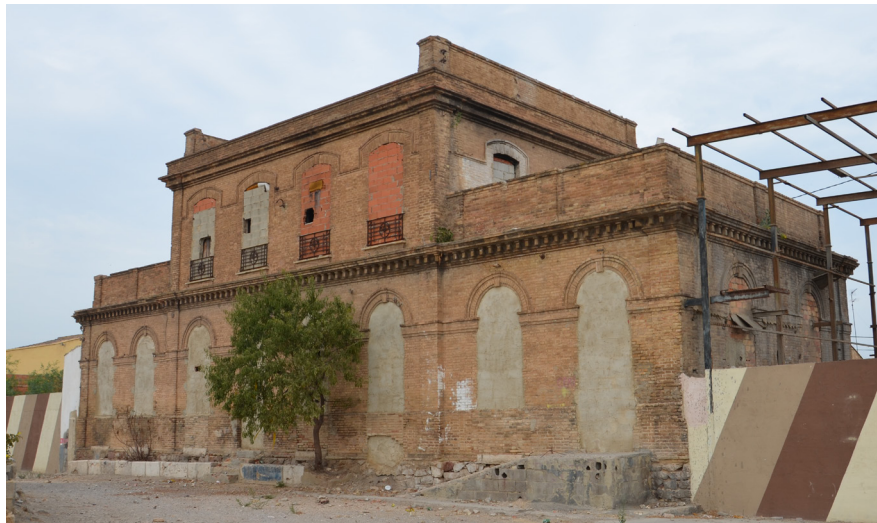
Imagen XI-3. Fachada Oeste (andén, c/ Cuatretoda). A la derecha de la fotografía, se observa la estructura metálica y el cerramiento de bloque en la fachada Sur. En la parte inferior se aprecia la jardinera, la rampa y los escalones de fachada, y el tapiado de los huecos en puertas y ventanas. En la parte izquierda del testero Norte se halla la edificación auxiliar. Fuente: Propia
