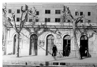
Compañía: S.V.T. Año: 27-IV-1893 Ingeniero: José Verdú. PEM: 7.681,36 Pts Categoría: 3ª. Posición: Paralelo a Vía
