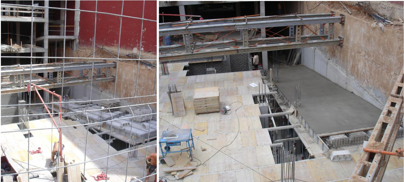
*Figura 221.- Imágenes del encofrado del primer forjado y del llenado de la rampa de sótano.*
