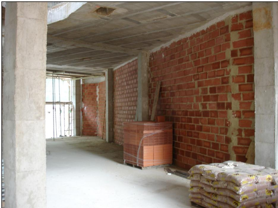
*Figura 251.- Imagen de una pared medianera entre la obra y una finca colindante.*
