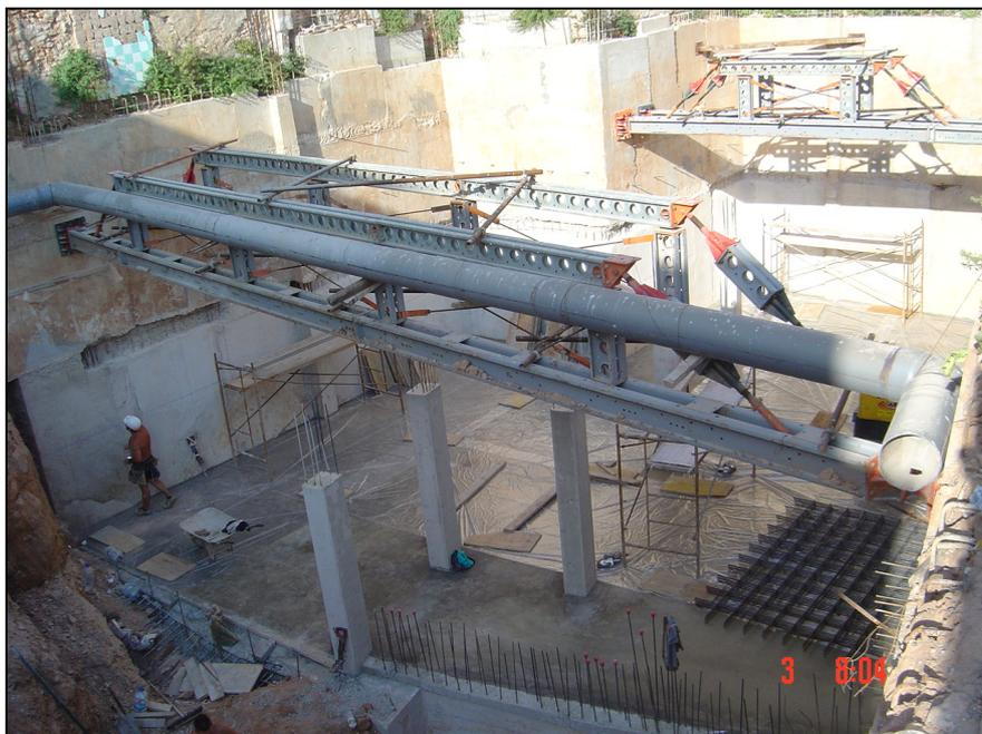
**Figura 131.- Pilares ya realizados y muros cajeadados. Se procede a encofrar y realizar el forjado.**
