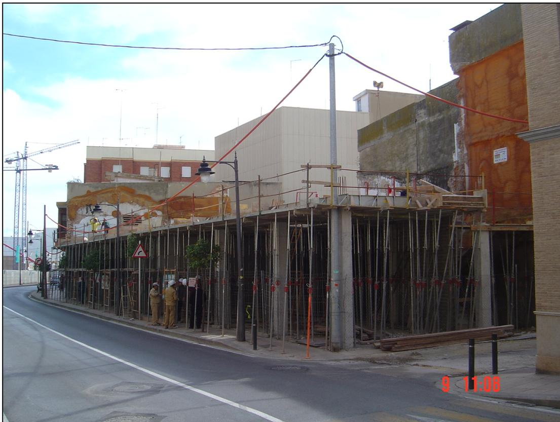
**Figura 233.- Vista anterior con el primer forjado encofrado y preparándose para su hormigonado.**
