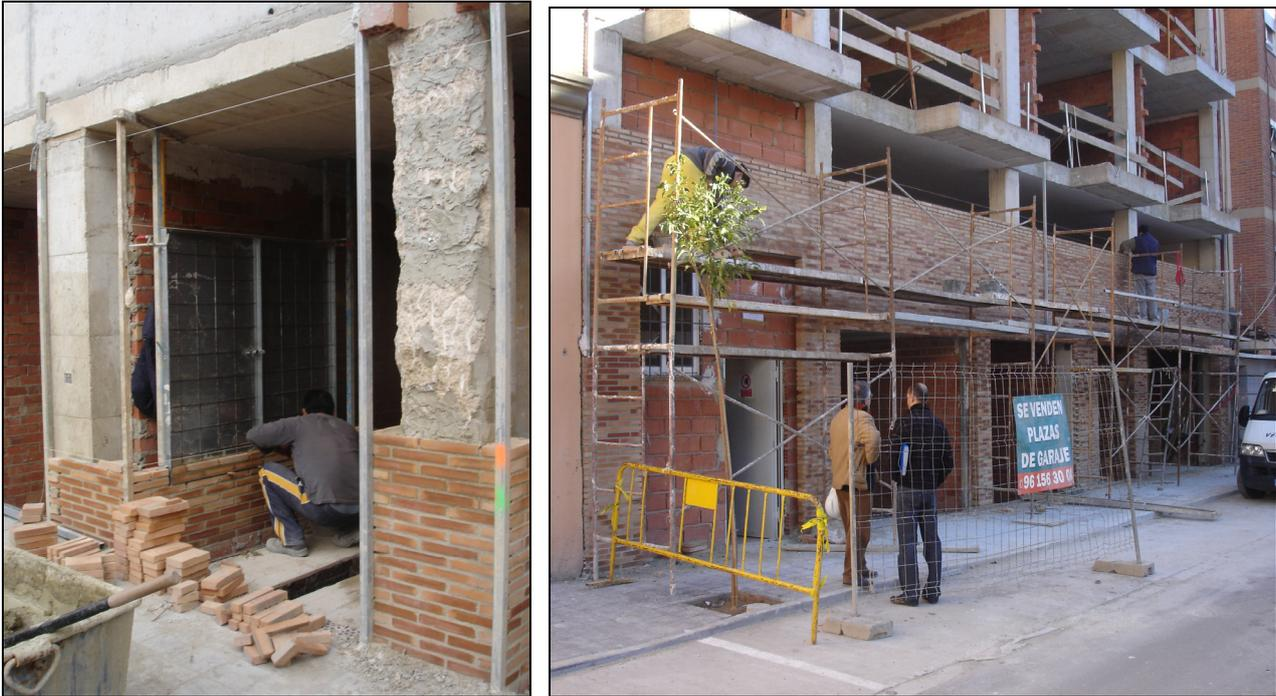
*Figura 265.- Imágenes del zaguán del edificio con la hornacina de la luz (C.G.P) y de toda la planta baja tabicada.*
