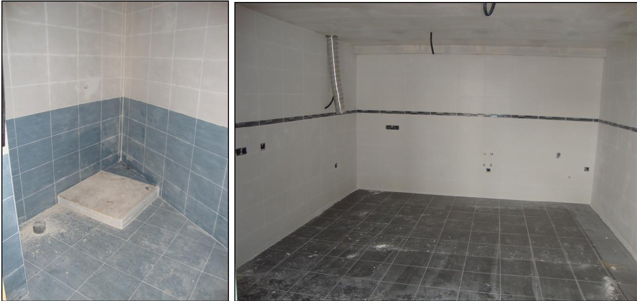
*Figura 284- Imágenes del solado de baños y cocinas y de la colocación de la escayola en los techos.*
