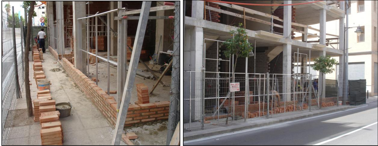
**Figura 259.- Imágenes del replanteo de la fachada principal de la fase A.**
