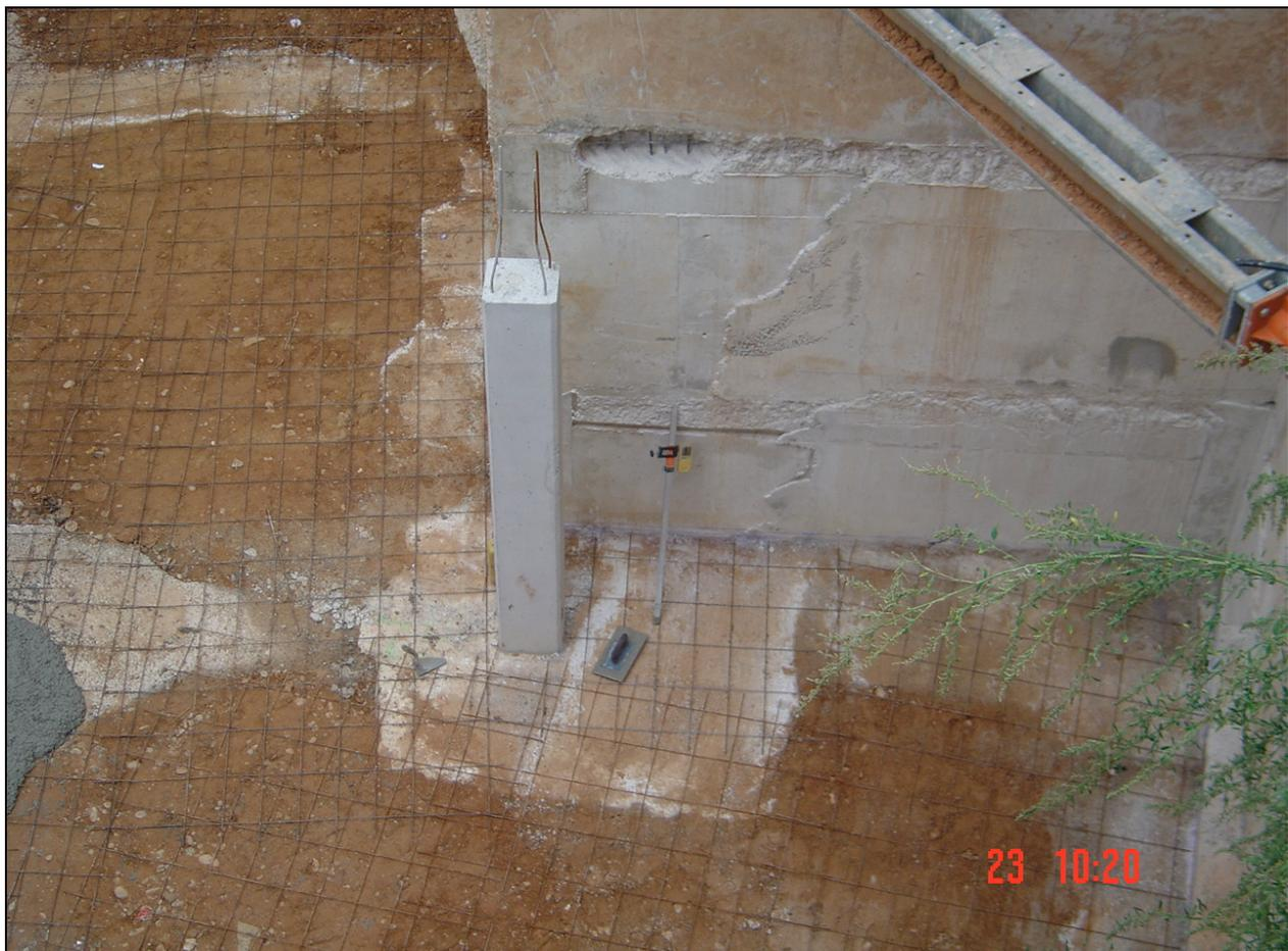
*Figura 190.- Imágenes de las zapatas y riostras hormigonadas y de la realización de los pilares.*
