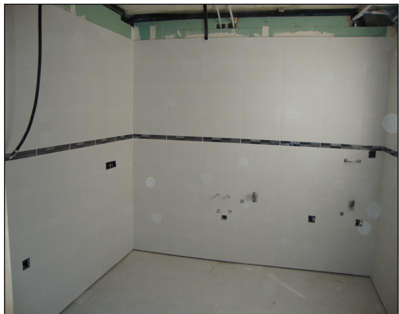
*Figura 281.- Imágenes del baño y la cocina alicatados de una de las viviendas del edificio.*
