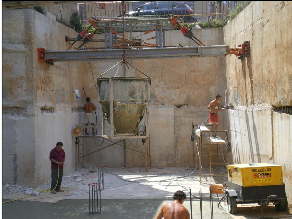
**Figura 130.- Operarios realizando el cajeadado en el muro del segundo anillo de sótano para recibir el forjado.**
