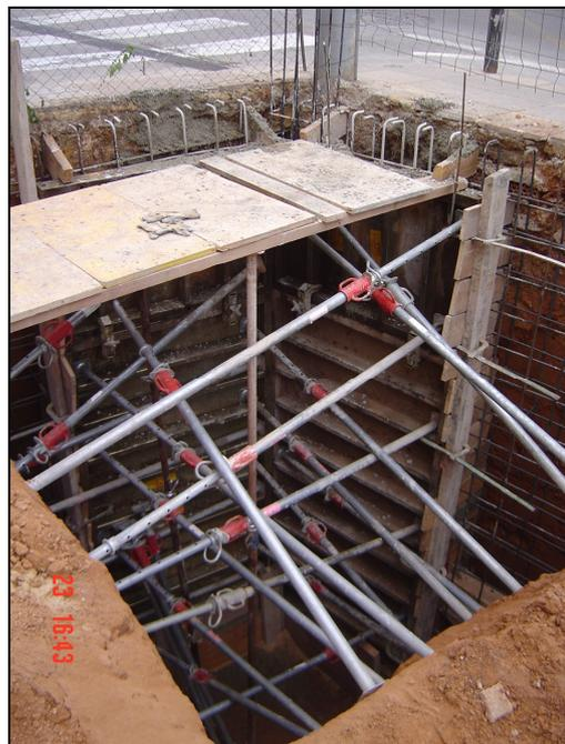
*Figura 30.- Imagen de la excavación y del muro hormigonado pendiente de desencofrar.*
