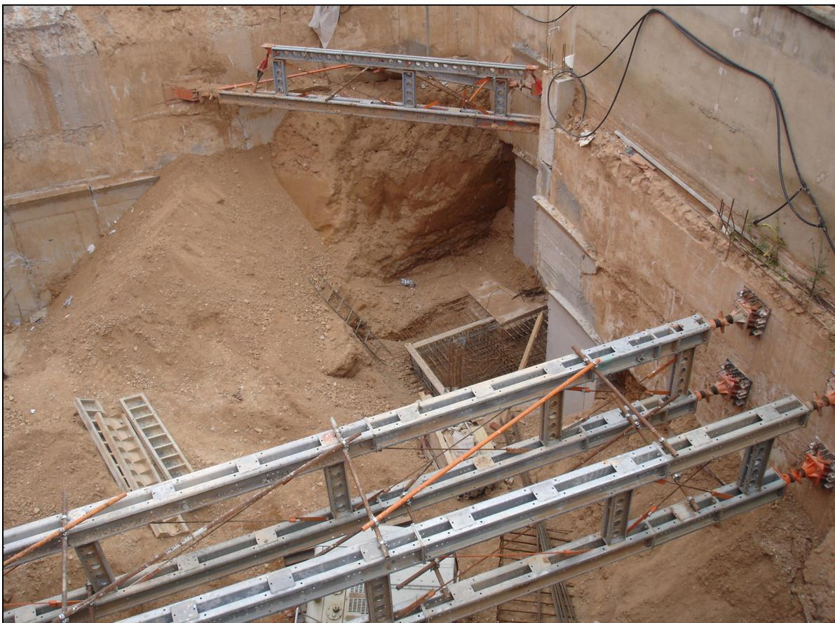
*Figura 213.- Imágenes aéreas de cómo se están ejecutando los muros y del dificultoso trabajo debido a los codales.*
