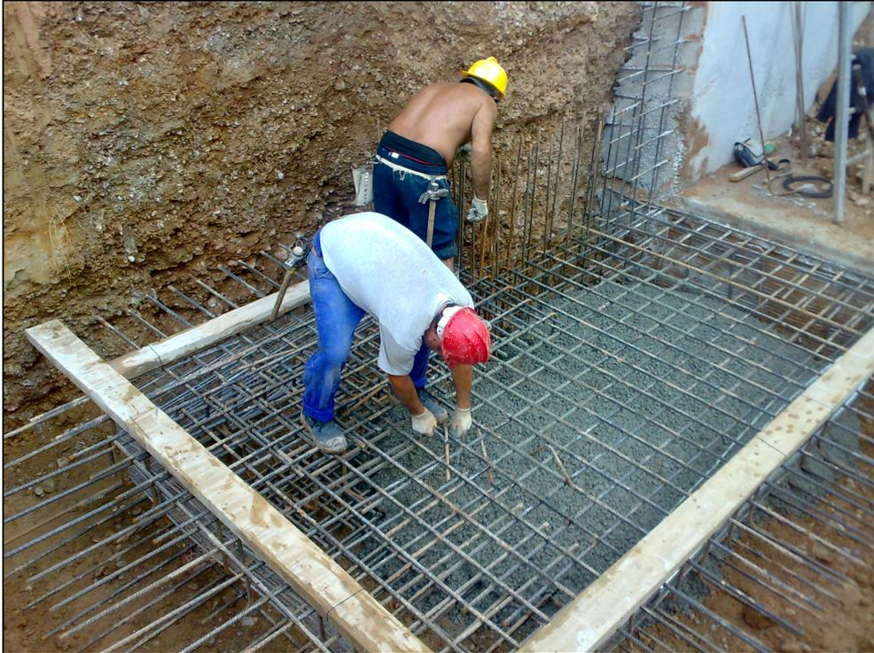
*Figura 126.- Realización de la parte de losa necesaria para poder realizar el muro del segundo anillo de sótano.*
