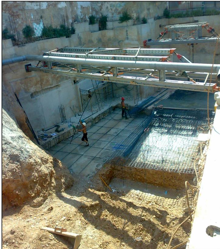
*Figura 128.- Vista de la losa de la zona 1 con el hormigón de limpieza ya vertido, donde se aprecia el replanteo del armado, y en especial de la situación de los pilares.*
