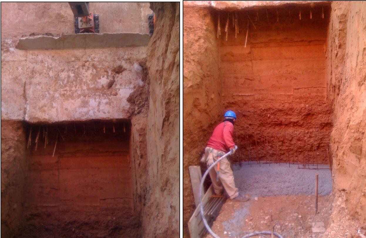
*Figura 203.- Imágenes de un batache de muro preparándose para realizar la zapata corrida bajo el mismo.*
