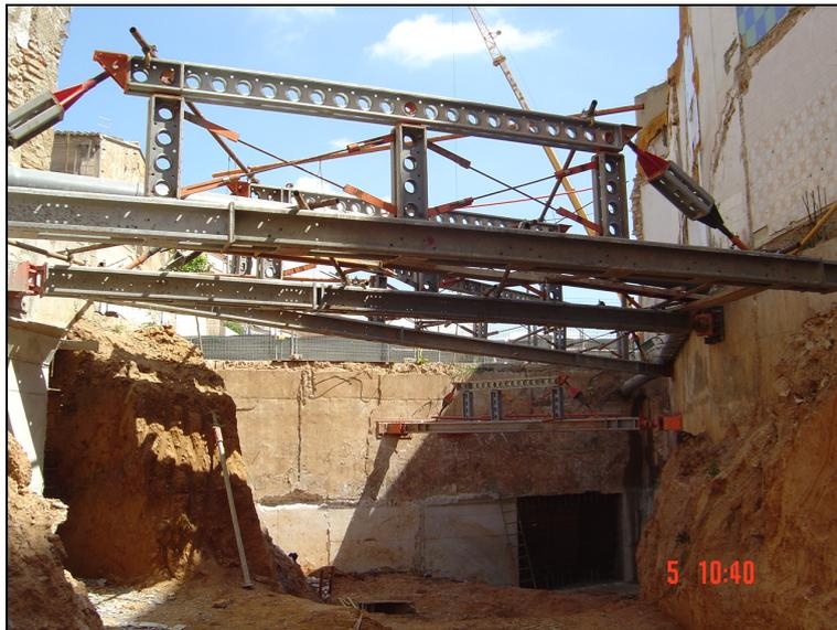
**Figura 134.- Imagen del segundo anillo de muro de sótano en la zona 2, donde se pueden ver muros ya realizados con los que aún faltaban por hacer.**
