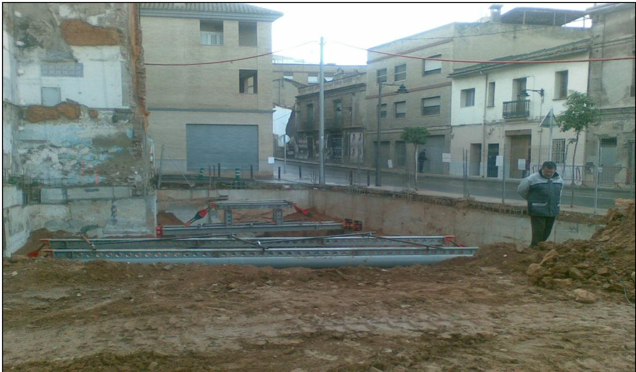
*Figura 50. - Vista de la excavación, preparada para comenzar los nuevos bataches.*
