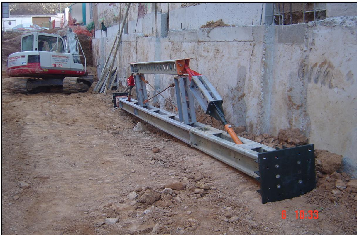
*Figura 47.- Codal montado y preparado para su colocación de muro a muro mediante las placas de anclaje y tornillos Hilti especiales, de gran resistencia.*
