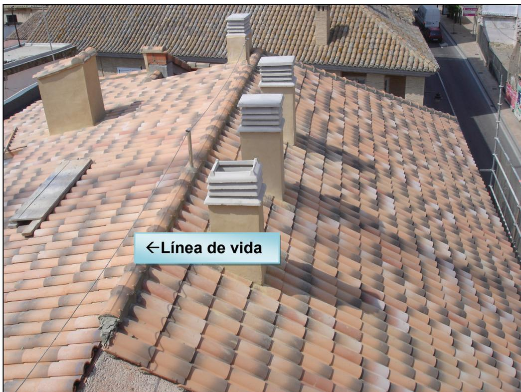
*Figura 269.- Imagen del tejado prácticamente terminado donde se aprecia la preceptiva colocación de una línea de vida.*
