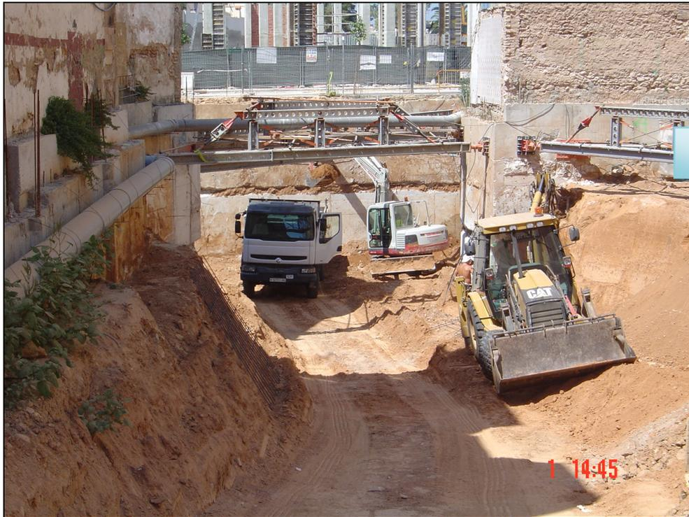
Figura 186.- Vista de la fase B donde se ve un codal colocado en la esquina con anterioridad.
