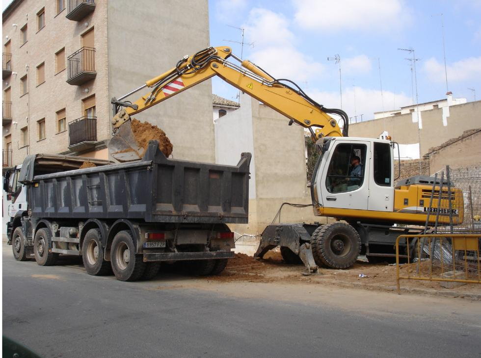
*Figura 211.- Imagen de la máquina giratoria situada en la fachada cargando la tierra en el camión.*
