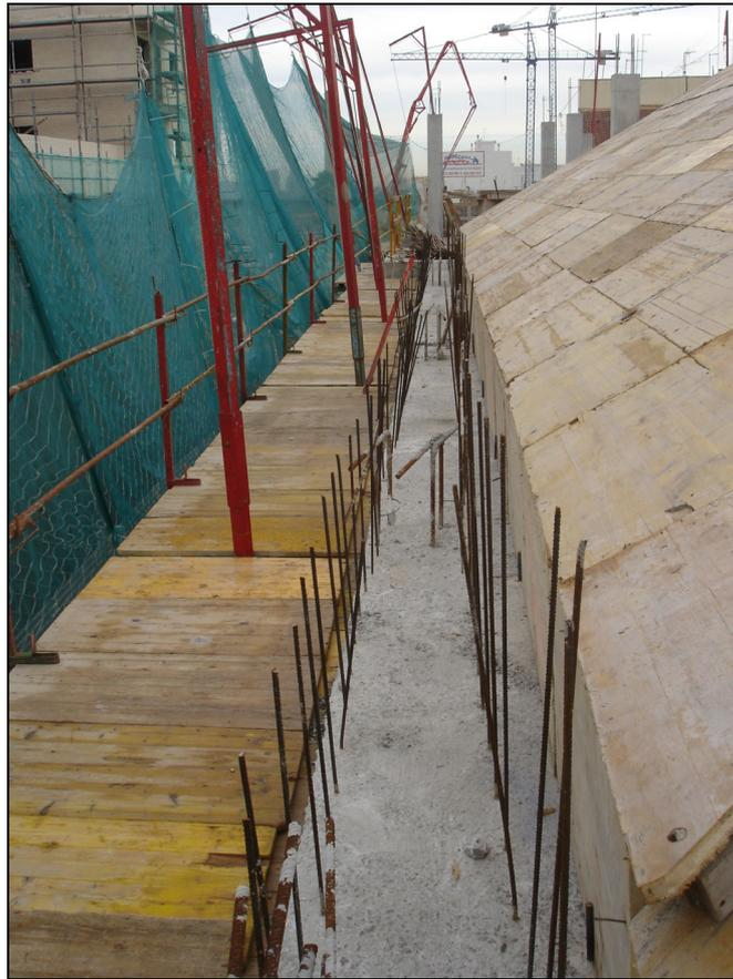
**Figura 236.- Imagen del forjado inclinado de los duplex y al fondo los pilares de la otra parte de la fase A para continuar con los forjados hasta llegar al último para la cubierta plana.**
