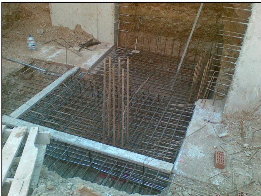
*Figura 212.- Imagen de la losa necesaria para ejecutar el muro y el pilar cercano.*
