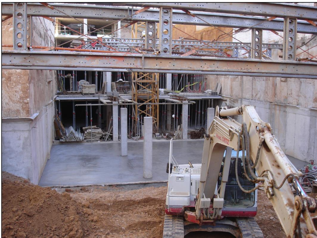
*Figura 204.- Imagen de la solera con los pilares ya realizados, listos para poder encofrar el forjado.*
