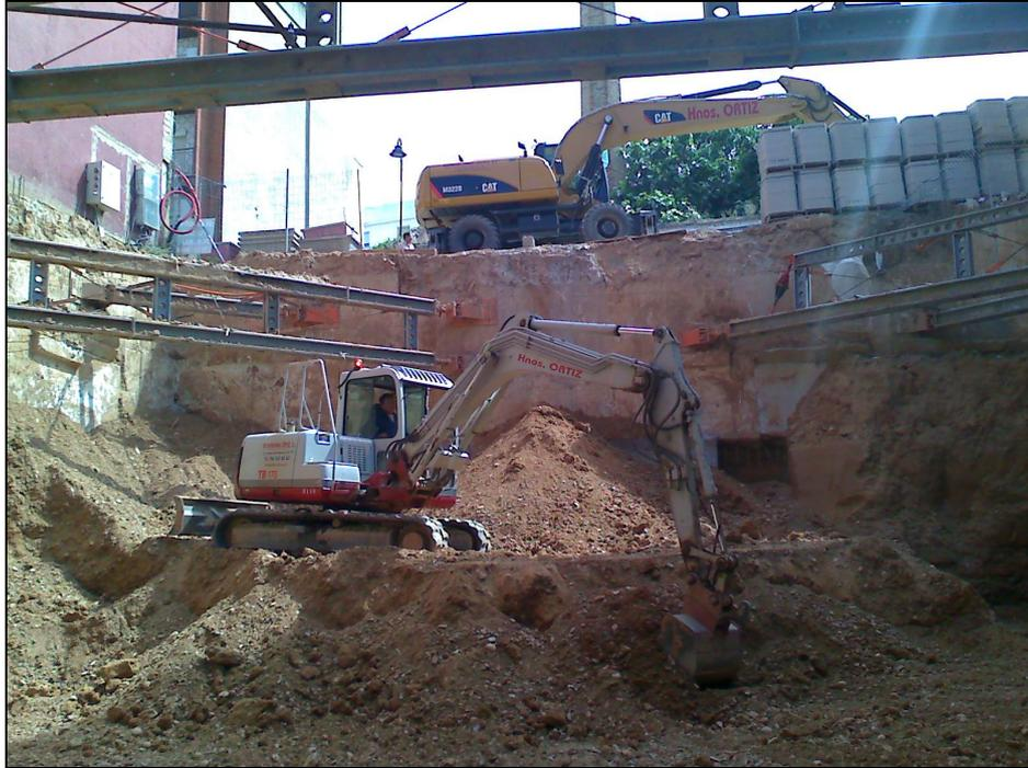
*Figura 214.- imagen de cómo la máquina realiza el vaciado del terreno para la losa.*
