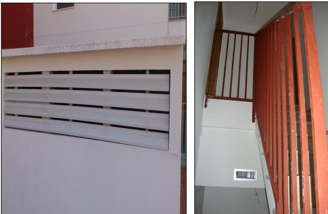
*Figura 283- Imágenes de rejillas de ventilación y de barandillas de escalera.*
