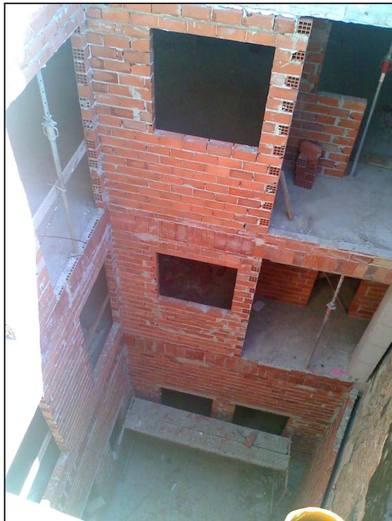
*Figura 253.- Imagen del patio de luces anterior totalmente tabicado hasta la cubierta inclinada.*
