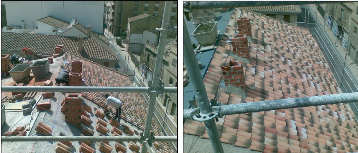
*Figura 268.- Imágenes del replanteo del tejado y de las chimeneas de ladrillo para los shunts de ventilación.*
