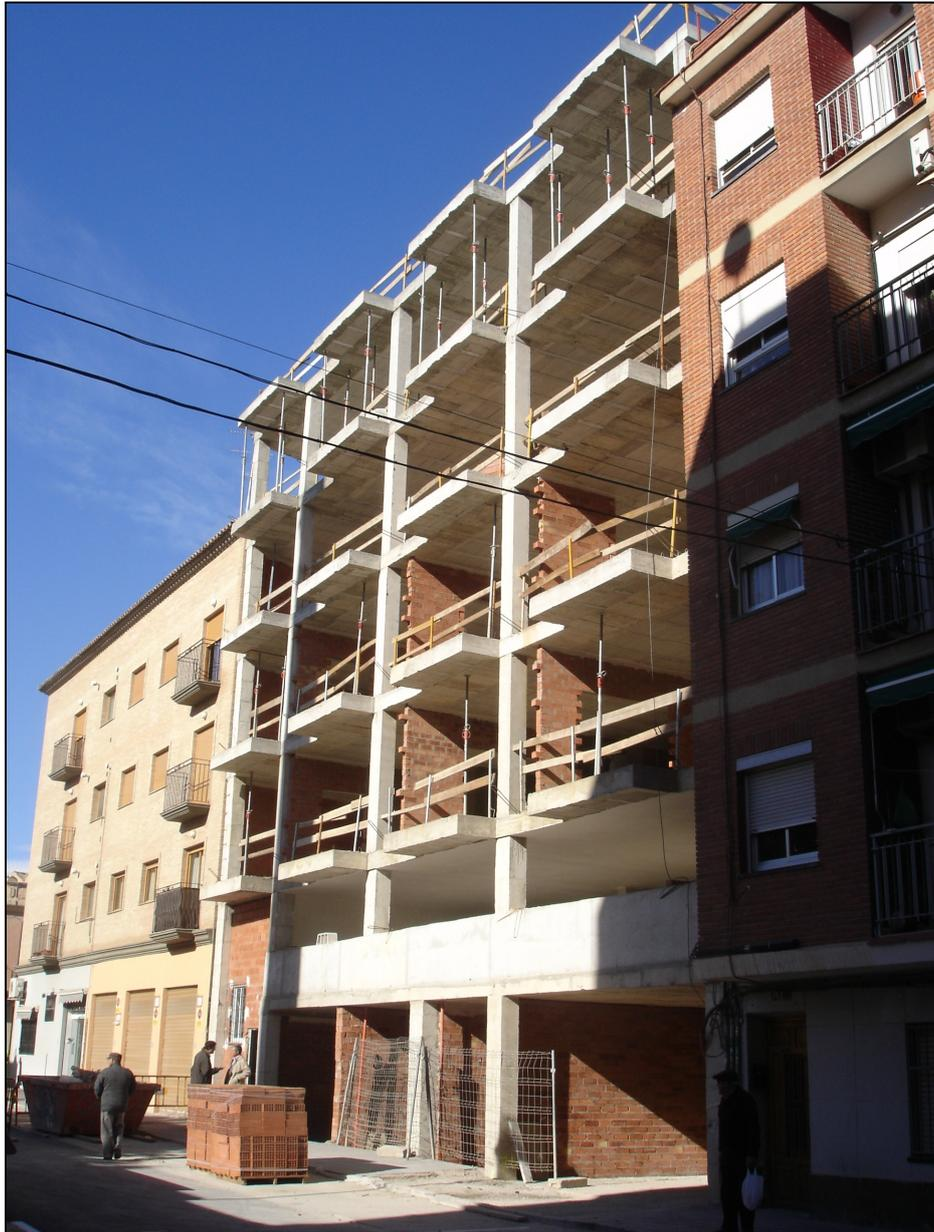
**Figura 246.- Imagen de la estructura de la fase B terminada, la planta baja, el altillo y las 4 plantas de viviendas.**
