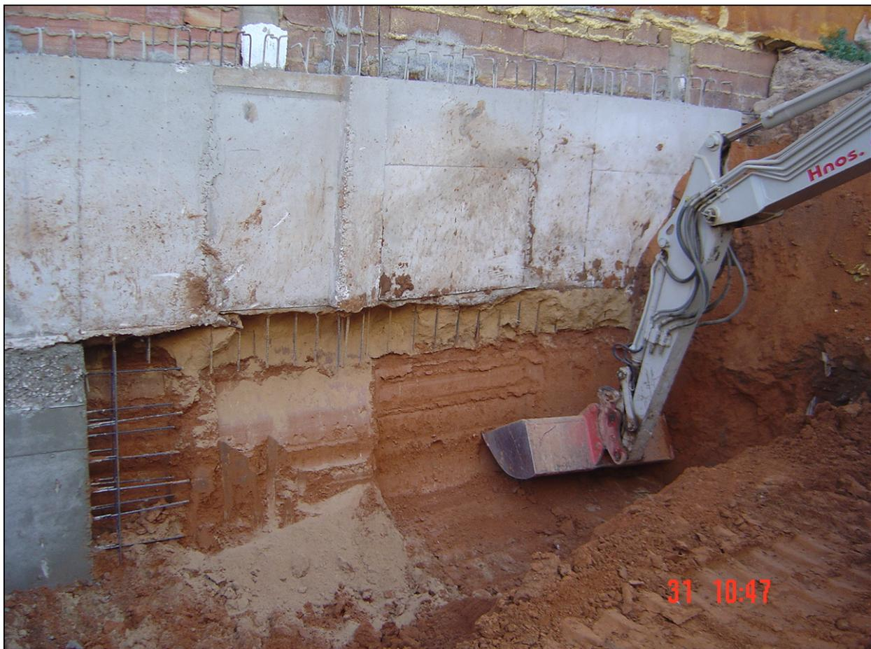
**Figura 35. - Muro a cota -2m preparándose para completar hasta su cota retirándose la arena y haciendo el corte del terreno hasta su cota.**
