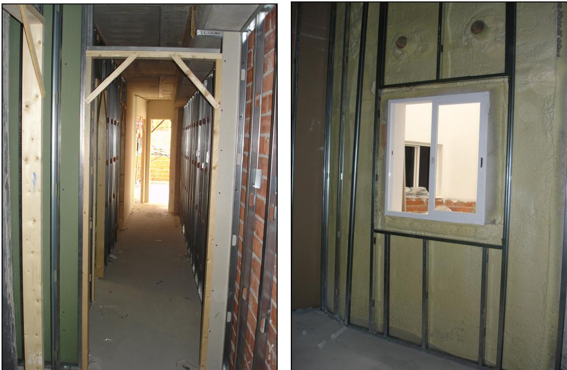
*Figura 277.- Imágenes de la perfilaría de aluminio de los tabiques de pladur y de los trasdosados de fachadas.*
