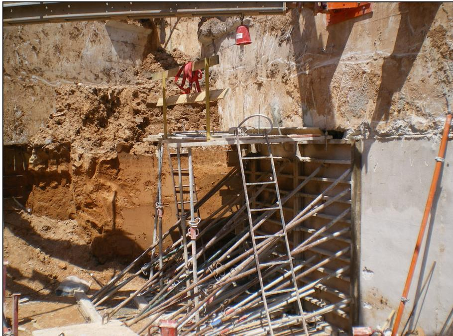
*Figura 127.- Muro de segundo anillo de sótano preparado para ser hormigonado.*
