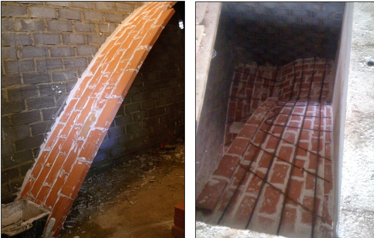
*Figura 249.- Imágenes de cómo se realiza la bóveda con ladrillo cerámico hueco de 4x12x24 y reforzada con un ligero armado de acero corrugado.*
