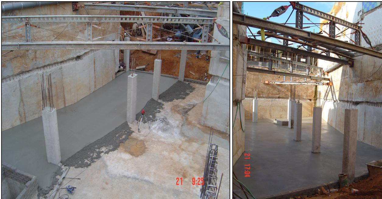
*Figura 136.- Imagen de la losa de la zona 2 aplicándole una capa de hormigón fratasado de 10cm de espesor para su acabado y otra donde se puede apreciar el resultado final.*
