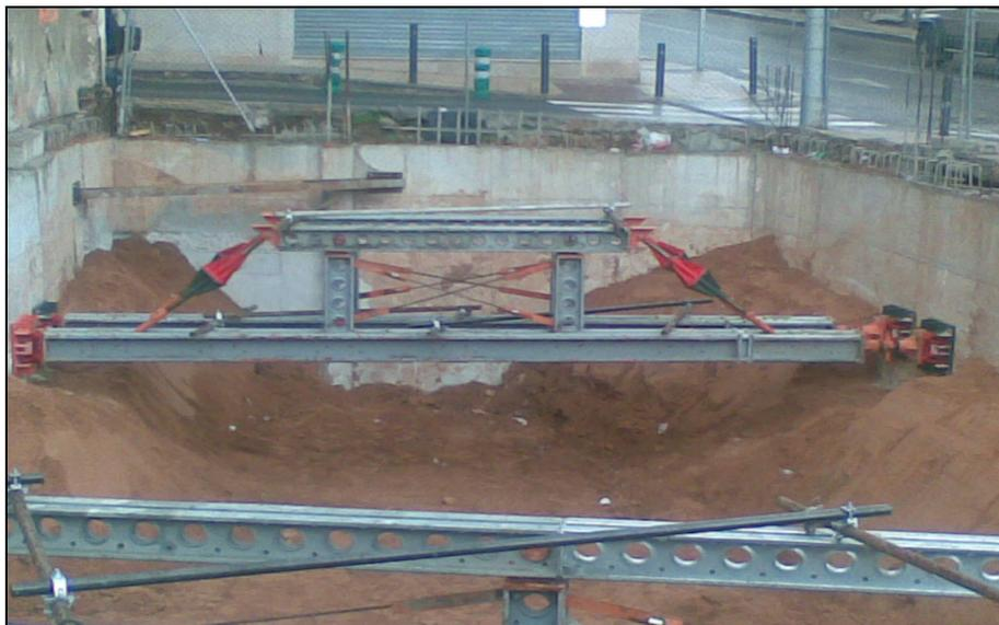
Figura 48.- Primeros acodamientos de fase A colocados en el primer anillo del sótano.
