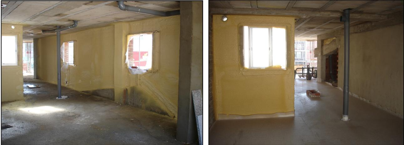
*Figura 276.- Imágenes de la pared de la fachada y de la pared del patio de luces con el poliuretano proyectado.*
