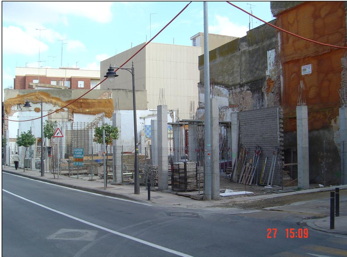
**Figura 232.- Vista de la fase A con los pilares de planta baja hormigonados.**
