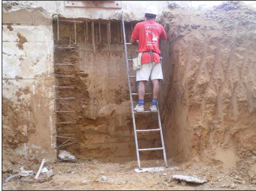
*Figura 53.- Imagen de un batache donde se aprecia la parte de cimentación excavada, en este caso de losa para posterior apoyo del muro de sótano.*
