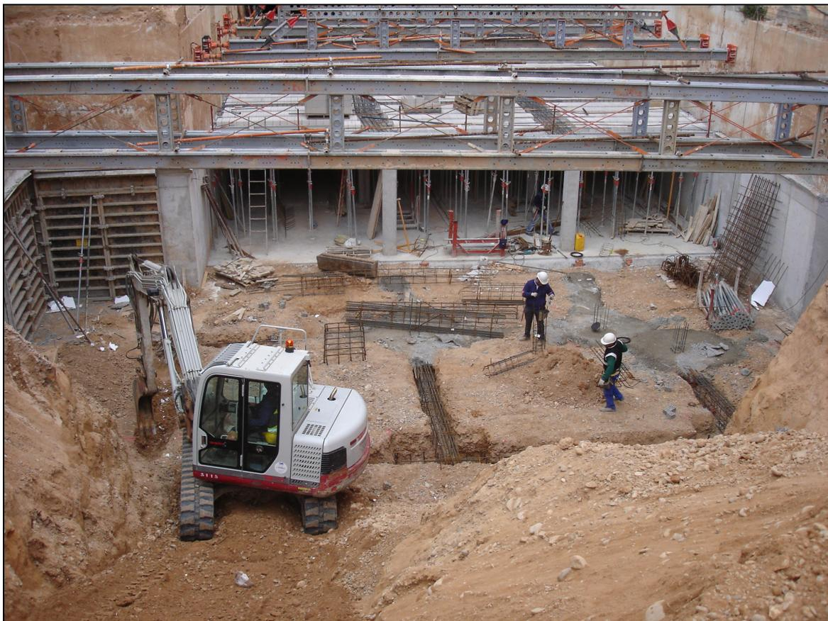
*Figura 205.- Imagen donde se aprecian todos los pasos que se llevan a cabo, la cimentación, los pilares, los muros y el forjado preparándose para el hormigonado.*
