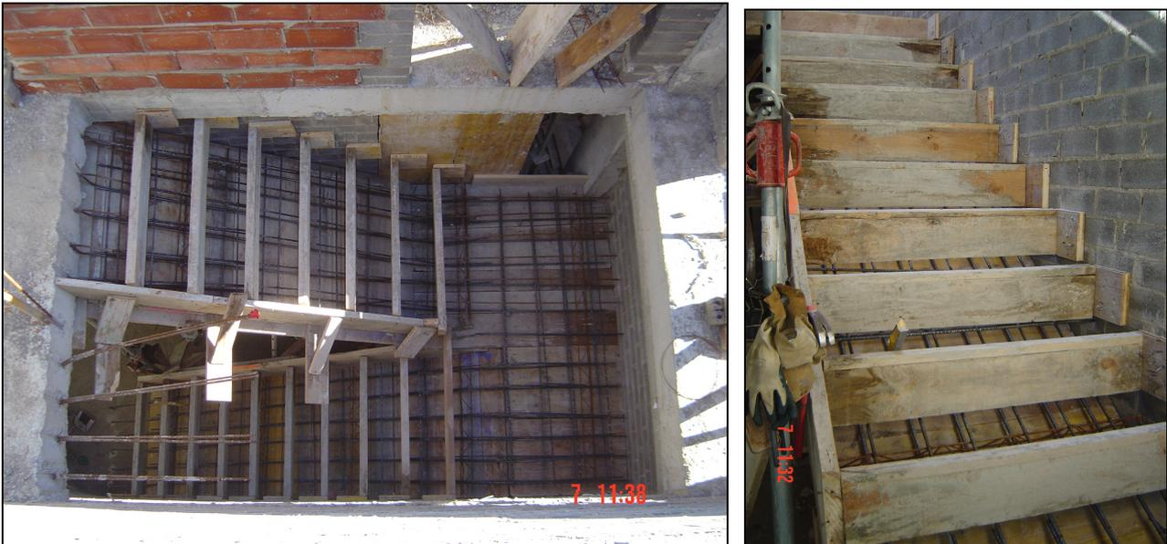
*Figura 248.- Imágenes de las escaleras generales del edificio realizadas con hormigón armado.*
