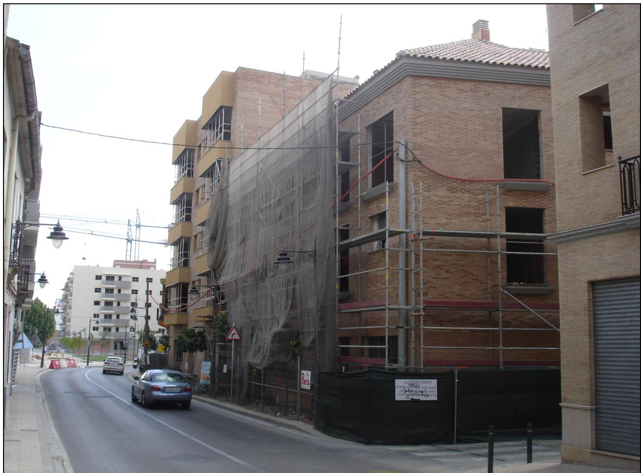
**Figura 260.- Imagen de la fachada principal tabicada y con los premarcos colocados de los ventanales y miradores.**
