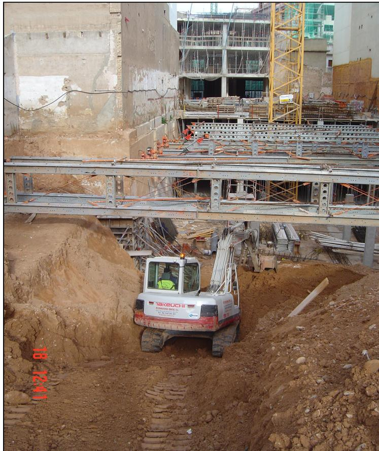
**Figura 201.- Imagen de lo difícil que resulta la excavación con los codales colocados.**
