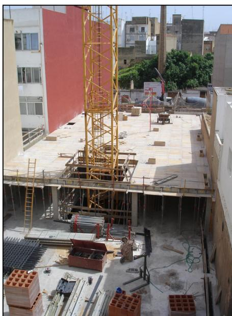
*Figura 241.- Imagen del forjado 3º ya realizado y del forjado 4º encofrándose parcialmente.*
