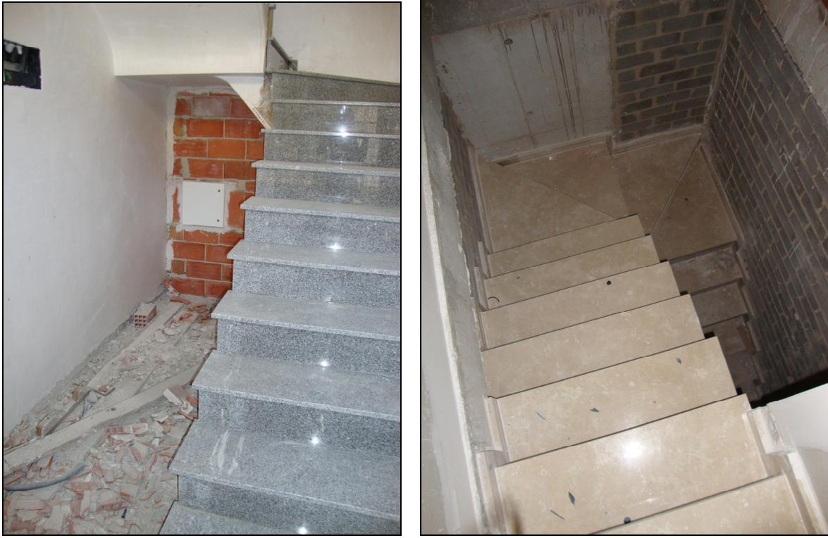
*Figura 282- Imágenes de la colocación del mármol en escaleras generales del edificio.*
