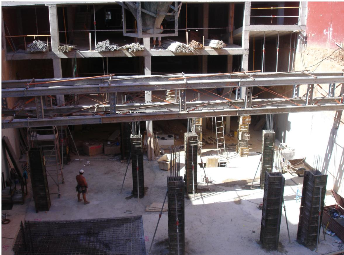
*Figura 220.- Imagen de la realización de los pilares para el primer forjado.*
