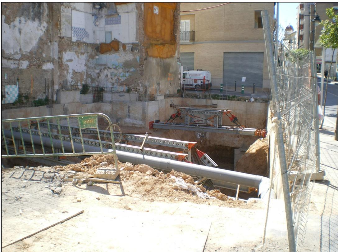
**Figura 52.- Vista de los bataches del segundo anillo de sótano situados bajo los codales y el primer anillo.**
