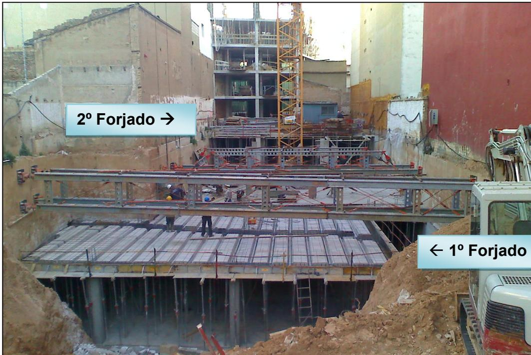
*Figura 228.- Vista donde se aprecia la realización del forjado 1º y 2º forjado a la vez.*
