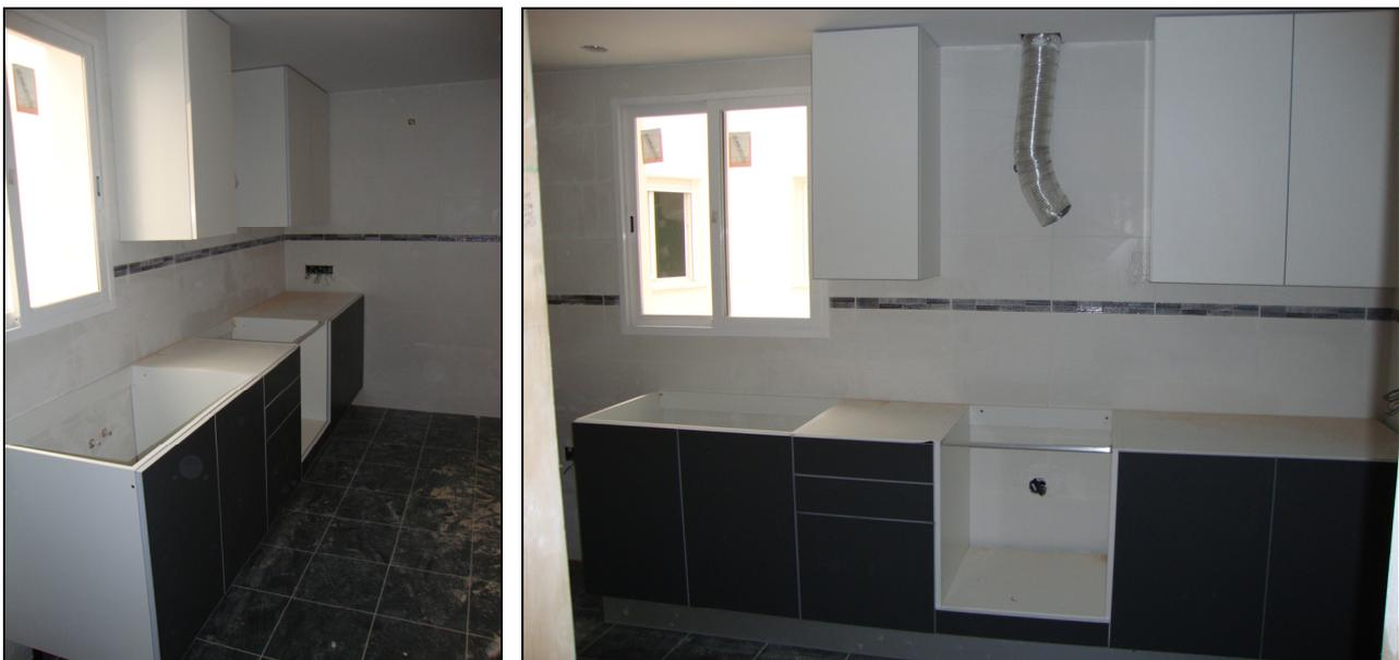
*Figura 285- Muebles de la cocina montados y listos para colocar el mármol sobre ellos.*
