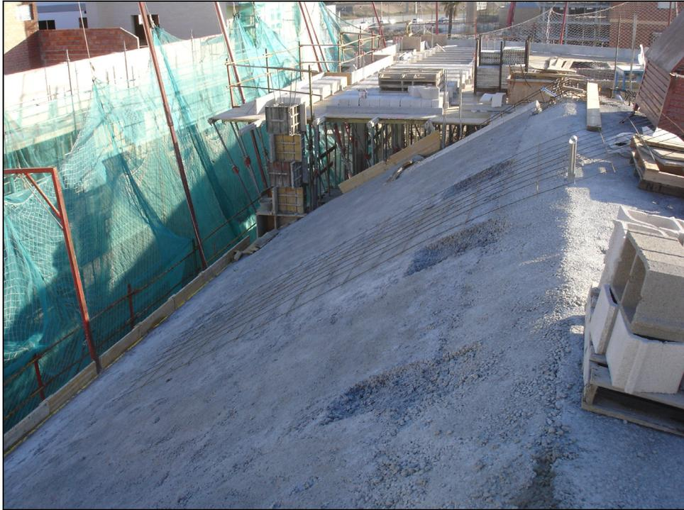
*Figura 238.- Imagen del forjado inclinado y del plano, pertenecientes a la misma planta pero diferente zona de fase A.*
