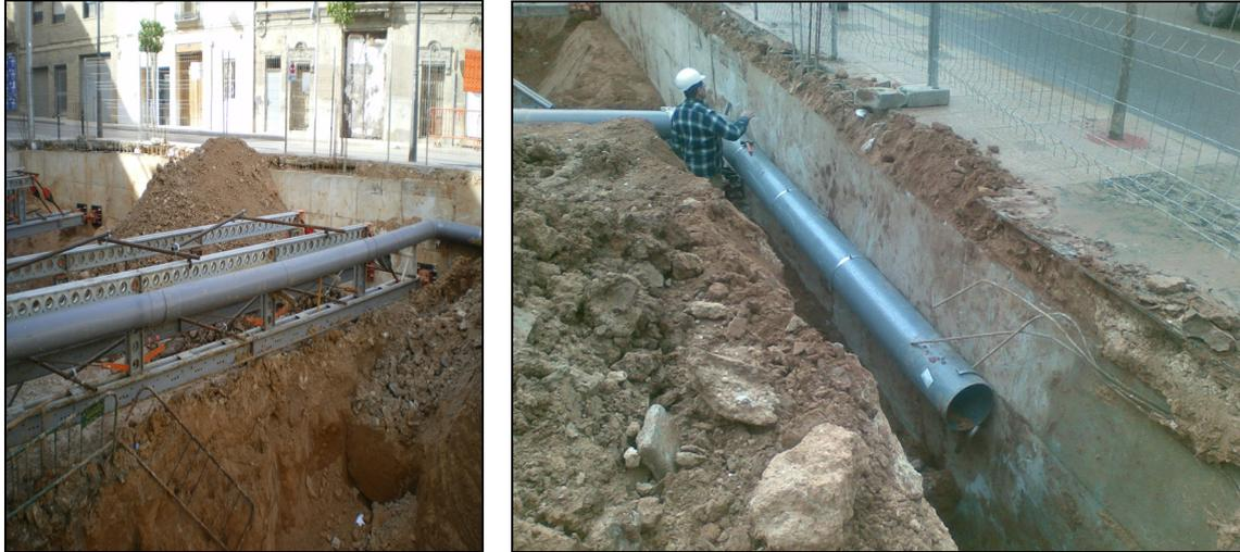
*Figura 49.- Colocación de la tubería de pvc en sustitución de la antigua acequia.*
