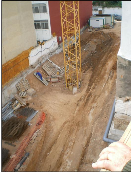
*Figura 185.- Imagen de la fase B con los muros de 2 metros realizados en todo el perímetro.*
