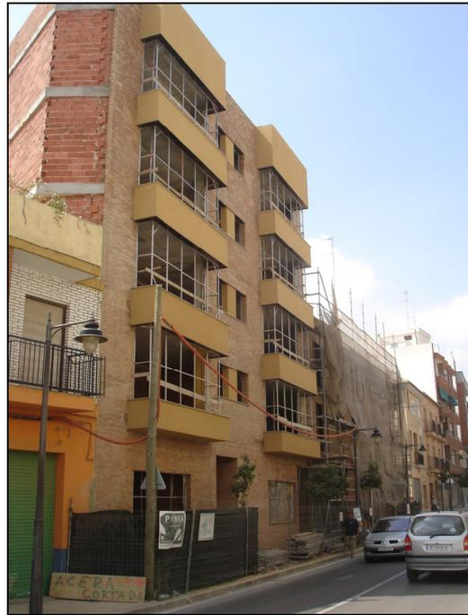
*Figura 261.- Imagen de la zona de viviendas con los miradores realizados con ladrillo ordinario y mortero monocapa.*
