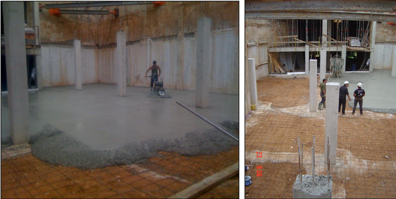
*Figura 191.- Imágenes de la realización de la solera fratasada una vez ejecutados los pilares.*
