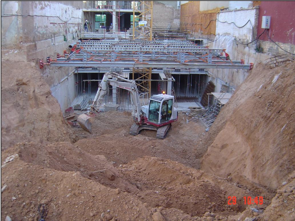
*Figura 197.- Imagen de la máquina excavadora minigradora retirando la tierra sobrante.*
