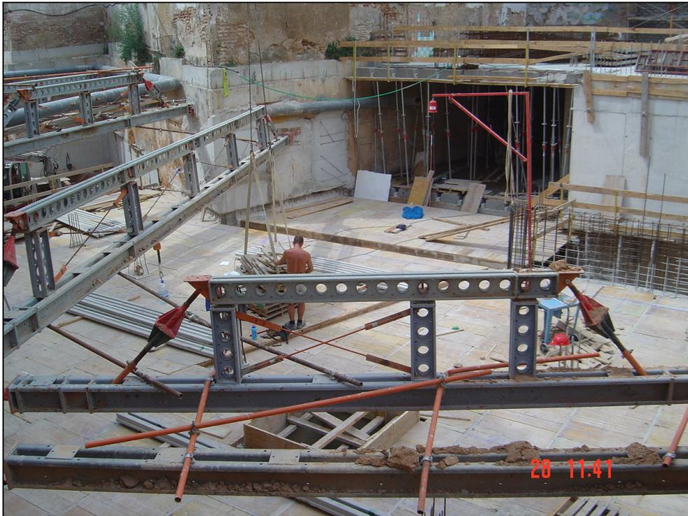
**Figura 226.- Imagen del forjado ya hormigonado y del encofrado de la otra parte del primero de fase A.**
