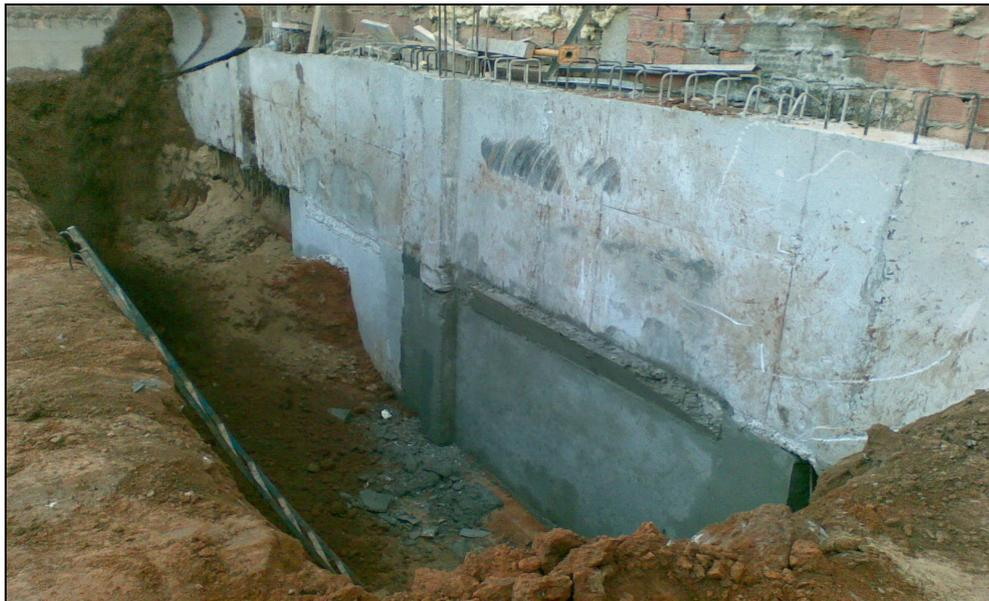
*Figura 36.- Muro hormigonado hasta su cota en la parte inferior están dejadas las esperas recubiertas de arena suelta para su posterior retirada con facilidad.*
