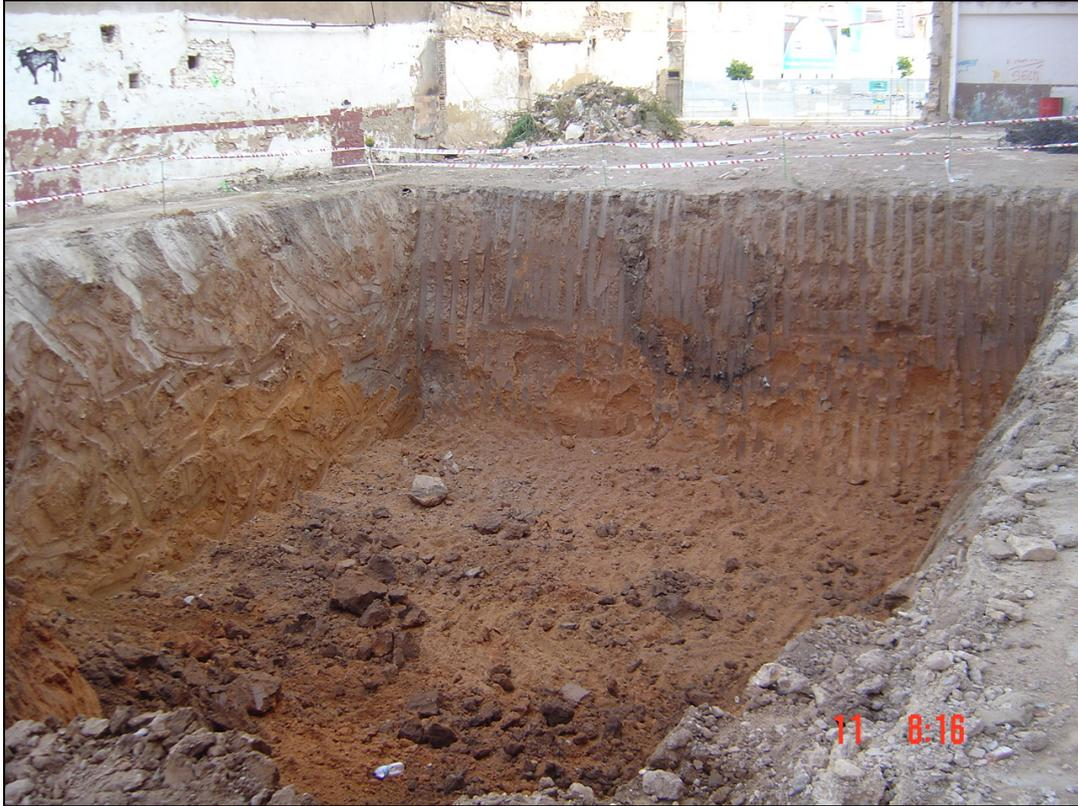
*Figura 23.- Vaciado para la colocación de la grúa –torre a la cota prevista.*
