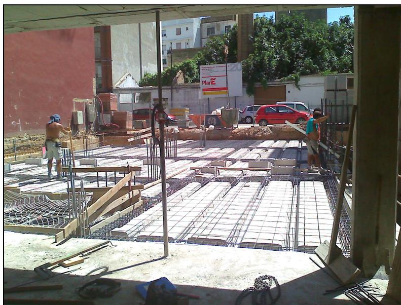
*Figura 229.- Imagen del segundo forjado de fase B listo para su hormigonado.*
