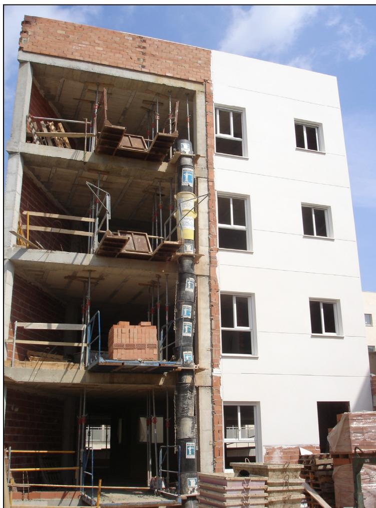
*Figura 258.- Imagen de la fachada interior realizada parcialmente para poder entrar el material a planta.*
