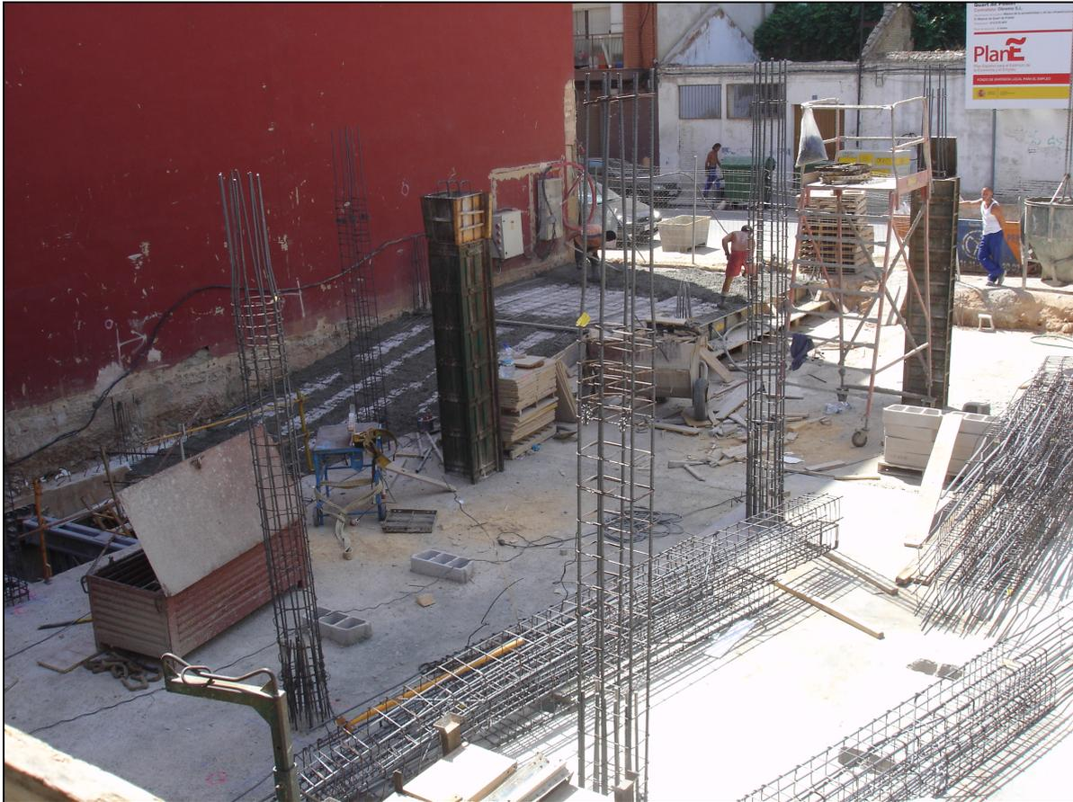
**Figura 230.- Imagen del llenado del último tramo del forjado segundo de fase B, la rampa de acceso al garaje.**
