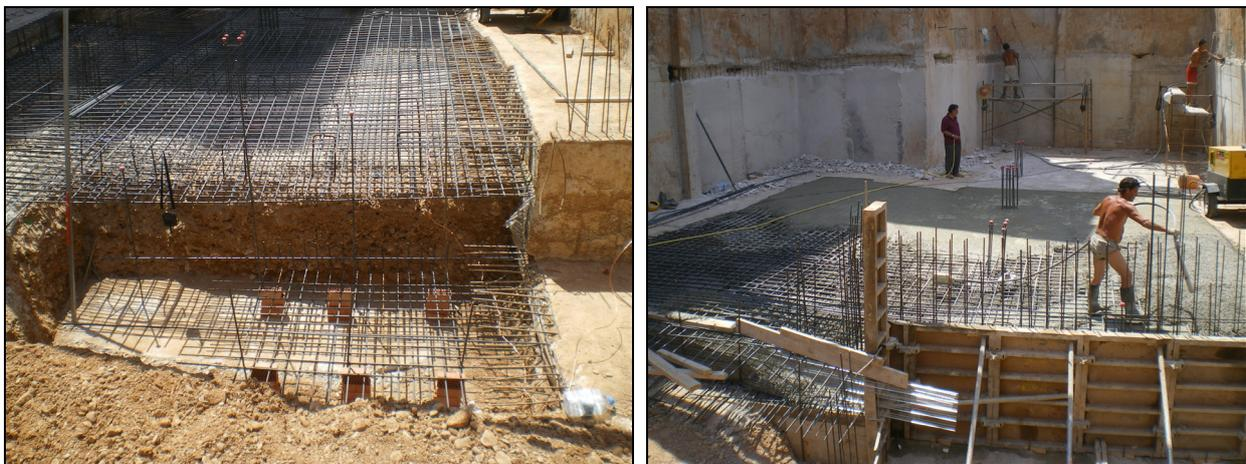
*Figura 129.- Losa de la zona 1 casi preparada para ser hormigonada y hormigonado de la misma.*
