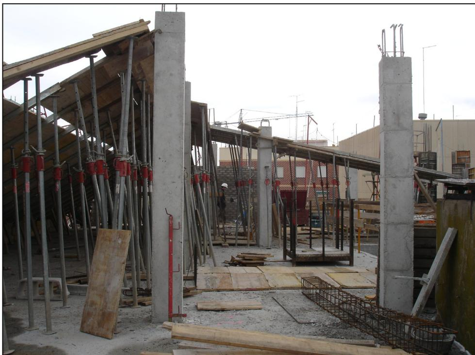
**Figura 237.- Imagen del encofrado del forjado inclinado de fase A.**
