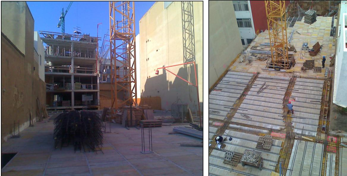
*Figura 240.- Imágenes de la fase central con una parte del forjado 3º encofrándose.*
