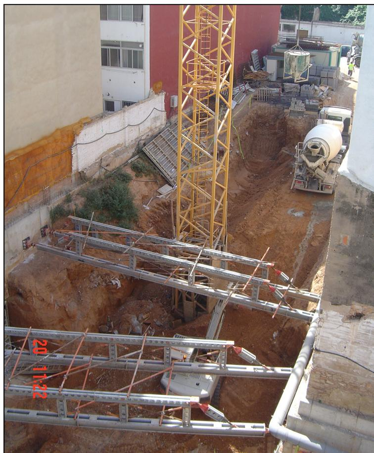
**Figura 188.- Imágenes de los nuevos codales colocados en la fase B.**
