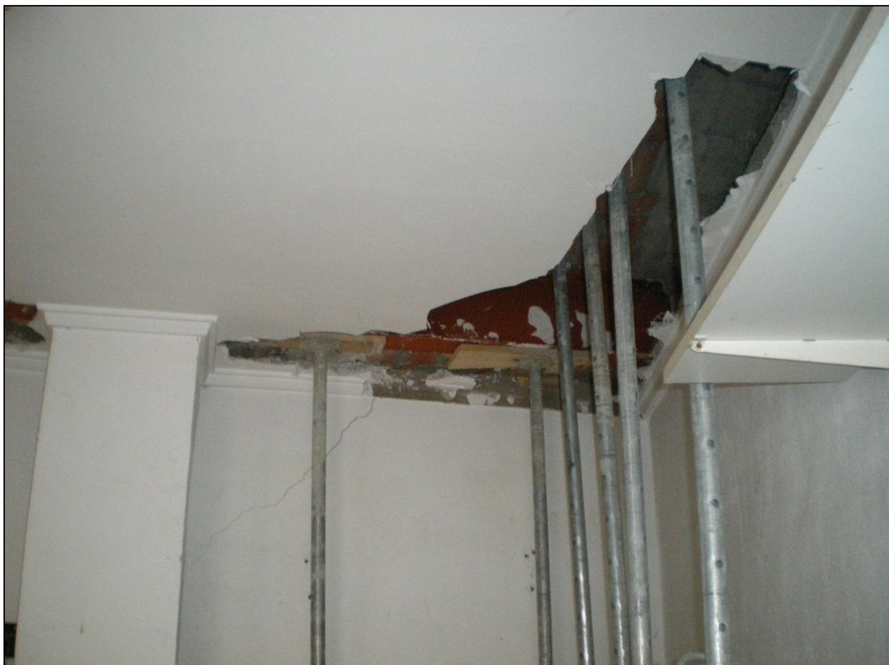
*Figura 72.- Apuntalamiento del forjado para repartir la carga y liberar de peso las zapatas.*
