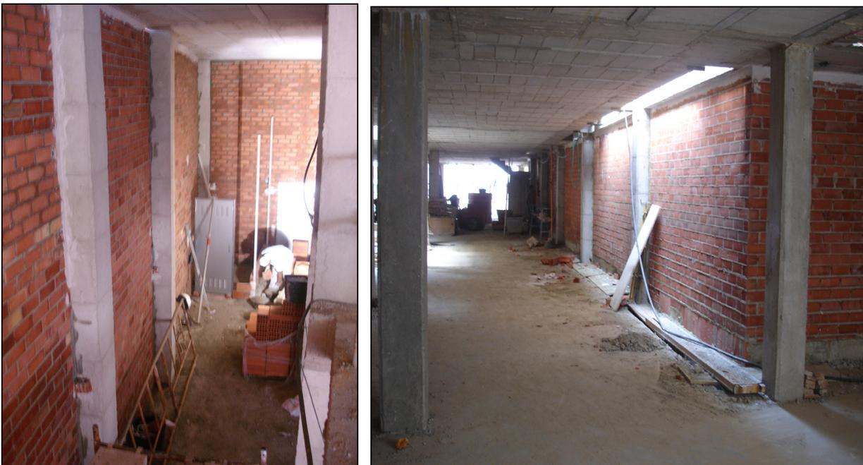
*Figura 262.- Imagen de las paredes medianeras del edificio realizadas con ladrillo de panal cerámico.*
