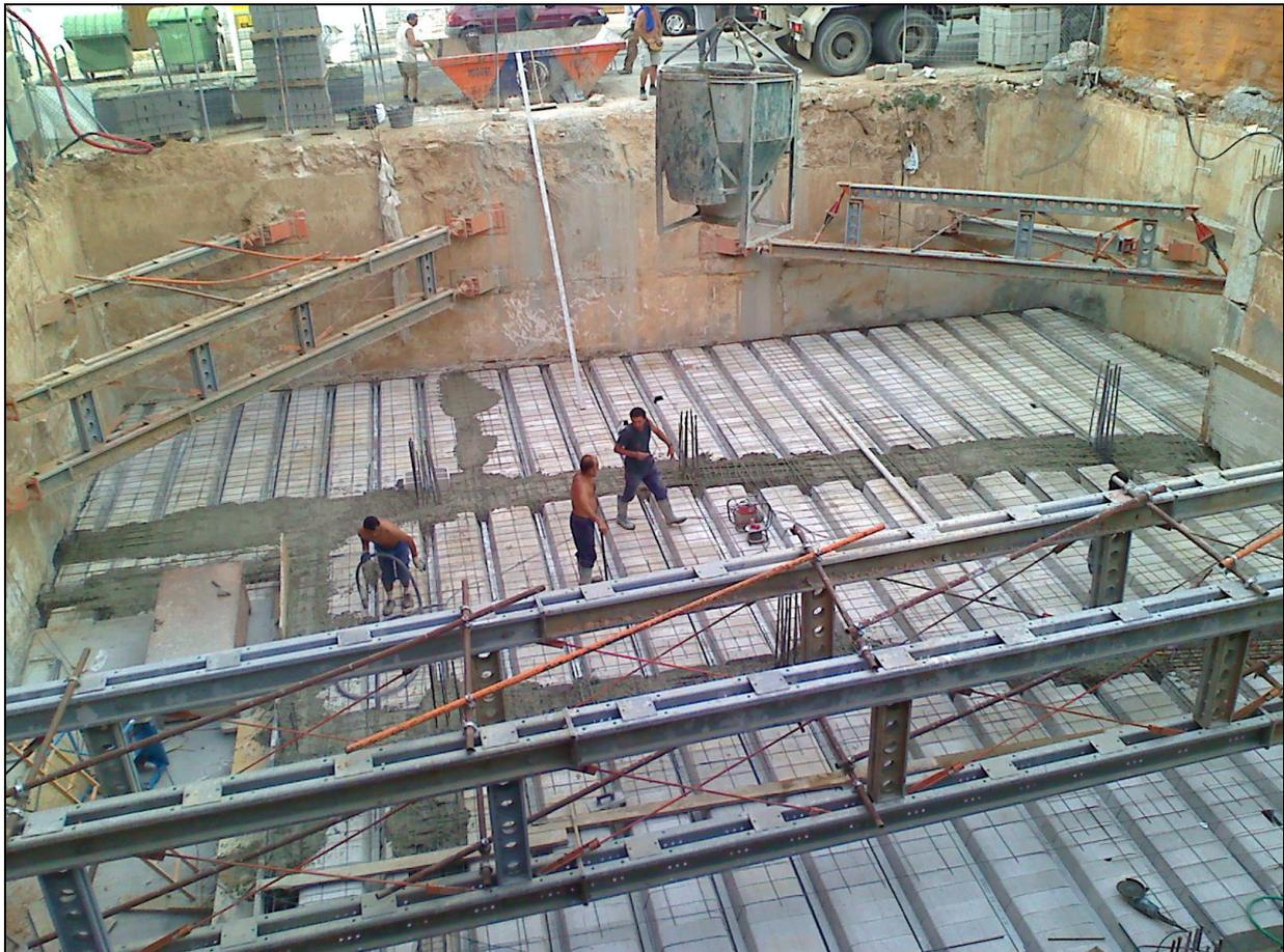
*Figura 222.- Imagen del hormigonado del último tramo del forjado primero de la fase B.*
