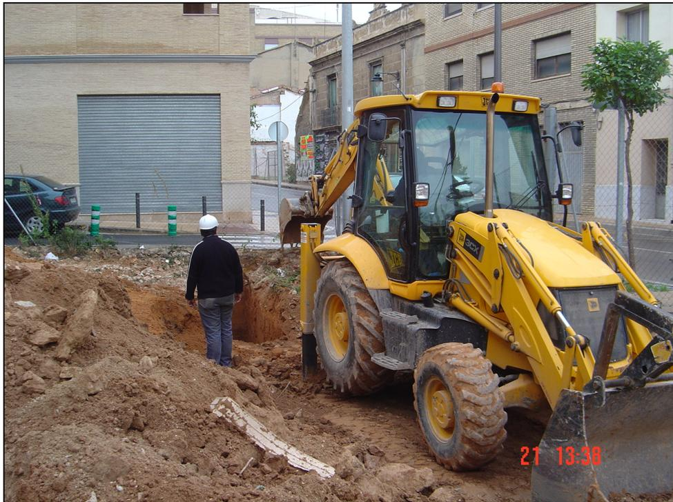
*Figura 29.- Comienzo de la excavación del primer batache en fase A.*
