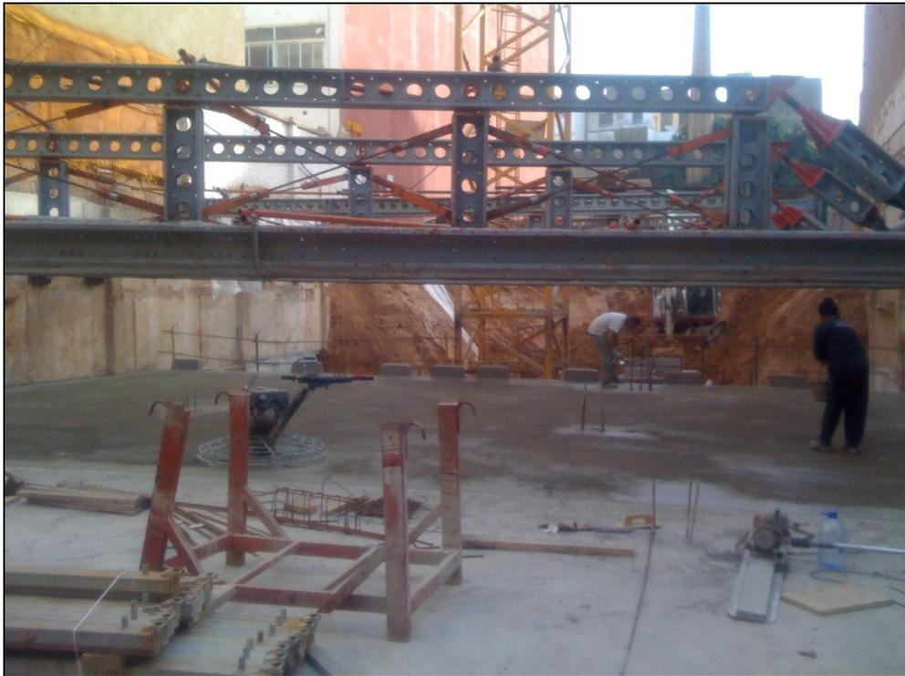
*Figura 195.- Imagen del llenado del forjado primero y de su fratasado, para darle un acabado visto.*
