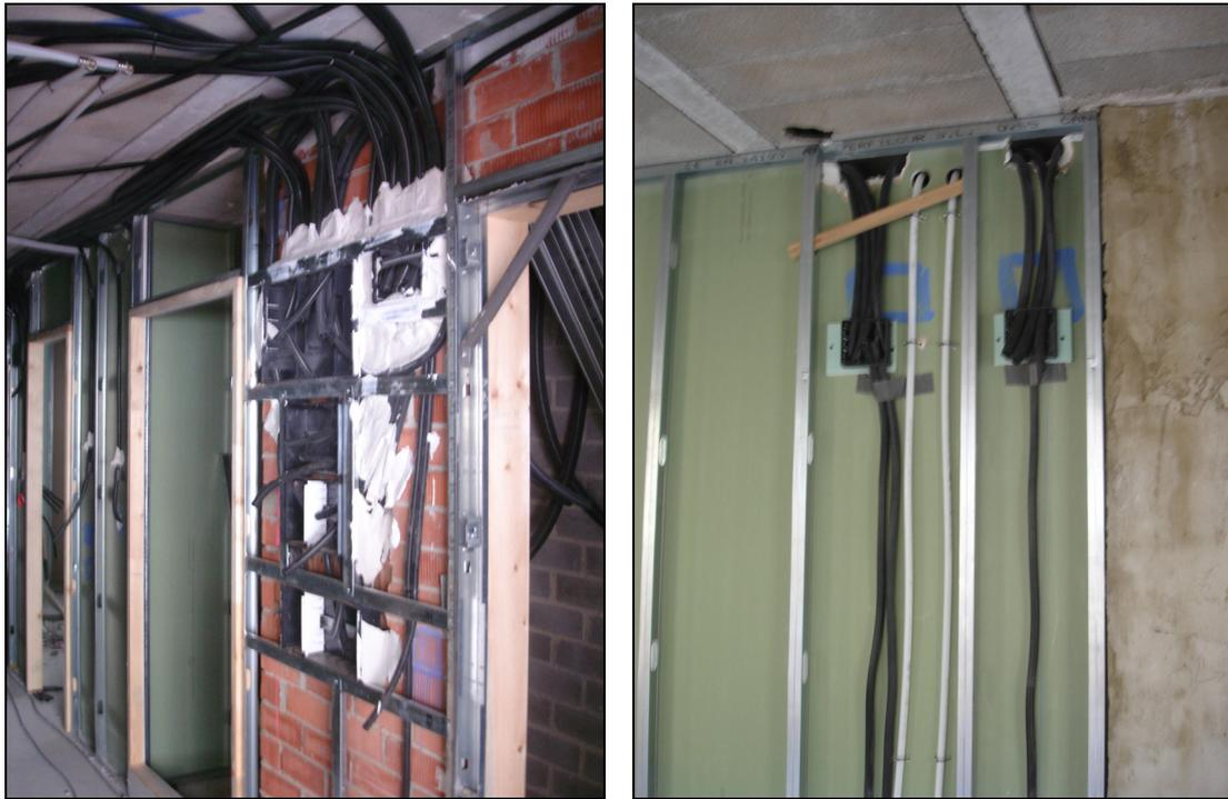
*Figura 278.- Imágenes de las instalaciones de electricidad y agua donde se aprecia la fijación sobre una de las placas de yeso laminado de la tabiquería y su colocación a través de los huecos de la perfilaría metálica existentes para tal fin.*
