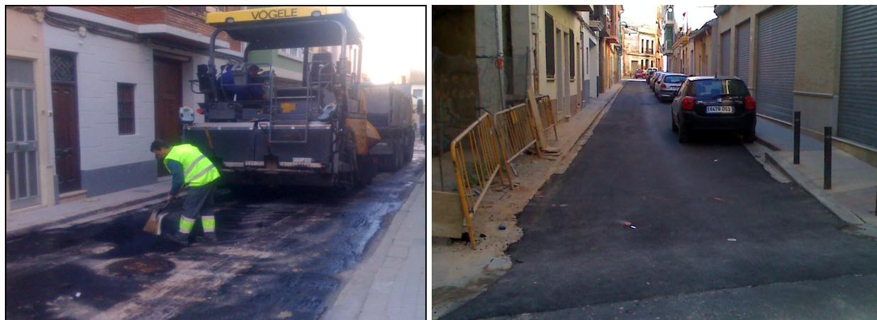
*Figura 143.- Imágenes del asfaltado del vial y de su acabado final.*
