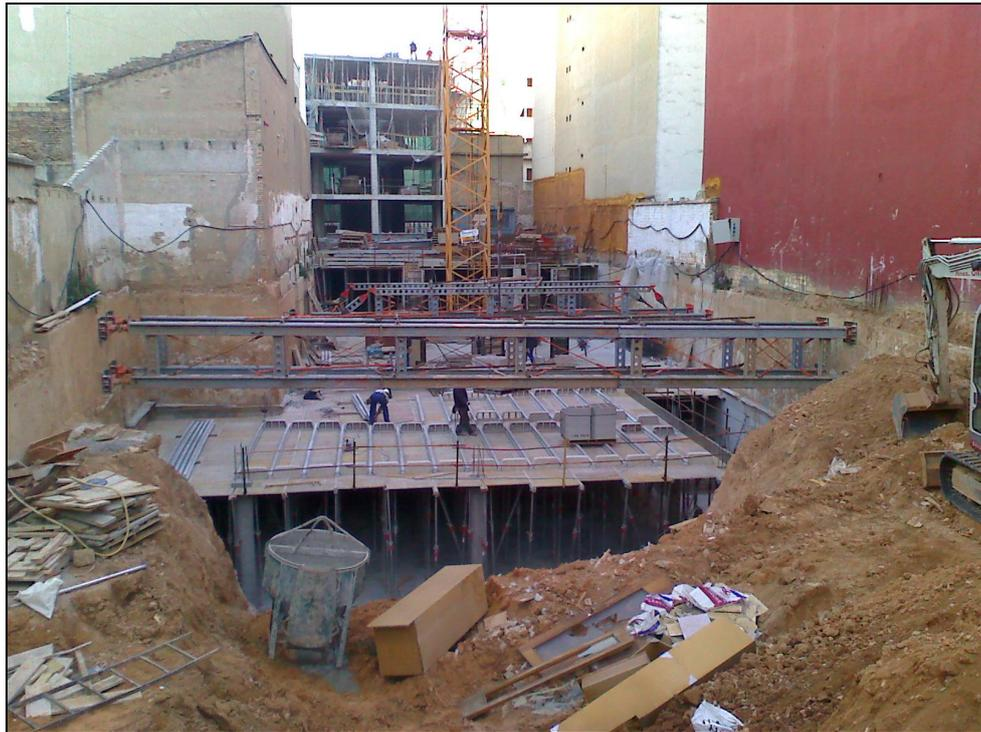
**Figura 207.- Imagen de la nueva zona donde se aprecia la realización del primer forjado.**
