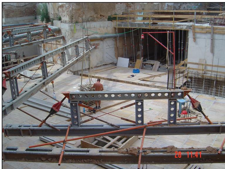
*Figura 137.- Vista del encofrado del primer forjado en la zona 2 y su unión con el ya realizado de la zona 1.*
