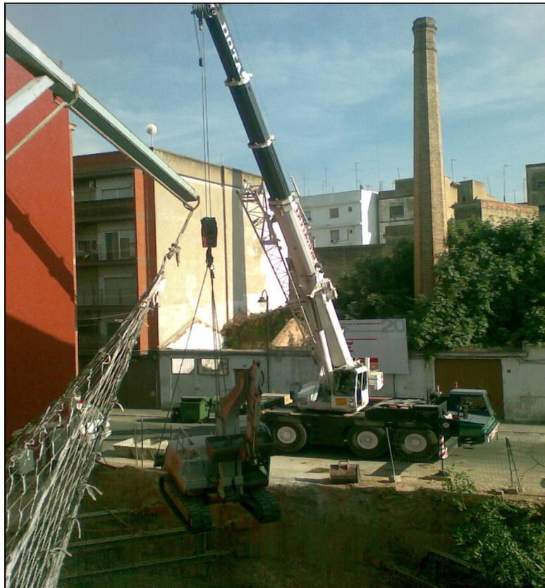
*Figura 217.- Proceso en imágenes de la retirada de la máquina minigradora mediante camión grúa.*
