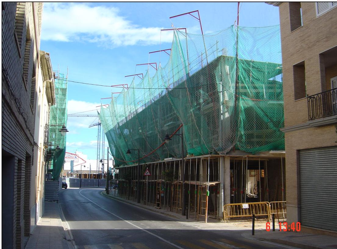
**Figura 235.- Imagen donde se puede ver el 1º y 2º forjado ya realizados y el encofrado del 3º ejecutándose.**
