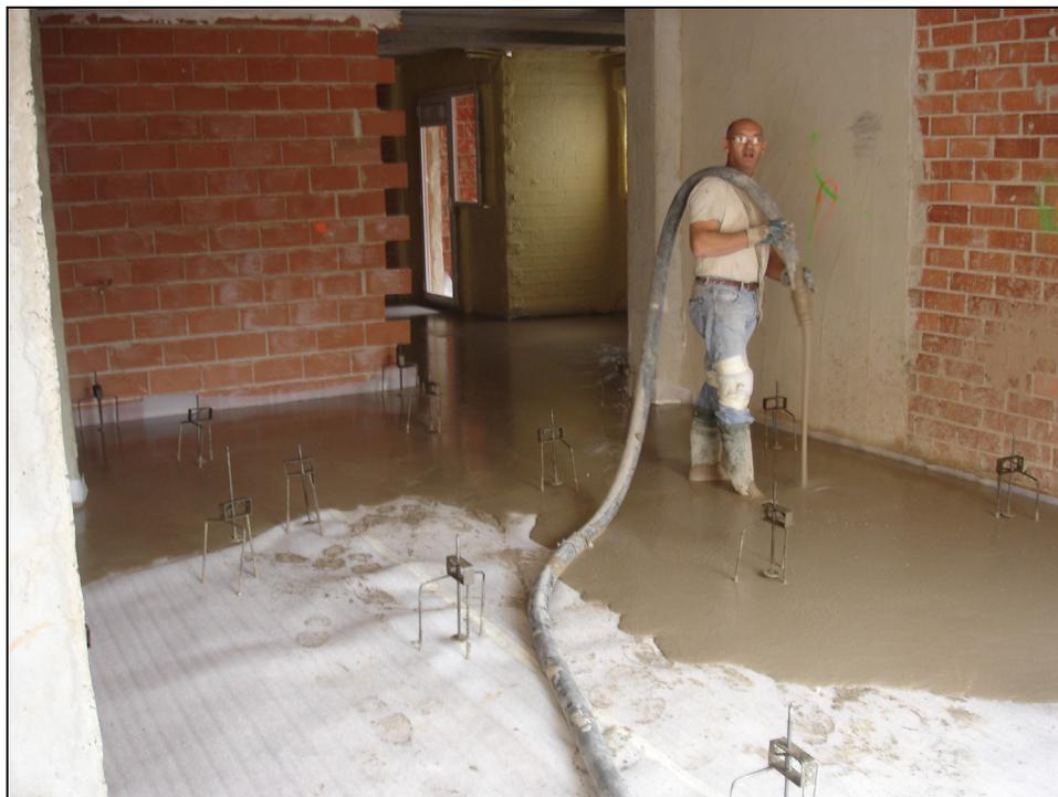
*Figura 273.- Imagen del vertido del mortero autonivelante sobre la lámina antiimpacto colocada en el forjado.*
