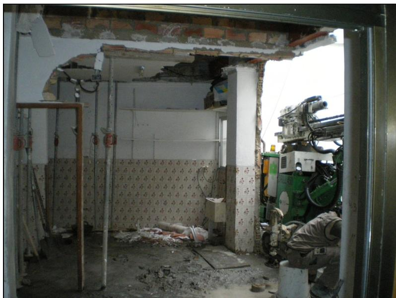
**Figura 83.-** *La máquina de pilotaje en la planta baja, donde se aprecian las mínimas dimensiones de la zona de trabajo.*
