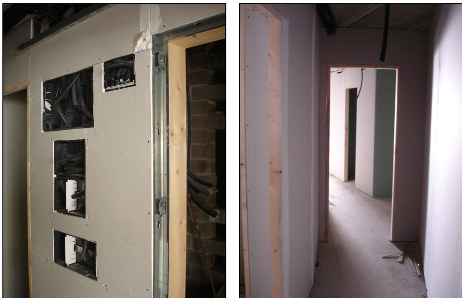
*Figura 279.- Imágenes de los tabiques con las placas de pladur colocadas tras estar realizadas las instalaciones. - 252 -*
