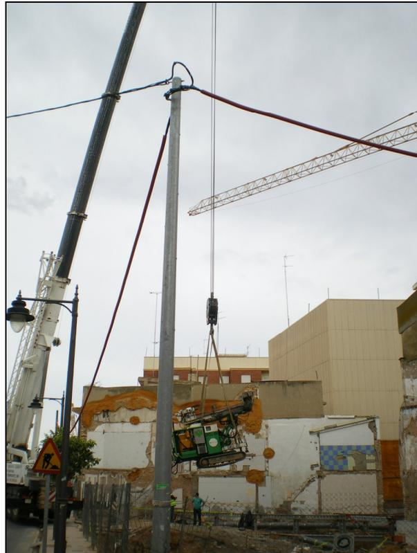
**Figura 82.-** *Maquinaria siendo izada para introducirla superiormente por el patio del edificio.*
