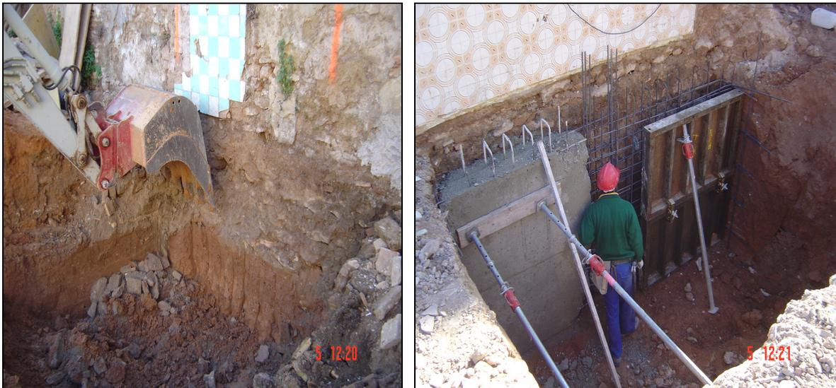
*Figura31.- Bataches en medianeras. Ejemplo del pequeño tamaño de los mismos y del muro resultante.*
