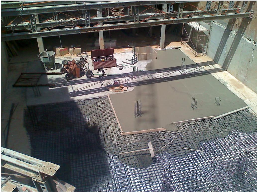
*Figura 219.- Imagen del llenado de la losa realizado en varias fases.*
