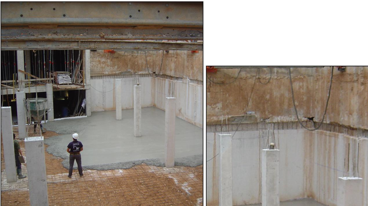
*Figura 192.- Imágenes del repicado del muro en la franja que aloja el forjado.*
