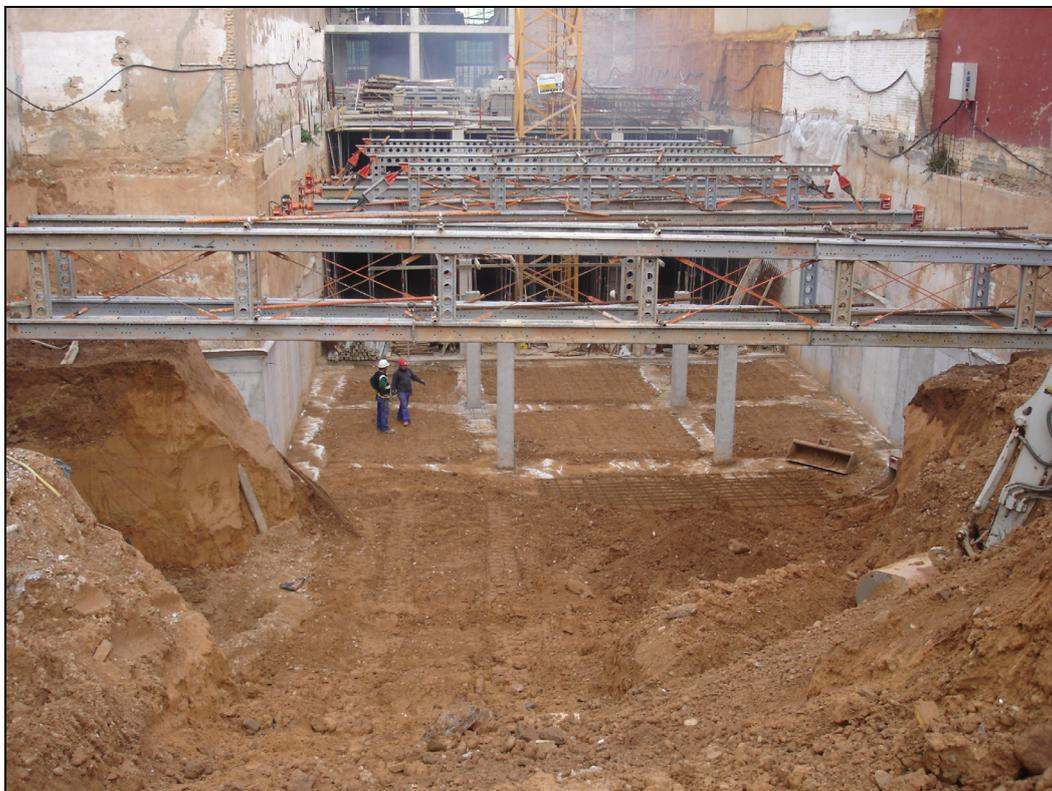
**Figura 202.- Imagen de la zona preparada para realizar los muros y para encofrar otra porción de forjado.**
