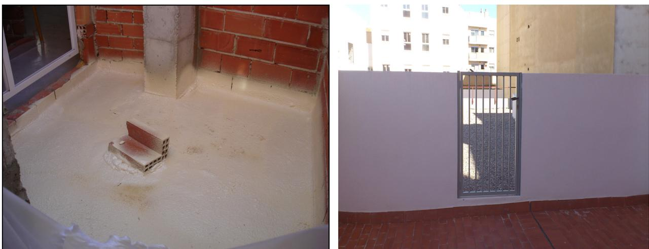
*Figura 271.- Imágenes del poliuretano proyectado sobre el forjado de un patio de duplex, y de la cubierta no transitable invertida protegida con una capa superficial de grava de la zona de garajes.*
