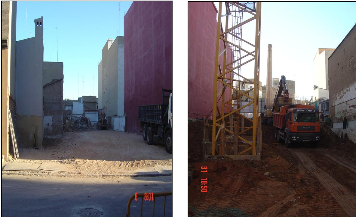
*Figura 28.- Todo el solar rebajado un metro de la cota de calle como se ve en la imagen dcha.*
