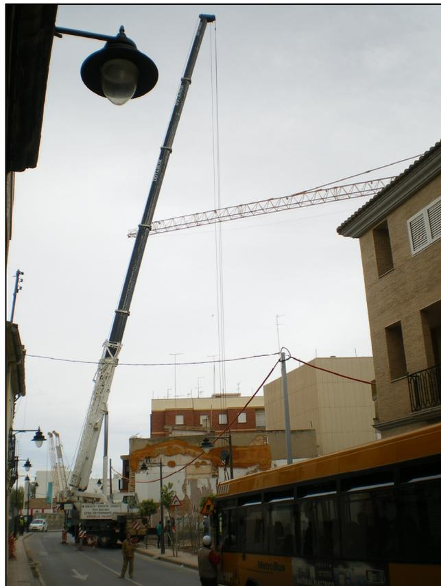
*Figura 81.- Grúa utilizada para introducir la máquina de micropilotes en el patio interior del edificio afectado.*
