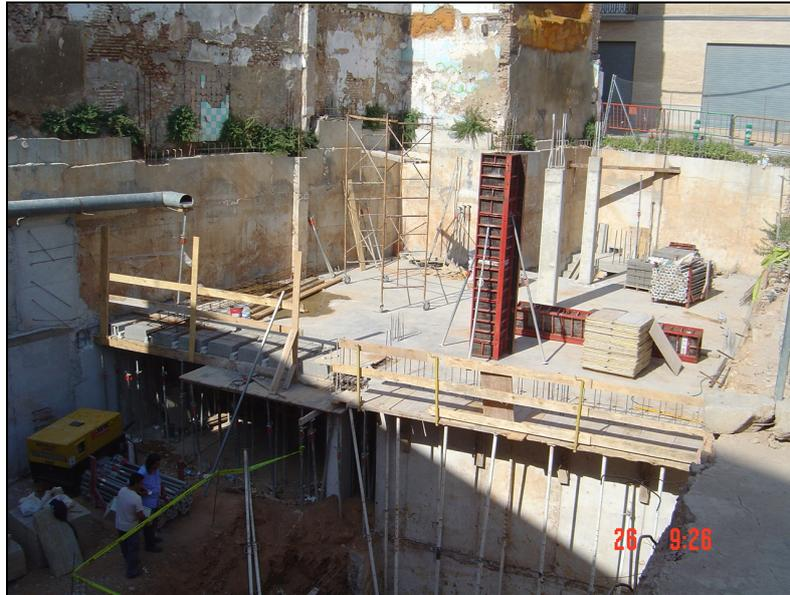
*Figura 132.- Vista del forjado primero hormigonado donde se aprecia que se han retirado los codales.*
