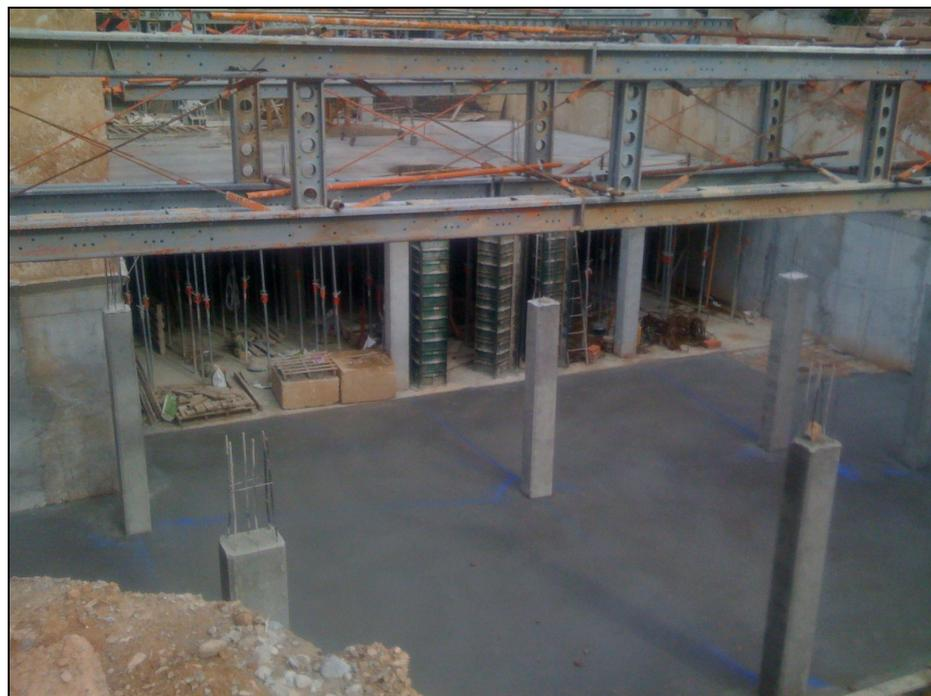
*Figura 206.- Imagen de la zona anterior con el forjado, la solera y muros ya realizados.*
