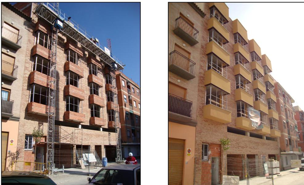
*Figura 266.- Imágenes de la fachada donde se aprecia como los miradores son de ladrillo cerámico ordinario revestido mediante mortero monocapa de color pastel.*
