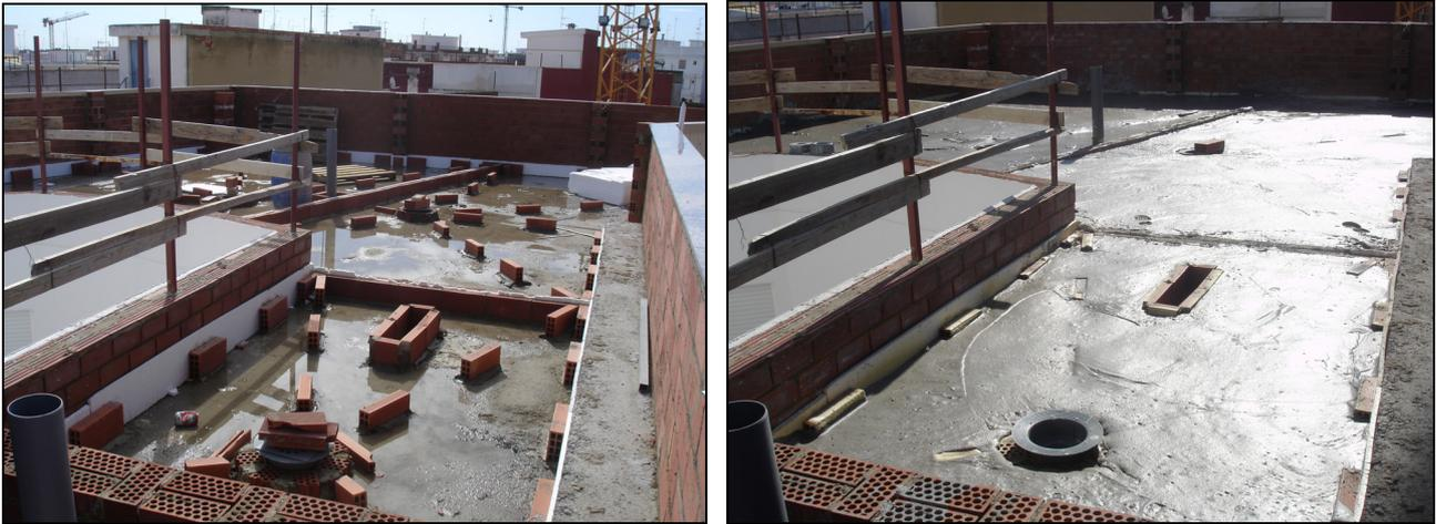
*Figura 270.- Imágenes de la formación de las pendientes de la terraza general del edificio mediante hormigón celular.*
