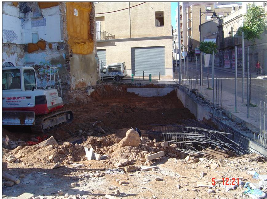
*Figura 34. Muros en fase A unidos en su totalidad, preparados para completar su altura hasta cota de forjado.*
