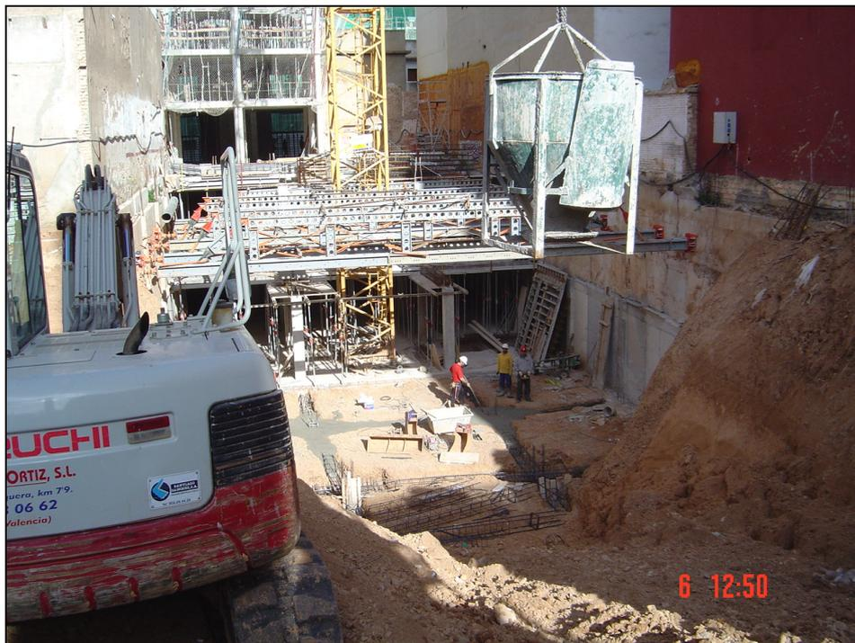
*Figura 198.- Imagen de las zapatas y riostras ya realizadas.*
