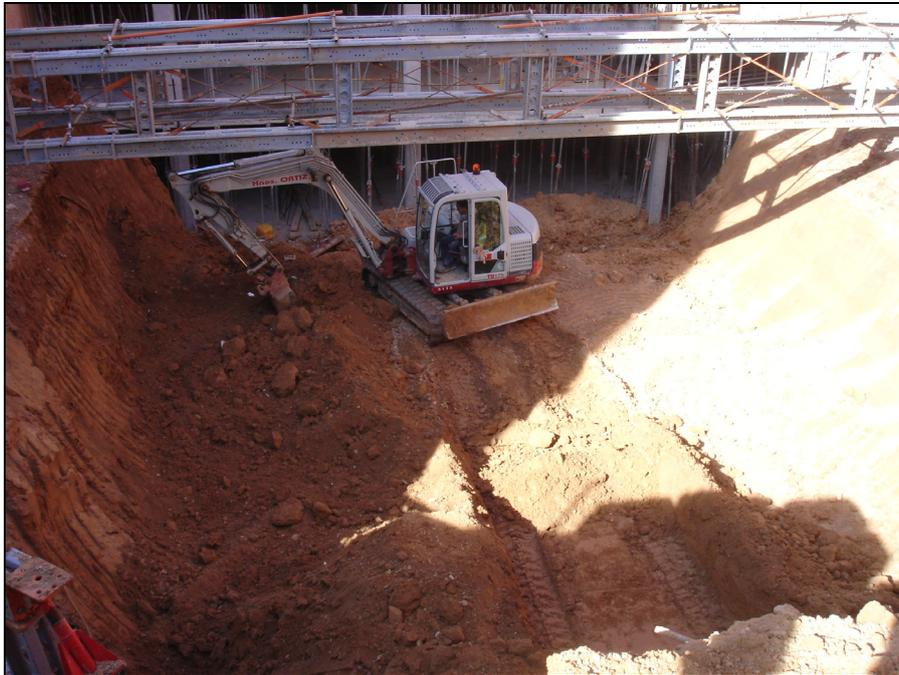
*Figura 209.- Imagen de cómo la máquina minigradora prepara la excavación para la realización de los muros.*
