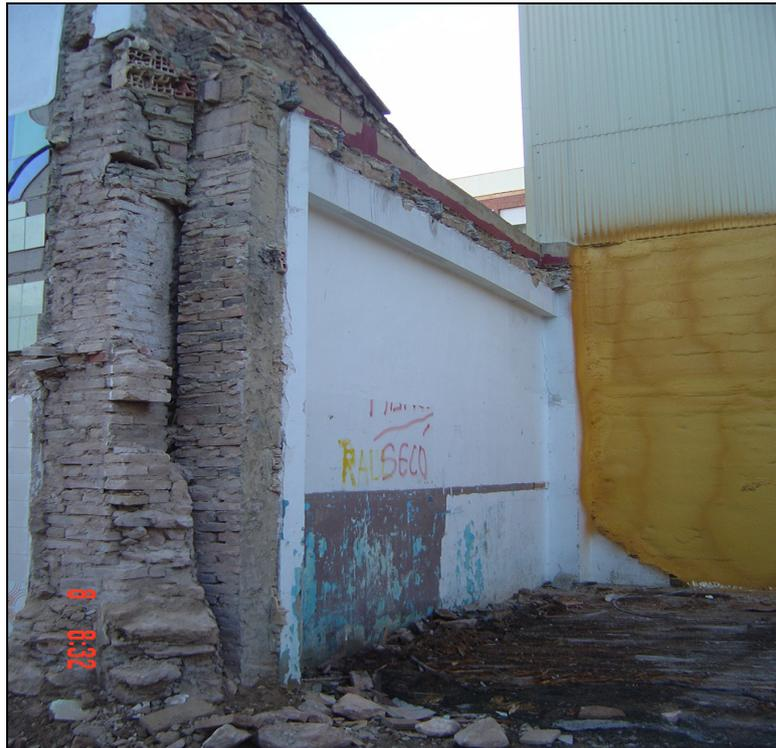
*Figura 13.- Restos de los antiguos muros de la fábrica de hilos que había que proceder a derribar.*
