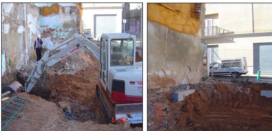
*Figura 32.- Máquina mini giratoria abriendo bataches. Muros aislados realizados para su posterior unión.*
