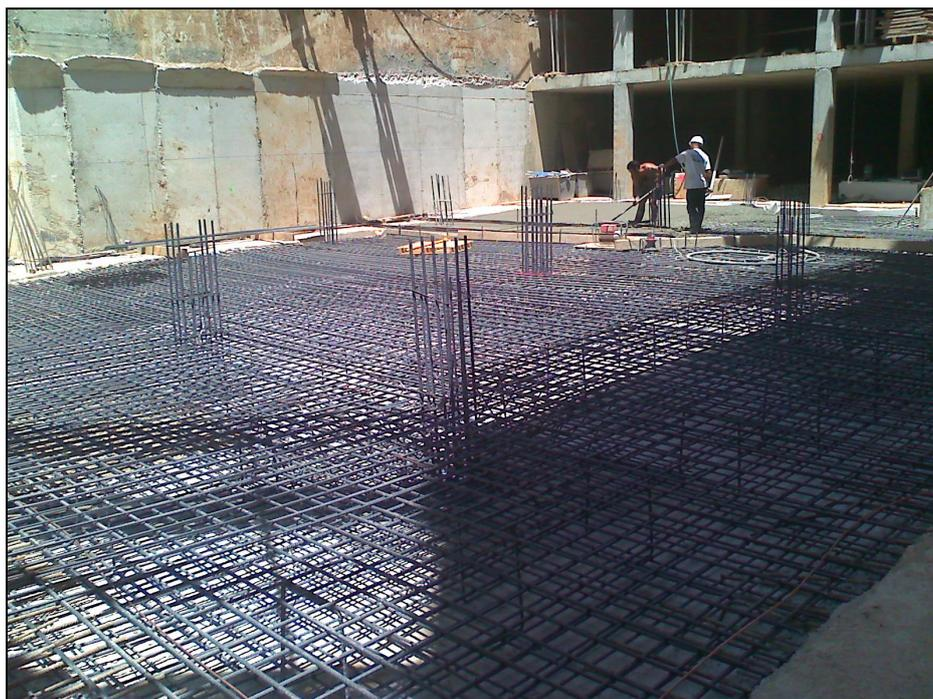
*Figura 218.- Imagen del ferrallado de la losa con los arranques de los pilares colocados.*
