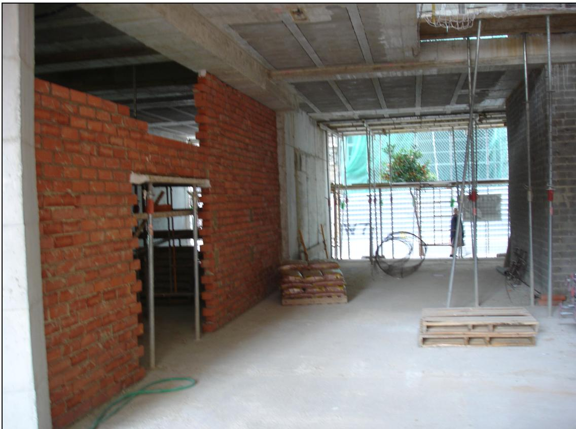
*Figura 255.- Imagen de una de las medianeras entre viviendas en planta baja dejando un hueco para pasar.*
