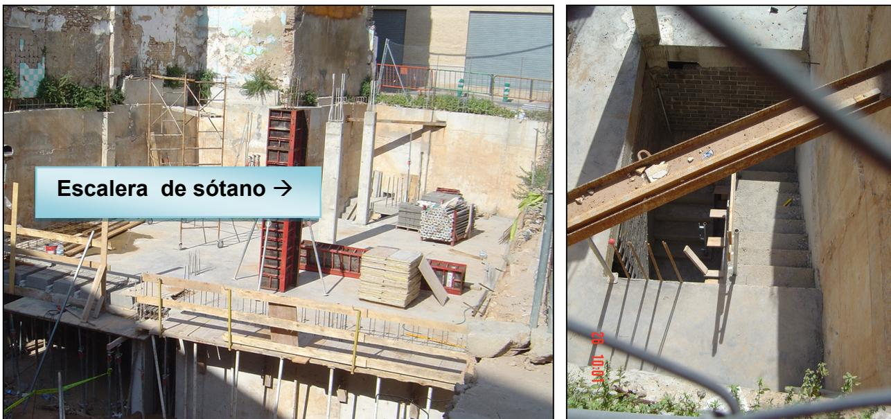
Figura 247.- Imágenes de la caja de escalera de sótano tabicada con ladrillo de panal acústico y escalera de hormigón.
