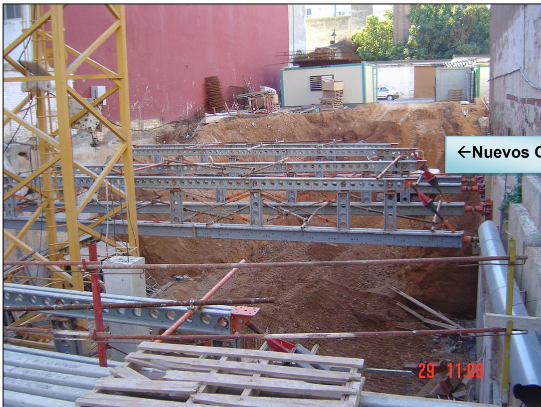
*Figura 196.- Imagen de los nuevos codales colocados tras el llenado del forjado primero.*
