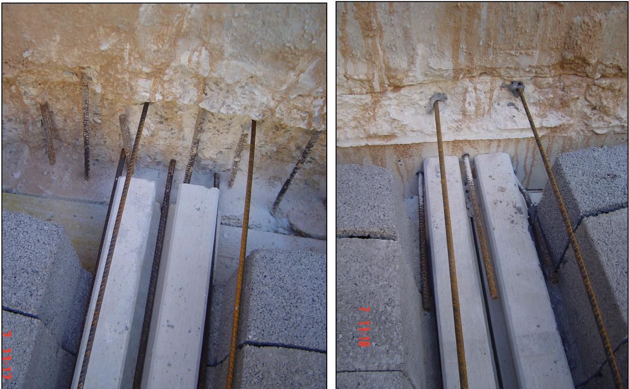
*Figura 194.- Unión de las viguetas con los muros mediante cajeados, y anclaje de armaduras con resina epoxi.*
