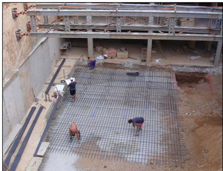
*Figura 215.- Imágenes del ferrallado de la losa donde se aprecia el replanteo de los ejes de los pilares en rosa.*
