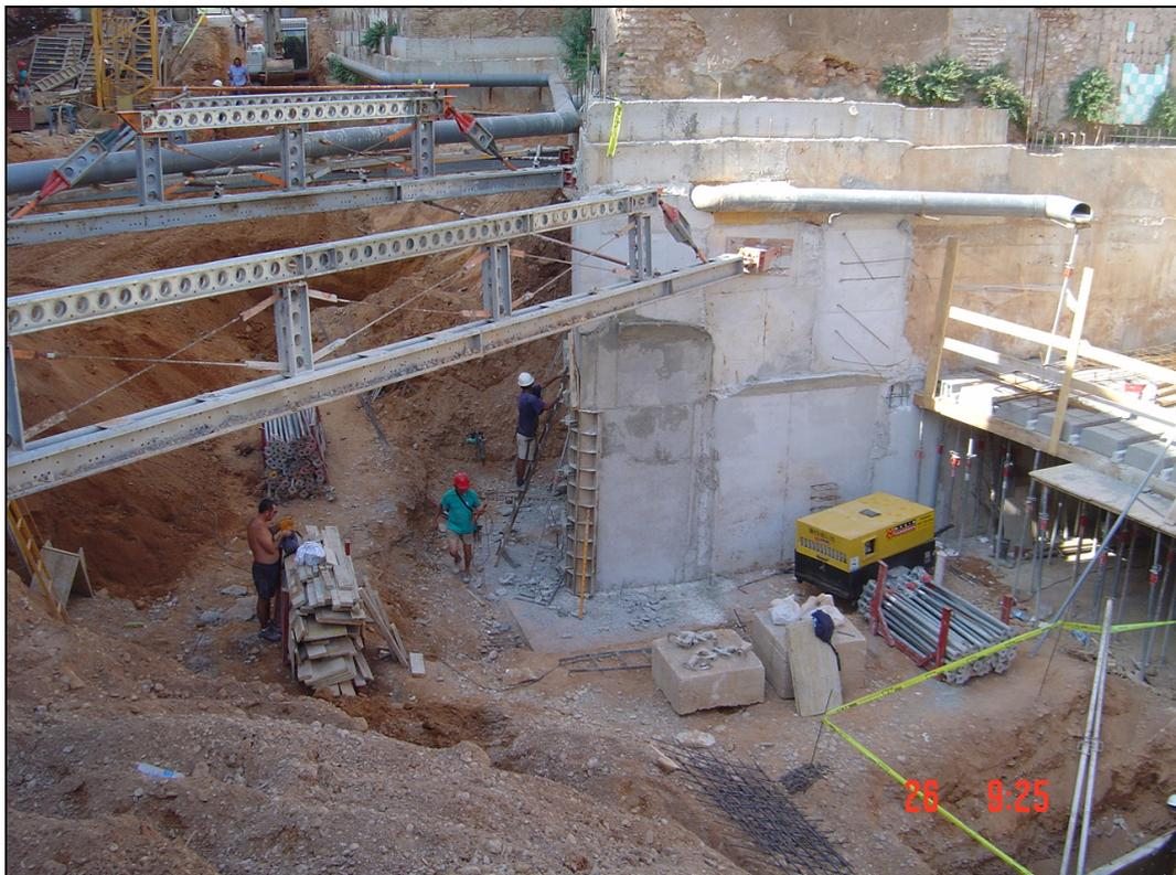
*Figura 54.- En esta imagen se aprecia la cimentación ejecutada y el muro del segundo anillo ya ejecutado.*
