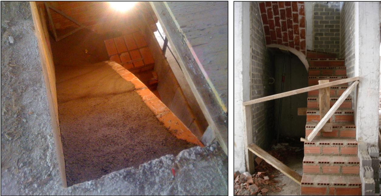
*Figura 250.- Imágenes del vertido de la capa de hormigón y el posterior peldañado de ladrillo cerámico de la escalera.*
