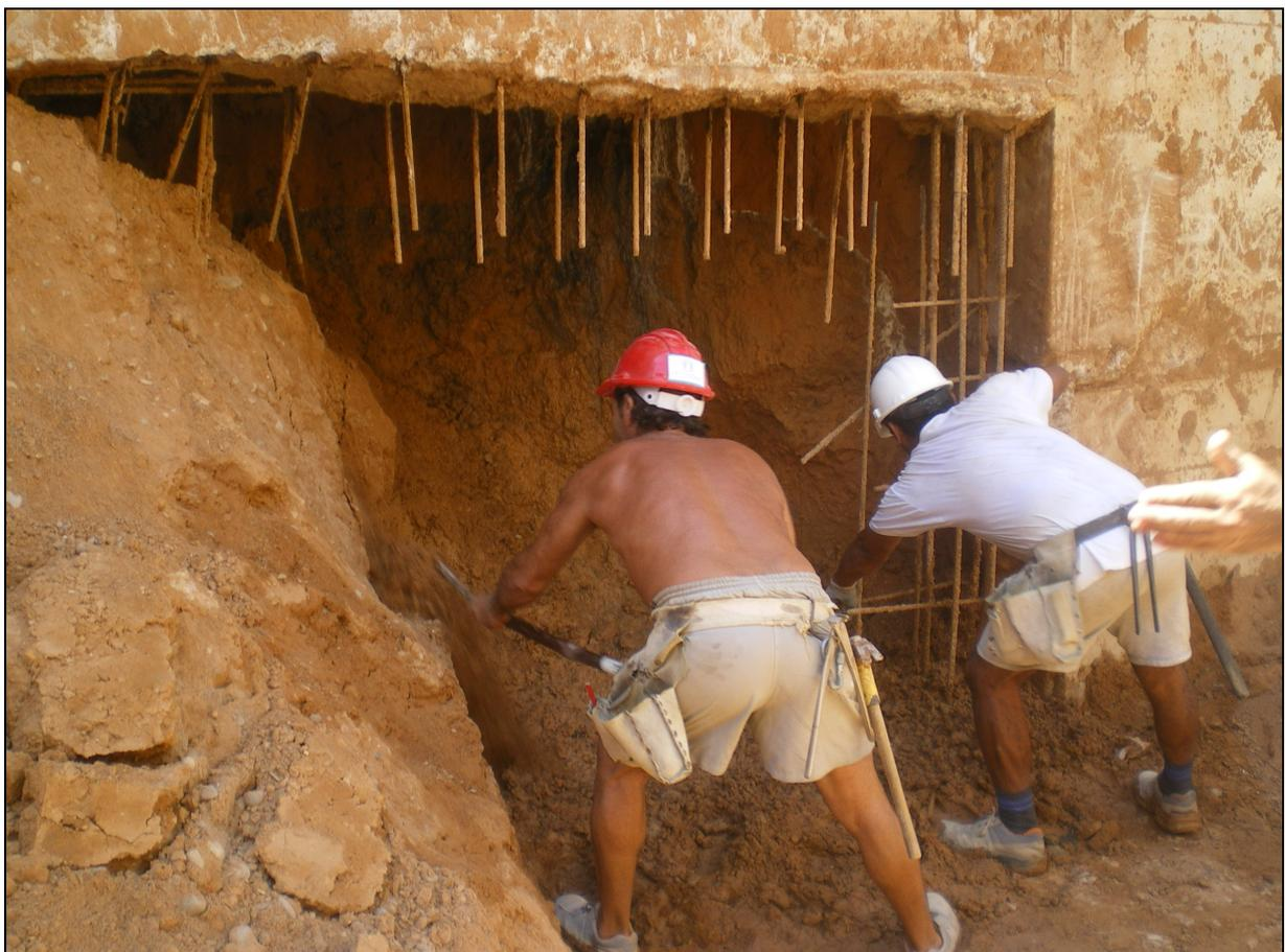
*Figura 37.- Imagen de las esperas que son limpiadas manualmente para continuar con el muro.*
