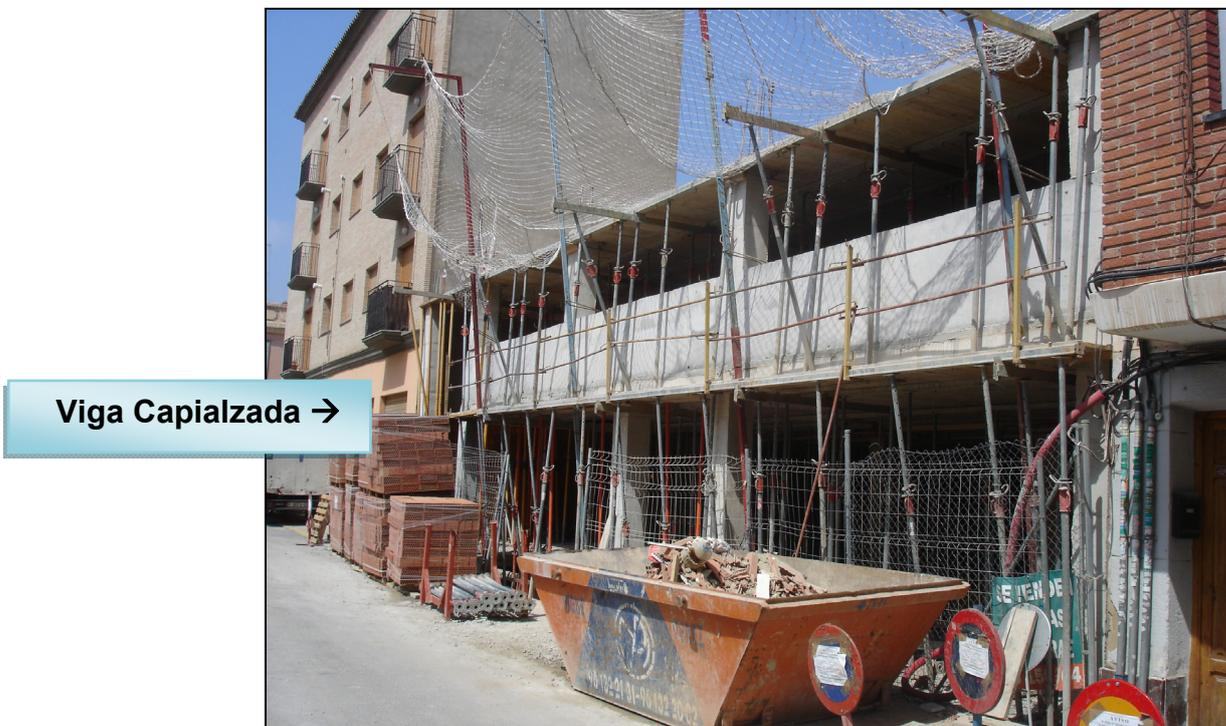
*Figura 243.- Imagen del forjado 4º desde la fachada de la calle Mayor. Se puede observar una viga capialzada.*
