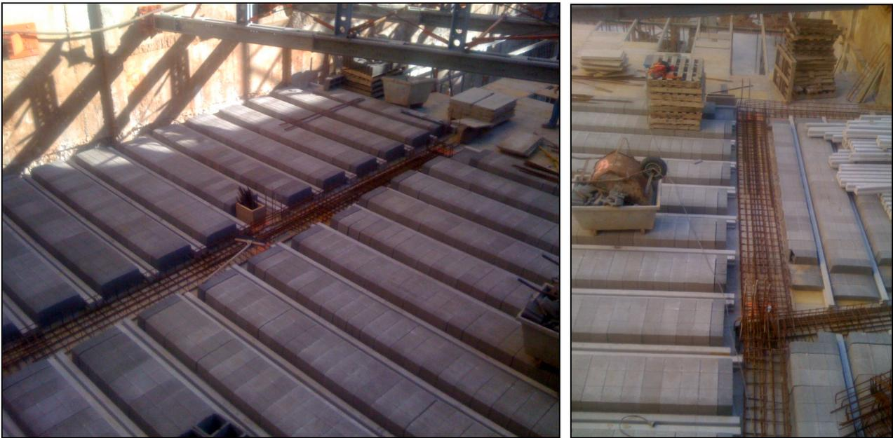
*Figura 193.- Imágenes del forjado preparándose para su posterior hormigonado.*
