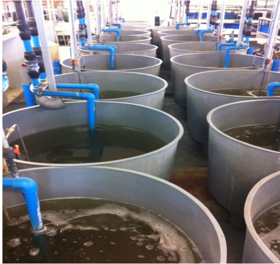
Figura 3. Detalle de los tanques cilíndricos de la línea 2 del LAC.
