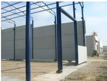
Ilustración 10 Cerramiento placa de hormigón prefabricado. Fuente: cerramientos.placasalveolares.com
