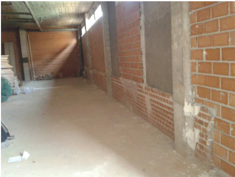
FOTO 4: Vista interior del local desde la entrada (oeste-este)
