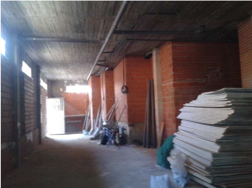
FOTO 5: Vista interior del local hacia entrada local (este-oeste)
