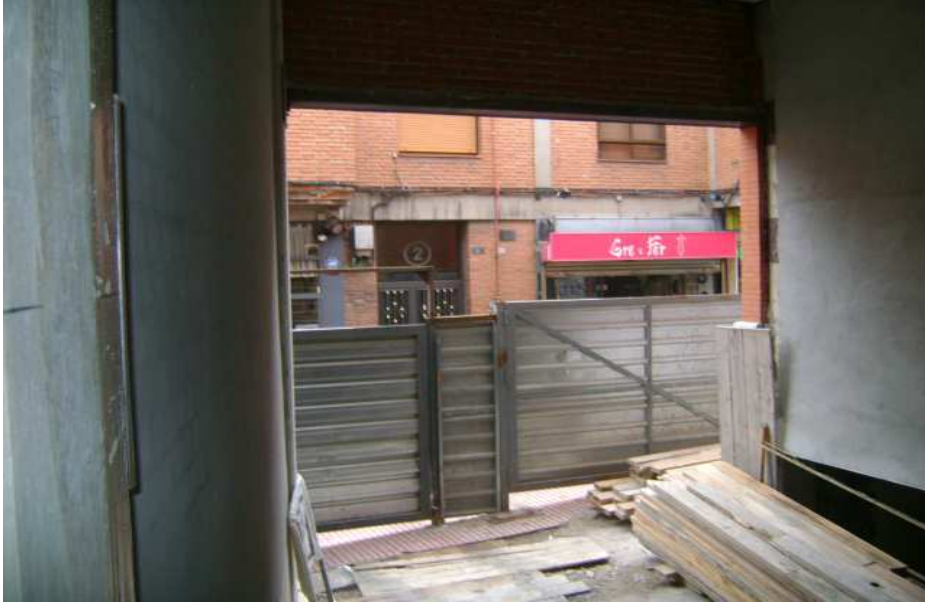
FOTO 1: Acceso rampa garaje
